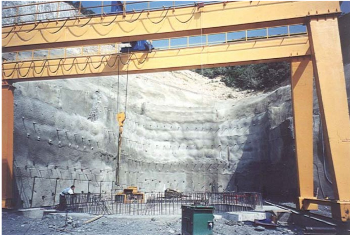
Εικόνα 3.12 Έργα αντιστήριξης για την κατασκευή του φρέατος θεμελίωσης του κεντρικού μεσόβαθρου [9].
