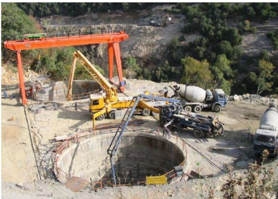
Εικόνα 3.5 Σκυροδέτηση φρεάτων θεμελίωσης [7]
