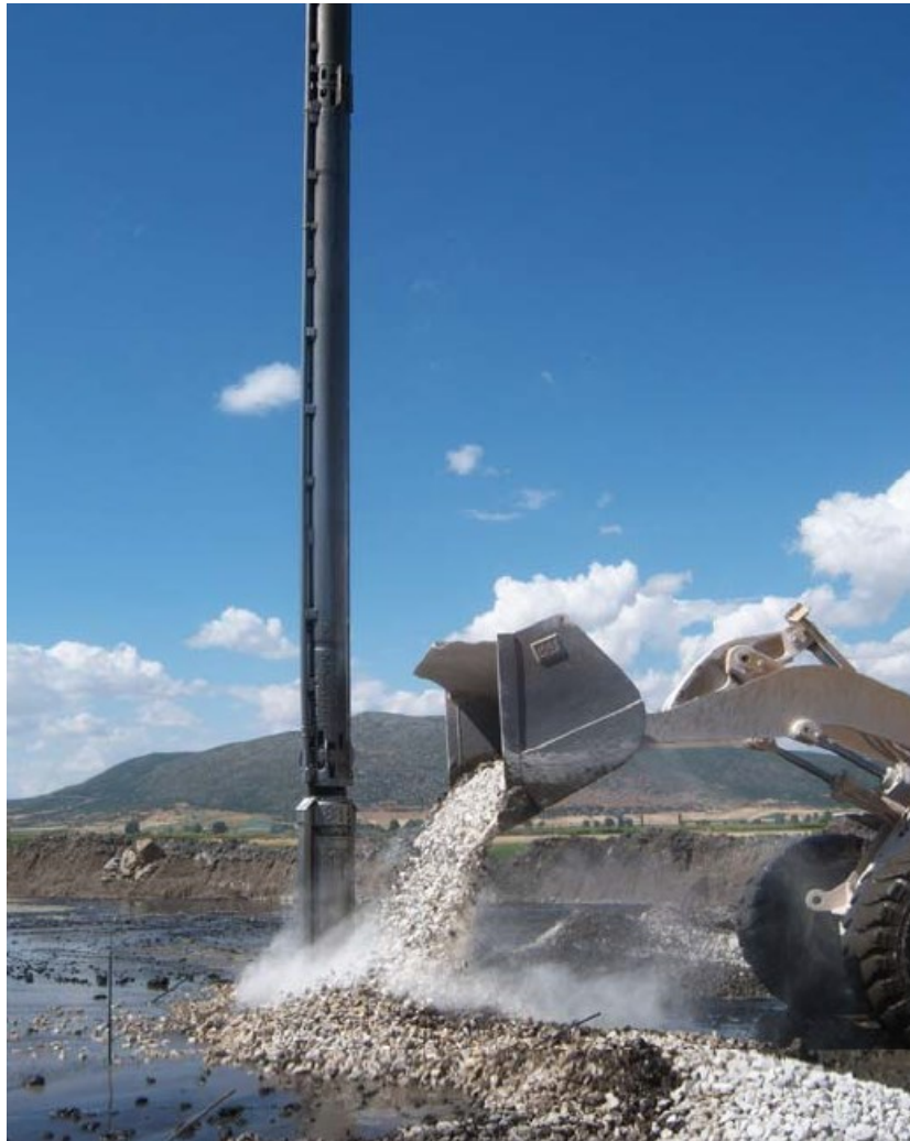
Εικόνα 2.6 Κατασκευή χαλικοπασσάλου σε «πραγματικές συνθήκες» [4].
