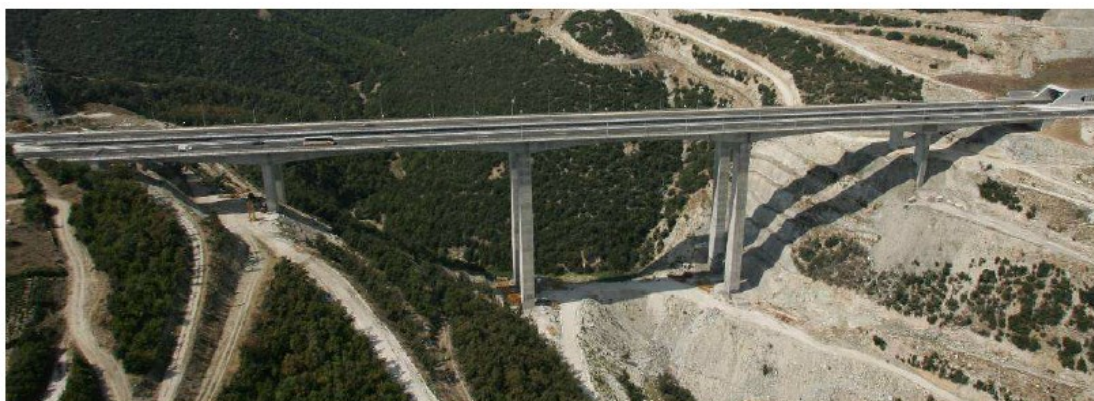
Εικόνα 6 Χαραδρογέφυρα θεμελιωμένη με φρέατα πάκτωσης, στο τμήμα Πολύμυλος- Βέροια της Εγνατίας Οδού [7].
