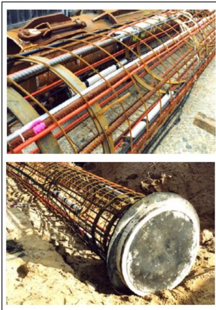
Εικόνα 3.20 Οργανομετρούμενος δοκιμαστικός πάσσαλος με εξοπλισμό ενεμάτωσης [6]
