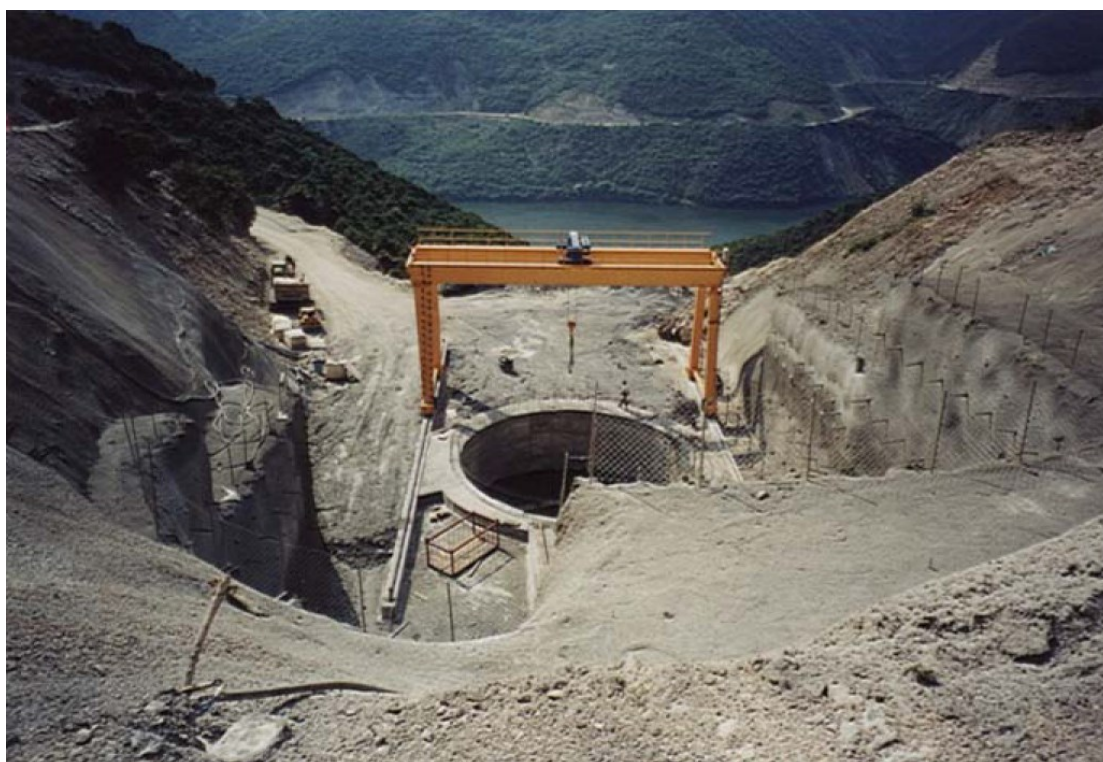
Εικόνα 3.10 Φρέαρ για τη θεμελίωση του μεσόβαθρου της Γέφυρας Γ1[9].
