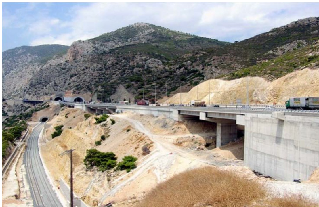
Εικόνα 3.16 Άποψη της γέφυρας ΑΓ2 κατά τη φάση λειτουργίας [9].
