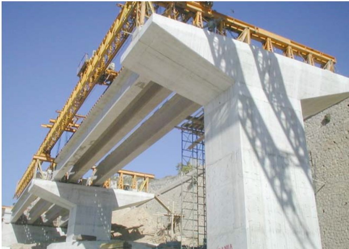
Εικόνα 3.15 Κατασκευή προεντεταμένων δοκών της Γέφυρας ΑΓ2 [9].
