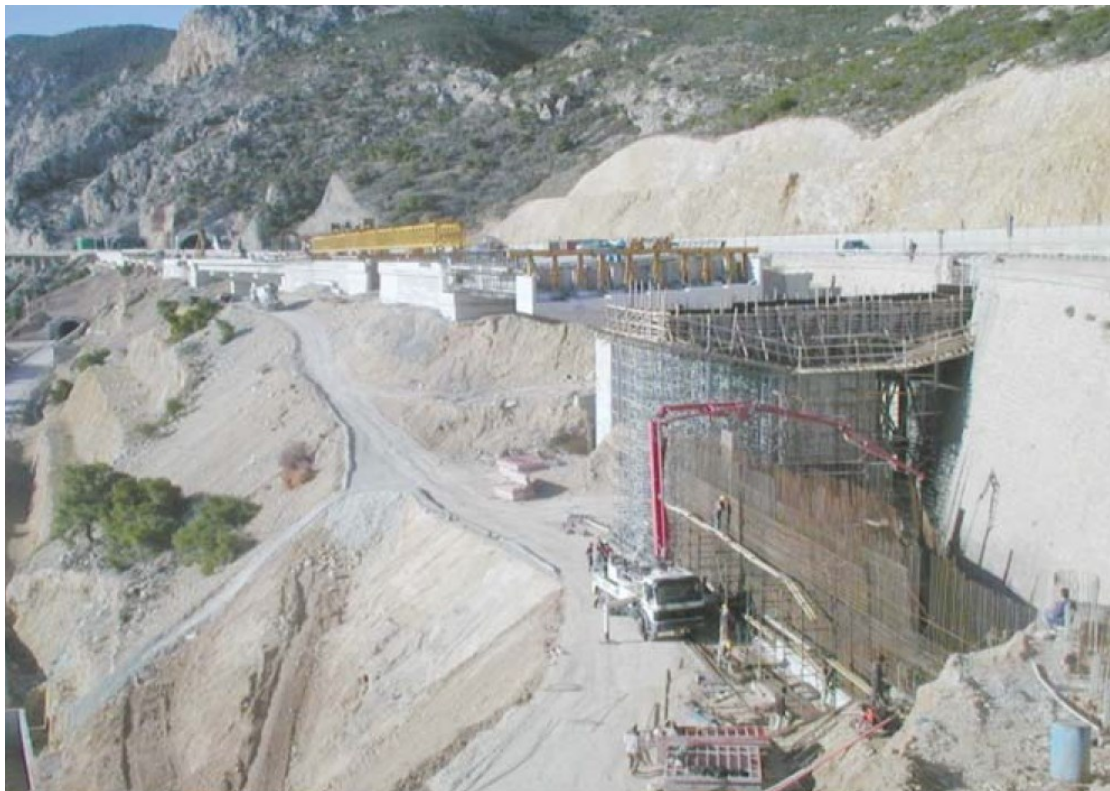
Εικόνα 3.14 Κατασκευή μεταβατικού φορέα της Γέφυρας ΑΓ2 [9].
