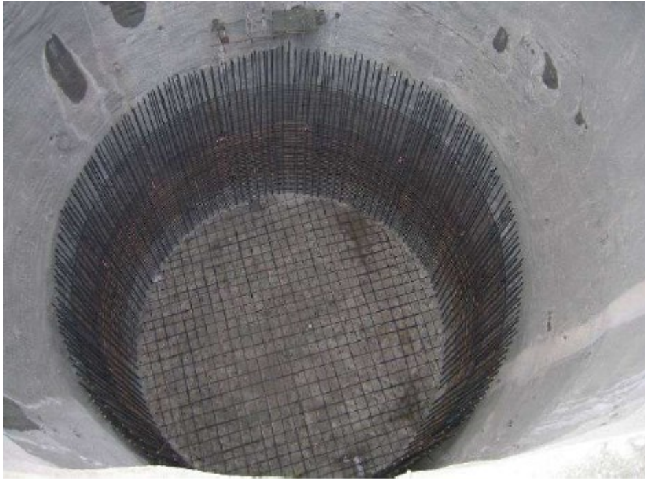
Εικόνα 3.4 Τοποθέτηση των οπλισμών σε φρέαρ θεμελίωσης [7]
