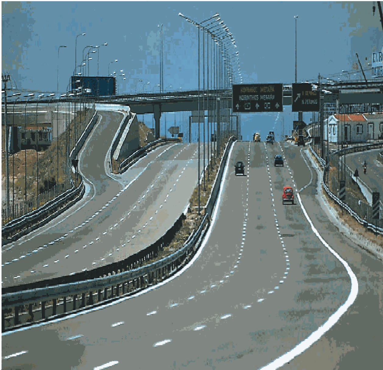
Εικόνα 1.3 Αυτοκινητόδρομος δύο λωρίδων (πηγή: διαδίκτυο)
