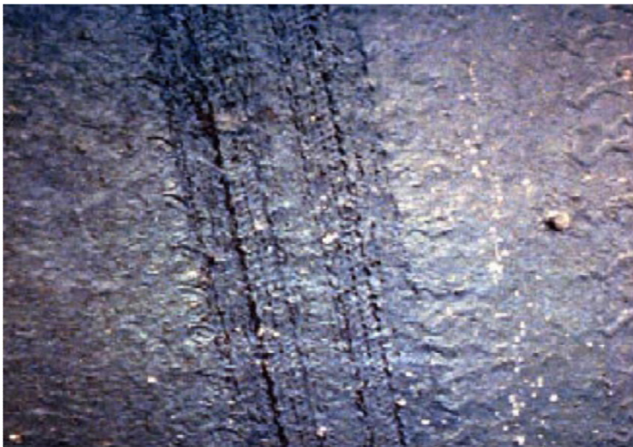
Εικόνα 2.19 Ανάδυση ασφάλτου(διαδίκτυο)
