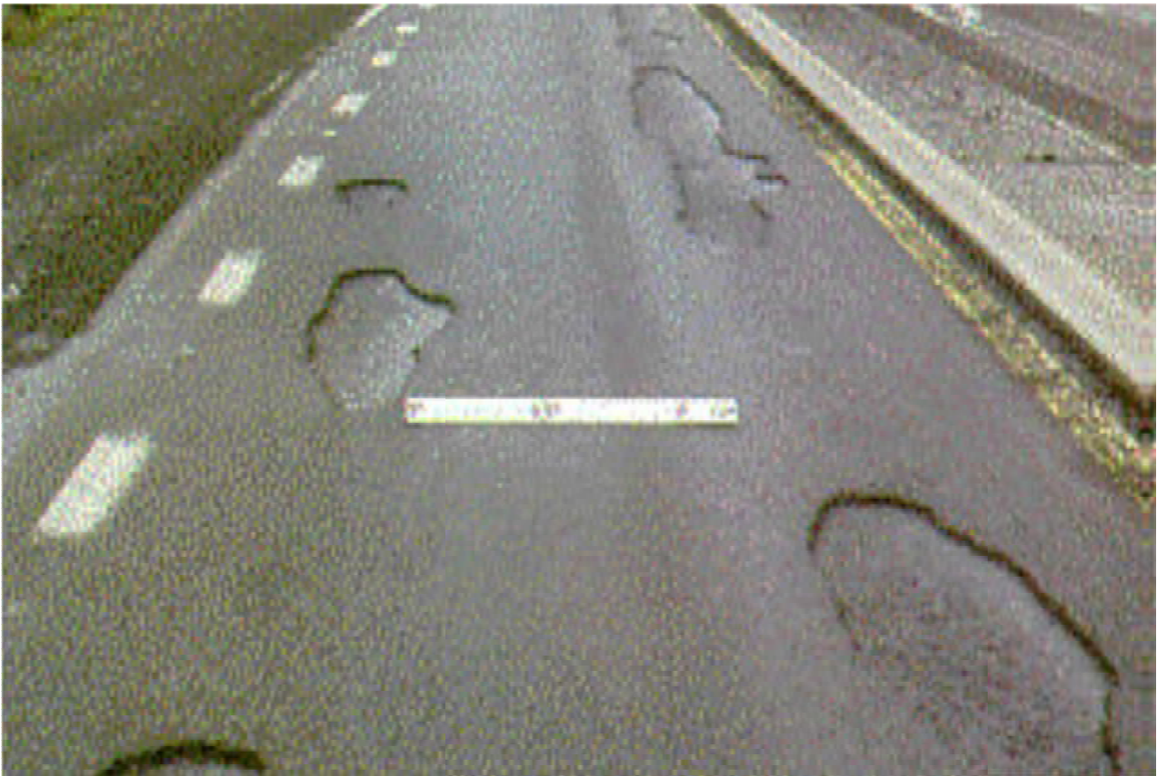
Εικόνα 2.18 Αποκόλληση κατά πλάκες (διαδίκτυο)
