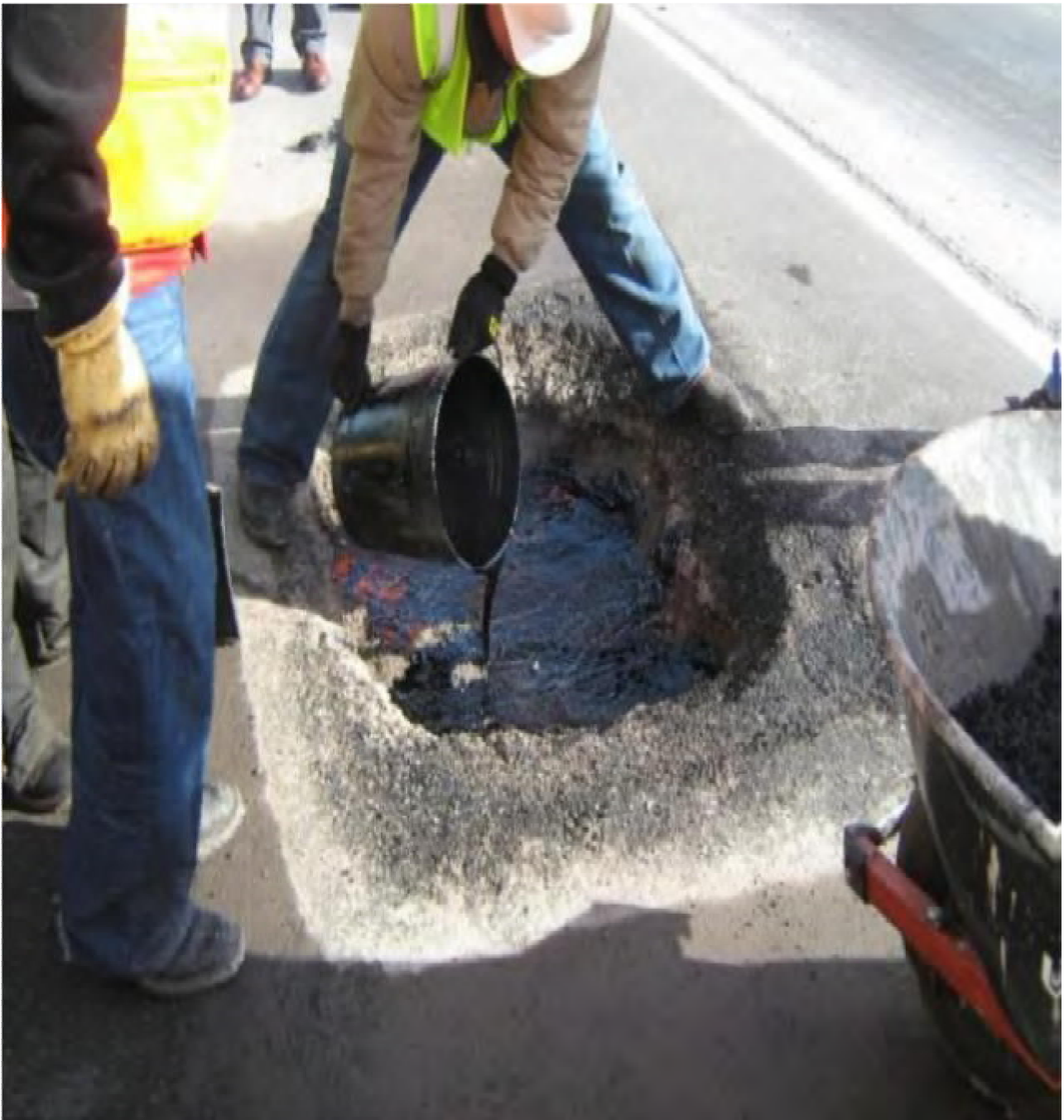
Εικόνα 2.16 Πλήρωση λακκουβών με ασφαλτόμιγμα (Σύστημα οικονομικής και περιβαλλοντικής διαχείρισης οδοστρωμάτων με χρήση γενετικών αλγορίθμων. ΜΑΙΡΗ Ι. ΠΑΝΑΓΟΠΟΥΛΟΥ )
