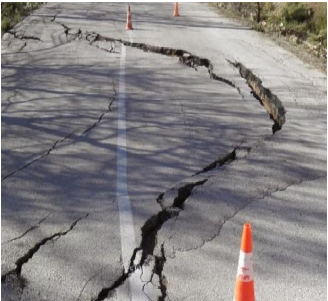
Εικόνα 2.11 Τοπική καθίζηση (διαδύκτιο)
