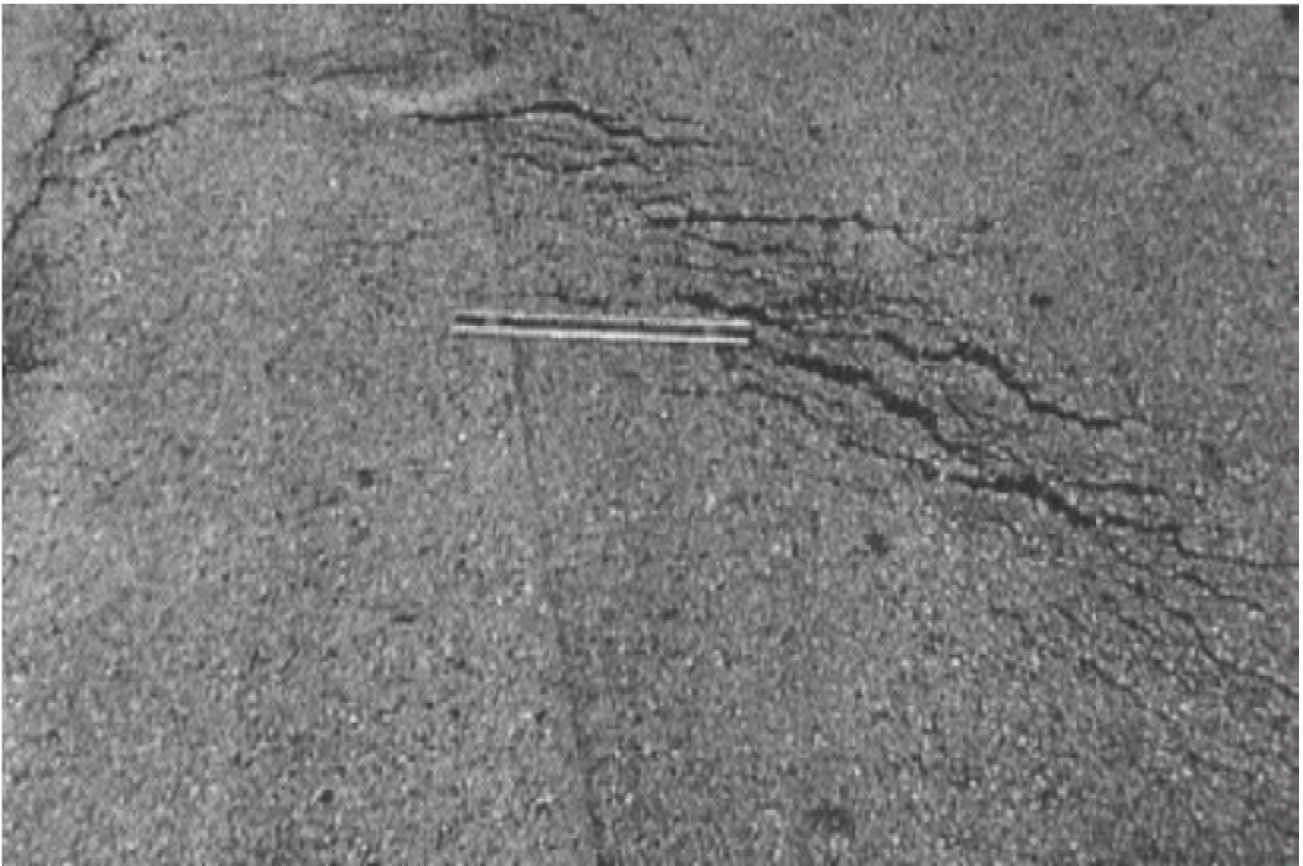
Εικόνα 2.5 Ολίσθηση τάπητα (διαδίκτυο)
