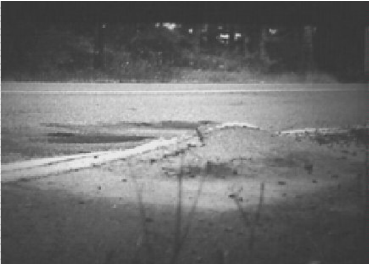
Εικόνα 2.13 Τοπική δίογκωση (διαδίκτυο)
