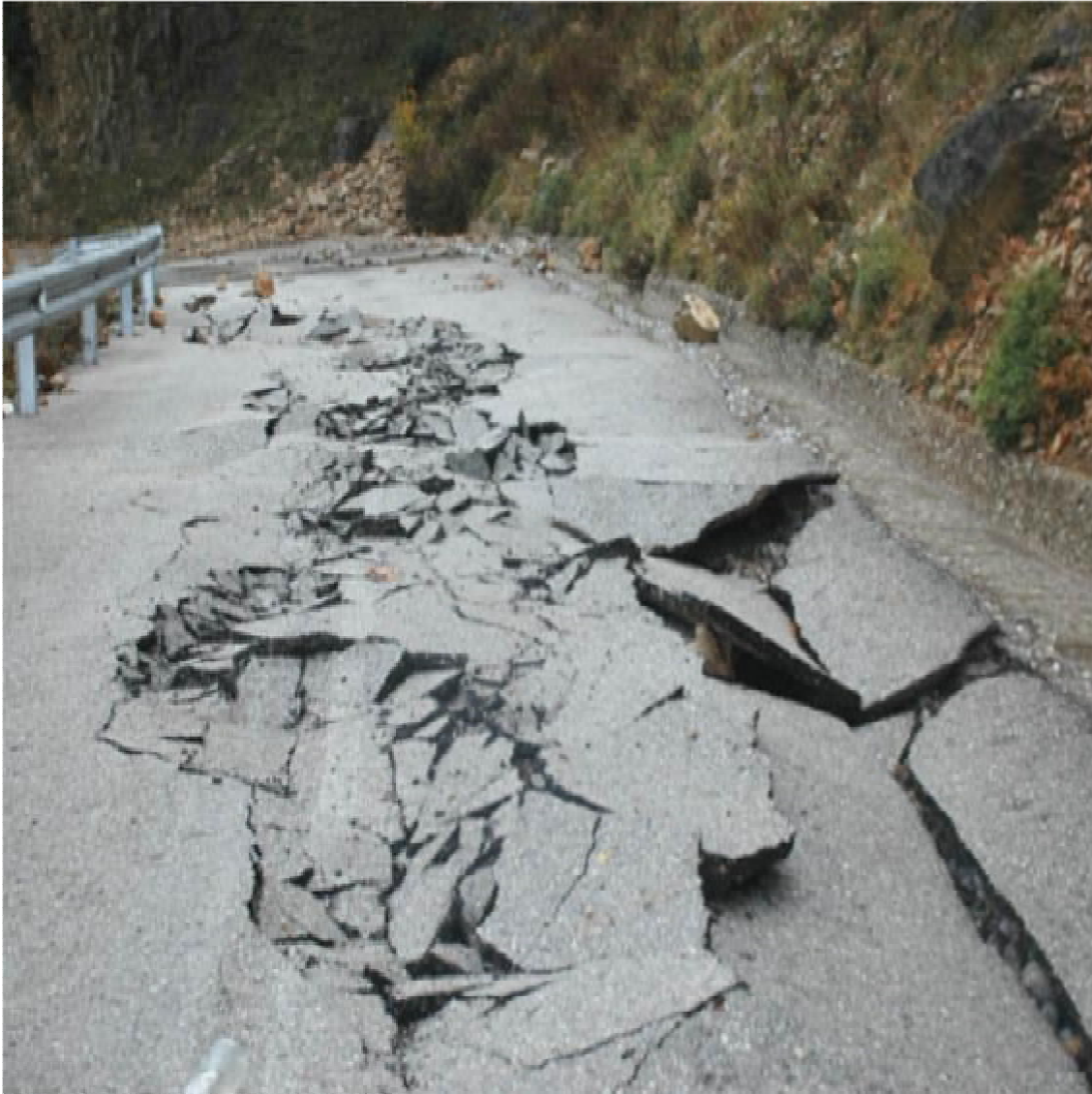
Εικόνα 2.12 Τοπική καθίζηση (διαδίκτυο)
