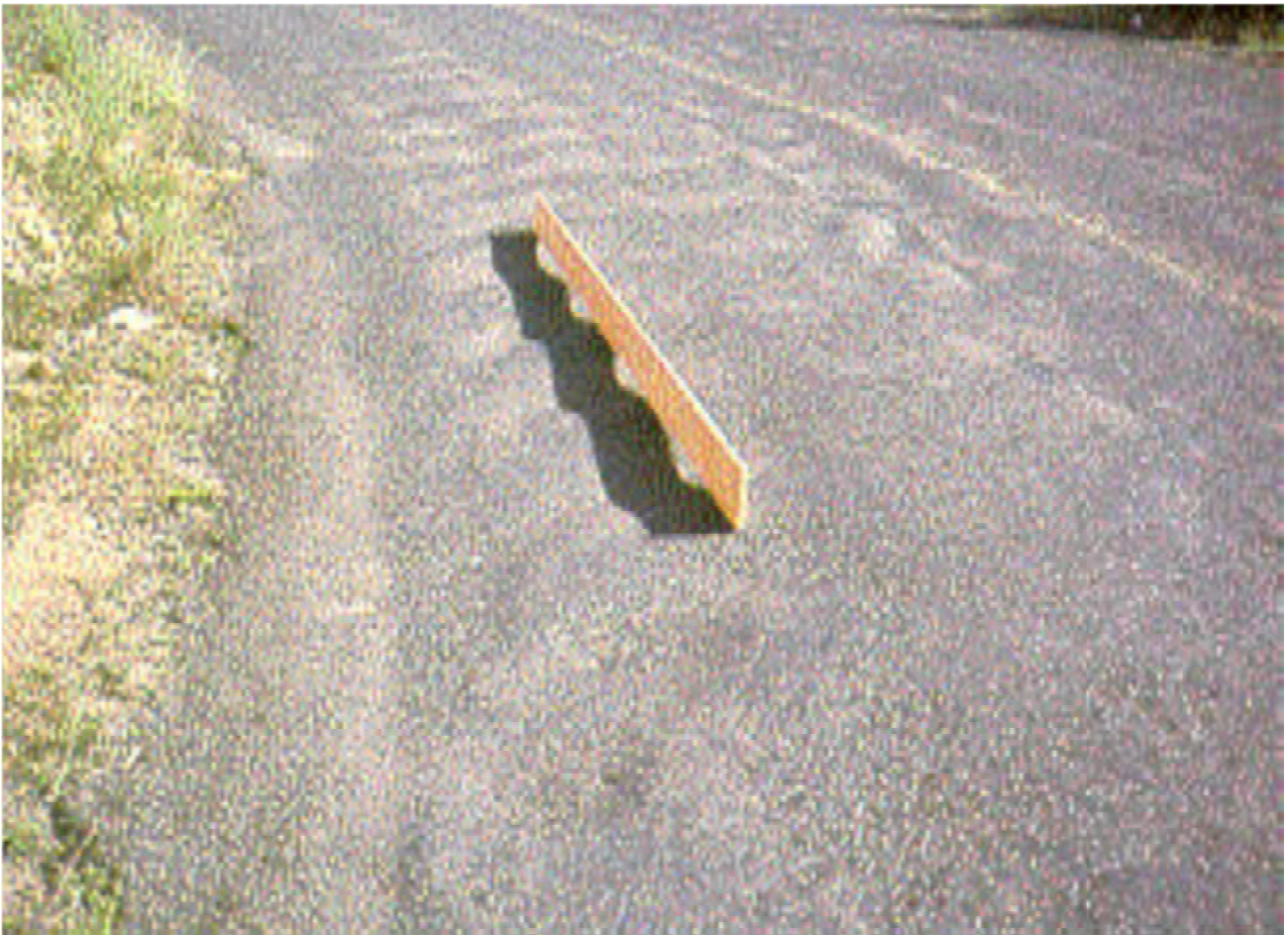
Εικόνα 2.14 Ρυτιδώσεις σε οδόστρωμα (διαδίκτυο)
