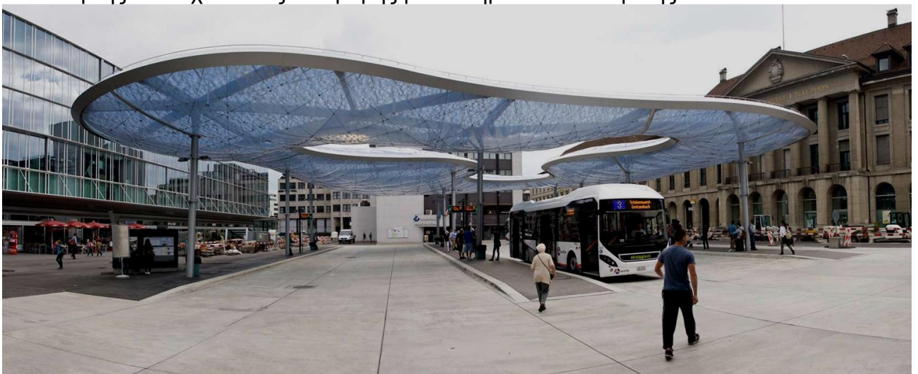
Εικόνα 90: Τερματικός σταθμός λεωφορείων στην Ελβετία.
