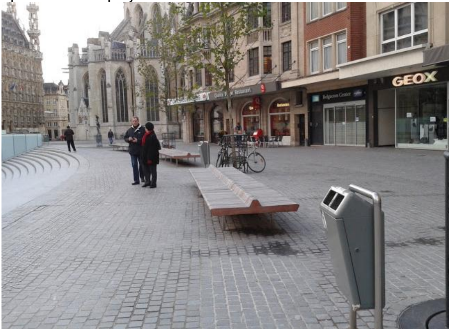
Εικόνα 93: Επίστρωση κυβόλιθων σε πεζόδρομο στη Leuven του Βελγίου.
