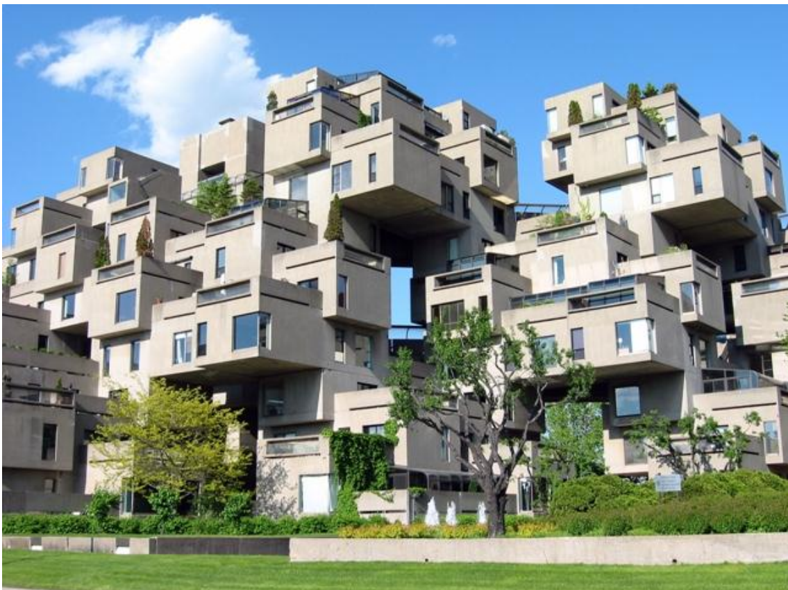
Εικόνα 123: Βιοκλιματικό συγκρότημα κατοικιών στο Montréal του Καναδά, σε μία ογκοπλαστικά ιδιότυπη ενδιαφέρουσα διάρθρωση που μοιάζει να αιωρείται.
