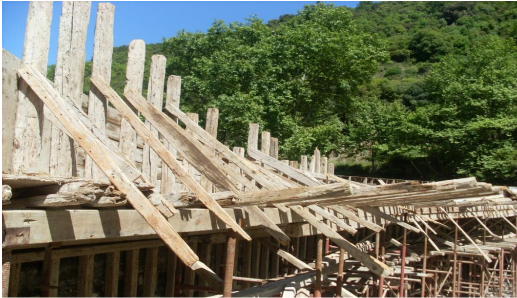
ΦΩΤΟΓΡΑΦΙΑ 6.7 ΛΕΠΤΟΜΕΡΕΙΑ ΤΩΝ ΙΚΡΙΩΜΑΤΩΝ ΠΟΥ ΧΡΗΣΙΜΟΠΟΙΗΘΗΚΑΝ ΚΑΤΑ ΤΗΝ ΚΑΤΑΣΚΕΥΗ ΤΟΥ ΚΑΤΑΣΤΡΩΜΑΤΟΣ.
