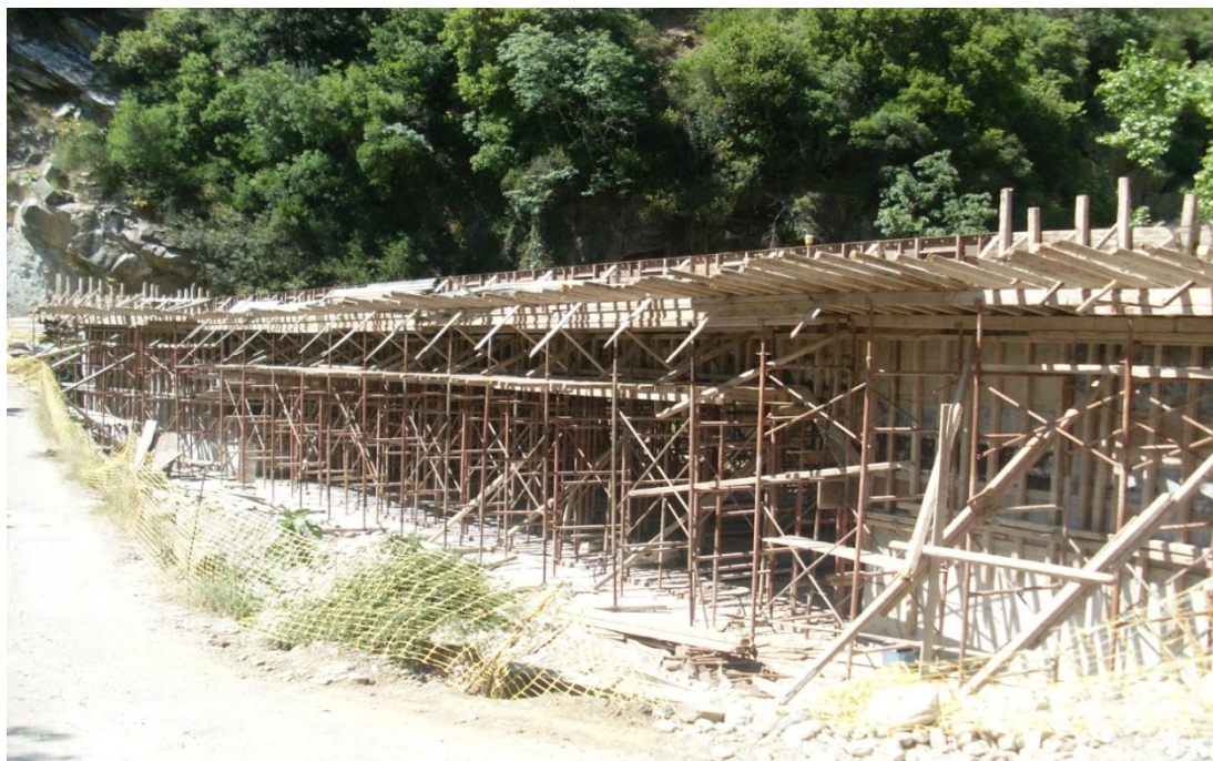
ΦΩΤΟΓΡΑΦΙΑ 2.1 ΚΑΤΑΣΚΕΥΗ ΠΤΕΡΥΓΟΤΟΙΧΟΥ ΣΤΗ ΣΥΝΕΧΕΙΑ ΤΟΥ ΑΚΡΟΒΑΘΡΟΥ ΑΡΙΣΤΕΡΟΥ ΚΛΑΔΟΥ ΓΕΦΥΡΑΣ
