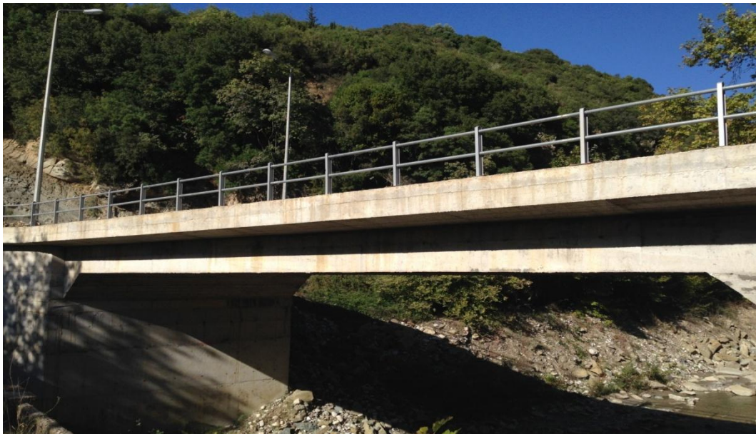
ΦΩΤΟΓΡΑΦΙΑ 6.2 ΝΟΤΙΟΑΝΑΤΟΛΙΚΗ ΑΠΟΨΗ ΤΟΥ ΚΑΤΑΣΤΡΩΜΑΤΟΣ ΚΑΙ ΑΚΡΟΒΑΘΡΟΥ ΤΗΣ ΓΕΦΥΡΑΣ.
