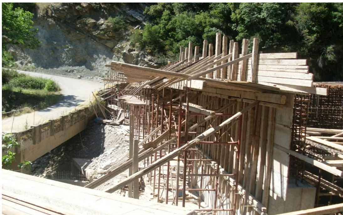
ΦΩΤΟΓΡΑΦΙΑ 1.1 ΑΠΟΨΗ ΚΑΤΑΣΚΕΥΗΣ ΝΕΑΣ ΓΕΦΥΡΑΣ ΠΑΡΑΠΛΕΥΡΩΣ ΤΗΣ ΥΦΙΣΤΑΜΕΝΗΣ ΓΕΦΥΡΑΣ
