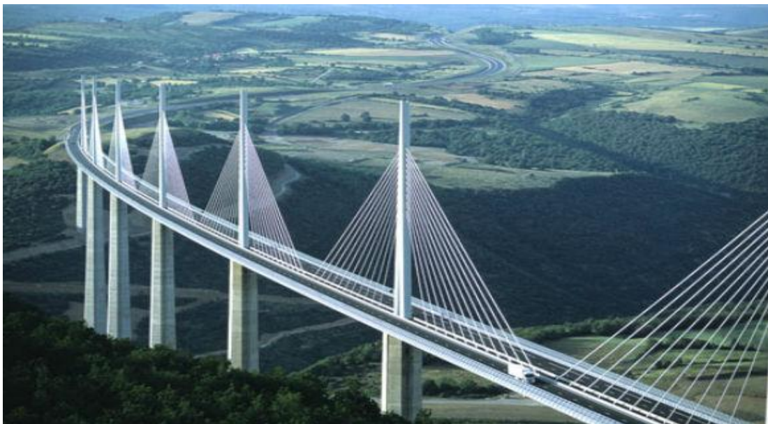
ΦΩΤΟΓΡΑΦΙΑ 2.9 ΓΕΦΥΡΑ ΣΤΗ ΓΑΛΛΙΑ(MILLAU-VIADUCT)
