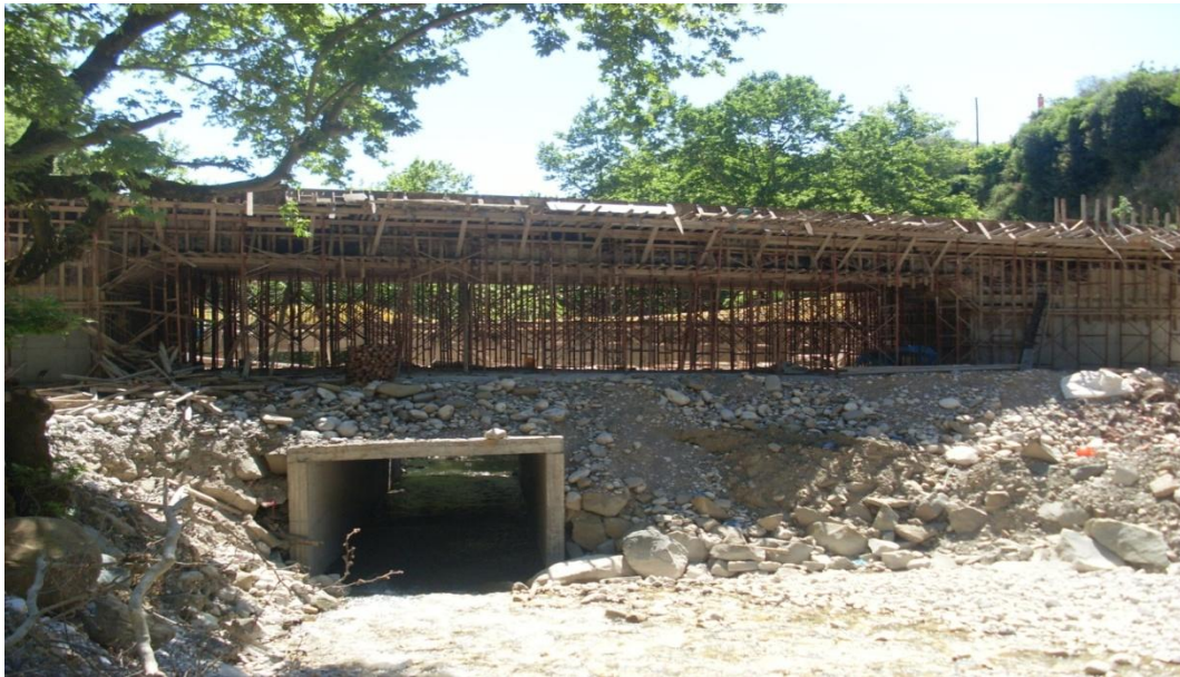
ΦΩΤΟΓΡΑΦΙΑ 6.8 ΒΟΡΕΙΑ ΑΠΟΨΗ ΤΗΣ ΓΕΦΥΡΑΣ ΠΡΙΝ ΤΗ ΣΚΥΡΟΔΕΤΗΣΗ ΤΟΥ ΚΑΤΑΣΤΡΩΜΑΤΟΣ ΟΠΟΥ ΔΙΑΚΡΙΝΕΤΑΙ ΤΟ ΠΥΚΝΟ ΣΥΣΤΗΜΑ ΙΚΡΙΩΜΑΤΩΝ ΠΟΥ ΧΡΗΣΙΜΟΠΟΙΗΘΗΚΕ.
