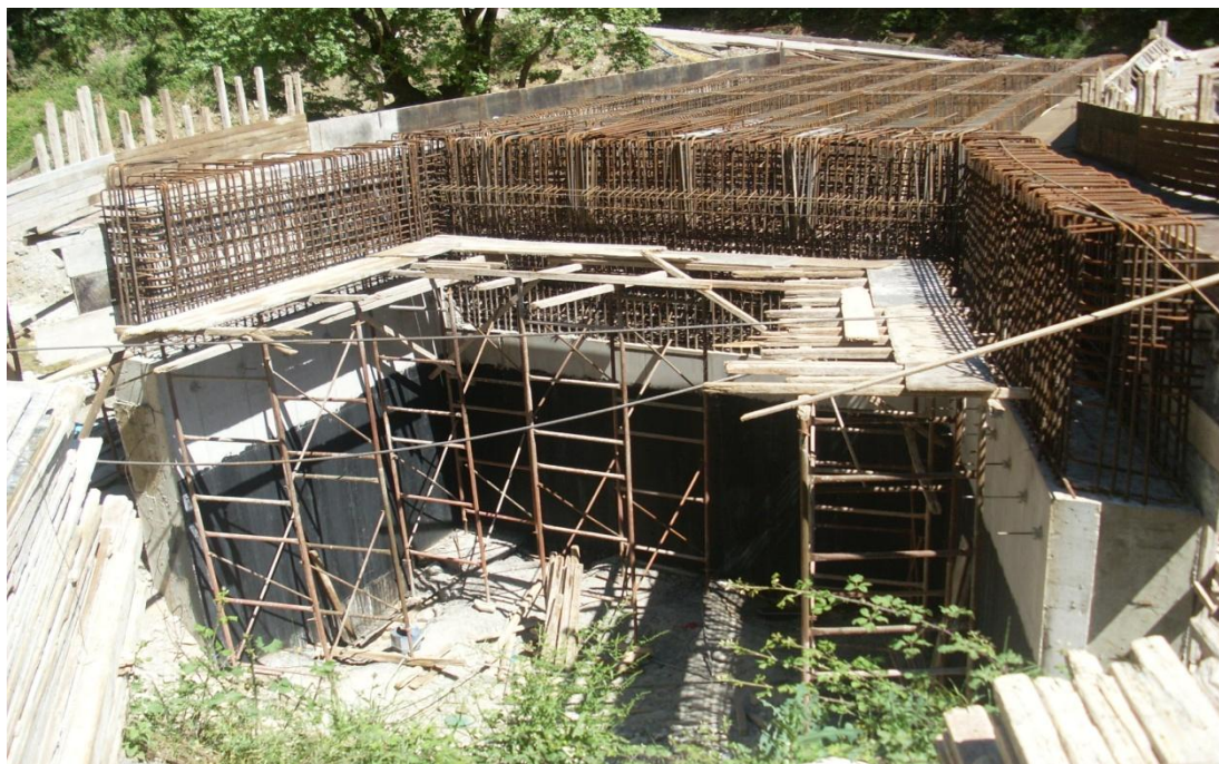
ΦΩΤΟΓΡΑΦΙΑ 2.2 ΚΑΤΑΣΚΕΥΗ ΑΚΡΟΒΑΘΡΟΥ ΓΕΦΥΡΑΣ
