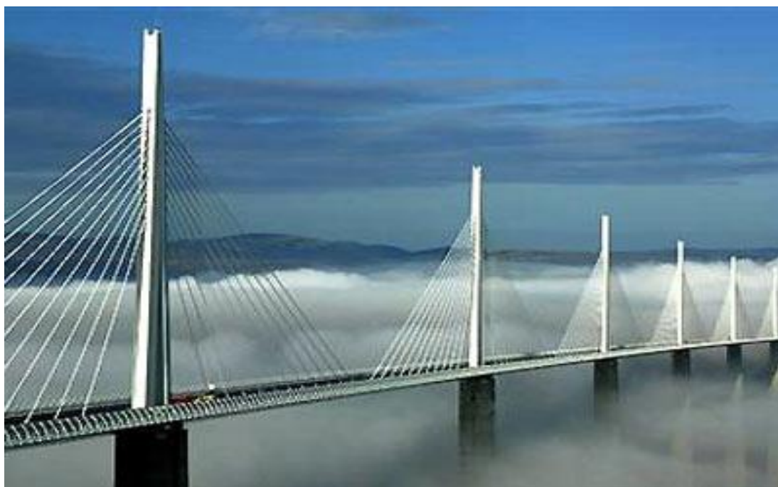
ΦΩΤΟΓΡΑΦΙΑ 2.16 ΓΕΦΥΡΑ ΣΤΗ ΓΑΛΛΙΑ
