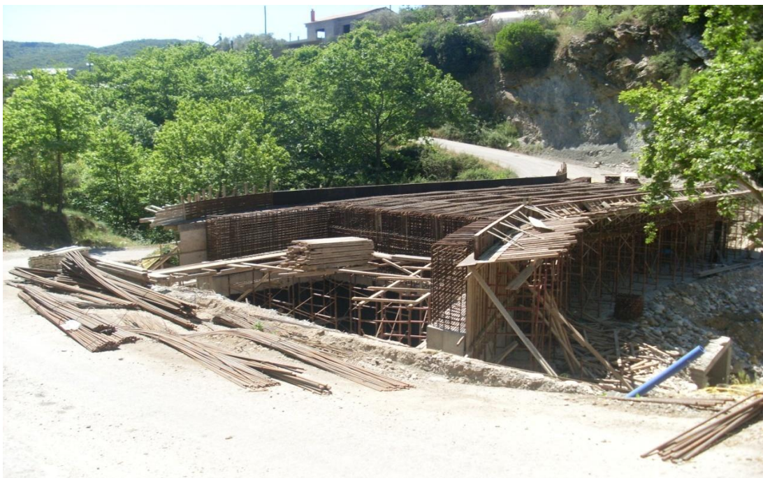
ΦΩΤΟΓΡΑΦΙΑ 1.2 ΘΕΣΗ ΣΗΜΕΙΟΥ ΔΙΑΚΟΠΗΣ ΤΗΣ ΚΥΚΛΟΦΟΡΙΑΣ ΓΙΑ ΤΗΝ ΚΑΤΑΣΚΕΥΗ ΤΗΣ ΓΕΦΥΡΑΣ.
