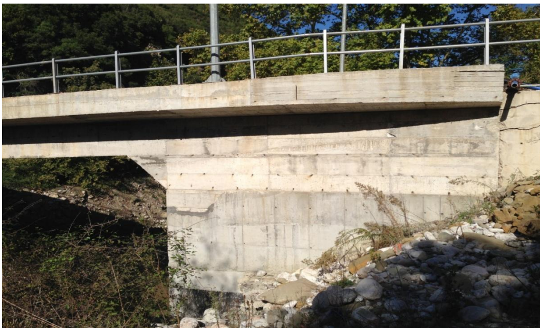
ΦΩΤΟΓΡΑΦΙΑ 6.3 ΝΟΤΙΑ ΑΠΟΨΗ ΓΕΦΥΡΑΣ ΚΑΙ ΤΟΥ ΤΟΙΧΟΥ ΑΝΤΕΠΙΣΤΡΟΦΗΣ ΤΟΥ ΑΝΑΤΟΛΙΚΟΥ ΑΚΡΟΒΑΘΡΟΥ.
