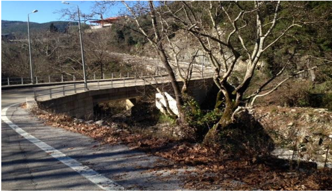
ΦΩΤΟΓΡΑΦΙΑ 6.1 ΒΟΡΕΙΟΑΝΑΤΟΛΙΚΗ ΑΠΟΨΗ ΤΗΣ ΓΕΦΥΡΑΣ.
