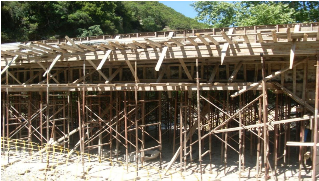
ΦΩΤΟΓΡΑΦΙΑ 6.10 ΝΟΤΙΑ ΑΠΟΨΗ ΤΟΥ ΚΑΤΑΣΤΡΩΜΑΤΟΣ ΚΑΤΑ ΤΗ ΦΑΣΗ ΤΗΣ ΚΑΤΑΣΚΕΥΗΣ ΤΗΣ ΓΕΦΥΡΑΣ ΚΑΙ ΠΡΙΝ ΤΗ ΣΚΥΡΟΔΕΤΗΣΗ ΤΟΥ.
