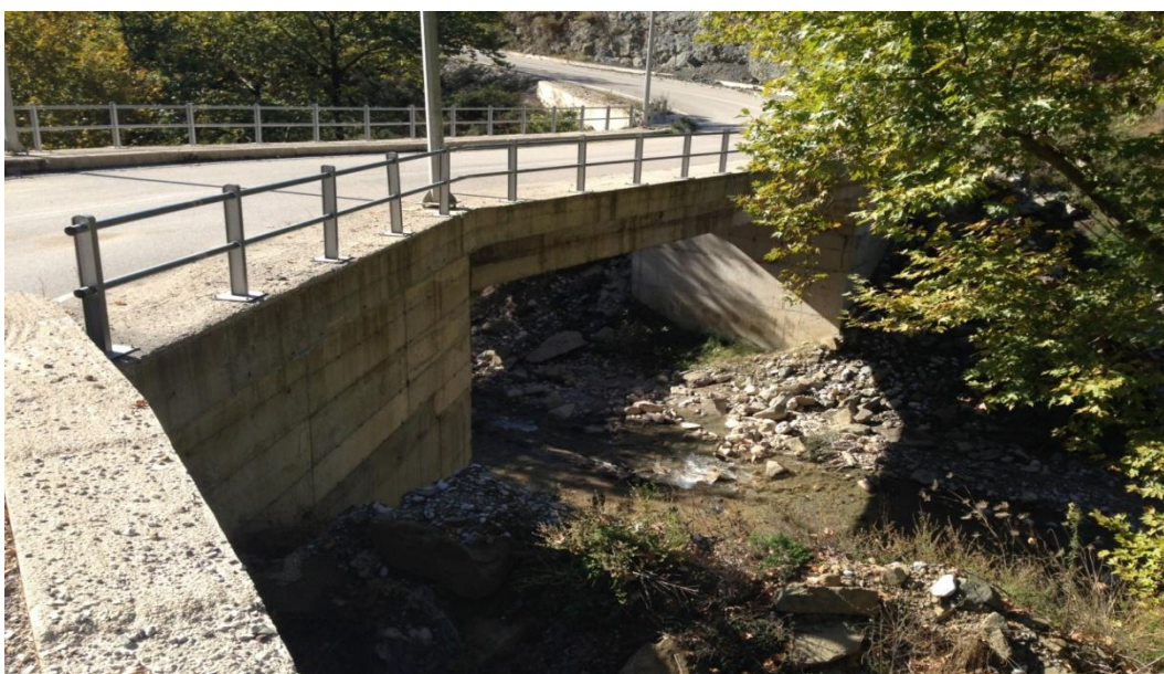
ΦΩΤΟΓΡΑΦΙΑ 6.4 ΒΟΡΕΙΟΑΝΑΤΟΛΙΚΗ ΑΠΟΨΗ ΤΗΣ ΓΕΦΥΡΑΣ.
