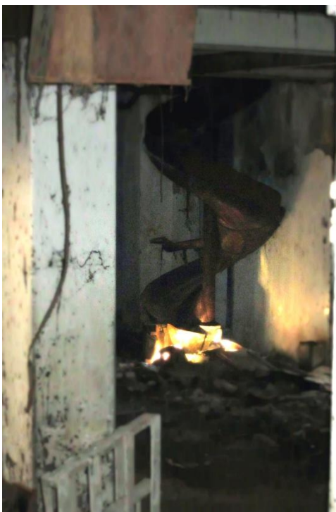
Τσουλήθρα μεταφοράς εμπορευμάτων
