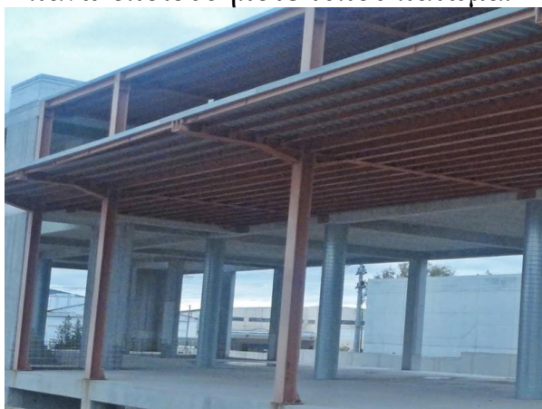
Αποψη 1 σύμμικτης κατασκευής
