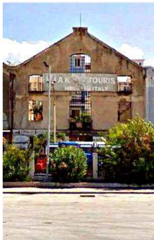
Σταφιδαποθήκες Μπάρρυ όψη Όθωνος Αμαλίας
