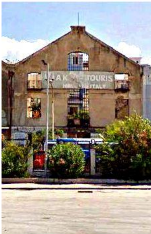
Σταφιδαποθήκες Μπάρρυ όψη Όθωνος Αμαλίας
