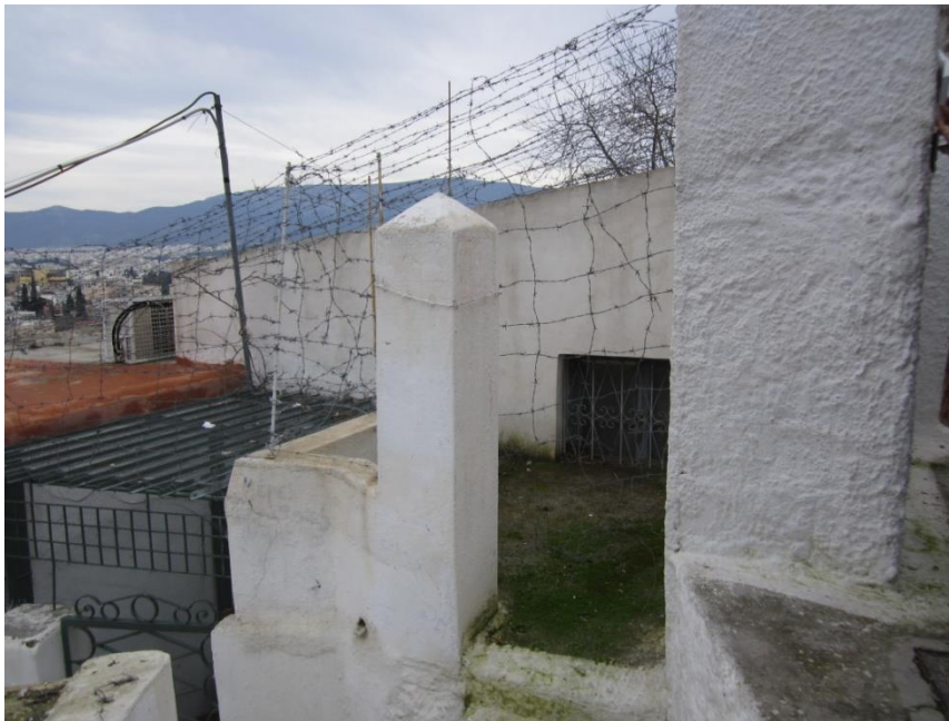
Δελτίο 21. Αριθμός Κτηρίου27
