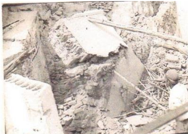
Εικόνα 2. Φωτογραφία από τις κατεδαφίσεις.
