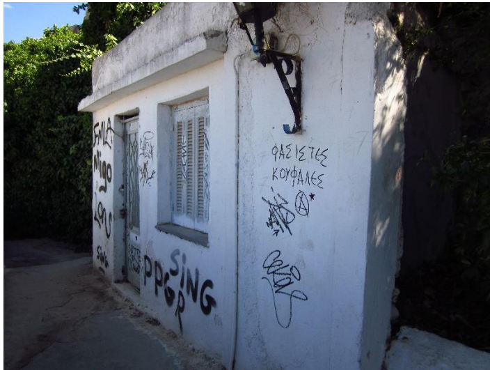
Δελτίο 57. Αριθμός Κτηρίου 71
