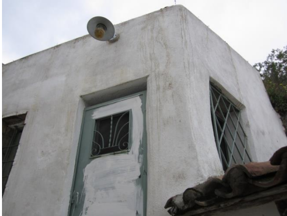
Δελτίο 20. Αριθμός Κτηρίου26
