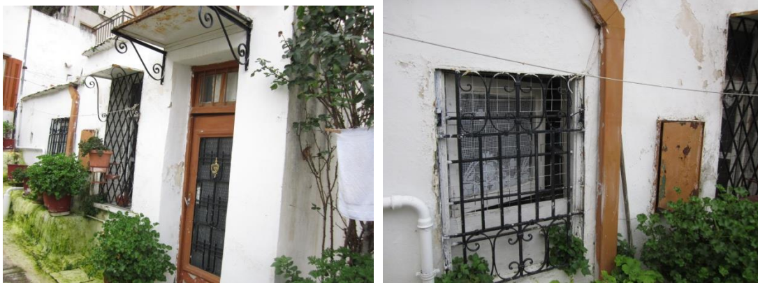
Δελτίο 14. Αριθμός Κτηρίου20
