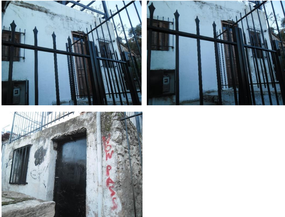
Δελτίο 54. Αριθμός Κτηρίου 11
