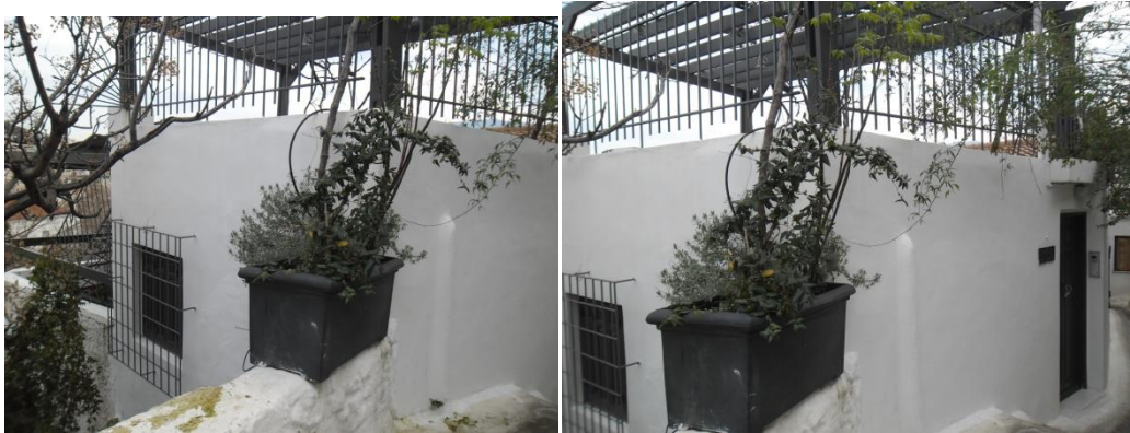
Δελτίο 6. Αριθμός Κτηρίου31-32
