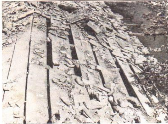
Φωτ. 197. Το σκελετό του 72, μετά από αφαίρεση των κεραμιδιών.
