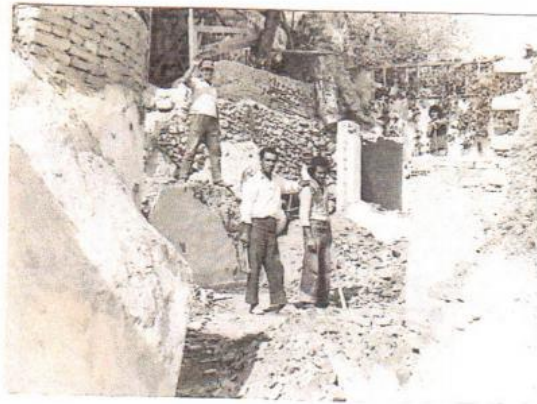
Φωτ. 195 Μετά την καταστροφή σου 67.
