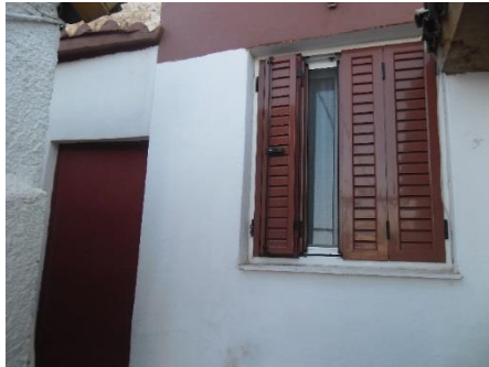
Δελτίο 41. Αριθμός Κτηρίου 50
