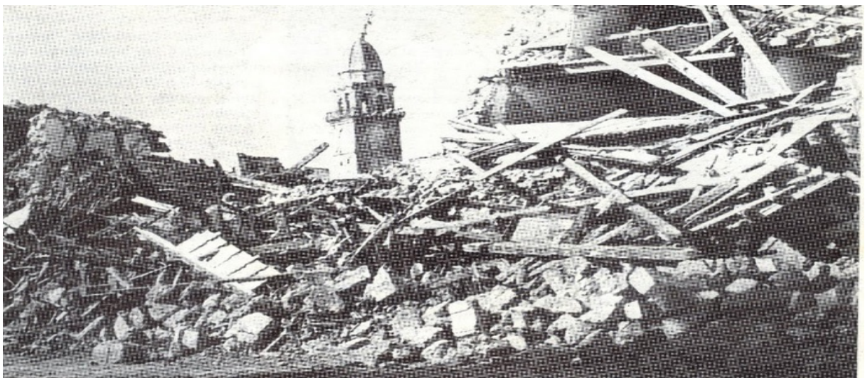
Εικόνα 1.1 Η ολοσχερώς κατεστραμμένη εκκλησία της Παναγίας της Φανερωμένης στη Ζάκυνθο από το φοβερό σεισμό της Κεφαλονιάς το 1953
