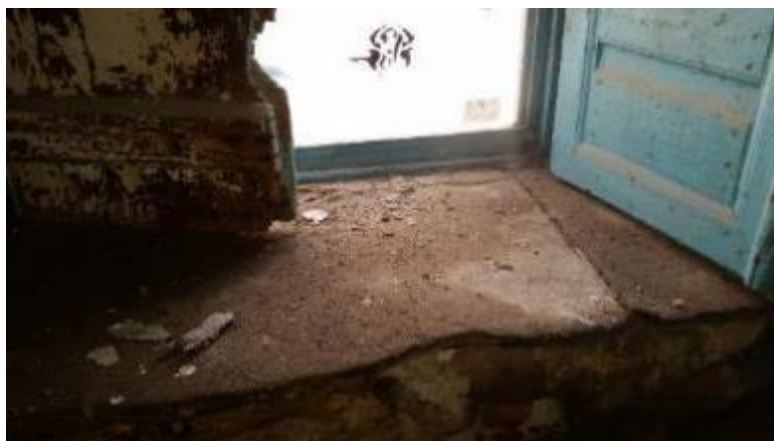
Εικόνα 84: Ποδιά από σχιστόπλακα σε παράθυρο του υπογείου.
