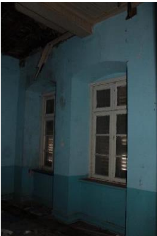
Εικόνα 123: Έδραση του μεσοδόκαρου πάνω από το άνοιγμα.
