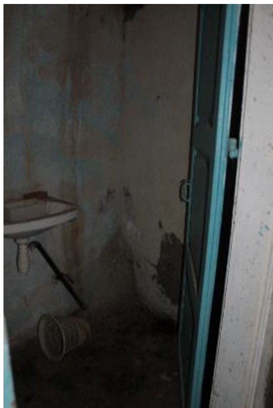
Εικόνα 19: Χώρος Υ10 πίσω από το κλιμακοστάσιο της Νότιας εισόδου.
