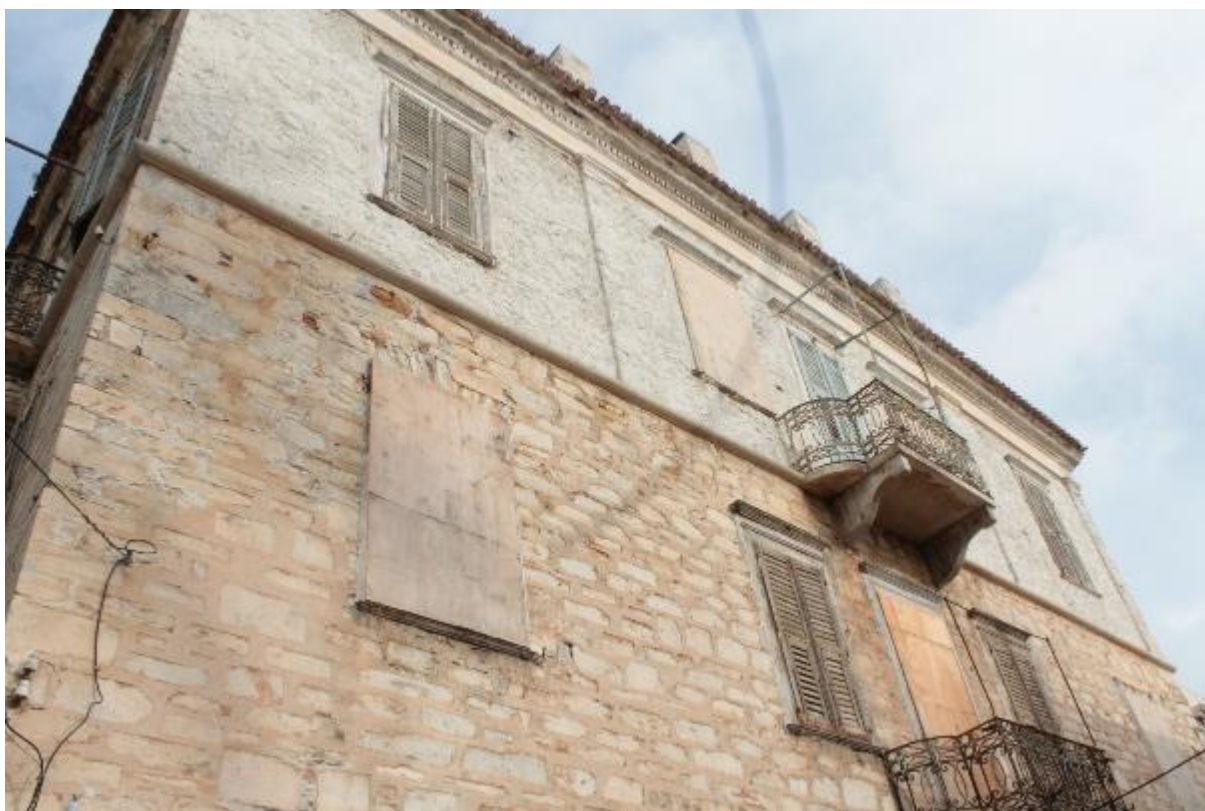
Εικόνα 60: Η εξωτερική τοιχοποιία της νότιας όψης.
