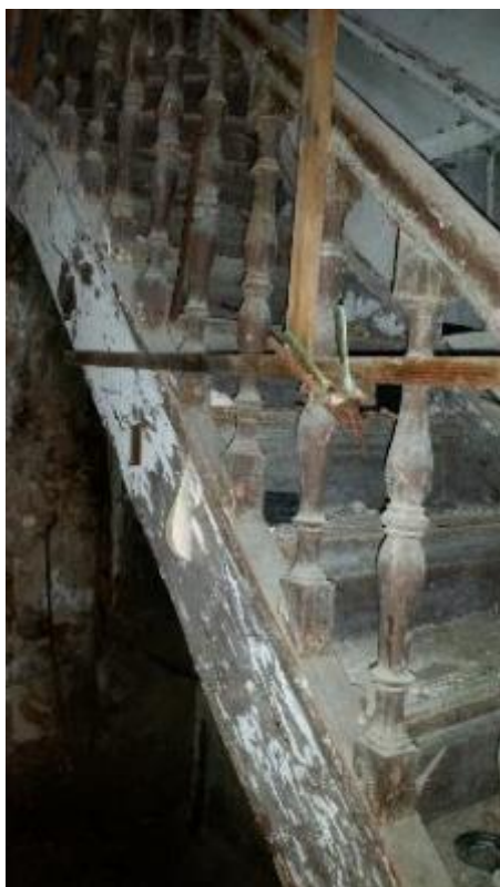
Εικόνα 97: Λεπτομέρεια κλίμακας νότιας εισόδου στον χώρο Υ1.
