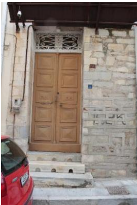
Εικόνα 80: Η εξωστόθυρα της βορεινής εισόδου.
