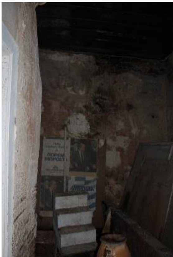
Εικόνα 18: Χώρος Υ9 πίσω από το κλιμακοστάσιο της Νότιας εισόδου.
