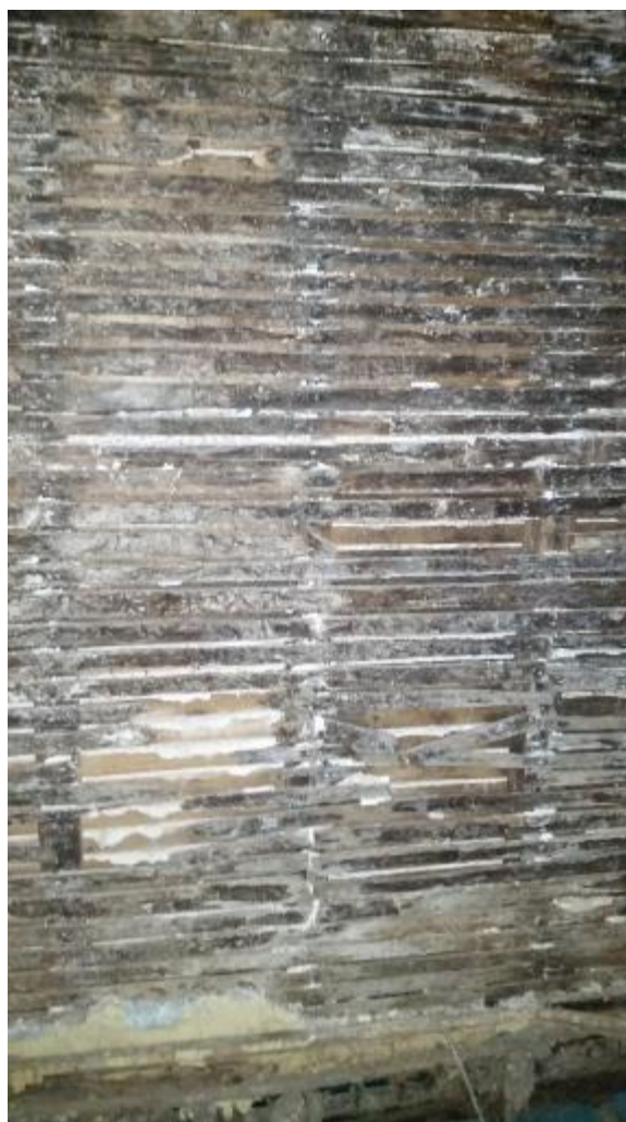
Εικόνα 65: Εσωτερική τοιχοποιία από τσατμά μεταξύ των χώρων Α7 και Α8 του Α' ορόφου. Διακρίνονται οι κάθετοι οδηγοί επικαλυμμένοι με οριζόντιο σανίδωμα.
