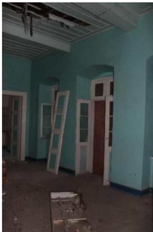
Εικόνα 26: Χώρος I3, η σάλα του ισογείου.
