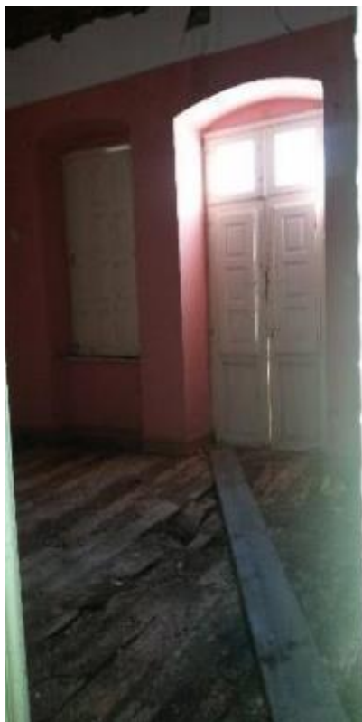
Εικόνα 132: Το δάπεδο του χώρου Α6 στον όροφο.
