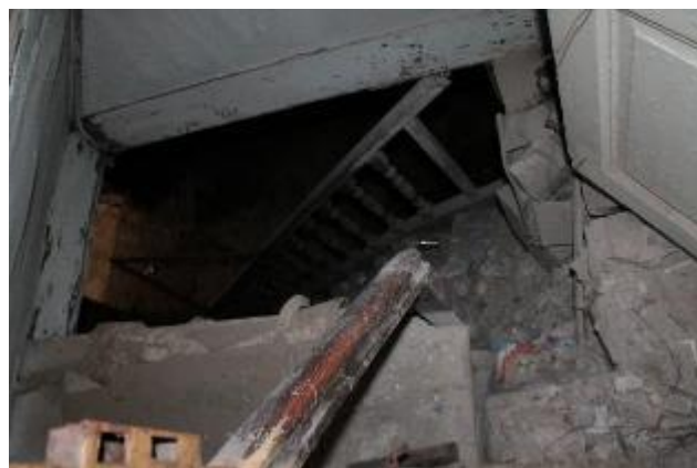
Εικόνα 28: Το κλιμακοστάσιο καθόδου προς τον υπόγειο χώρο Y8 από το κλιμακοστάσιο στον χώρο 16.
