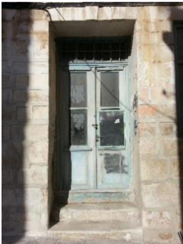
Εικόνα 139: Νότια όψη, είσοδος στον χώρο Υ2.
