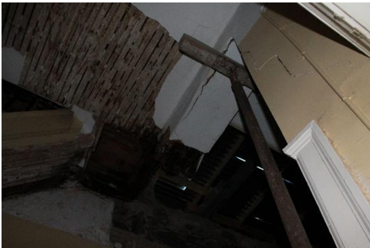
Εικόνα 125: Υποστύλωση εναπομείναντα τμήματος κεντρικής δοκού στην οροφή του ορόφου.
