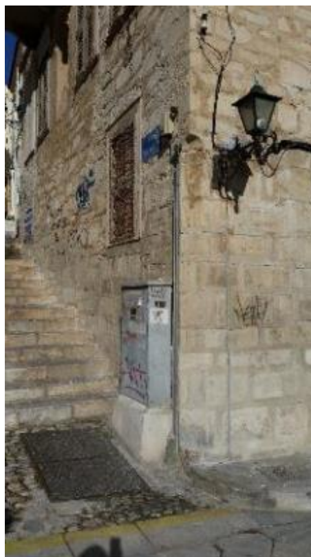
Εικόνα 104: Λοξοτομημένοι ακρογωνιαίοι μαρμαρόλιθοι στην νοτιοδυτική γωνία του κτηρίου.
