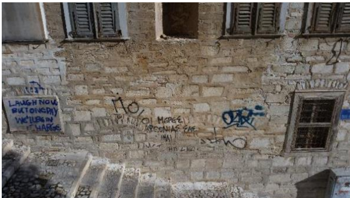
Εικόνα 45: Η δυτική όψη του υπογείου επί της οδού Ιωάννου Φωτίου. Διακρίνονται δύο ανακουφιστικά τόξα στο μέσο της όψης.
