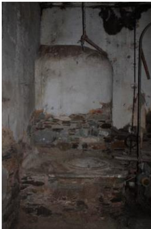
Εικόνα 56: Ο κρίκος ανάρτησης του κουβά βρίσκεται πάνω από το στόμιο του πηγαδιού. Διακρίνεται η νέα ηλεκτρική αντλία υδροληψίας.
