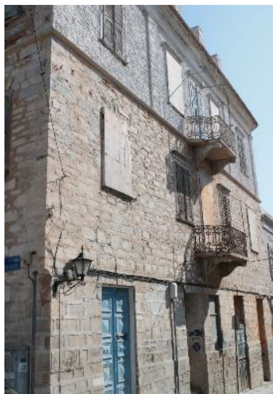
Εικόνα 39: Η νότια όψη. Το σαρδελωτό κονίαμα συνεχίζεται και στο επίπεδο του υπογείου.
