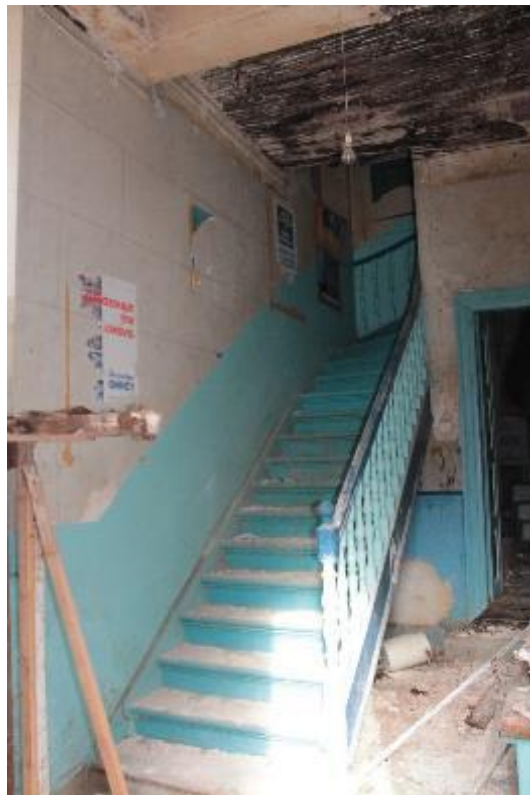
Εικόνα 48 Η κλίμακα της νότιας εισόδου.
