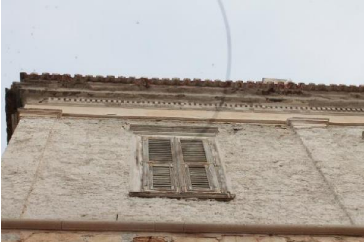
Εικόνα 122: Σοβατισμένος όροφος με πεταχτό τσιμεντοκονίαμα.
