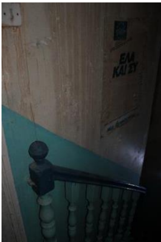
Εικόνα 100: Το δεξί (κατά την ανάβαση) κιγκλιδωμά της κλίμακας της νότιας εισόδου.
