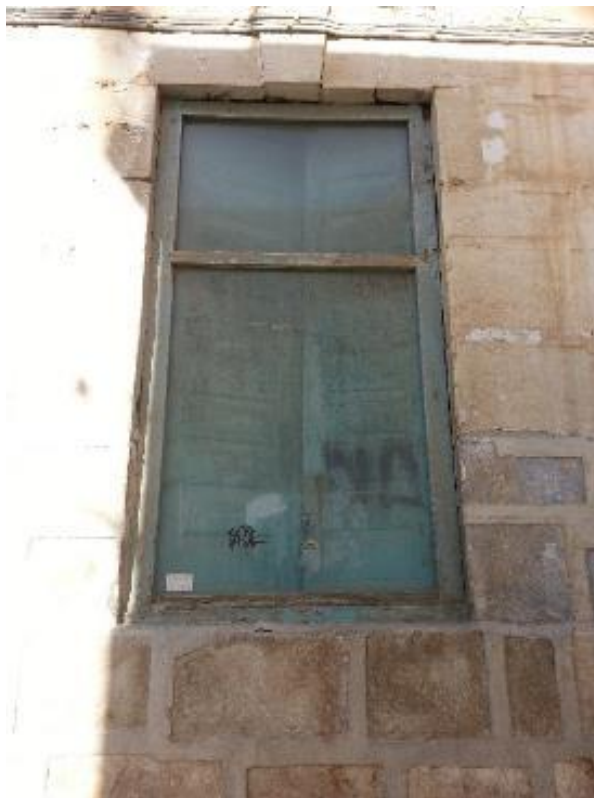
Εικόνα 140: Νότια όψη, παράθυρο χώρου Υ2.
