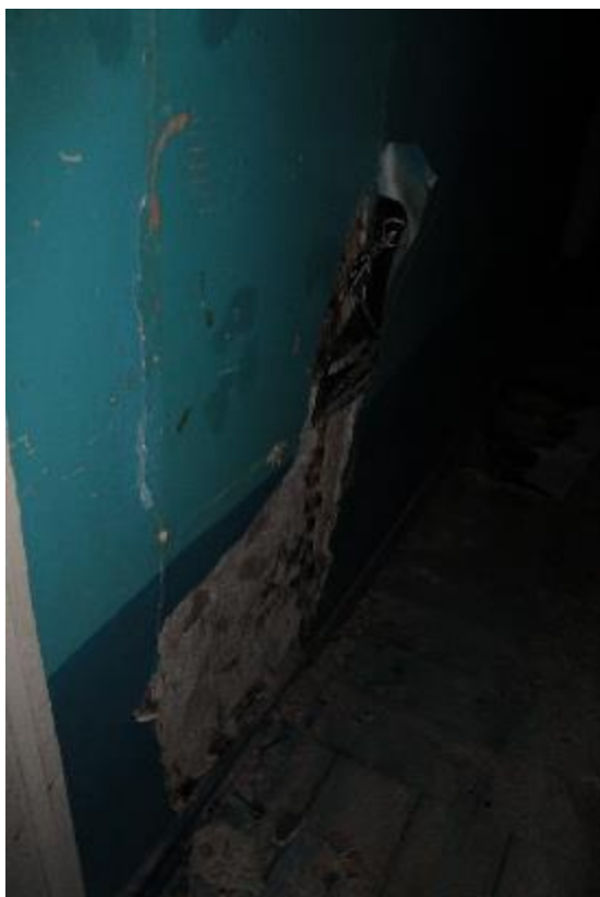
Εικόνα 109: Εφαρμογή χρωματισμού με πλαστικά χρώματα στο ισόγειο, στον χώρο 11.
