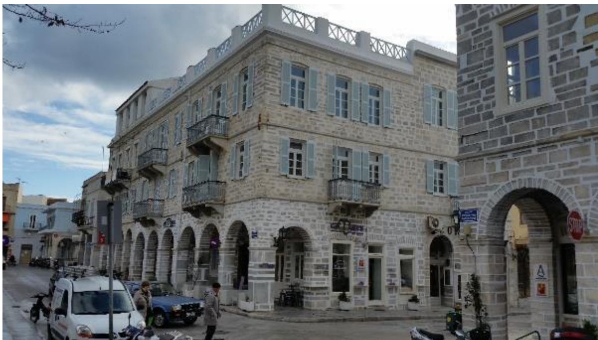
Εικόνα 11: Τα κτίρια στη νότια πλευρά της πλατείας με τις στοές, τα πυκνά ανοίγματα και την χαρακτηριστική αρμολογημένη τοιχοποιία.
