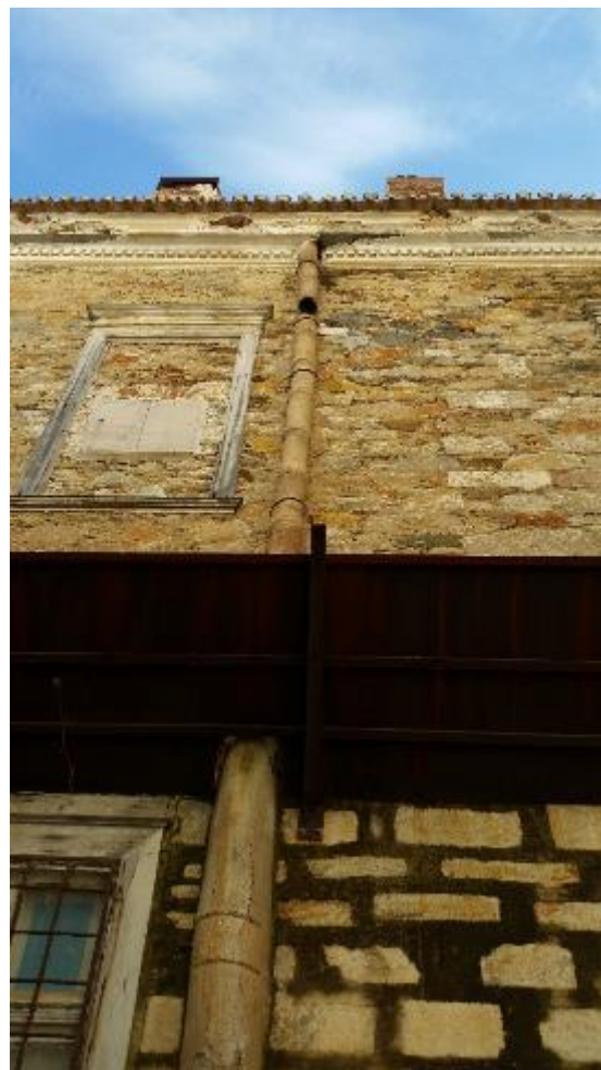
Εικόνα 46: Η κεραμική υδρορροή στην βόρεια όψη.
