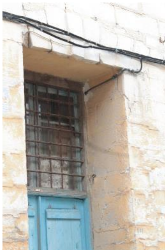
Εικόνα 141: Αποκόλληση θολιτών στο ανώφλι της θύρας.
