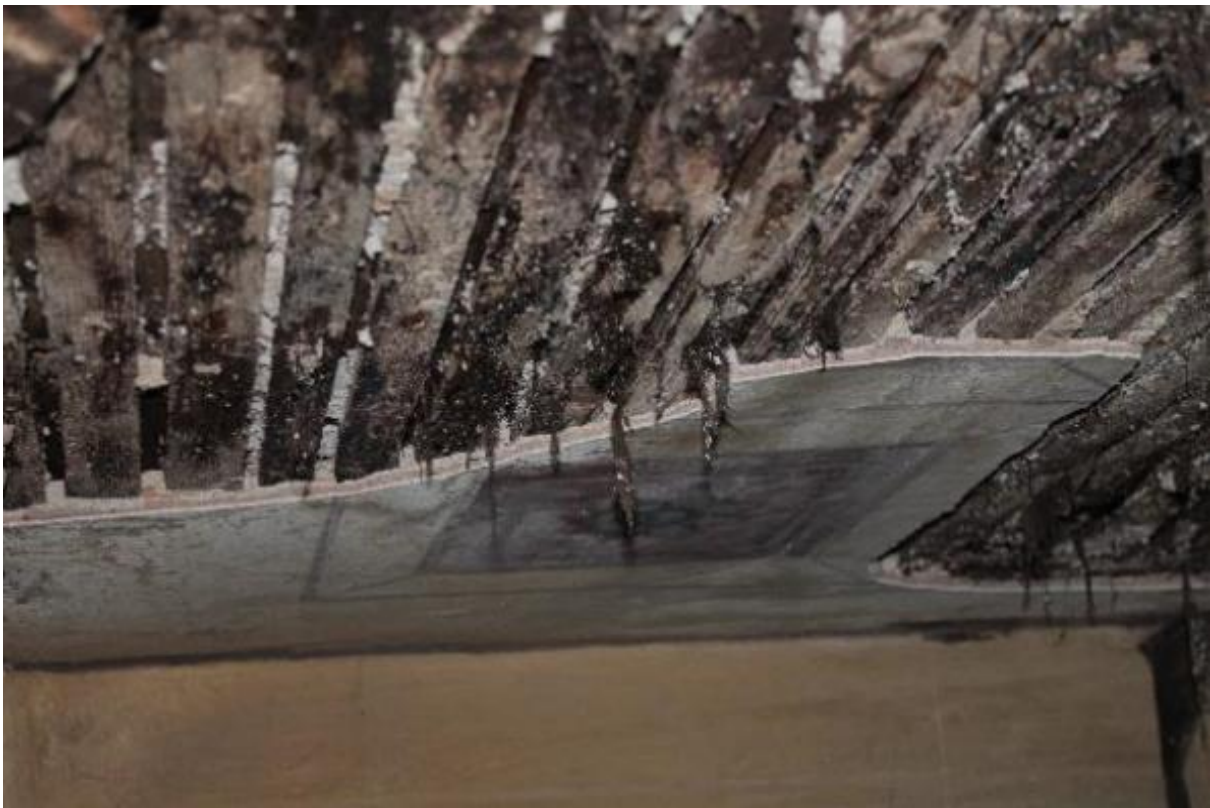
Εικόνα 145: Λεπτομέρεια οροφोगραφίας. Αποκόλληση και προσβολή από την υγρασία στο εναπομείναν τμήμα. χρωματισμένη όψη, όπως οι διακοσμητικές κορνίζες των οροφών. Αντίθετα, οι ξύλινες διακοσμήσεις στις εξωστόθυρες δεν έχουν προσβληθεί σε τέτοιο μεγάλο βαθμό εξαιτίας του
