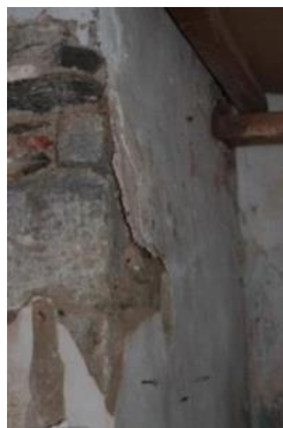
Εικόνα 128: Αποκόλληση επιχρίματος.
