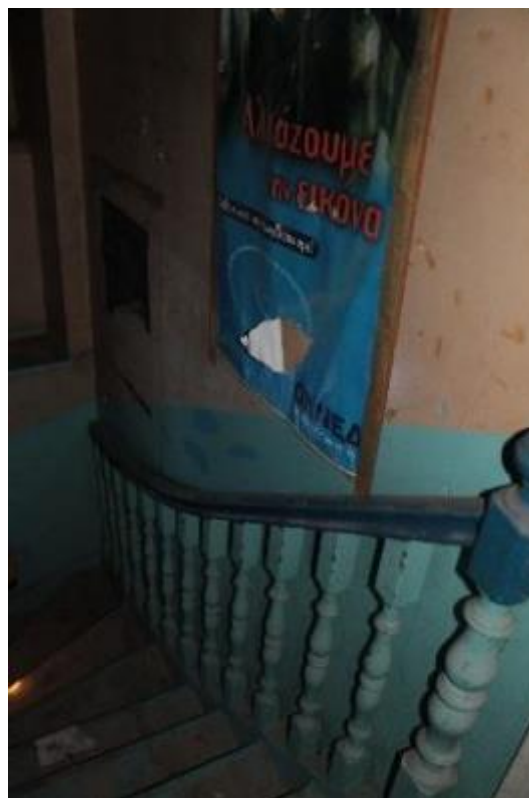
Εικόνα 101: Το αριστερό κιγκλιδωμά της κλίμακας της νότιας εισόδου.
