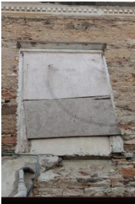
Εικόνα 116: Παράθυρο της βορεινής όψης. Διακρίνονται οι μεταγενέστερες εγκαταστάσεις αποχέτευσης στην εξωτερική επιφάνεια της τοιχοποιίας.
