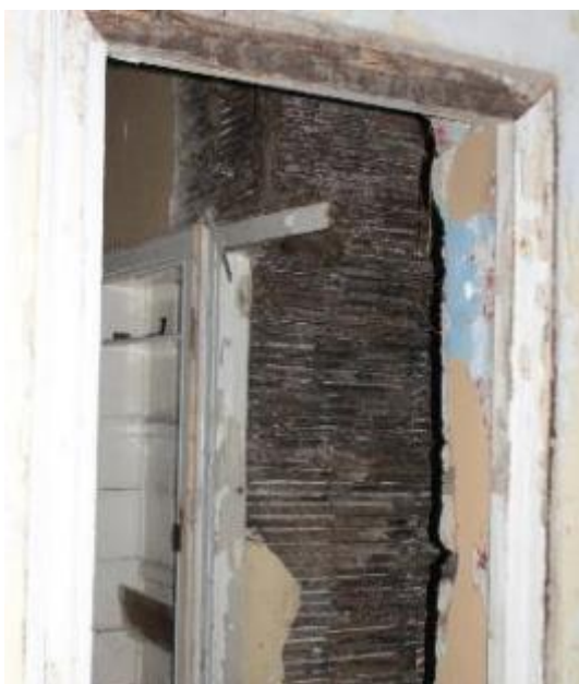
Εικόνα 126: Εσωτερική τοιχοποιία στον χώρο A9 του ορόφου.
