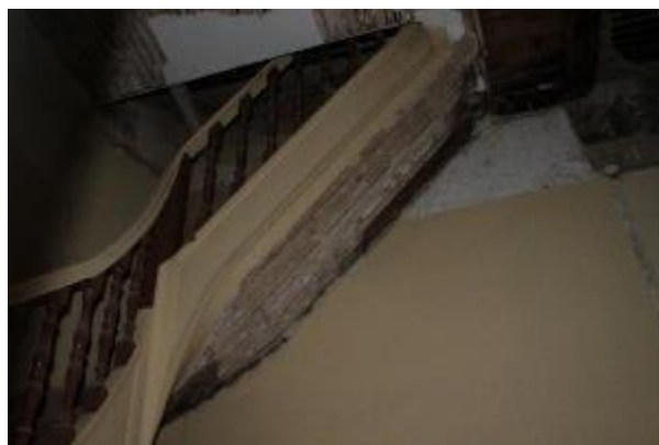
Εικόνα 35: Η κλίμακα ανόδου στο δώμα.
