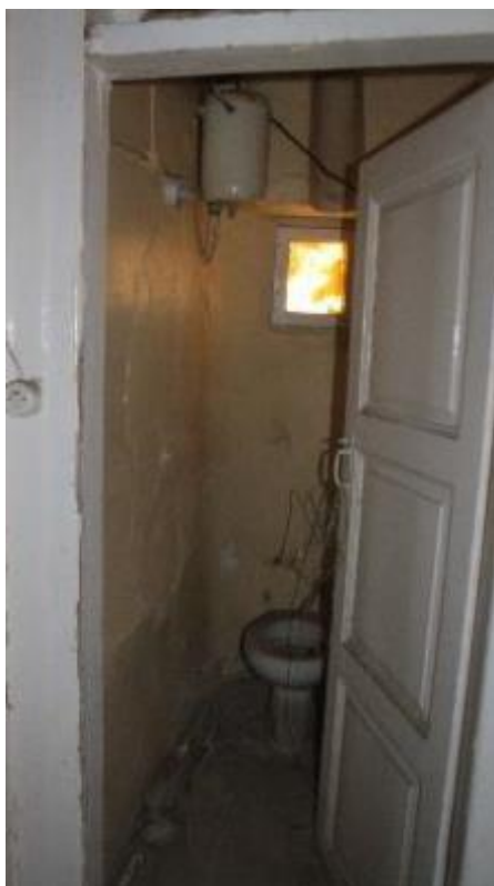
Εικόνα 54: Η υποδοχή της τρίτης υδροροής στην τοιχοποιία του χώρου Υ3 του Α' ορόφου.
