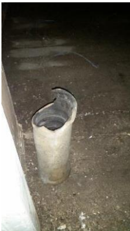
Εικόνα 53: Κεραμικός αγωγός.
