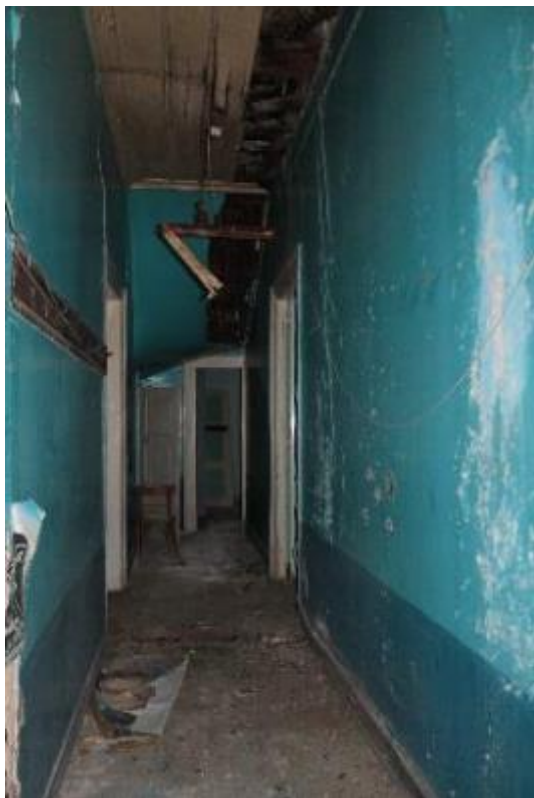
Εικόνα 24: Ο διάδρομος του Ισογείου, χώρος I1.
