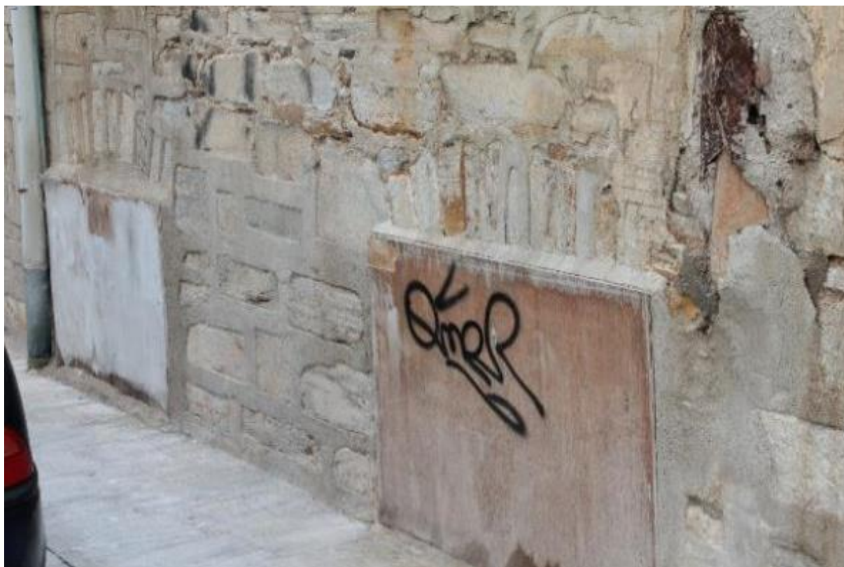
Εικόνα 136: Σφράγιση των κουφωμάτων του υπογείου στην βόρεια όψη.
