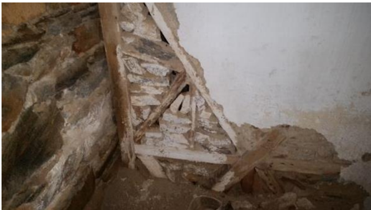
Εικόνα 66: Εσωτερική τοιχοποιία μεταξύ των χώρων Υ6 και Υ7 του υπογείου.
