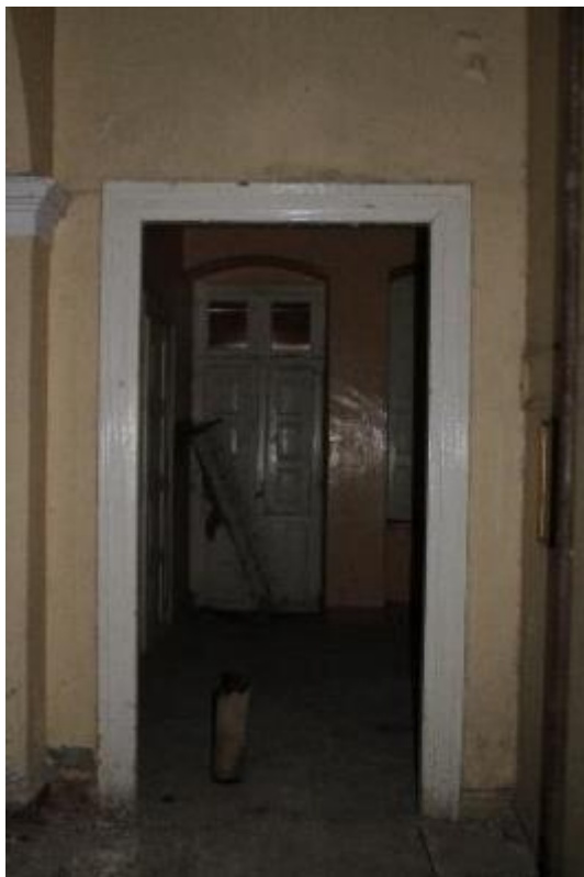
Εικόνα 30: Κεντρικός διάδρομος ορόφου (χώρος A1). Στο βάθος το υπνοδωμάτιο (χώρος A5).
