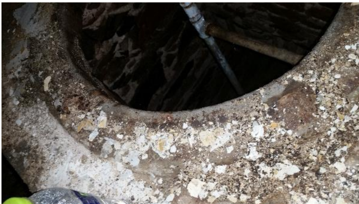
Εικόνα 118: Το εσωτερικό του πηγαδιού.
