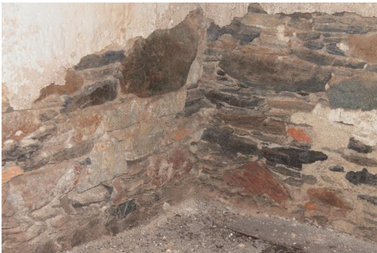
Εικόνα 61: Τμήμα της φέρουσας εσωτερικής λιθοδομής στον χώρο Υ2 του υπογείου.
