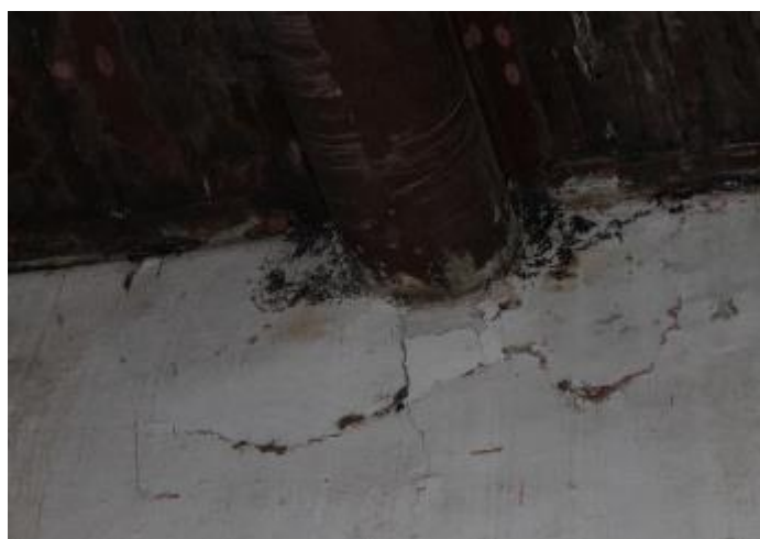
Εικόνα 64: Η έδραση του μεσοδόκαρου σε φωλιά της τοιχοποιίας.
