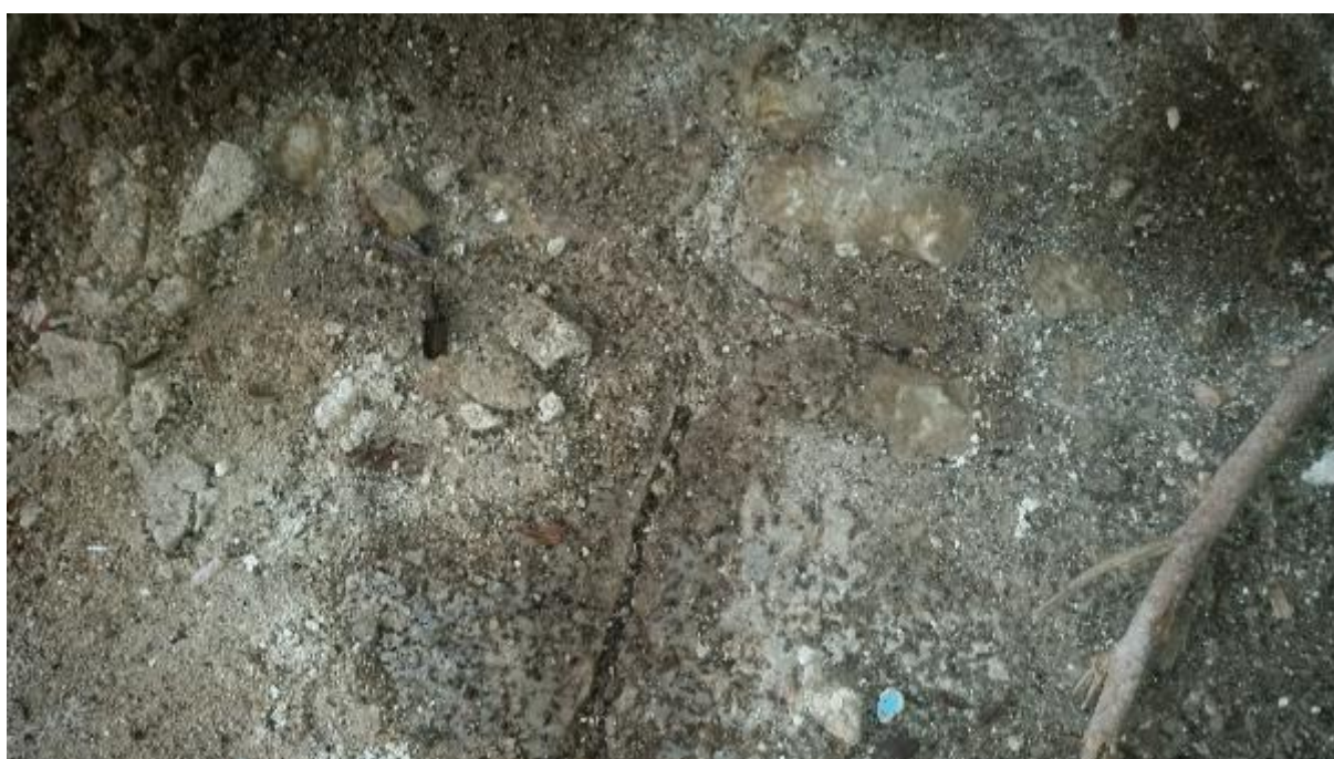
Εικόνα 76: Μαρμάρινο δάπεδο υπογείου στον χώρο Υ2.
