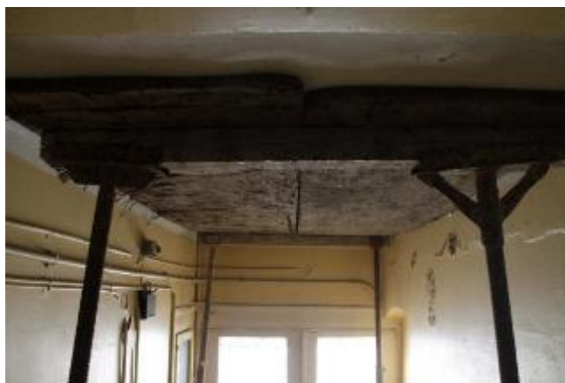
Εικόνα 75: Η οροφή την βορεινής εισόδου, χώρος 16.
