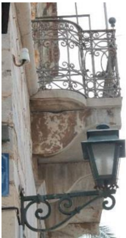
Εικόνα 99: Μεταλλικό κιγκλίδωμα στο μπαλκόνι της δυτικής όψης. Διακρίνονται τα καμπυλόγραμμα σχέδια που επαναλαμβάνονται σε όλο το μήκος.
