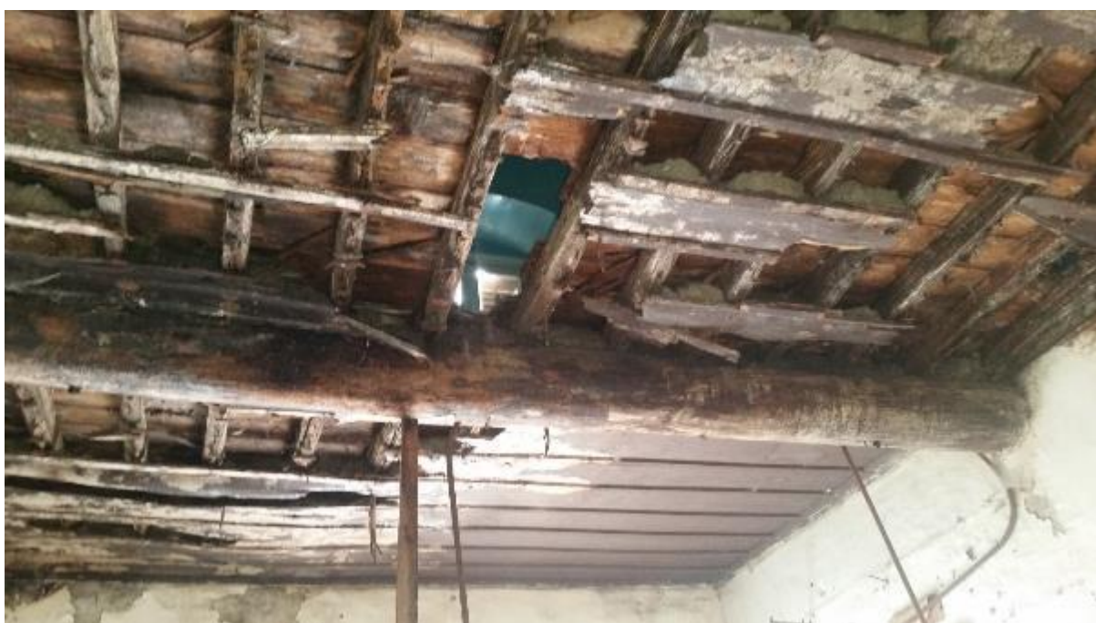
Εικόνα 63: Χαρακτηριστική κατασκευαστική δομή του οριζόντιου φέροντα οργανισμού. Χώρος Υ2 του υπογείου.
