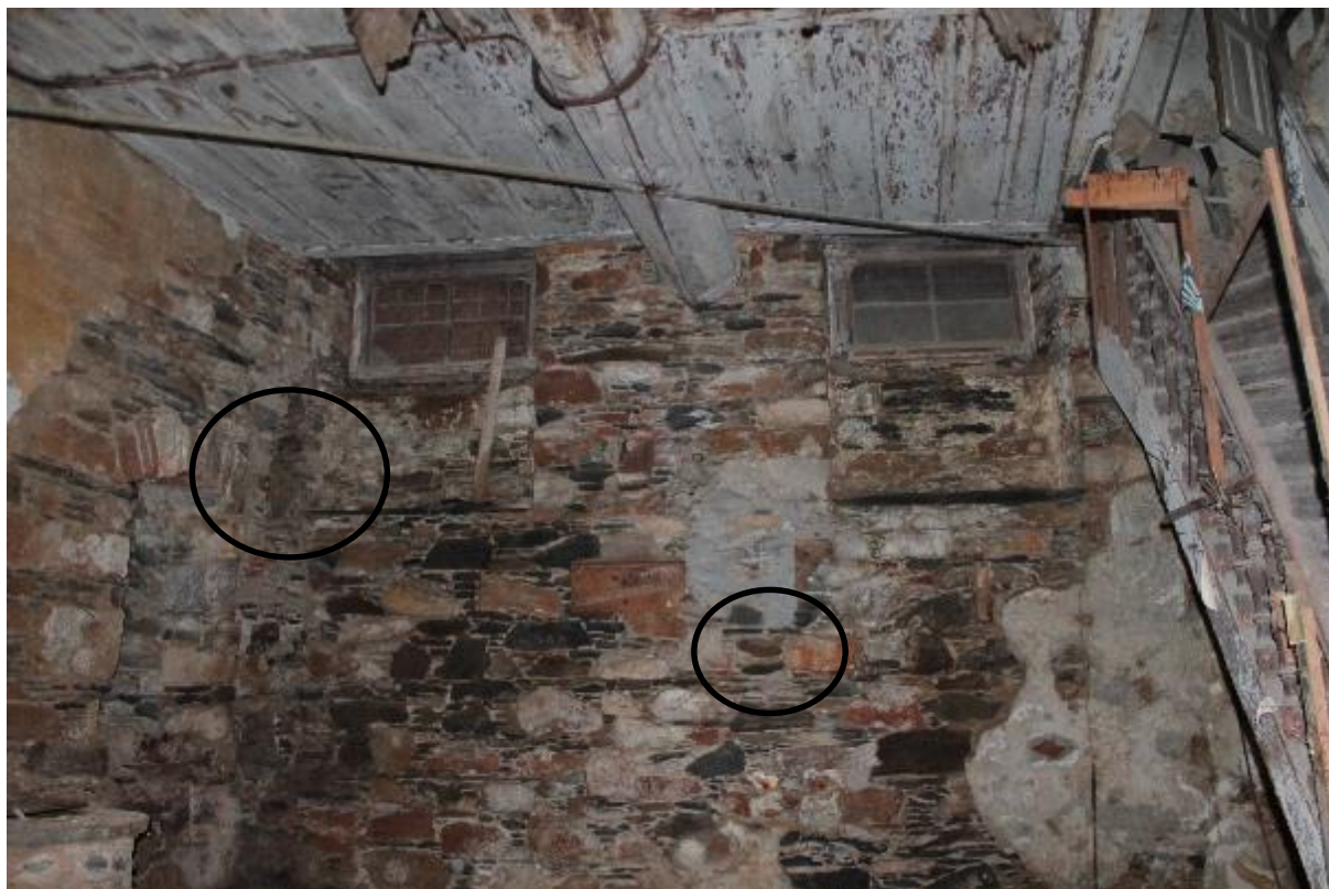
Εικόνα 57: Οι θέσεις εισόδου των υδρορροών στον χώρο Υ8 του υπογείου μέσω της εξωτερικής τοιχοποιίας.
