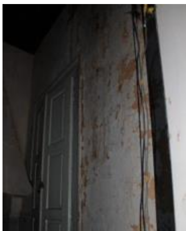
Εικόνα 68: Εσωτερικά επιχρίσματα στον χώρο 18 του ισογείου.
