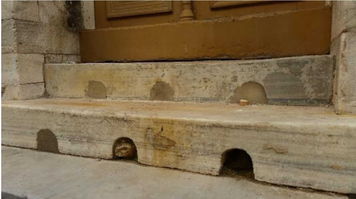
Εικόνα 91: Διαμπερή ανοίγματα στις βαθμίδες της εισόδου στην βορεινή όψη.
