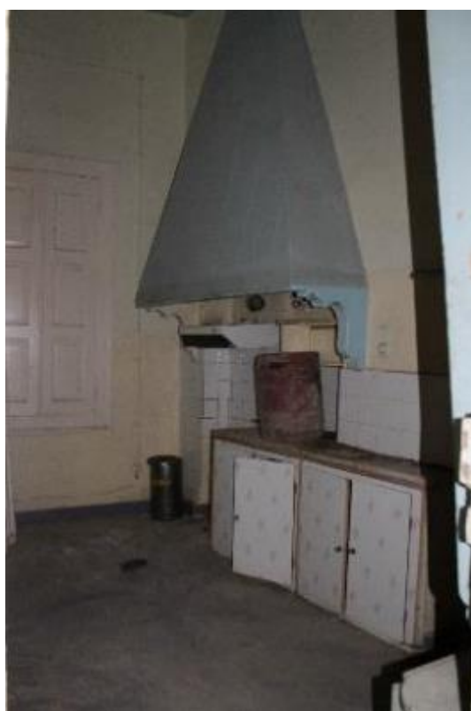
Εικόνα 32: Χώρος A4, η κουζίνα του ορόφου.
