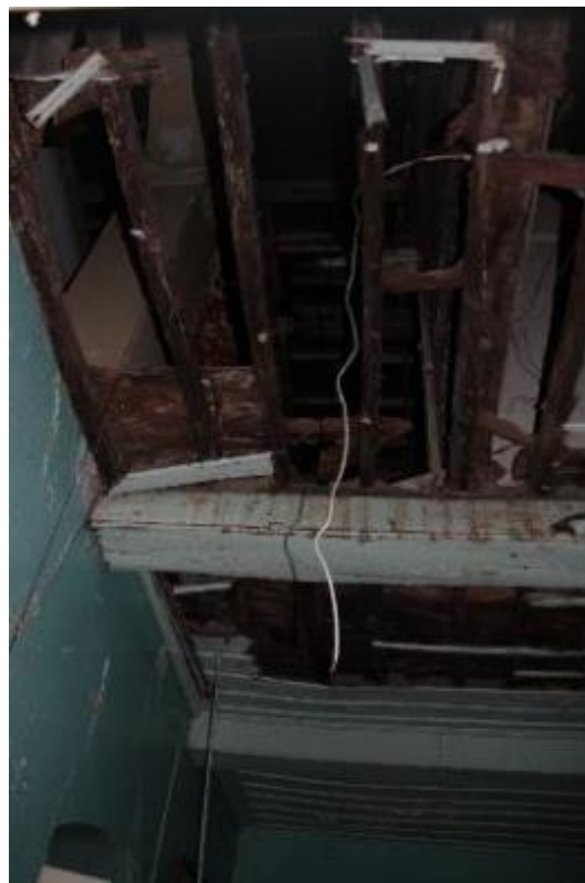
Εικόνα 133: Η οροφή του χώρου Ι3 του ισογείου κάτω από τον χώρο Α9 του ορόφου.
