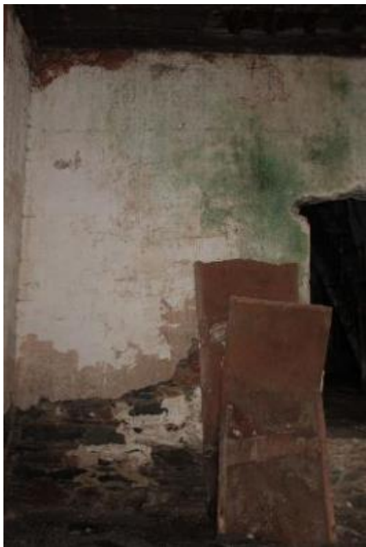
Εικόνα 120: Αποκόλληση των επιχρισμάτων του φέροντα οργανισμού στον χώρο Υ2.
