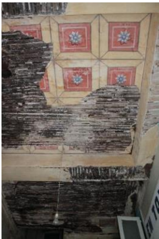
Εικόνα 49: Η οροφोगραφία στον χώρο Υ1 στο κλιμακοστάσιο της βορεινής εισόδου.
