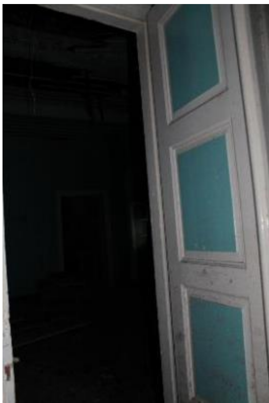
Εικόνα 78: Φύλλο εσωτερικής θύρας.
