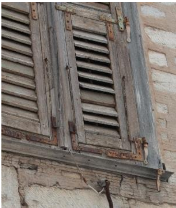
Εικόνα 88: Οι σιδερένιου βραχίονες που επιτρέπουν το άνοιγμα μόνο του κάτω μέρους του εξώφυλλου.
