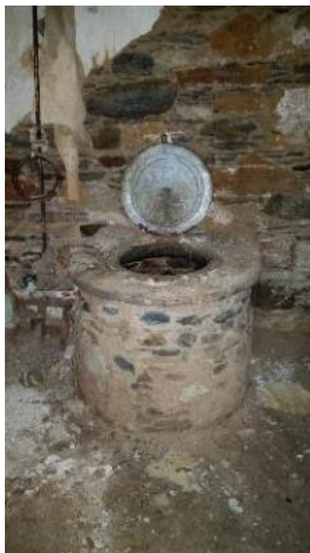
Εικόνα 59: Το κλείσιμο του στομίου της δεξαμενής με γαλβανισμένη λαμαρίνα.
