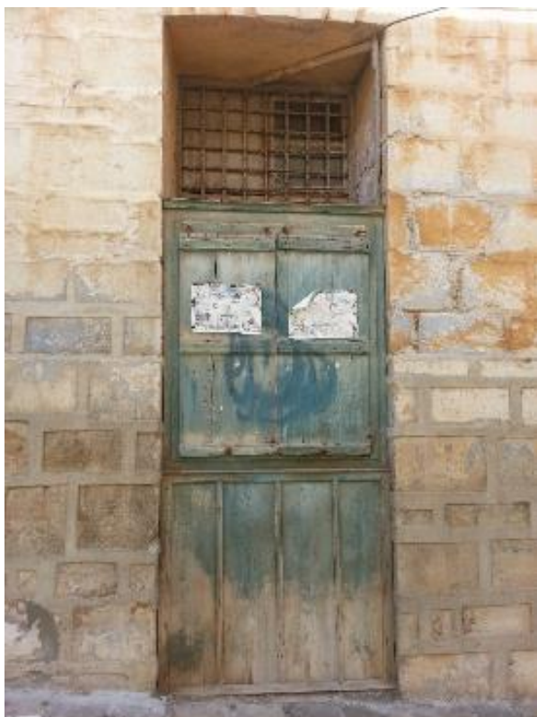
Εικόνα 137: Νότια όψη, είσοδος στον χώρο Υ4.
