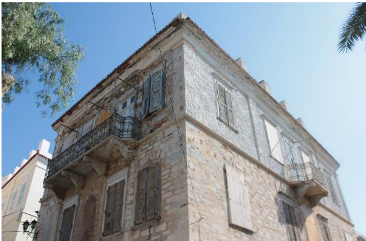
Εικόνα 38: Σοβατισμένος όροφος και κονίαμα στους αρμούς του ισογείου. Διακρίνεται η διακοσμητική ταινία ανάμεσα στους ορόφους, τα μπαλκόνια με τα φουρούσια τους, οι ψευδοπαραστάδες και το γείσο. Στην Νότια όψη προεξέχουν τα διακοσμητικά κολωνάκια.
