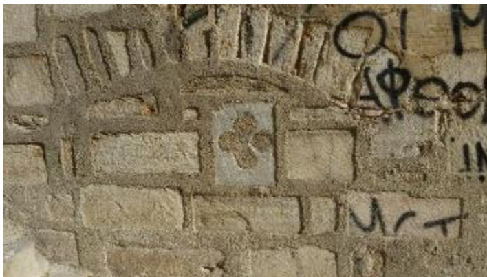
Εικόνα 93: Μαρμάρινο στοιχείο με οπές στην εξωτερική τοιχοποιία της δυτικής όψης.
