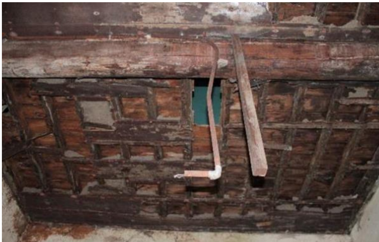
Εικόνα 148: Φωτιστικό σημείο στον χώρο Υ2.
