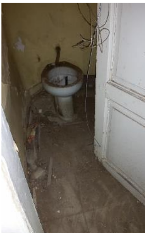
Εικόνα 114: Το WC του Α' ορόφου στον χώρο Α3.
