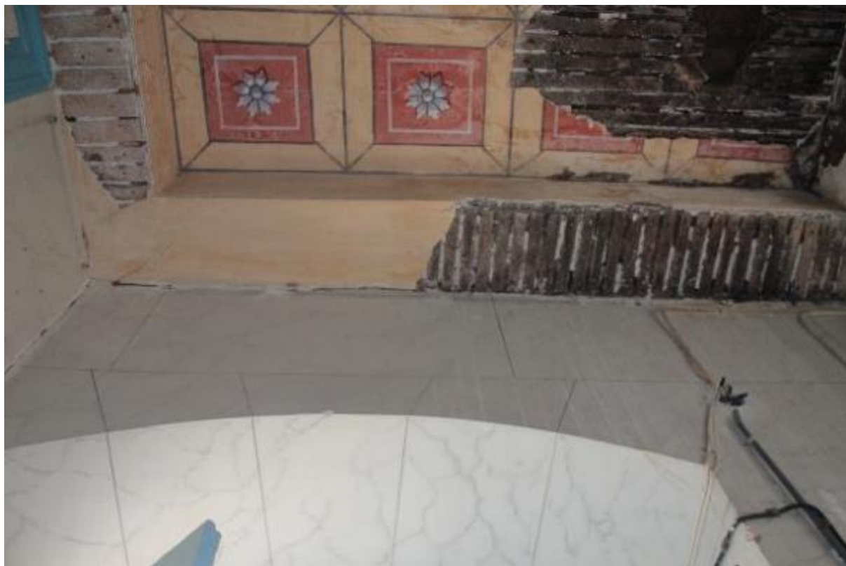
Εικόνα 107: Χώρος κλιμακοστασίου της νότιας εισόδου. Διακρίνεται ο διάκοσμος της οροφογραφίας, καθώς και η τοιχογραφία.
