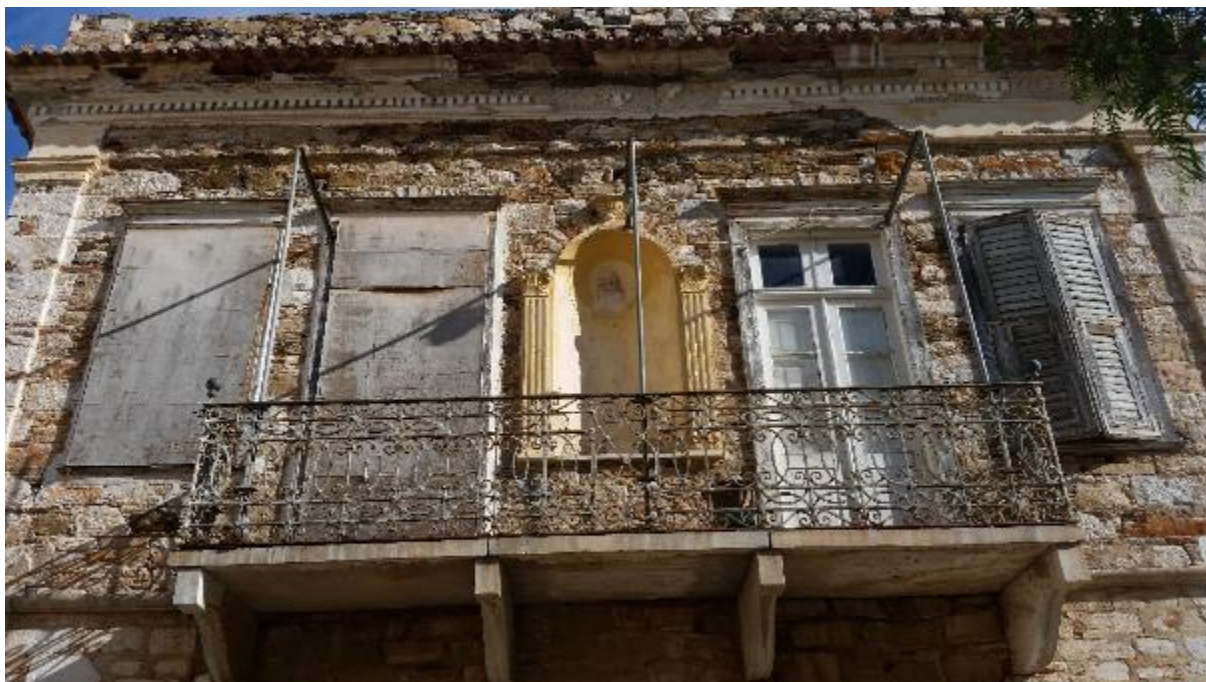
Εικόνα 41: Η δυτική όψη του Α' ορόφου. Διακρίνονται το μπαλκόνι με τα φουρούσια του, η διακοσμητική ταινία στην τοιχοποιία, τα συμμετρικά ανοίγματα με τους φεγγίτες, η ζωγραφιστή κόγχη, το γείσο και το στηθαίο του δώματος.
