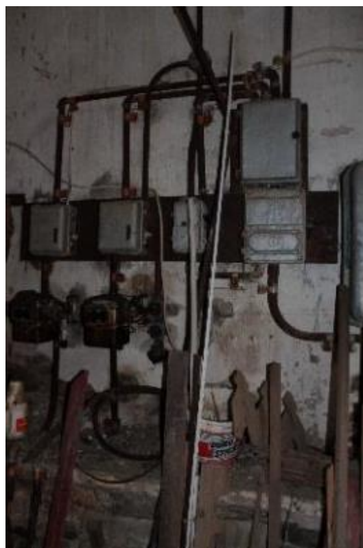
Εικόνα 112: Επαύξηση της ισχύος της ηλεκτρικής εγκατάστασης στον χώρο Υ4 του υπογείου για την χρήση εργαστηρίου.
