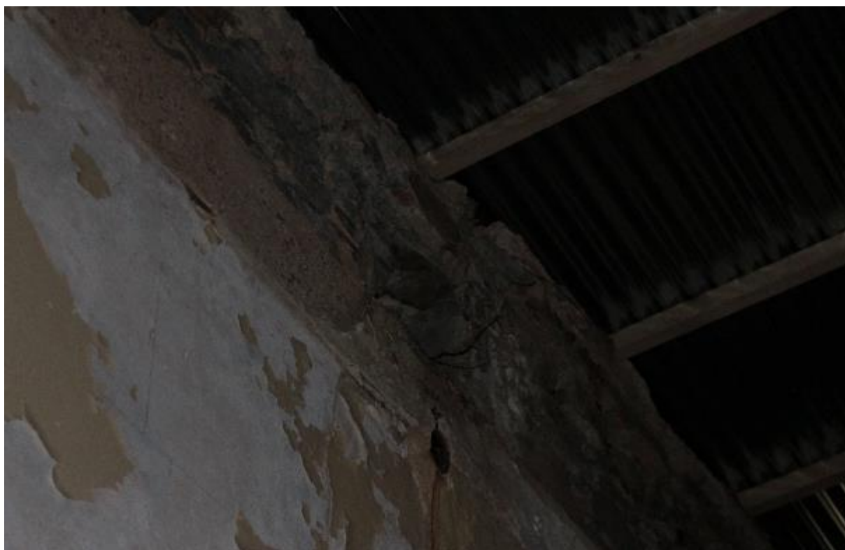
Εικόνα 131: Τμήμα της λιθοδομής πάνω στην οποία εδραζόταν ο σκελετός του δώματος.
