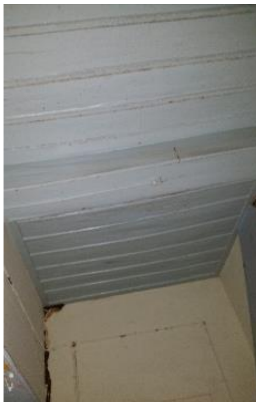
Εικόνα 72: Η οροφή της κουζίνας στον χώρο A4 στον όροφο.
