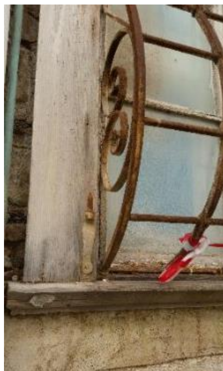
Εικόνα 95: Λεπτομέρεια καμπυλόγραμμου σχηματισμού κιγκλιδώματος σε κούφωμα.
