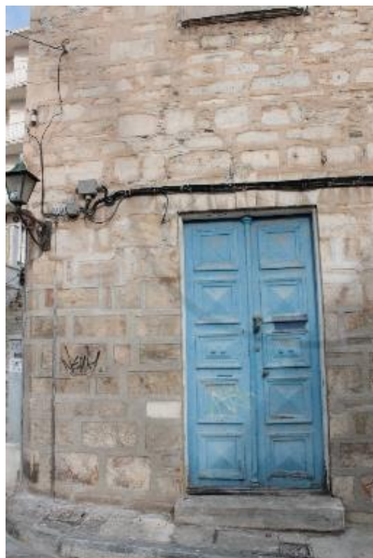
Εικόνα 16: Η κεντρική είσοδος της Νότιας όψης.
