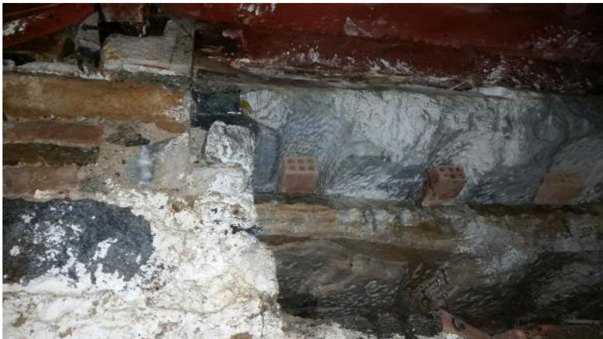
Εικόνα 92: Η πίσω όψη των βαθμίδων της βορεινής όψης επικοινωνεί με τον χώρο Υ7 του υπογείου. Διακρίνονται οι οπές που εξυπηρετούσαν στον αερισμό.
