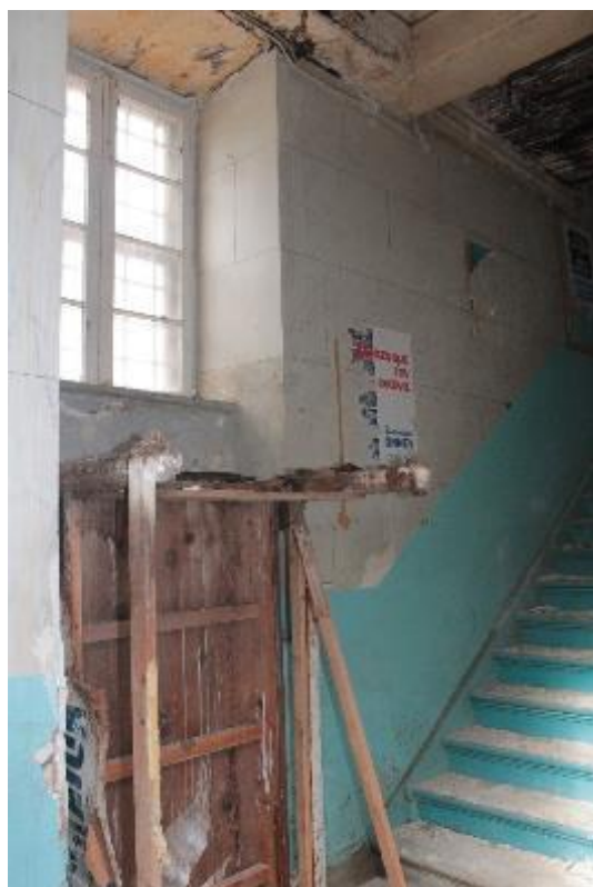
Εικόνα 108: Η εφαρμογή χρωματισμού επί της τοιχογραφίας στο κλιμακοστάσιο της νότιας εισόδου στον χώρο Υ1.
