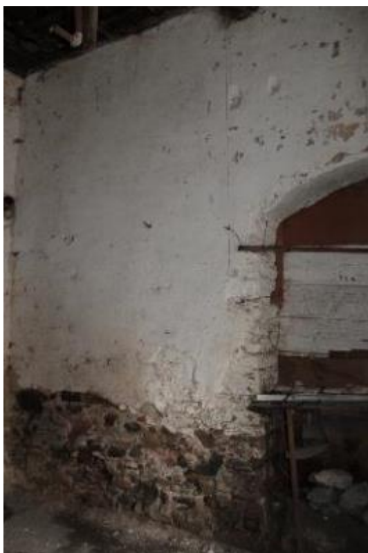
Εικόνα 62: Η εσωτερική φέρουσα τοιχοποιία στον χώρο Υ2 του υπογείου πάχους 50 εκ.
