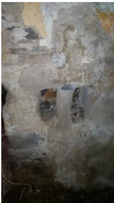
Εικόνα 58: Εσοχή στην τοιχοποιία για το δέσιμο του σχοινού.
