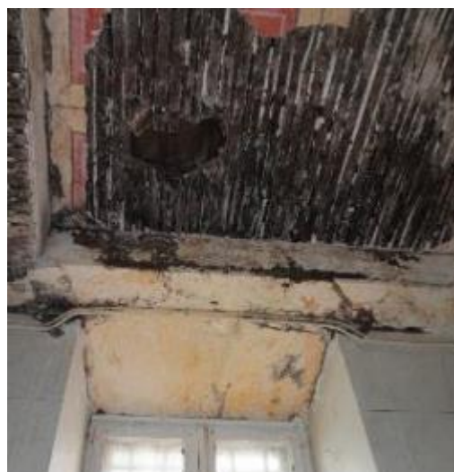
Εικόνα 73: Η οροφή της νότιας εισόδου στον χώρο Y1.
