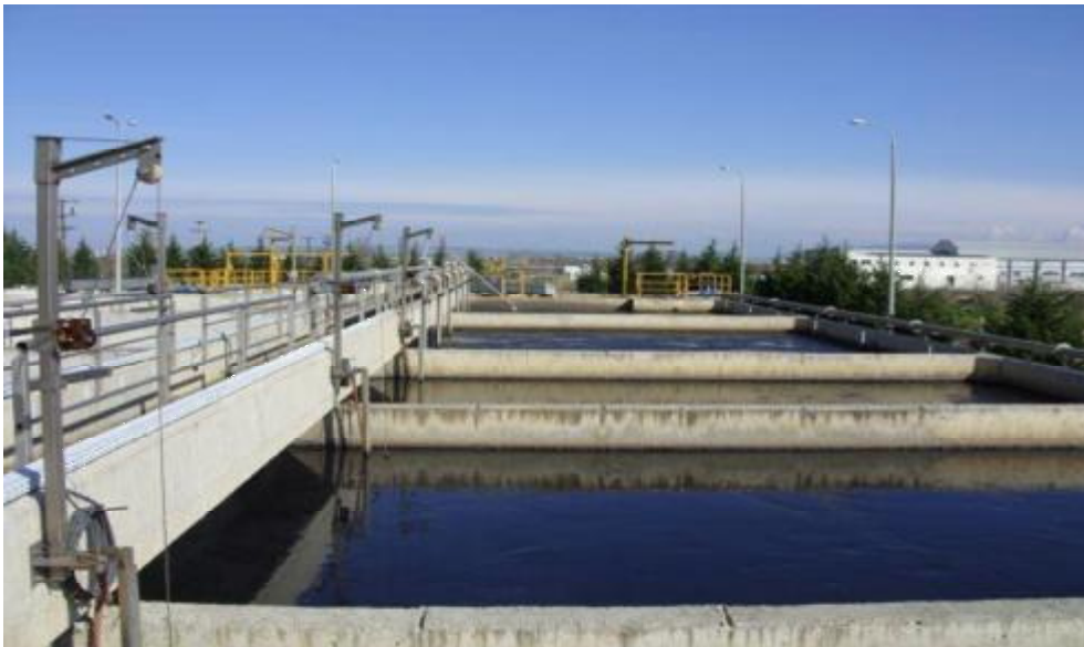
Εικόνα 16: Δεξαμενή χλωρίωσης
