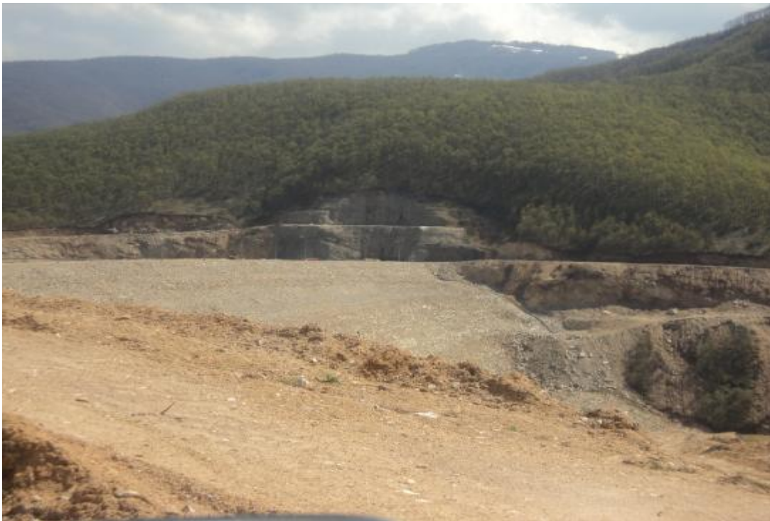
Εικόνα 54. Πίσω όψη του φράγματος, στο δεξί αντέρεισμα θα γίνεται η κατάληξη του νερού από τη διώρυγα εκτροπής.
