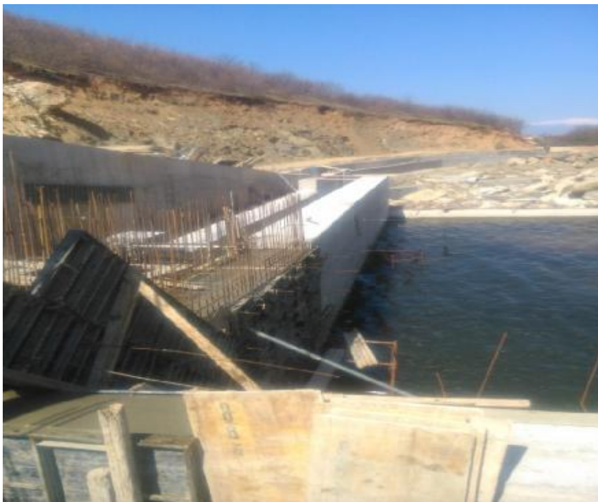
Εικόνα 52. Διώρυγα του θυροφράγματος.
