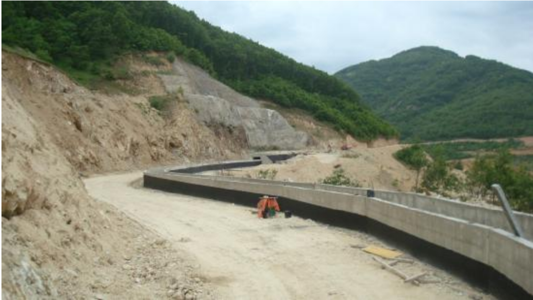
Εικόνα 53. Διώρυγα εκτροπής ρουφράχτη Δροσοπηγής.
