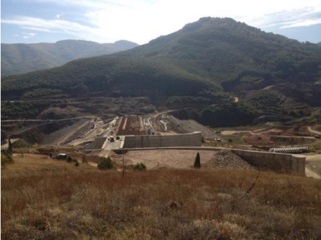
Εικόνα 47. Δεξιά ταμιευτήρας υπό κατασκευή και οριζόντια υπερχειλιστής, (Εταιρία TENA Α.ΤΕ.ΒΕ).
