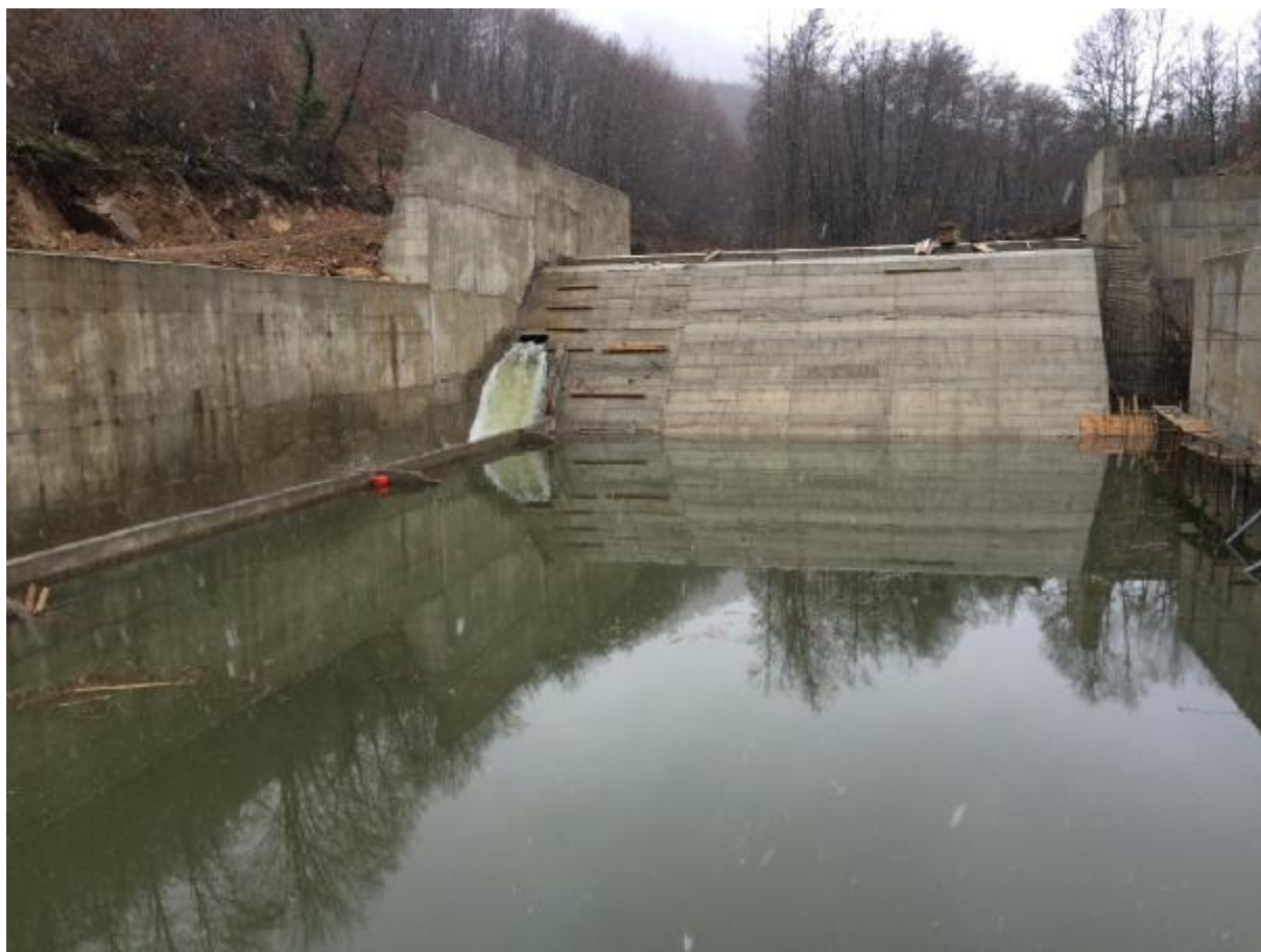
Εικόνα 40. Ρουφράκτης Δροσοπηγής υπό κατασκευή, (Εταιρία ΤΕ.ΝΑ- Α.ΤΕ.ΒΕ).
