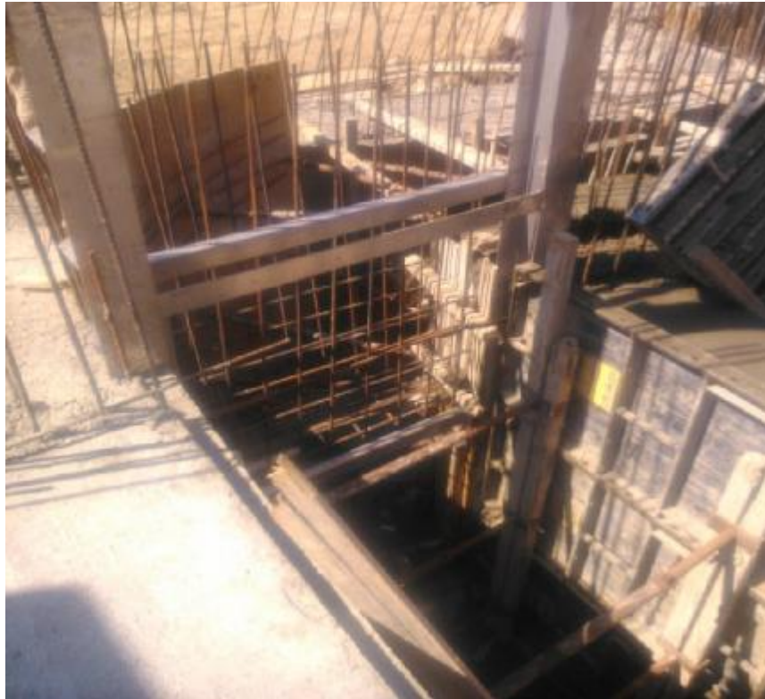
Εικόνα 51. Θυρόφραγμα ρουφράχτη Δροσοπηγής υπό κατασκευή.
