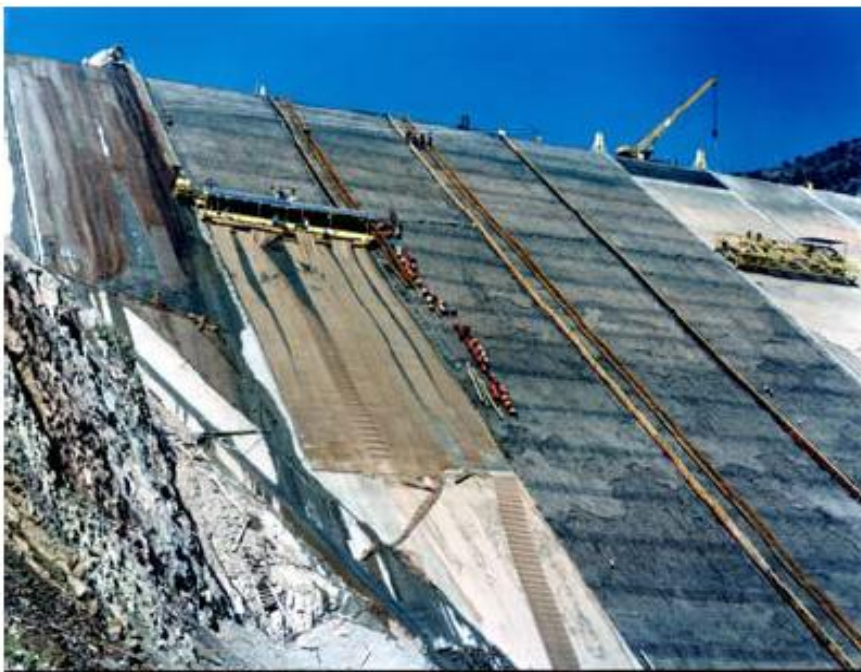
Εικόνα 29.Μεταλλότυπος φράγματος Μεσοχώρας, «Λιθόρριπτα Φράγματα με ανάτη πλάκα σκυροδέματος», ( Ι. Θανόπουλος & Κ. Αναστασόπουλος).
