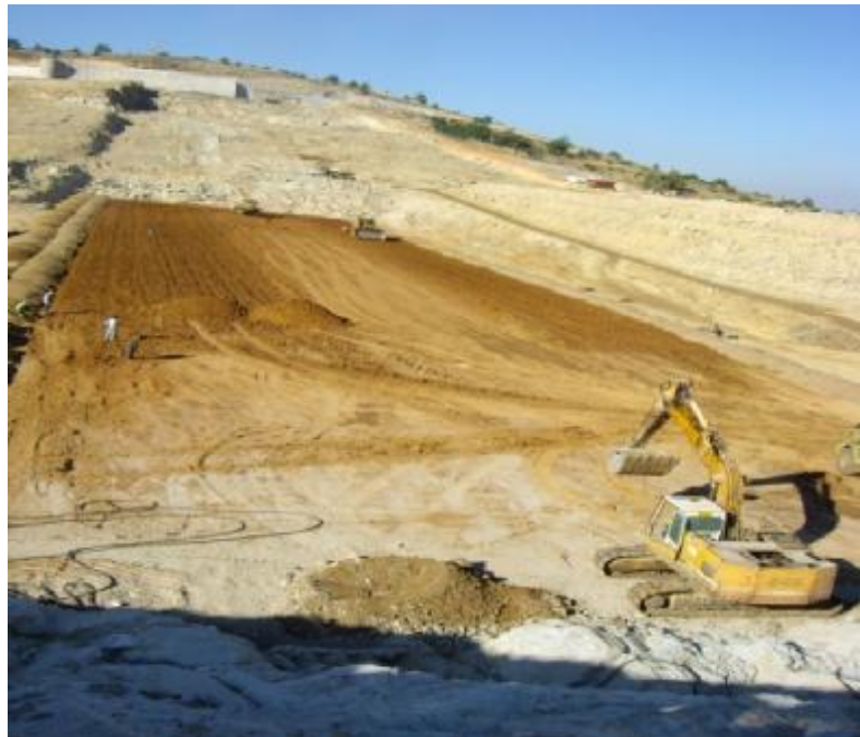
Εικόνα 44. Θεμελίωση του ταμιευτήρα, (Εταιρία ΚΟΥΡΤΙΔΗΣ Α.Ε).
