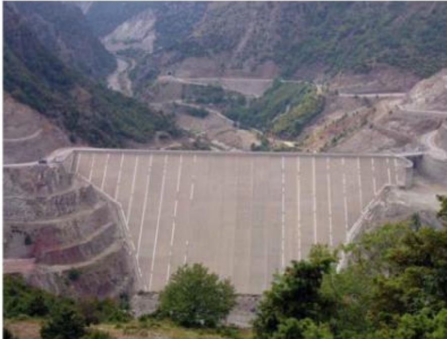
Εικόνα 28.Ανάτη όψη του φράγματος Μεσοχώρας, «Λιθόρριπτα Φράγματα με ανάτη πλάκα σκυροδέματος», ( Ι. Θανόπουλος & Κ. Αναστασόπουλος).
