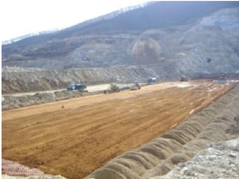
Εικόνα 43. Συμπύκνωση αργίλου στη θεμελίωση του ταμιευτήρα, (Εταιρία ΚΟΥΡΤΙΔΗΣ Α.Ε).
