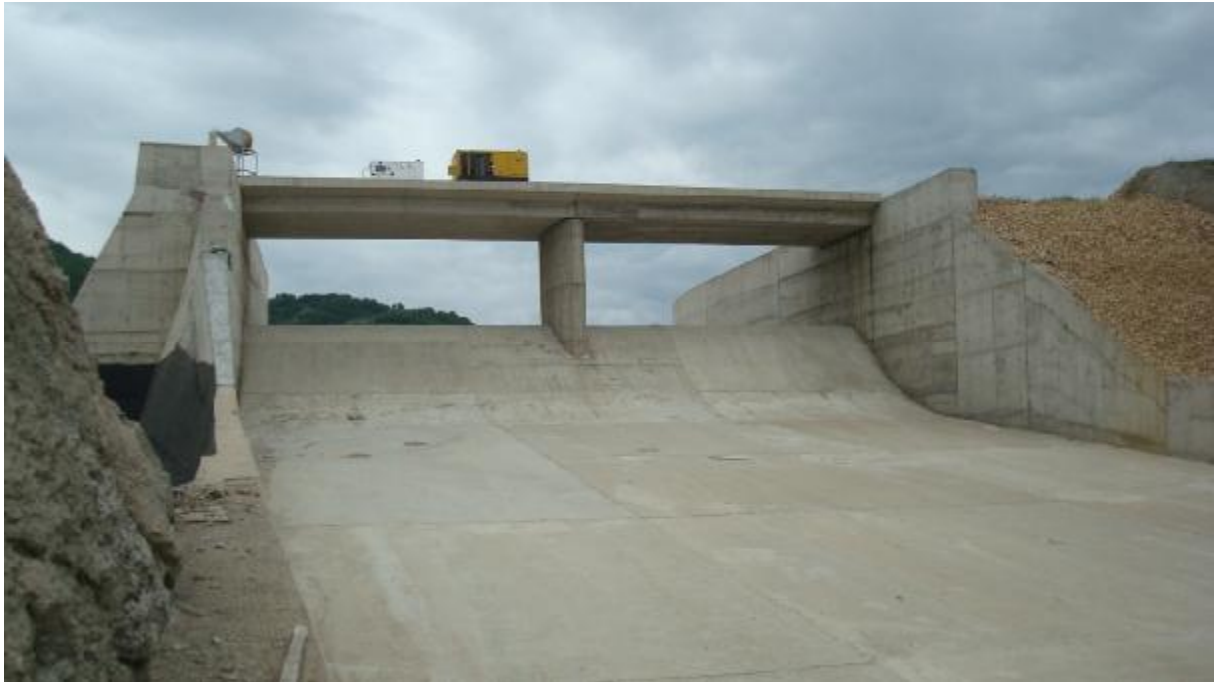
Εικόνα 41.Υπερχειλιστής υπό κατασκευή, (Εταιρία ΤΕ.ΝΑ- Α.ΤΕ.ΒΕ).
