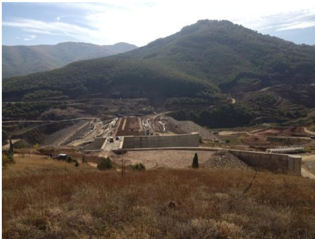
Εικόνα 38. Δεξιά θέση ταμιευτήρα υπό κατασκευή και οριζόντια υπερχειλιστής. (Εταιρία ΤΕ.ΝΑ-Α.ΤΕ.ΒΕ)
