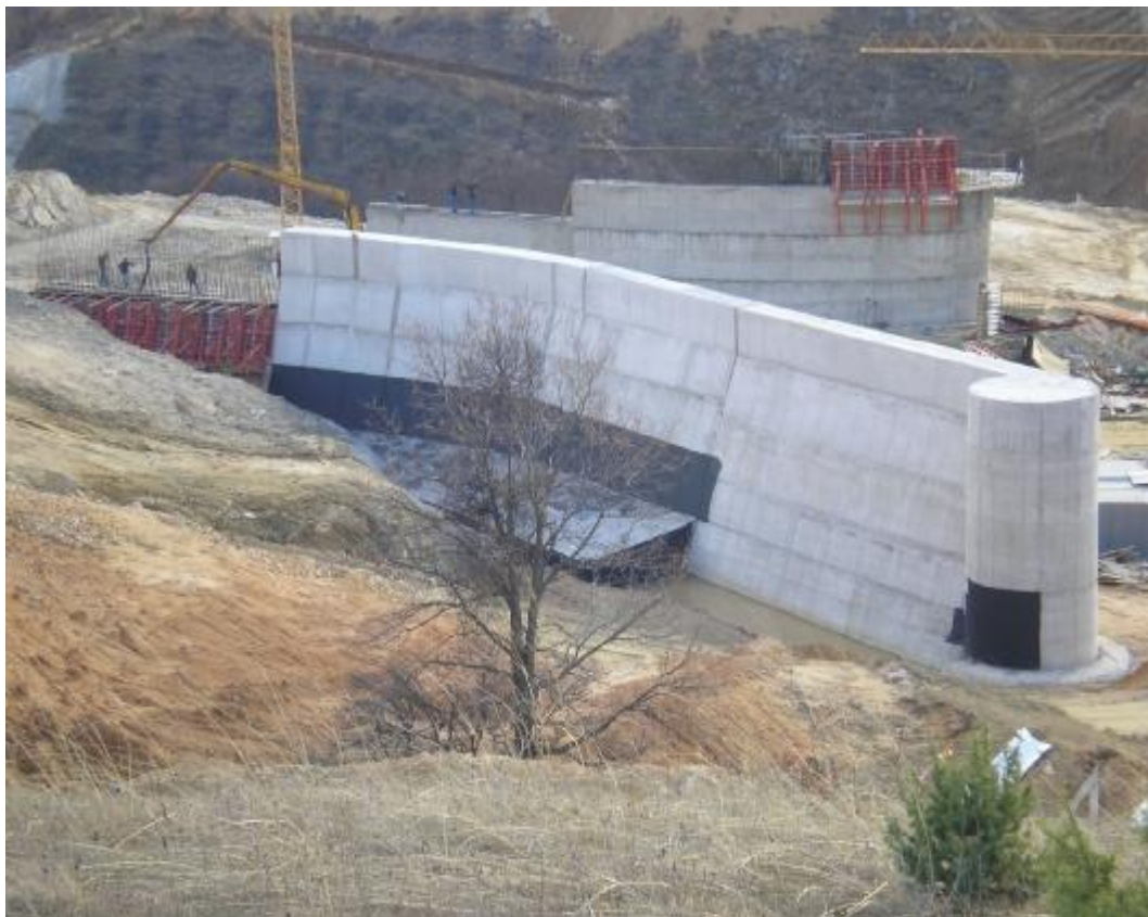
Εικόνα 46. Διώρυγα προσαγωγής υπό κατασκευή, (Εταιρία ΚΟΥΡΤΙΔΗΣ Α.Ε).
