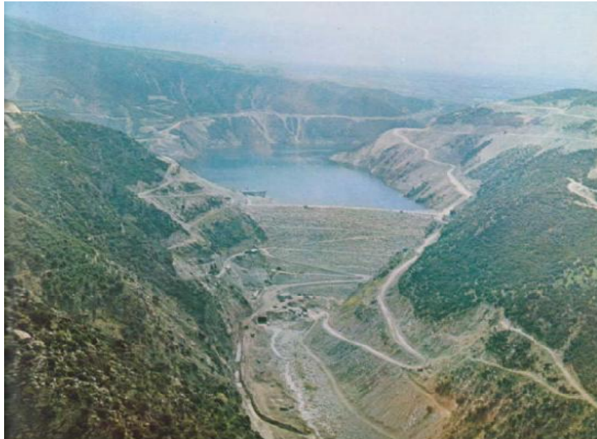
Εικόνα 24. Φράγμα Πολυφύτου Κοζάνης, (Γ.Ντούνιας, κ.α., 2013).
