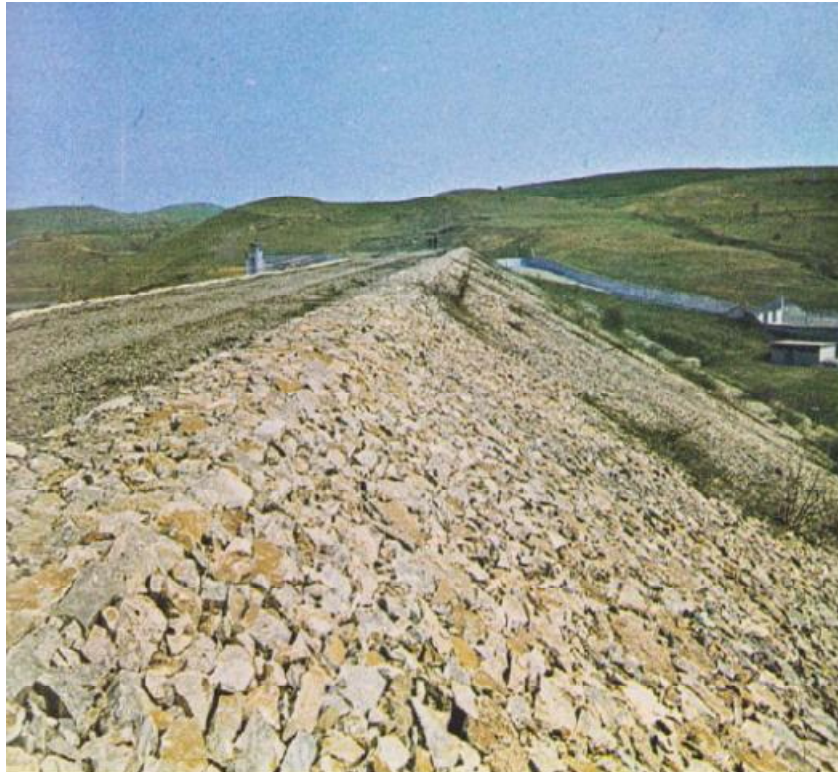
Εικόνα 21. Φράγμα Πέρδικας , χωμάτινο με κεντρικό πυρήνα, (Γ.Ντούνιας, κ.α., 2013).
