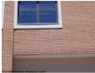
Εικόνα 14 Τοιχοποιία με διακοσμητικά τούβλα 1
