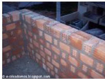
Εικόνα 10 Μπατική τοιχοποιία (πάχους 19 εκ.), τύπου "ντάμα".
