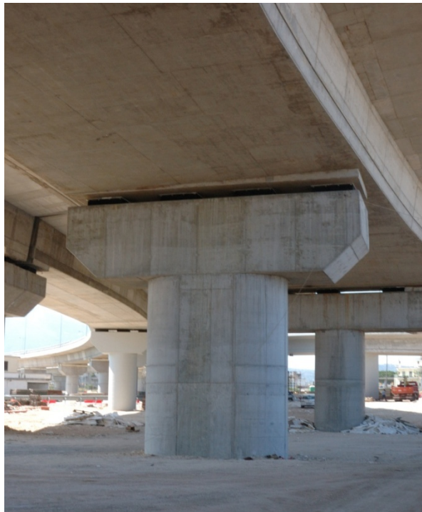
Φωτ. 6.5: Βόρεια όψη μεσοβάθρου M7.Δ (αποτελείται από ένα στύλο και έχει ορθογωνική διατομή με ημικυκλικά άκρα με εξωτερικές διαστάσεις 2.5m x 4.0m) και ελαστομεταλλικά εφέδρανα.
