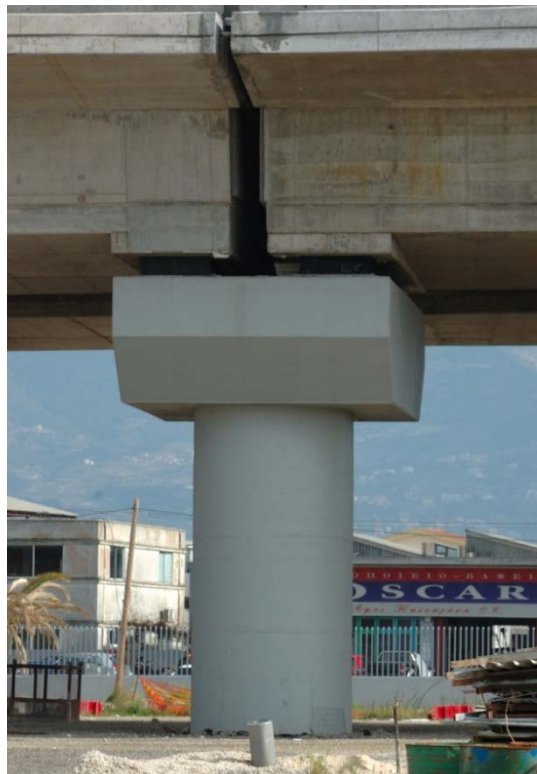
Φωτ. 6.3: Δυτική όψη μεσοβάθρου M5.Δ (αποτελείται από ένα στύλο και έχει ορθογωνική διατομή με ημικυκλικά άκρα με εξωτερικές διαστάσεις 2.5m x 4.0m) και αρμός μεταξύ γέφυρας T1 (αριστερά) και παρούσας γέφυρας T2 (δεξιά). Επίσης διακρίνονται τα ελαστομεταλλικά εφέδρανα.
