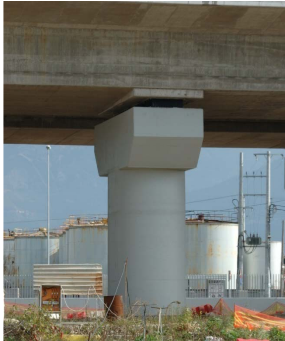
Φωτ. 6.4: Δυτική όψη μεσόβαθρου M6.Δ (αποτελείται από ένα στύλο και έχει ορθογωνική διατομή με ημικυκλικά άκρα με εξωτερικές διαστάσεις 2.5m x 4.0m) και ελαστομεταλλικά εφέδρανα.
