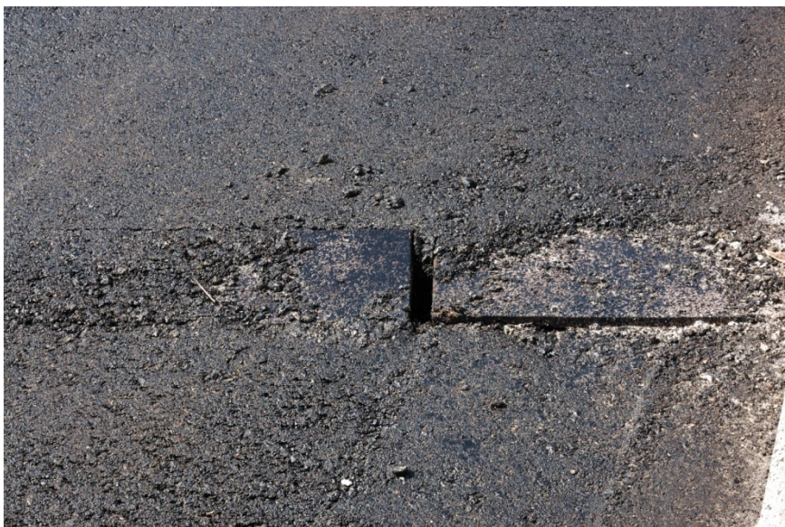
Φωτ. 6.17: Πρώτη φάση ασφαλτόστρωσης. Ακόμη διακρίνεται ο αρμός συστολής-διαστολής.
