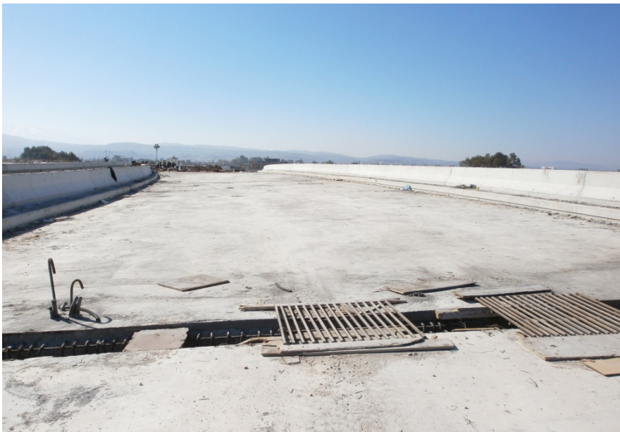
Φωτ. 6.13: Το κατάστρωμα της παρούσας γέφυρας T2 πριν την ασφαλτόστρωση και πριν την κάλυψη των αρμών.
