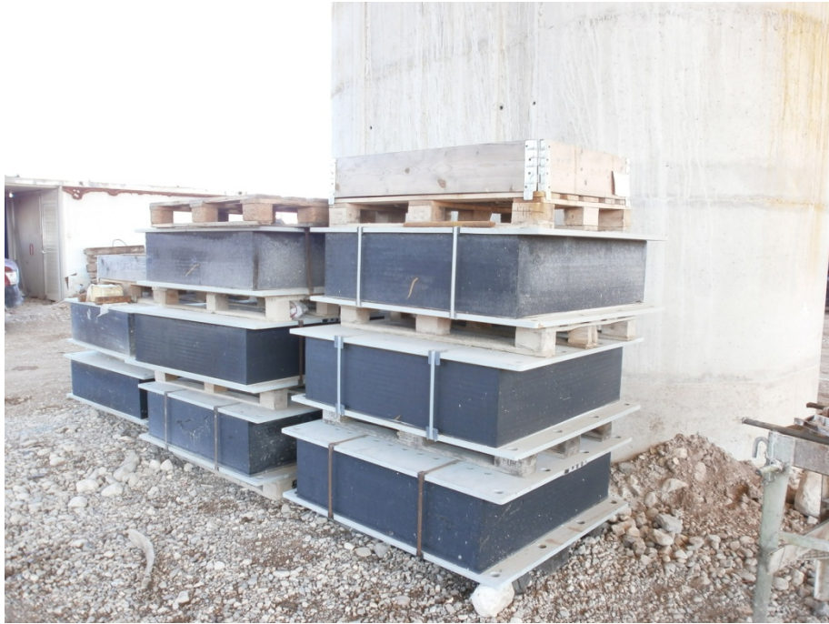
Φωτ. 6.20: Τα εφέδρανα που χρησιμοποιήθηκαν για όλο το έργο του Ανισόπεδου Κόμβου.
