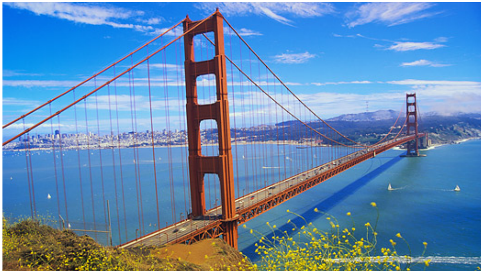
Σχήμα 1.3 – Γέφυρα της Χρυσής Πύλης, Σαν Φρανσίσκο.
