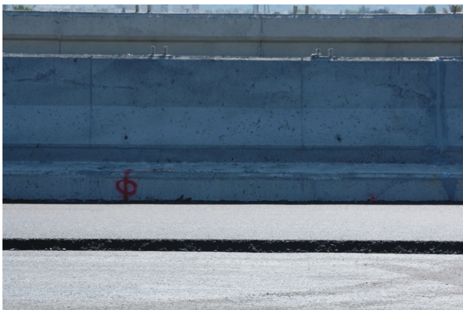
Φωτ. 6.19: Διακρίνεται η ελάχιστη διαφορά ύψους της αριστερής Παραγλαύκιας αρτηρίας Πατρών με τη δεξιά Παραγλαύκια αρτηρία (παρούσα). Επίσης παρατηρείται το αναμενόμενο πάχος (ίσο με 14cm) των ασφαλτοστρώσεων.
