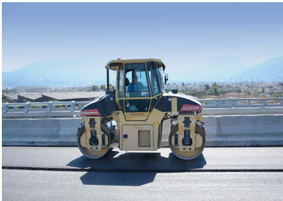
Φωτ. 6.15: Οδοστρωτήρας με δύο κυλίνδρους κατά τη διάρκεια συμπύκνωσης της ασφαλτικής στρώσης.
