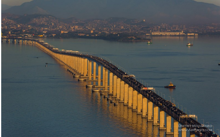
Σχήμα 1.7 – Γέφυρα στο Rio de Janeiro, Βραζιλία.
