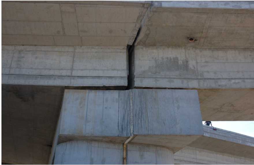
Φωτ. 6.12: Αρμός μεταξύ παρούσας γέφυρας T2 (αριστερά) και της γέφυρας T17 (δεξιά).
