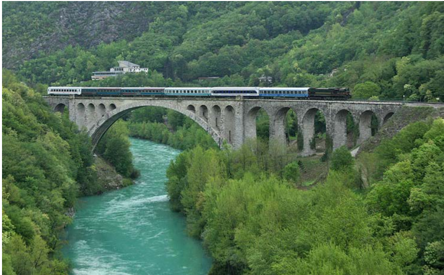
Σχήμα 1.11 – Γέφυρα Solkan, Σλοβενία.
