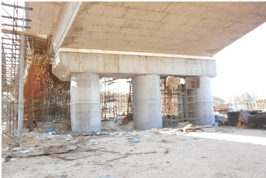
Φωτ. 6.7: Βόρεια όψη του μεσοβάθρου Μ8.Δ (αποτελείται από τρεις σύλους οι οποίοι έχουν ορθογωνική διατομή με το ένα άκρο ημικυκλικό με εξωτερικές διαστάσεις 2.5m x 2.5m) υπό την κατασκευή της γέφυρας Τ3 (Γέφυρα Δεξιάς Παραγλαύκιας Αρτηρίας) και της γέφυρας Τ17 (κλάδου Γ).
