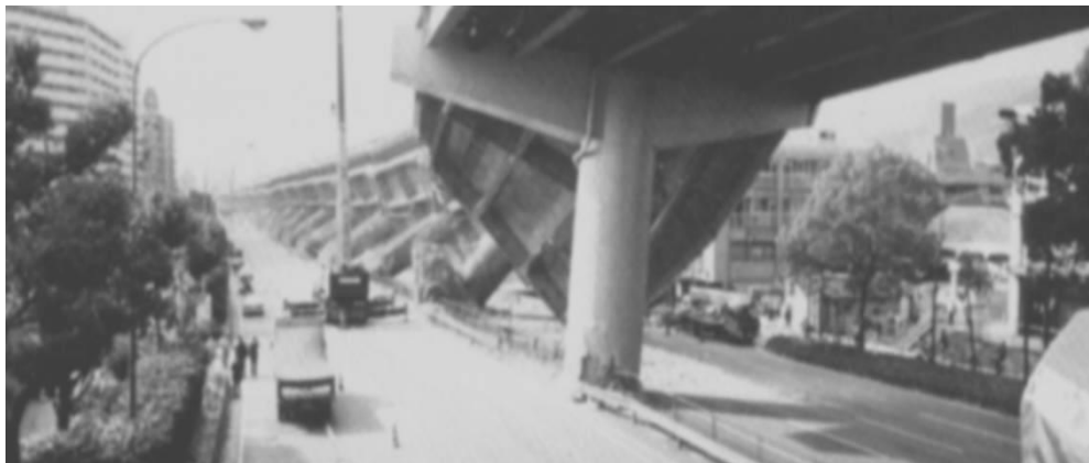
Σχήμα 2.2 - Καμπτική αστοχία μονόστηλων κυκλικών βάθρων του αυτοκινητόδρομου Hanshin στο σεισμό του Kobe, Ιαπωνία, το 1995.
