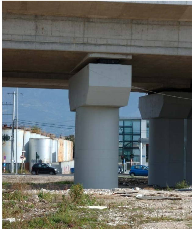
Φωτ. 6.6: Δυτική όψη μεσοβάθρου Μ7.Δ και ελαστομεταλλικά εφέδρανα.
