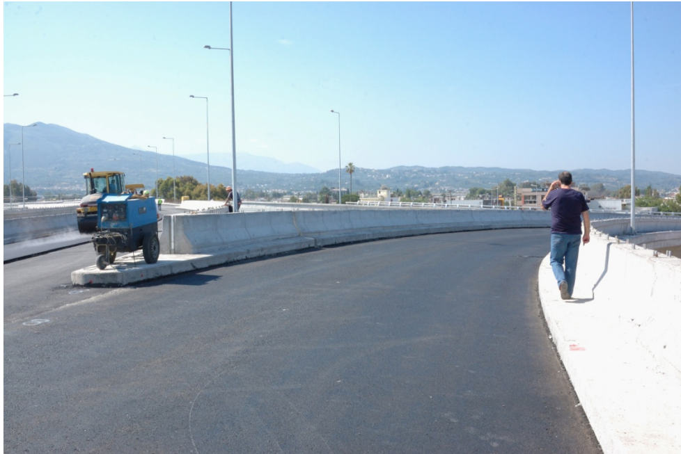
Φωτ. 6.16: Έξοδος της δεξιάς Παραγλαύκιας αρτηρίας που ενώνει η γέφυρα T2 με το κλάδο Γ (δεξιά), γέφυρα T17.
