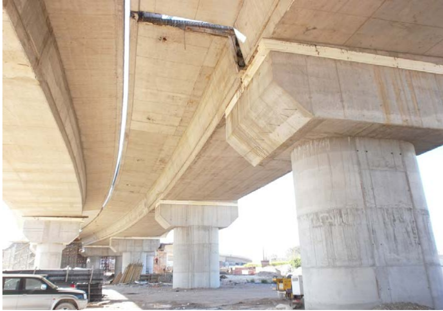
Φωτ. 6.2: Βόρεια όψη μεσοβάθρου M5.Δ σε πρώτο πλάνο και σε δεύτερο πλάνο τα μεσόβαθρα M6.Δ, M7.Δ καθώς και η θέση τοποθέτησης εφεδράνων. Αριστερά διακρίνεται η γέφυρα T7 της αριστερής Παραγλαύκιας αρτηρίας Πατρών.
