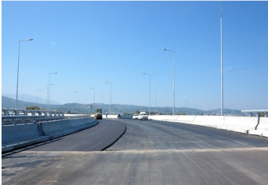
Φωτ. 6.14: Βόρεια όψη του καταστρώματος της γέφυρας T2 κατά την διάρκεια της ασφαλτόστρωσης.
