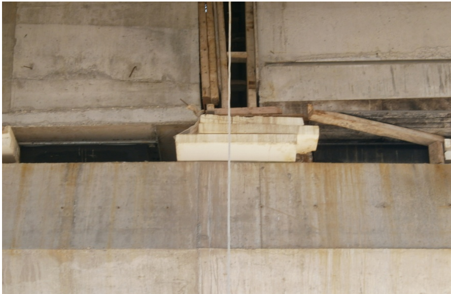
Φωτ. 6.11: Θέση τοποθέτησης εφεδράνων και αρμός μεταξύ γέφυρας T1 (αριστερά) και παρούσας γέφυρας T2 (δεξιά).
