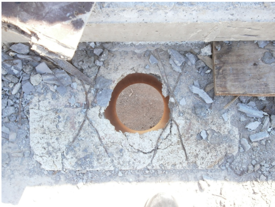
Φωτ. 6.21: Θέση αγωγού παροχέτευσης ομβρίων υδάτων.
