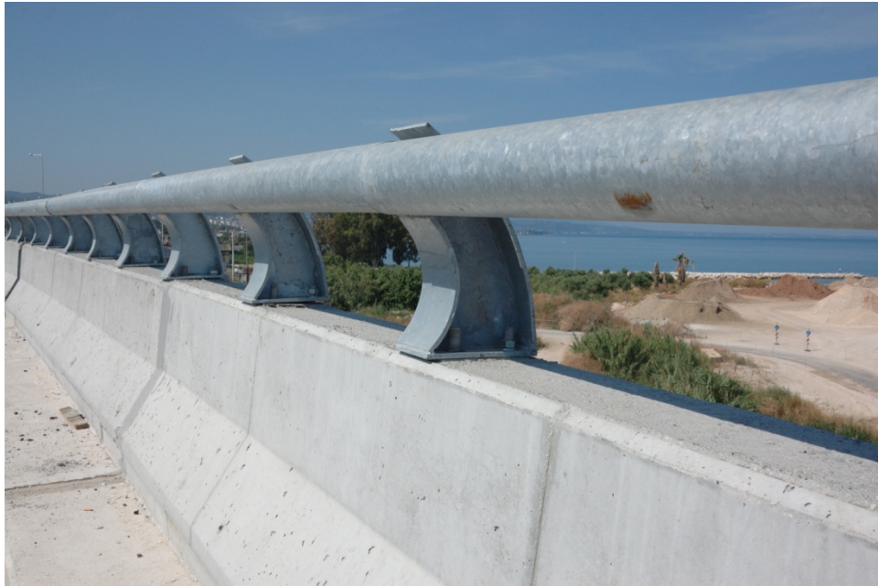
Φωτ. 6.22: Προστατευτικά κιγκλιδώματα και κράσπεδο.
