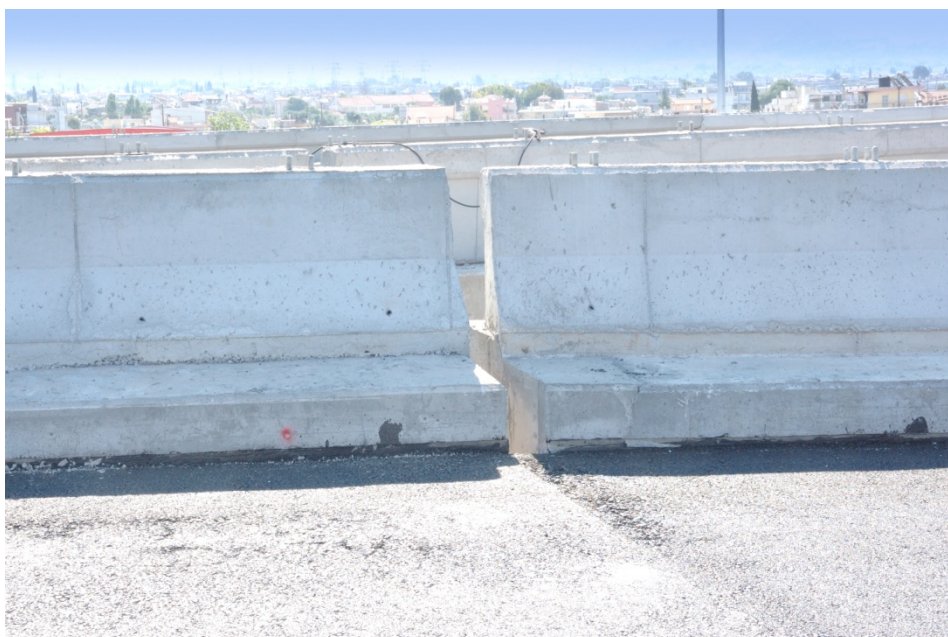
Φωτ. 6.18: Διακρίνουμε το ένα άκρο της παρούσας γέφυρας T2 (αριστερά), τον αρμό και το ένα άκρο της γέφυρας T17 (δεξιά).
