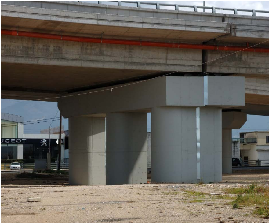
Φωτ. 6.8: Δυτική όψη του μεσοβάθρου M8.Δ και αρμός μεταξύ παρούσας γέφυρας T2 (αριστερά) και γέφυρας T17 (δεξιά).
