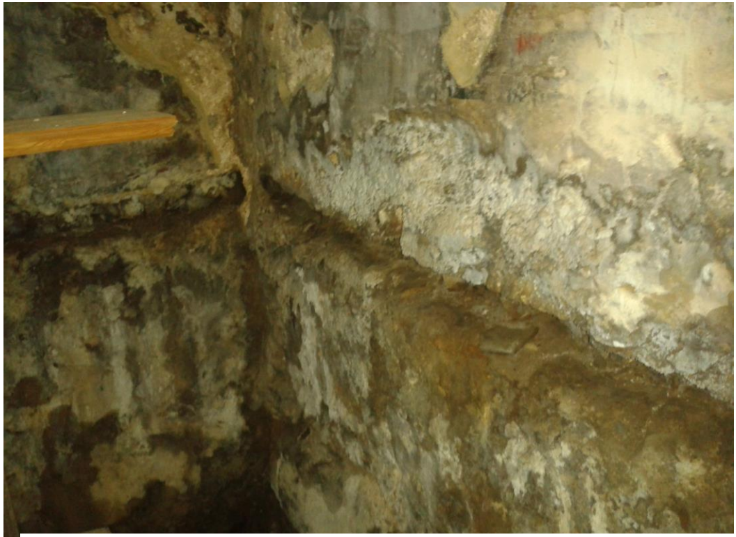
Εικόνα 7 ανερχόμενη υγρασία
