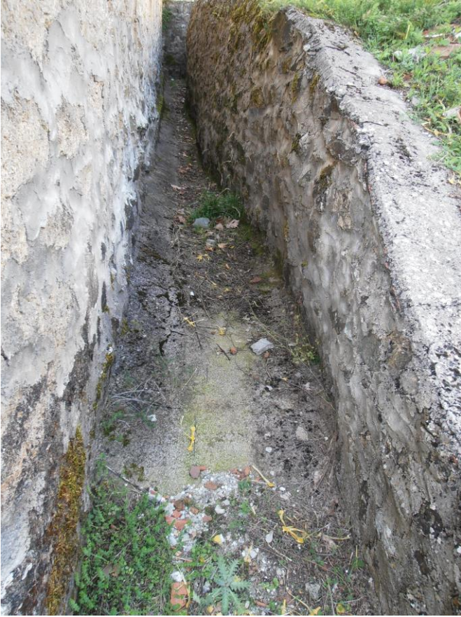
Εικόνα 10 Ξηρολιθιά στη Βόρεια όψη
