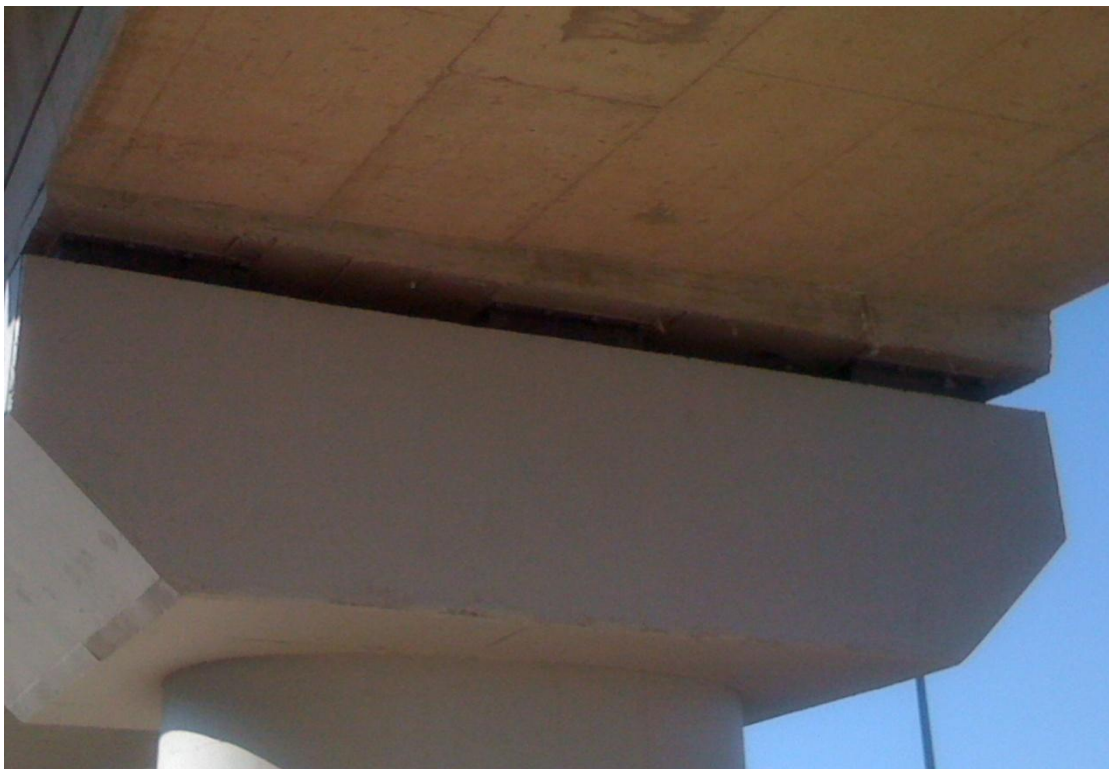
Φωτ.7.11 Βορειοδυτική όψη της κεφαλής του μεσοβάθρου M11.Δ όπου διακρίνονται τα ελαστομεταλλικά εφέδρανα της παρούσας γέφυρας.
