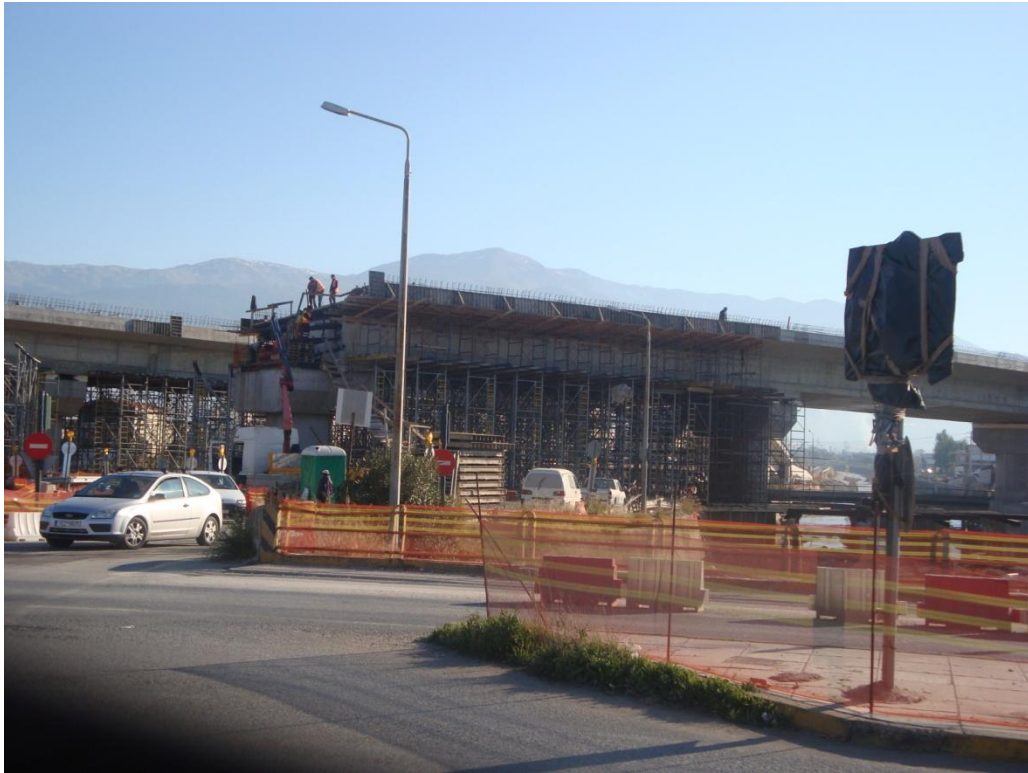
Φωτ.7.2 Γενική άποψη του μεσοβάθρου Μ.12Δ, όπου διακρίνεται η ο αρμός της παρούσας γέφυρας (αριστερά) με τη γέφυρα Τ5 (δεξιά).
