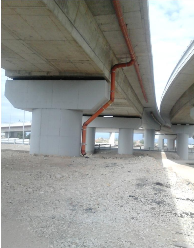
Φωτ.7.22 Διάταξη αγωγών υδροσυλλογής στην περιοχή του μεσοβάθρου Μ12.Δ.
