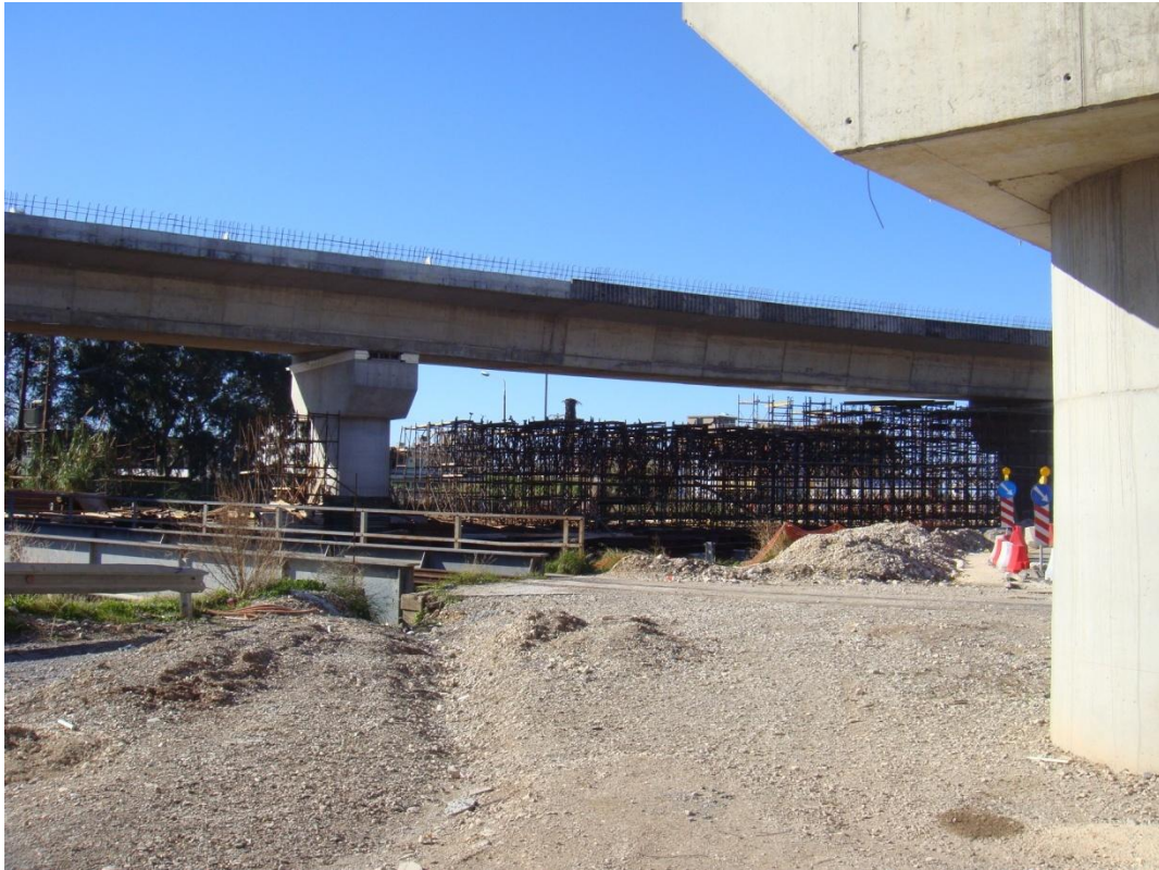
Φωτ. 7.6 Νοτιοδυτική όψη μεσόβαθρου M11.Δ της παρούσας γέφυρας.
