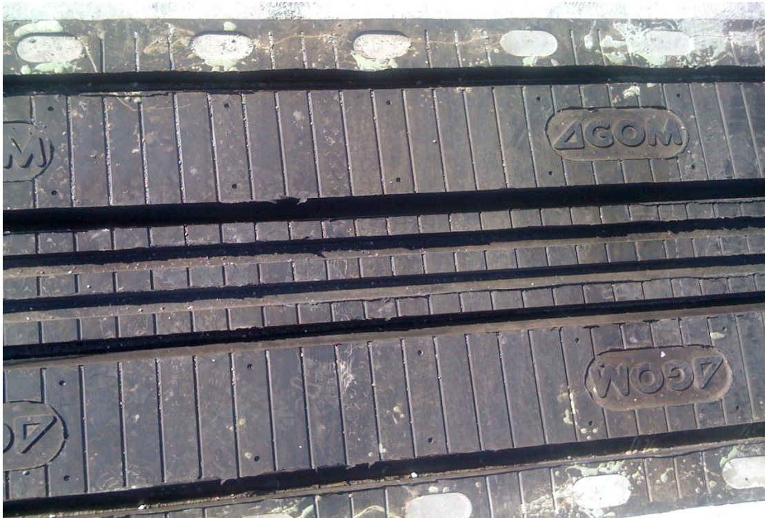
Φωτ.7.14 Αρμός τύπου ALGAFLEX T250AS με ικανότητα μετακίνησης \pm 125\text{mm} (στη θέση του μεσοβάθρου M10.Δ)
