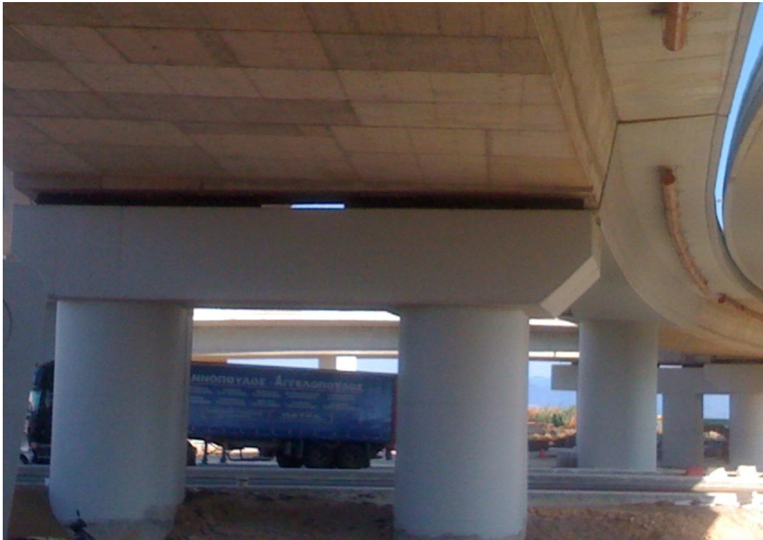
Φωτ.7.12 Όψη του μεσοβάθρου Μ10.Δ της παρούσας γέφυρας (ύψους 9.21m)
