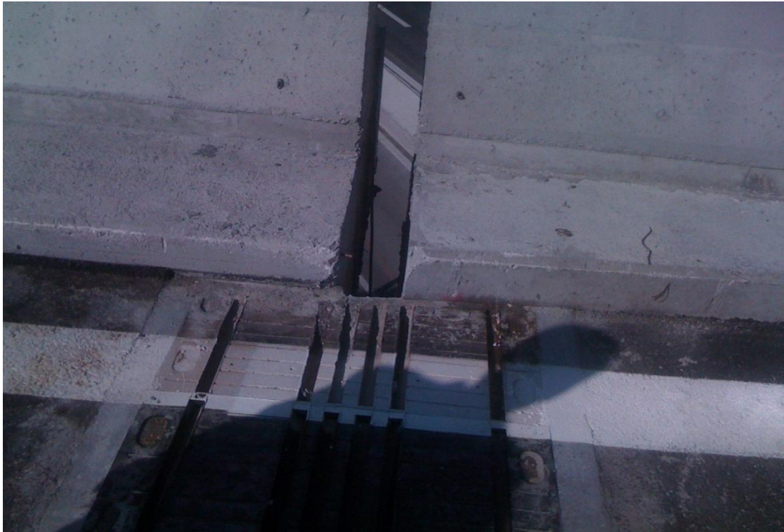
Φωτ.7.16 Λεπτομέρεια του αρμού πάνω από το μεσόβαθρο M10.Δ στην ένωση της παρούσας γέφυρας (αριστερά) με τη γέφυρα T3 (δεξιά).
