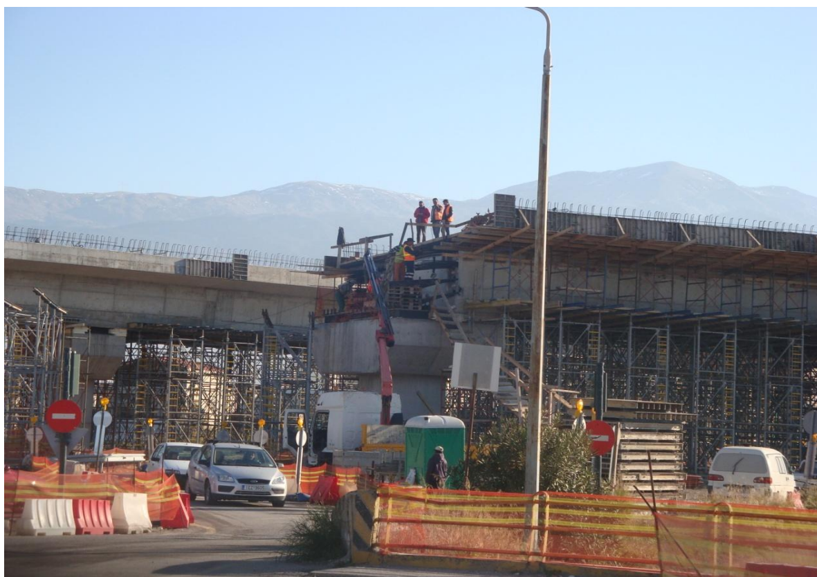
Φωτ.7.1 Βορειοανατολική όψη του Μεσόβαθρου M12.Δ της παρούσας γέφυρας κατά τη φάση κατασκευής του καταστρώματος.
