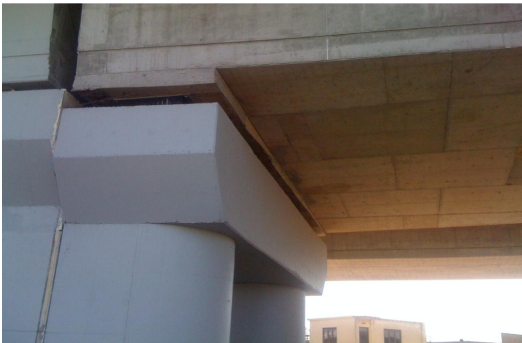
Φωτ.7.7 Πλάγια όψη της κεφαλής του ολοκληρωμένου μεσοβάθρου M10.Δ (δύο ορθογωνικοί στύλοι με ημικυκλικά άκρα), όπου διακρίνεται η έδραση του καταστρώματος στα ελαστομεταλλικά εφέδρανα στη θέση ένωσης της παρούσας γέφυρας (δεξιά) με το τεχνικό T5 (αριστερά).
