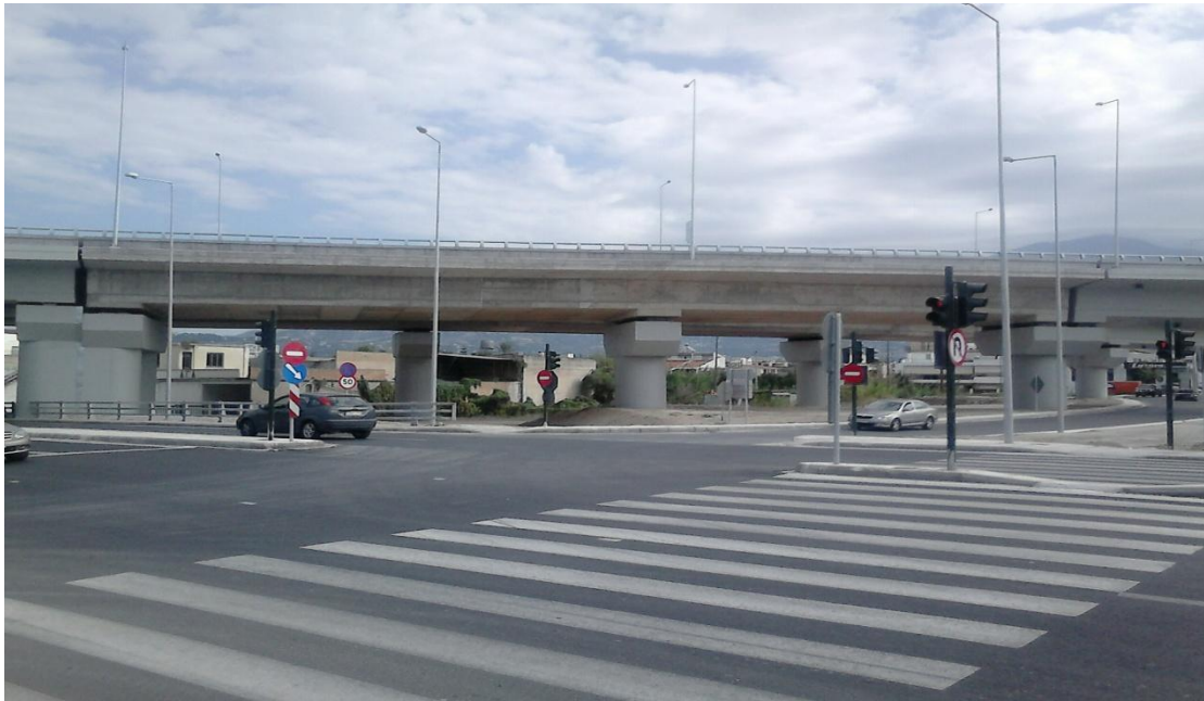
Φωτ.7.23 Γενική όψη της ολοκληρωμένης γέφυρα που μελετήθηκε στην παρούσα Πτυχιακή Εργασία με τις ενώσεις των γεφυρών Τ3 (αριστερά) και Τ5 (δεξιά).
