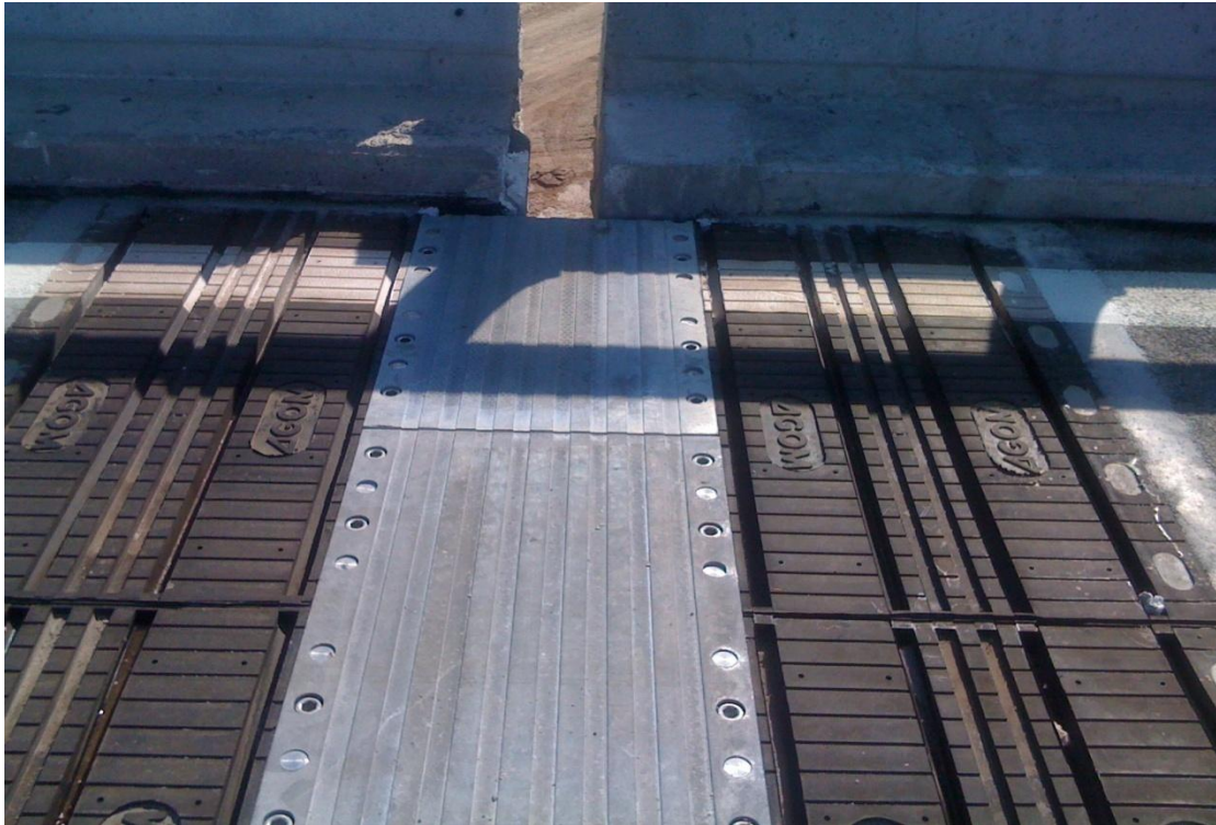
Φωτ.7.18 Αρμός τύπου ALGAFLEX TM400 στη θέση του μεσόβαθρου M12Δ στην ένωση της παρούσας (δεξιά) με τη γέφυρα T5 (αριστερά).
