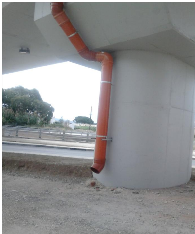
Φωτ.7.21 Μεσόβαθρο Μ12.Δ όπου διακρίνεται αγωγός υδροσυλλογής.
