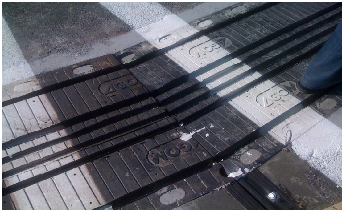
Φωτ.7.14 Αρμός τύπου ALGAFLEX T250AS με ικανότητα μετακίνησης \pm 125\text{mm} (στη θέση του μεσοβάθρου M10.Δ)
