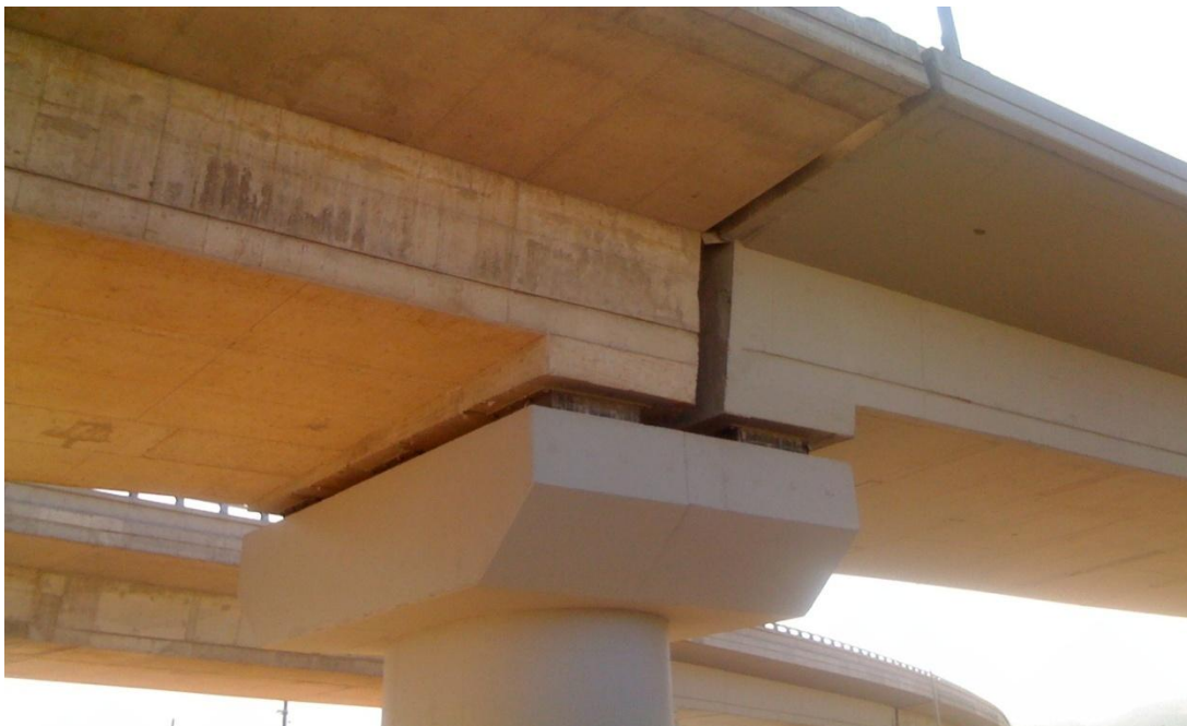
Φωτ.7.9 Λεπτομέρεια της κεφαλής του μεσοβάθρου M12.Δ (ορθογωνική διατομή με ημικυκλικά άκρα) της παρούσας γέφυρας (αριστερά) με τη γέφυρα T5 (δεξιά).
