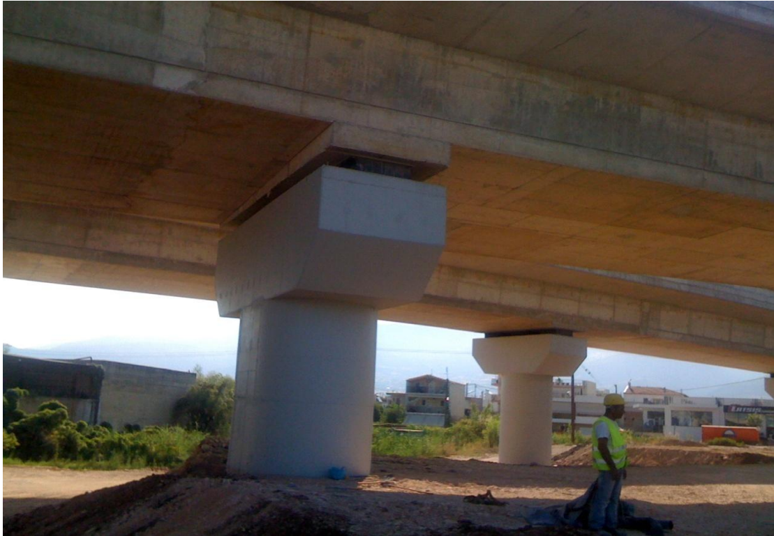
Φωτ.7.8 Σε πρώτο πλάνο άποψη του μεσόβαθρου M11.Δ της παρούσας γέφυρας, ορθογωνικής διατομής με ημικυκλικά άκρα διαστάσεων (4.0 x 2.5m), όπου διακρίνεται η έδραση του φορέα ανωδομής επί των εφεδράνων στην κεφαλή του βάθρου.
