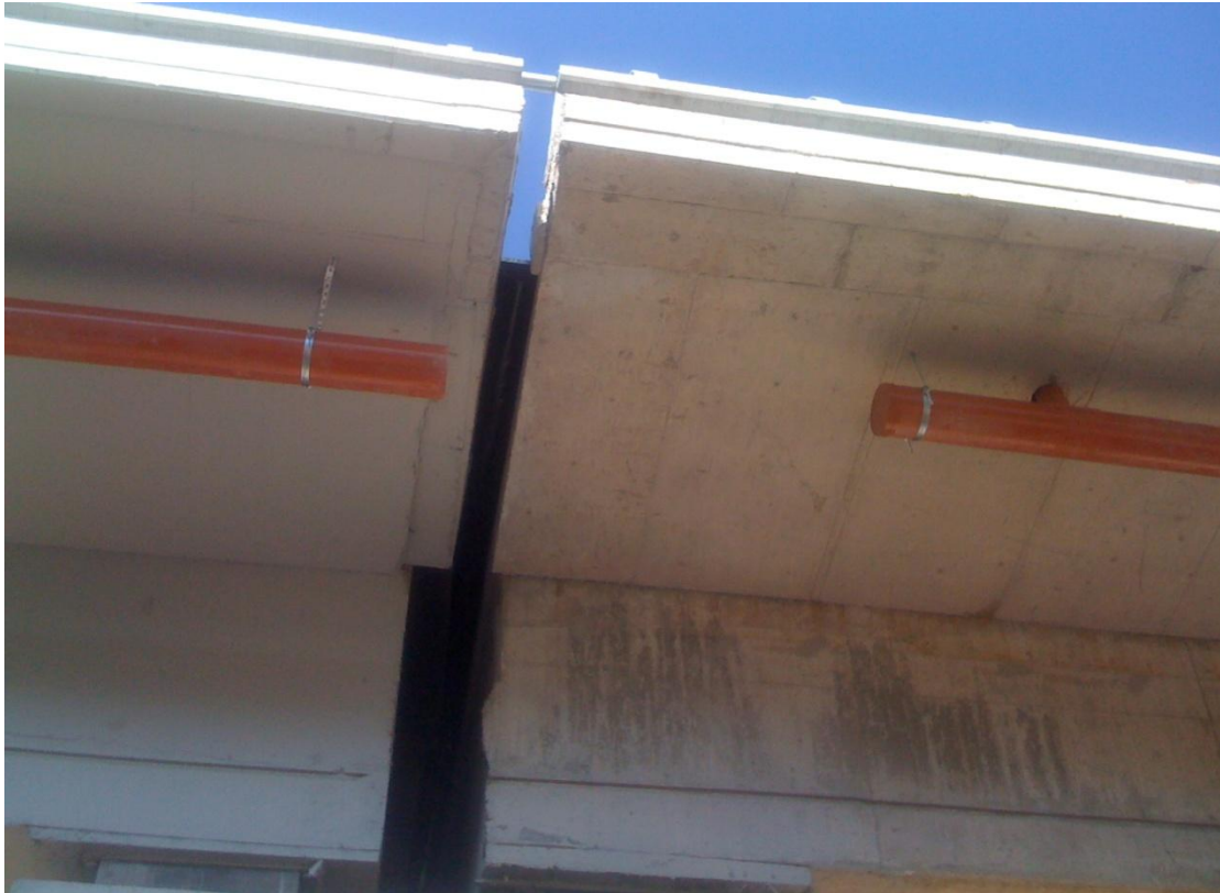
Φωτ.7.10 Αρμός (σε όψη) της παρούσας γέφυρας (δεξιά) με τη γέφυρα T5 (αριστερά) στη θέση του μεσόβαθρου M12.Δ.
