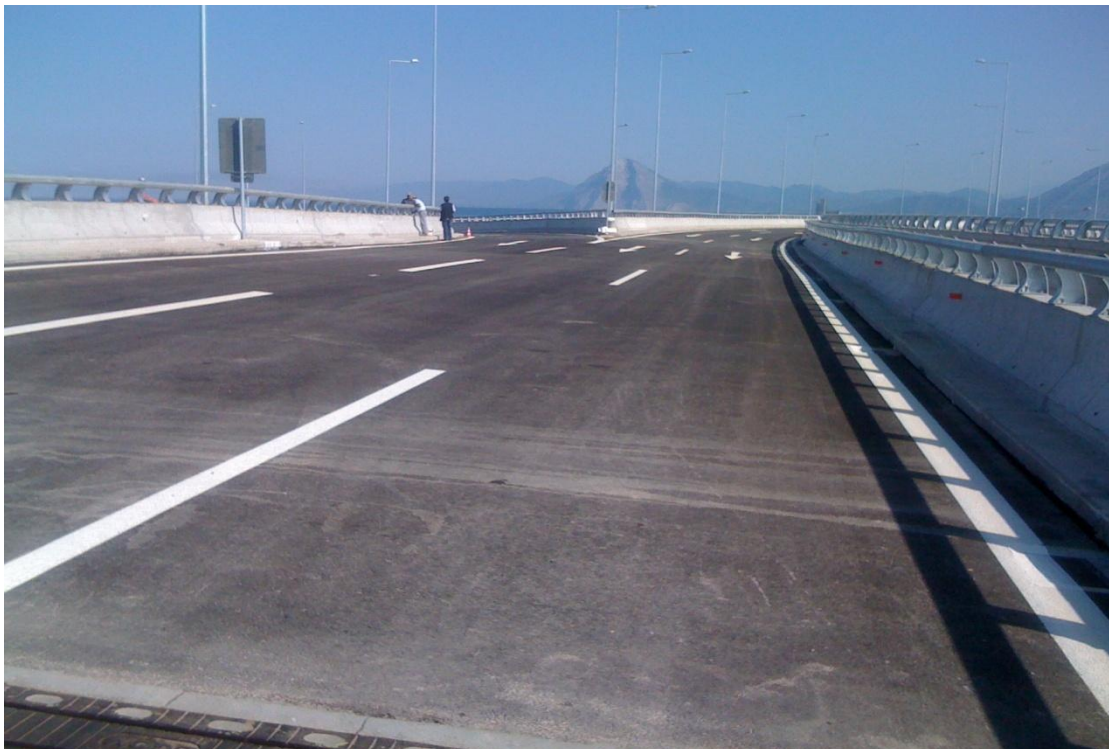
Φωτ.7.16 Λεπτομέρεια του αρμού πάνω από το μεσόβαθρο M10.Δ στην ένωση της παρούσας γέφυρας (αριστερά) με τη γέφυρα T3 (δεξιά).
