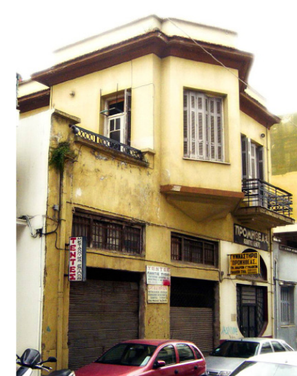
εικ. 31 Δ. Υψηλάντου 30 (1936), Οικία Μανωλοπούλου, Αρχιτέκτων Ν. Νομπάρ / Κυριαρχη η τριγωνική αρχιτεκτονική προεξοχή (έρκερ) και η περίτεχνη μορφή της πόρτας στο ισόγειο. Εμπειρεύονται οι κυριότερες αρχές του Art Nouveau και της νεοκλασσικής συμμετρίας
