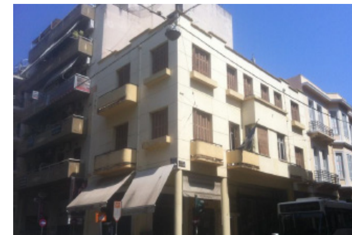
εικ. 17 Κανακάρη 150 και Πατρέως, Κτήριο Μιλτ. Ζαχαρόπουλου (1935-36). Λιτό και βαρύ κτήριο με έντονο το στοιχείο των εξωστών καθ'ότι είναι συμπαγείς με μια λωρίδα κενού στο κάτω μέρος.
