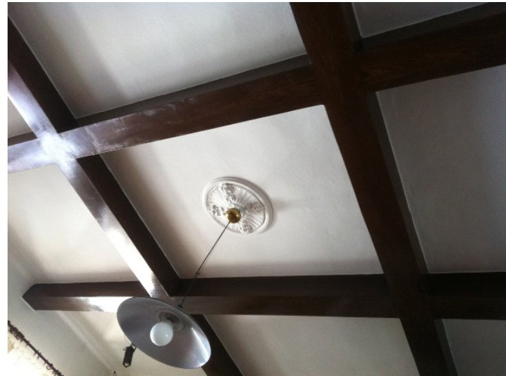
εικ. 125 Μπετονένια δοκάρια στο χώρο του καθιστικού
