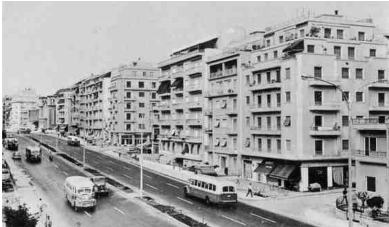
εικ. 154 Η Λεωφόρος Κηφισίας, με τις πρώτες πολυκατοικίες της
