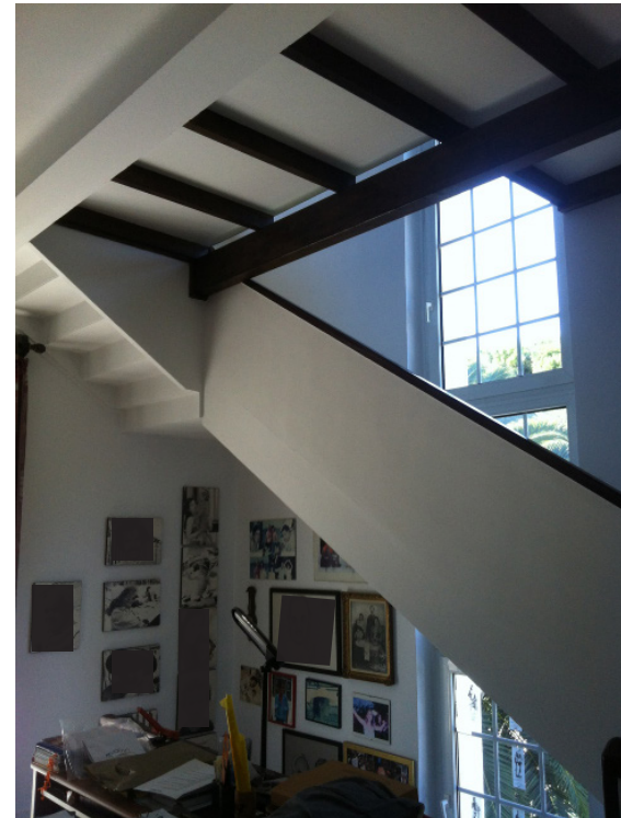
εικ. 126 Λεπτομέρεια σκάλας από Α' Όροφο
