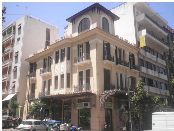
εικ. 58 Κτήριο Διον Τσαμαδού
