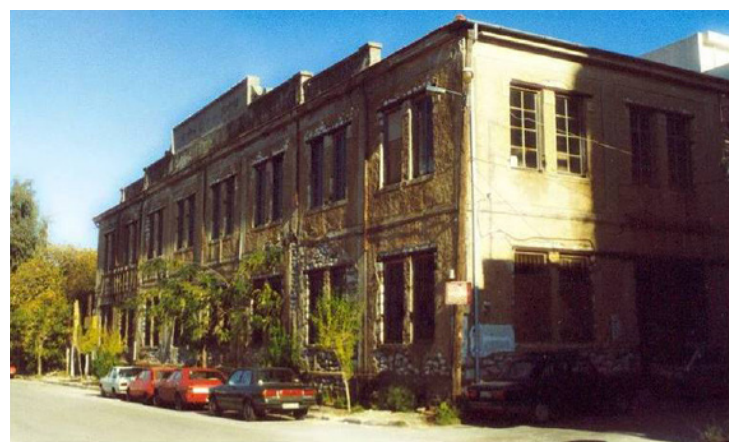
εικ. 40 Εργοστάσιο Αναστασόπουλου, Αθηνών, Ιωαννίνων, Γαννισών
