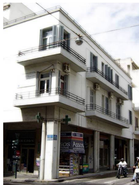
εικ. 27 Ερμού και Κανακάρη, (1934-35), Κτήριο Παπαδοπούλου, Αρχιτέκτων Ζ. Ναχνικιάν
