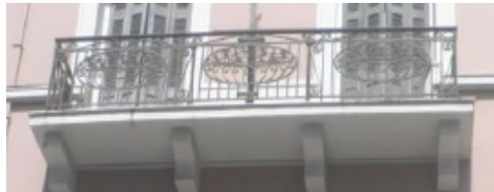
εικ. 98 Εξώστης Β' Ορόφου
