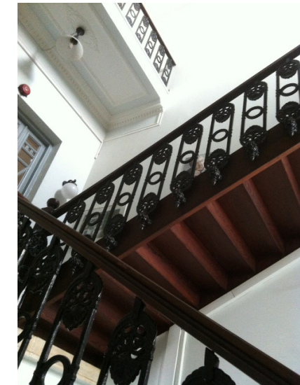
εικ. 101 Κλιμακοστάσιο, λήψη από όροφο
