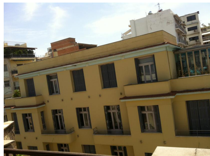
εικ. 140 Κτήριο Ασημακόπουλου, λήψη από το απέναντι κτήριο
