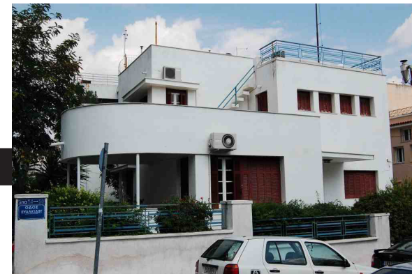
Οικία Οικ. Λαζαρίδου, Ευαλκίδου 54 και Πρεβέζης, Αθήνα, Νταμής Πετρόπουλος (αρχιτέκτων που σπούδασε στην Αυστρία), τροποποιήσεις στο σχέδιο από τον Τ.Μάρθα, 1936. Το κύριο συνθετικό χαρακτηριστικό είναι ο ημικυκλικός όγκος που δημιουργείται στην εξωτερική γωνία του κτιρίου (συμβολή των δρόμων), ο οποίος αποτελεί εξώστη στον όροφο και στεγασμένη βεράντα στο ισόγειο. Είναι ένα στοιχείο που συναντούμε και στην περίπτωση Βασιλείου και Παναγιωτάκου.
