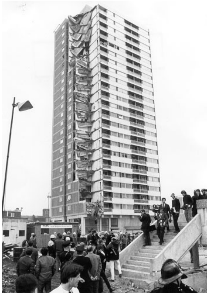
Σχήμα 4.2 Το πολυώροφο κτίριο Ronan Point μετά την έκρηξη του φυσικού αερίου το 1968 στο Λονδίνο [7].
