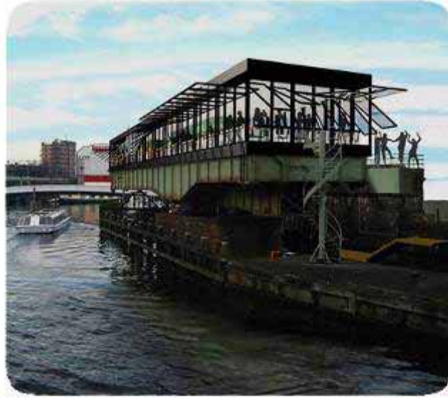
Σχήμα 3.9 Το εστιατόριο που κατασκευάστηκε από την άμεση ανακύκλωση του χάλυβα μιας σιδηροδρομικής γέφυρας στο Άμστερνταμ [8].
