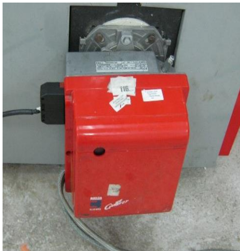
Εικόνα 1.8: Καυστήρας χαμηλής πίεσης καυσίμου
