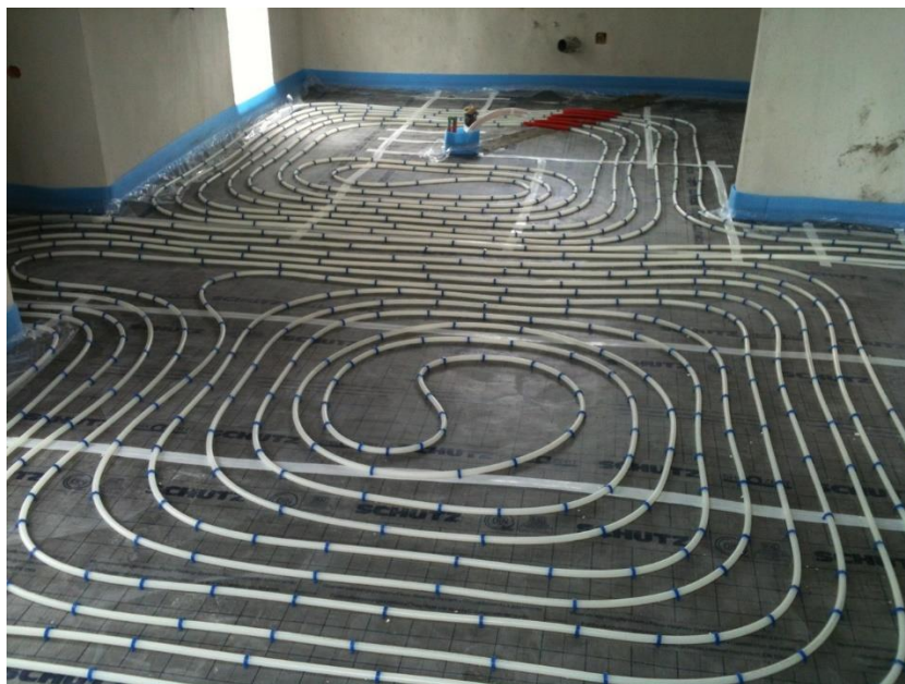
Εικόνα 1.3: Ενδοδαπέδιο σύστημα θέρμανσης [3]
