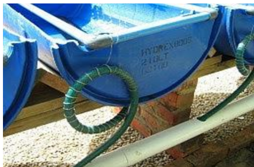
Εικόνα 27. Σιφόνι τύπου βρόχου (Πηγή: www.synaptoman.files.wordpress.com )
