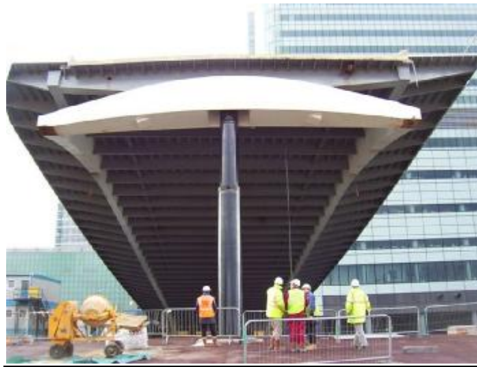
Σχήμα 3.3: Ανύψωση γέφυρας
