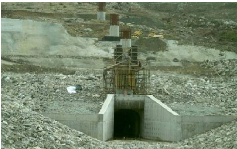
ΕΙΚΟΝΑ 7.1 : ΣΥΝΔΕΣΗ ΠΥΡΓΩΝ ΥΔΡΟΛΗΨΙΑΣ ΜΕ ΣΗΡΑΓΓΑ
