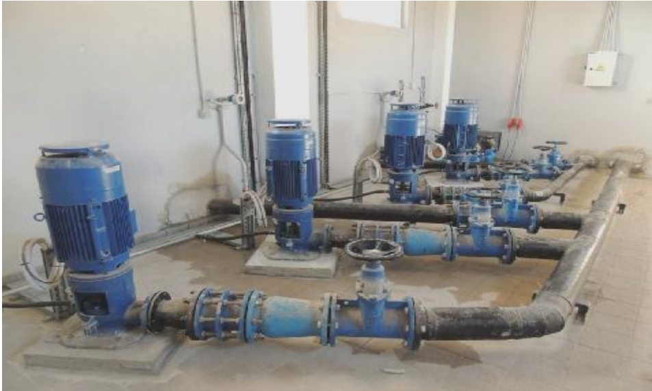
ΕΙΚΟΝΑ 10.16 : ΑΝΤΛΗΤΙΚΑ ΣΥΓΚΡΟΤΗΜΑΤΑ ΔΕΞΑΜΕΝΗΣ ΝΕΡΟΥ ΧΡΗΣΗΣ
