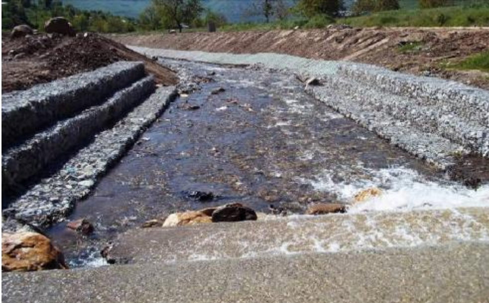
ΕΙΚΟΝΑ 6.4 : ΕΠΕΝΔΥΣΗ ΚΟΙΤΗΣ ΔΙΩΡΥΓΑΣ ΦΥΓΗΣ ΜΕ ΣΥΡΜΑΤΟΚΙΒΩΤΙΑ
