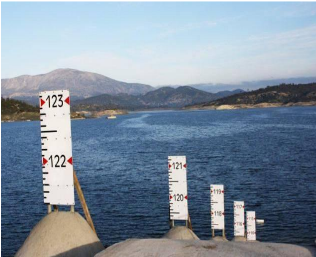
ΕΙΚΟΝΑ 7.3 : ΣΤΑΘΜΗΜΕΤΡΑ ΦΡΑΓΜΑΤΟΣ
