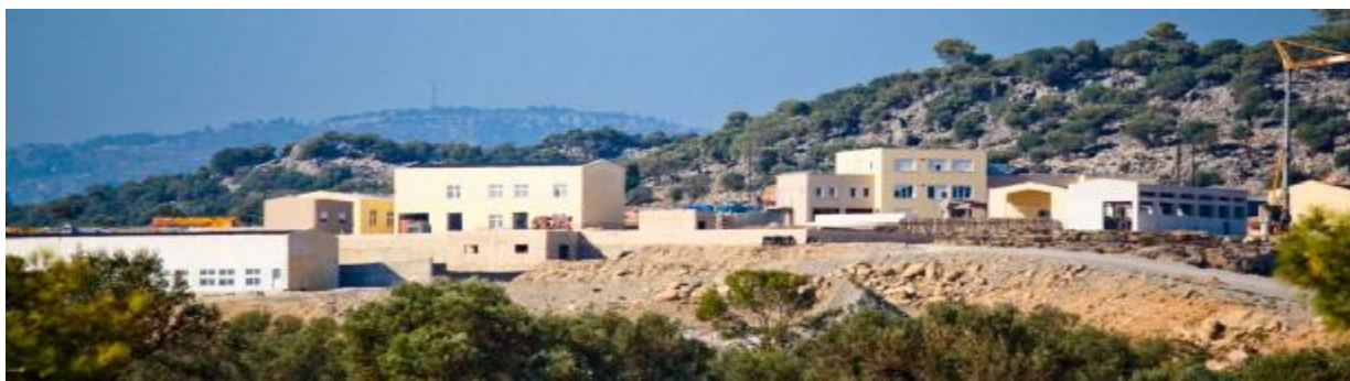
ΕΙΚΟΝΑ 3.5 : ΕΓΚΑΤΑΣΤΑΣΕΙΣ ΕΠΕΞΕΡΓΑΣΙΑΣ ΝΕΡΟΥ ΥΠΟ ΚΑΤΑΣΚΕΥΗ
