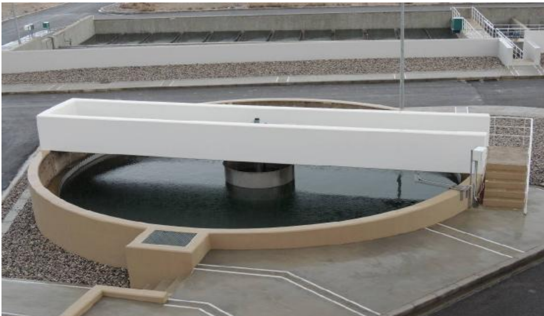
ΕΙΚΟΝΑ 10.19 : ΕΓΚΑΤΑΣΤΑΣΗ ΠΑΧΥΝΤΗ ΙΛΥΟΣ
