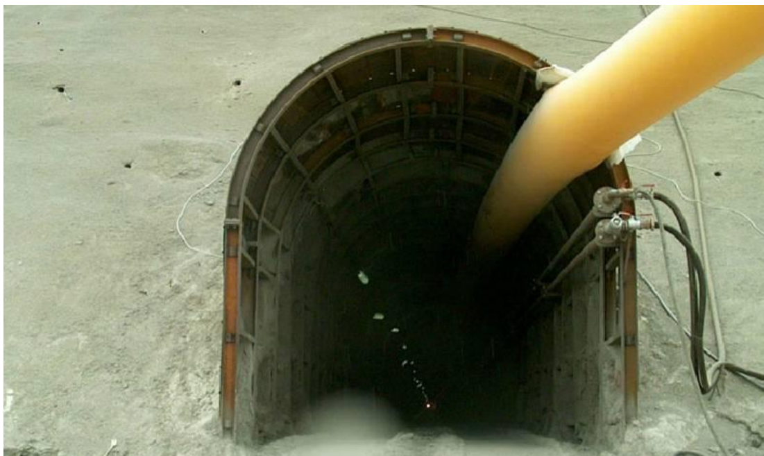
ΕΙΚΟΝΑ 3.4: ΕΙΣΟΔΟΣ ΣΗΡΑΓΓΑΣ ΥΔΡΑΓΩΓΕΙΟΥ
