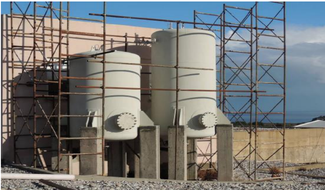
ΕΙΚΟΝΑ 10.17 : ΑΕΡΟΦΥΛΑΚΙΑ ΔΕΞΑΜΕΝΗΣ ΝΕΡΟΥ ΧΡΗΣΗΣ
