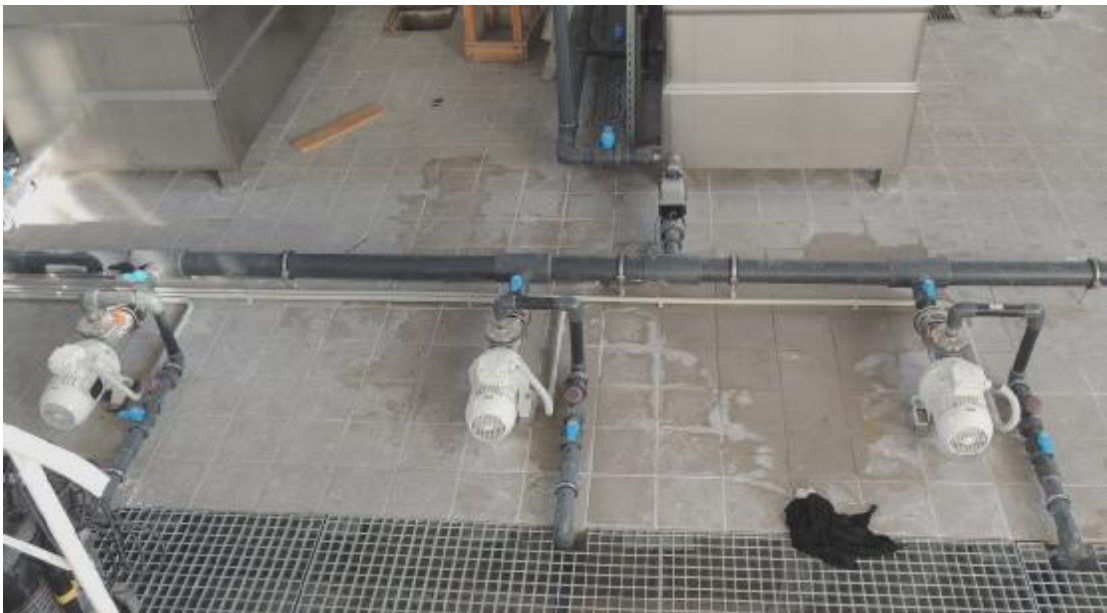
ΕΙΚΟΝΑ 10.7 : ΣΥΣΤΟΙΧΙΑ ΤΡΙΩΝ ΔΟΣΟΜΕΤΡΙΚΩΝ ΑΝΤΛΙΩΝ ΘΕΙΚΟΥ ΑΡΓΙΛΙΟΥ
