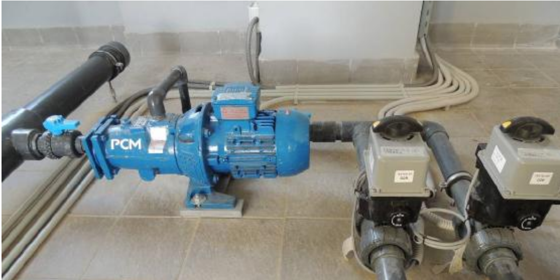
ΕΙΚΟΝΑ 10.6 : ΚΟΝΤΙΝΗ ΛΗΨΗ ΔΟΣΟΜΕΤΡΙΚΗΣ ΑΝΤΛΙΑΣ ΠΟΛΥΗΛΕΚΤΡΟΛΥΤΗ
