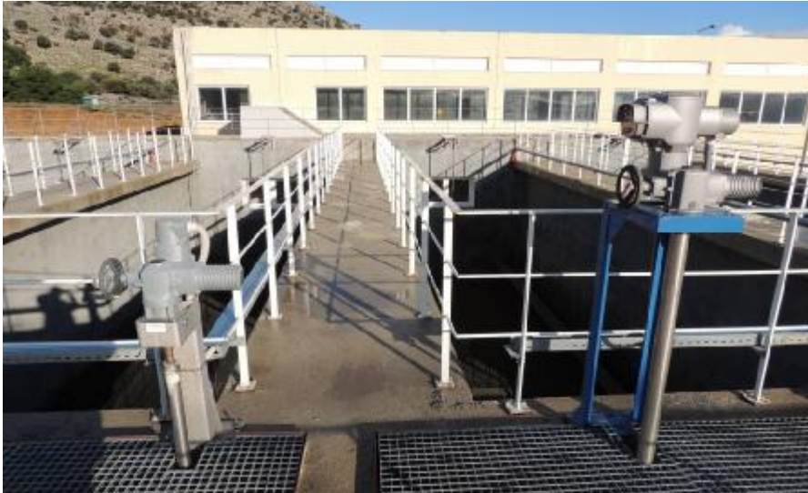
ΕΙΚΟΝΑ 10.13 : ΔΙΚΛΕΙΔΑ ΔΙΟΧΕΤΕΥΣΗΣ ΑΚΑΘΑΡΤΟΥ ΝΕΡΟΥ ΠΛΥΣΗΣ (ΑΡΙΣΤΕΡΑ)- ΑΥΤΟΜΑΤΗ ΡΥΘΜΙΣΤΙΚΗ ΔΙΚΛΕΙΔΑ ΔΙΥΛΙΣΜΕΝΟΥ ΝΕΡΟΥ (ΔΕΞΙΑ)
