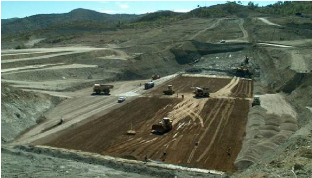
ΕΙΚΟΝΑ 4.1 : ΕΡΓΑΣΙΕΣ ΔΙΑΣΤΡΩΣΗΣ ΠΥΘΜΕΝΑ ΦΡΑΓΜΑΤΟΣ
