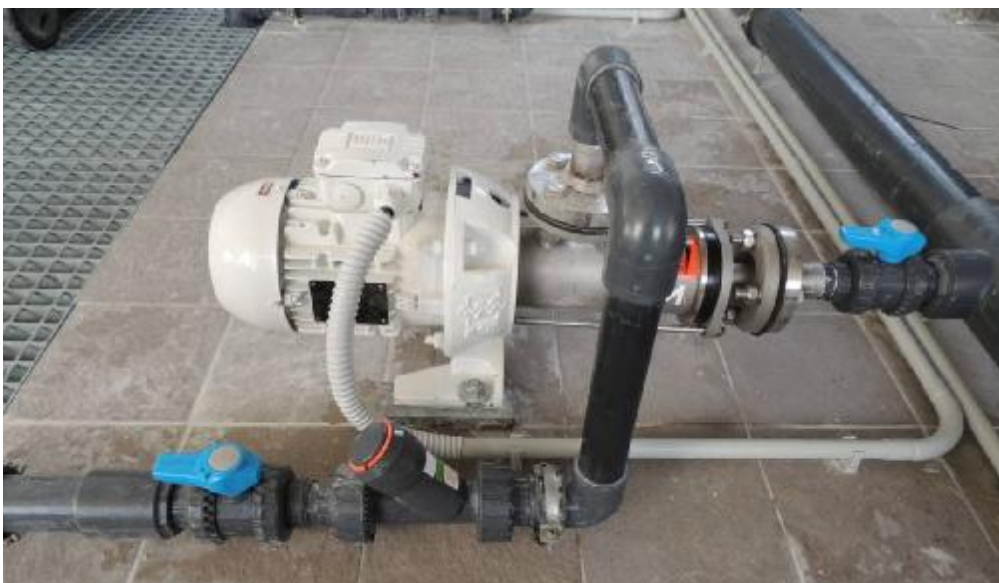
ΕΙΚΟΝΑ 10.8 : ΚΟΝΤΙΝΗ ΛΗΨΗ ΔΟΣΟΜΕΤΡΙΚΗΣ ΑΝΤΛΙΑΣ ΘΕΪΚΟΥ ΑΡΓΙΛΙΟΥ
