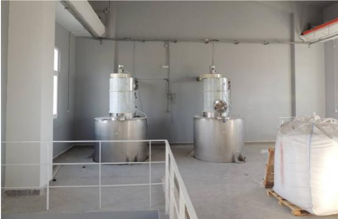
ΕΙΚΟΝΑ 10.1 : ΔΙΑΤΑΞΗ ΤΡΟΦΟΔΟΣΙΑΣ ΘΕΪΚΟΥ ΑΡΓΙΛΙΟΥ ( ΔΑΠΕΔΟ Α΄ ΟΡΟΦΟΥ )
