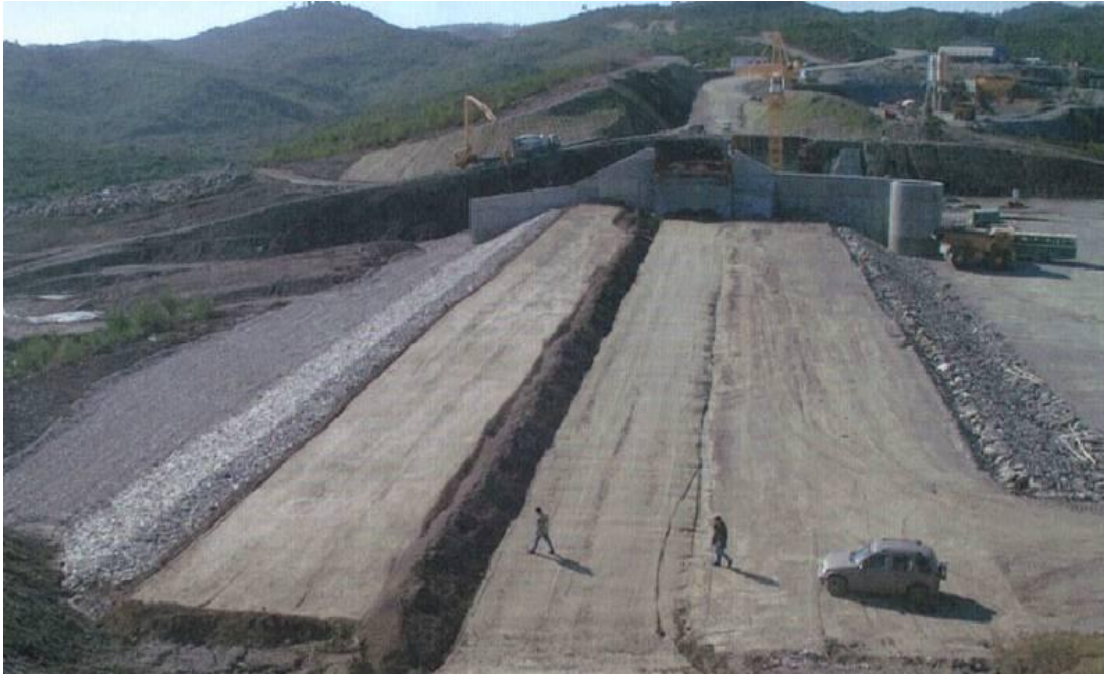
ΕΙΚΟΝΑ 4.2 : ΕΡΓΑΣΙΕΣ ΚΑΤΑΣΚΕΥΗΣ ΚΕΛΥΦΩΝ ΑΠΟ ΑΜΜΟΧΑΛΙΚΑ
