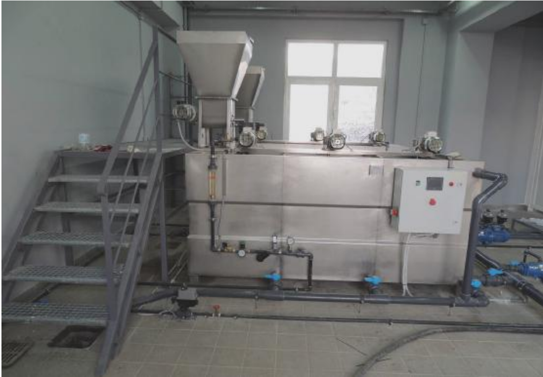
ΕΙΚΟΝΑ 10.4 : ΔΙΑΤΑΞΗ ΠΑΡΑΣΚΕΥΗΣ ΔΙΑΛΥΜΑΤΟΣ ΠΟΛΥΗΛΕΚΤΡΟΛΥΤΗ
