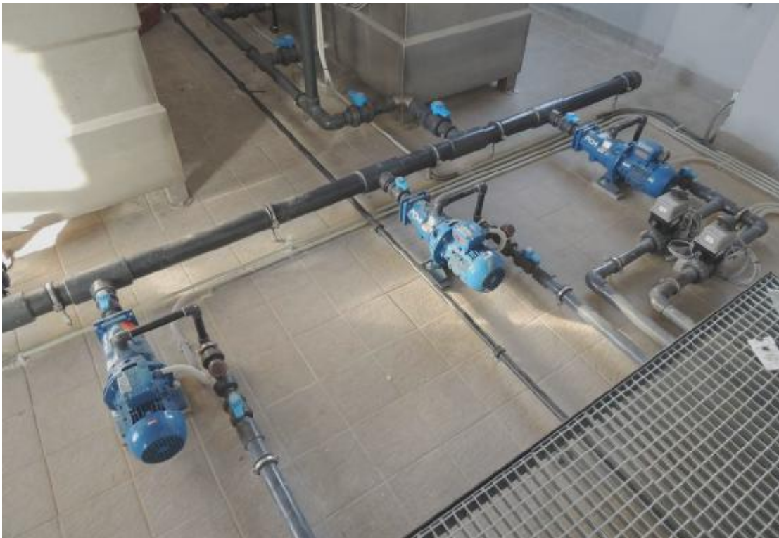
ΕΙΚΟΝΑ 10.5 : ΣΥΣΤΟΙΧΙΑ ΤΡΙΩΝ ΔΟΣΟΜΕΤΡΙΚΩΝ ΑΝΤΛΙΩΝ ΠΟΛΥΗΛΕΚΤΡΟΛΥΤΗ
