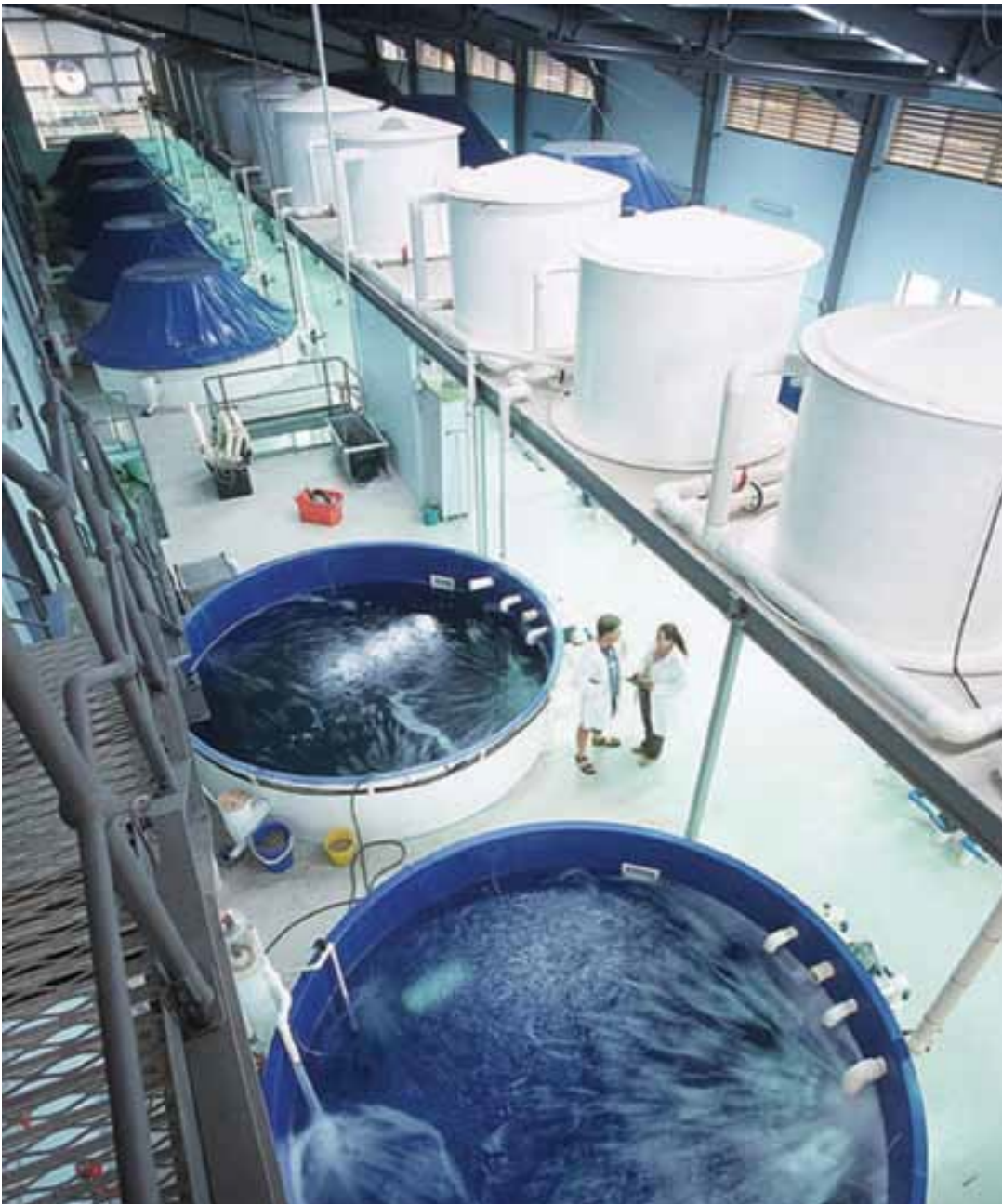
Εικόνα 9. Πολυεστερικές δεξαμενές που φιλοξενούν γεννήτορες ροφών τίγρεων, στο Κέντρο Βόρειας Αλιείας, Καίνζ, Κουίνσλαντ, Αυστραλία. Οι δεξαμενές στο προσκήνιο είναι περίπου 20 κυβικά μέτρα και καθεμία είναι εξοπλισμένη με σύστημα επανακυκλοφορίας που περιλαμβάνει ένα βιολογικό φίλτρο (άσπρες υπερυψωμένες δεξαμενές) και σύστημα όζοντος για τη διατήρηση ποιότητας του νερού, καθώς και ανταλλάκτη θερμότητας για τη διατήρηση της θερμοκρασίας του νερού. Κάποιες δεξαμενές είναι καλυμμένες (παρασκήνιο) και εξοπλισμένες με συστήματα φωτισμού ελεγχόμενα από υπολογιστή για τον έλεγχο της διάρκειας της μέρας καθώς και της θερμοκρασίας. (Φωτογραφία: Τμήμα Βιομηχανιών και Αλιείας του Κουίνσλαντ).
