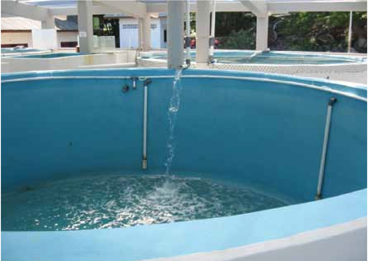
Εικόνα 8. Τσιμεντένιες δεξαμενές που χρησιμοποιούνται για την διατήρηση ροφών τίγρεων στο Κέντρο Ανάπτυξης Υδατοκαλλιέργειας Brackishwater, Ουζούνγκ Μπατί, Ινδονησία. Καθεμία από τις δεξαμενές αυτές έχει όγκο περίπου 50 κυβικά μέτρα. (Φωτογραφία: M. Rimmer)
