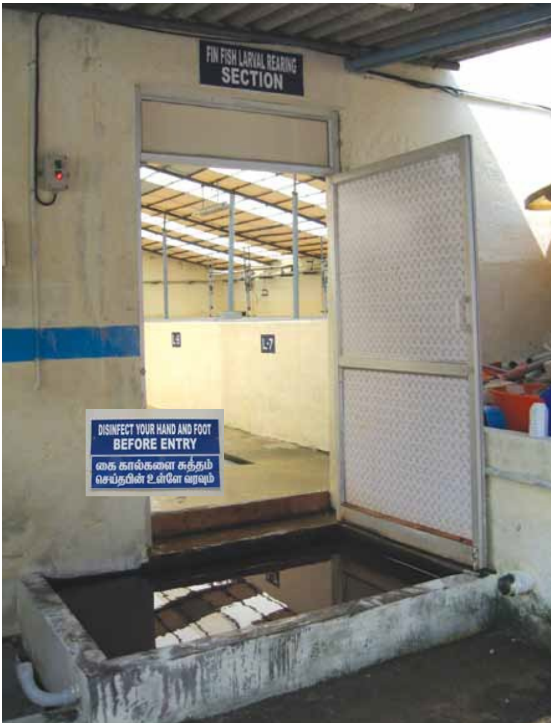
Εικόνα 6. Για τη διασφάλιση της βιοασφάλειας, τα εκκολαπτήρια θα πρέπει να εξοπλίζονται από πόρτες με δυνατότητα κλειδώματος και κάθε είσοδος θα πρέπει να διαθέτει ποδόλουτρο. Η σηματοδότηση θα πρέπει να συμπεριλαμβάνει οδηγίες απολύμανσης χεριών και υποδημάτων στην είσοδο (ενθέτως) και γραπτή απαγόρευση πρόσβασης σε μη εξουσιοδοτημένους επισκέπτες (δεν απεικονίζεται). (Φωτογραφία: M. Rimmer)
