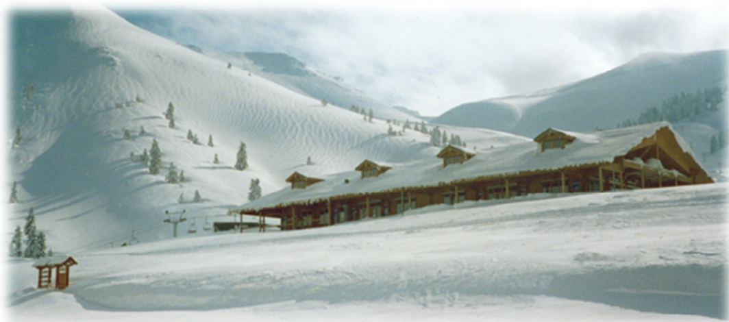
Φωτογραφία 11-Σαλέ Χιονοδρομικού Καλαβρύτων
