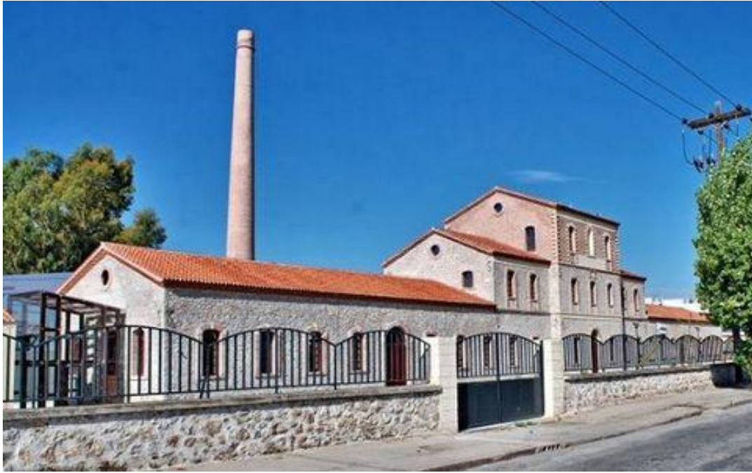
Οινοποιείο και Παγοποιείο "ΑΡΕΘΟΥΣΑ" Μετά την αποκατάσταση του.
