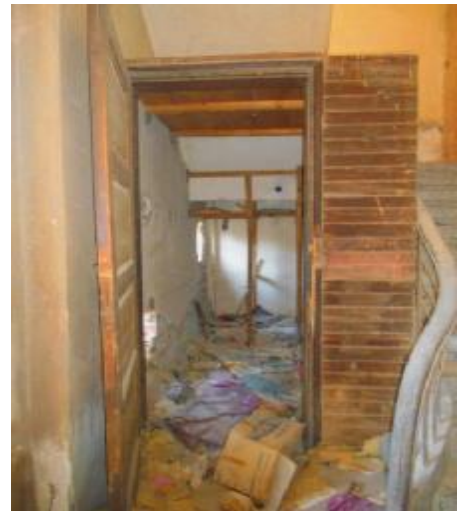
Χώρος ξύλινης κατασκευής
