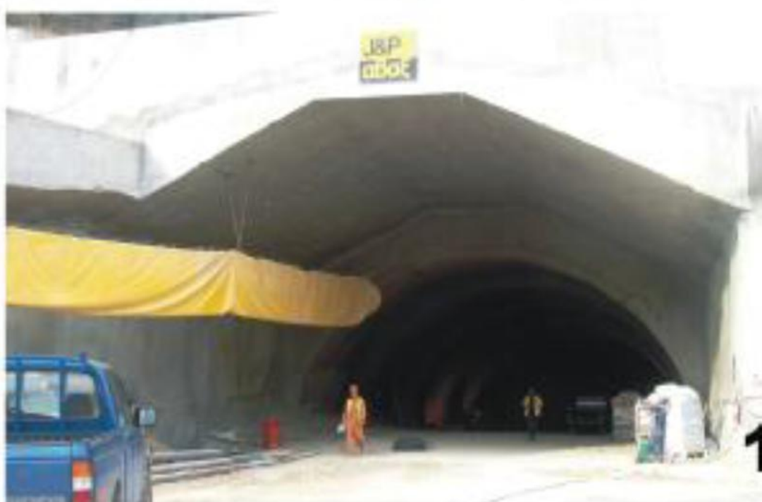
Εικόνα 20. Σήραγγα T13A της Ακράτας
