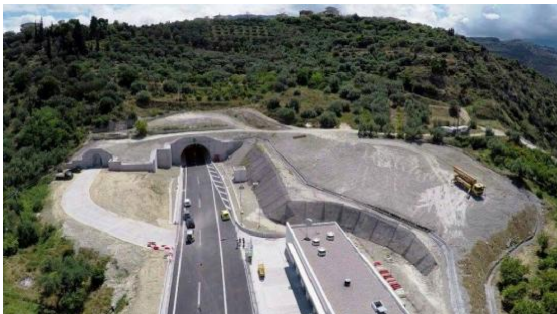
Εικόνα 36. Πανοραμική θέα Δυτικού στομίου και κέντρο ελέγχου.
