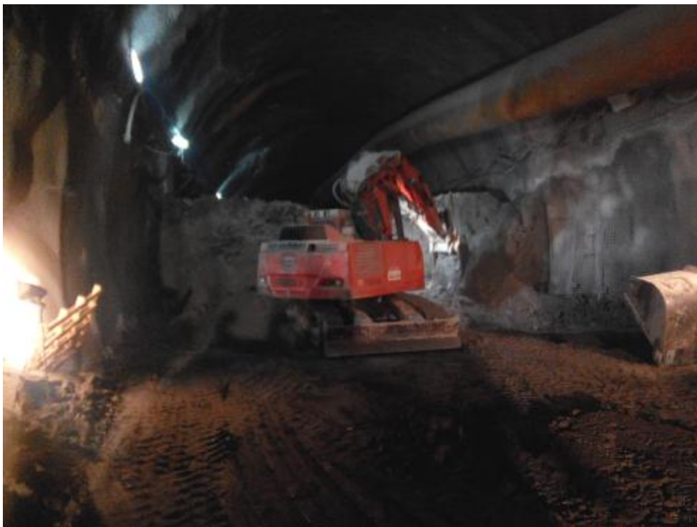
Εικόνα 55. Εκσκαφή, Β φάση.
