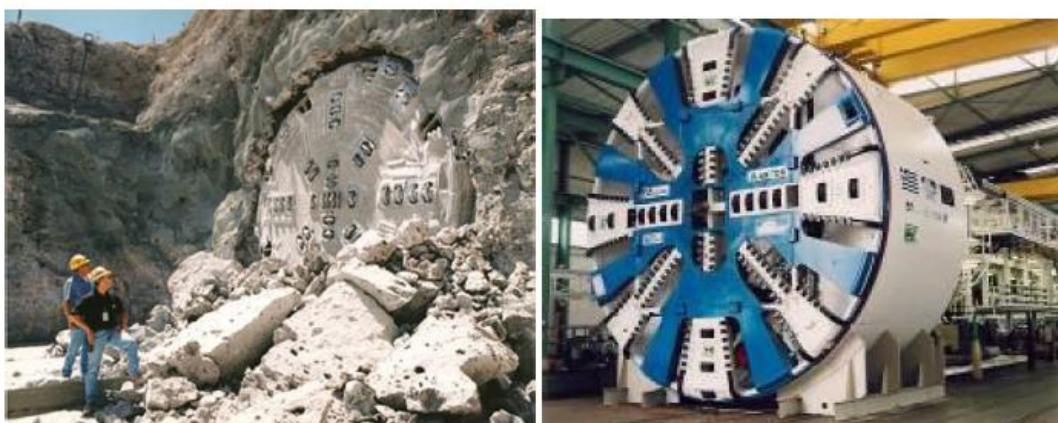
Εικόνα 16. α) TBM κατά την έξοδο του από τη σήραγγα σε βραχώμαζα β) TBM που χρησιμοποιήθηκε στο Μετρό Αθηνών
