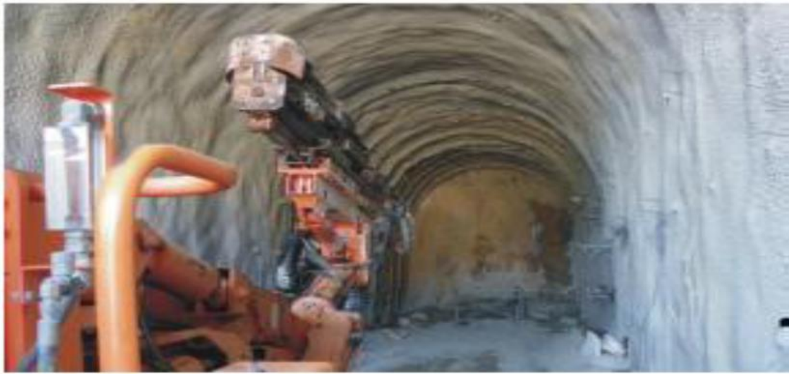
Εικόνα 21. Σήραγγα T13A της Ακράτας
