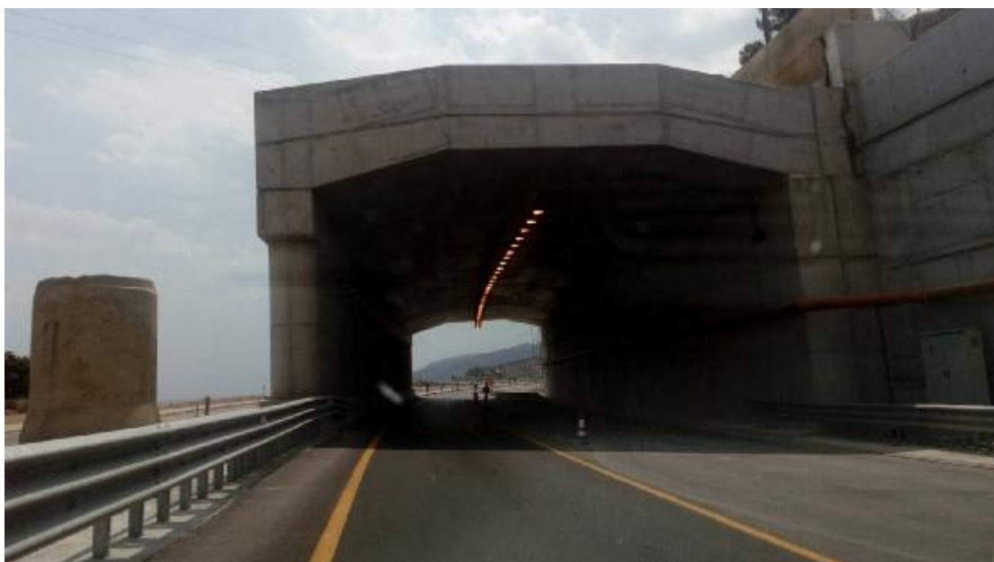
Εικόνα 37. Τεχνικό lane cover μετά το ανατολικό στόμιο.
