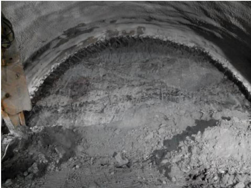
Εικόνα 54. Εκσκαφή, Α φάση.
