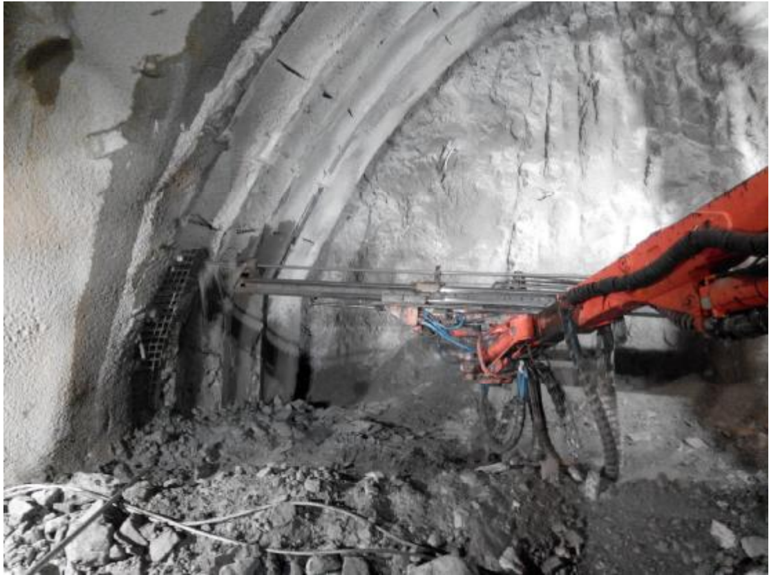
Εικόνα 56. Διάτρηση αγκυρίων.
