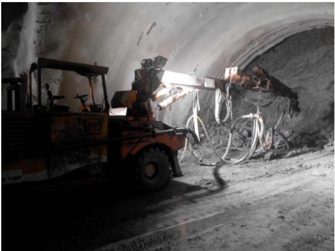
Εικόνα 57. Εφαρμογή εκτοξευόμενου σκυροδέματος.
