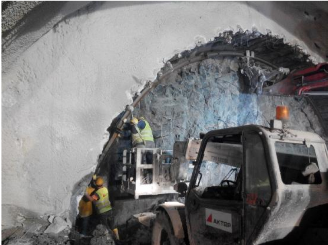
Εικόνα 58. Τοποθέτηση πλαισίων.
