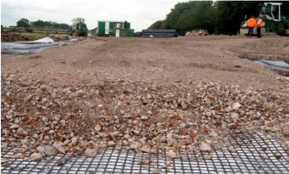
Εικόνα 2.23: Τοποθέτηση γεωπλεγμάτων στην επιφάνεια «ασθενούς» εδάφους
