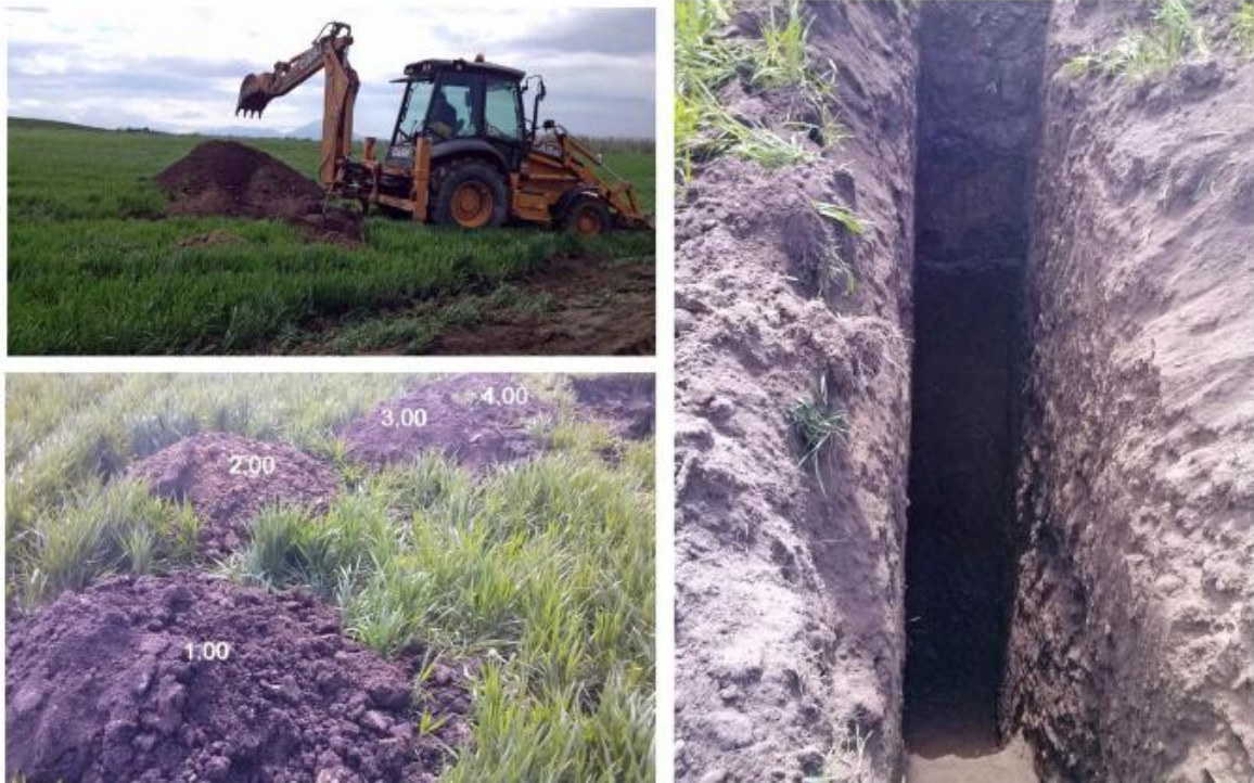
Εικόνα 3.1: Εκσκαφή ερευνητικού φρέατος
