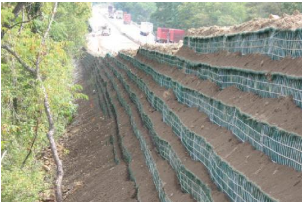
Εικόνα 2.21: Χρήση γεωπλεγμάτων στην ενίσχυση και σταθεροποίηση πρανών
