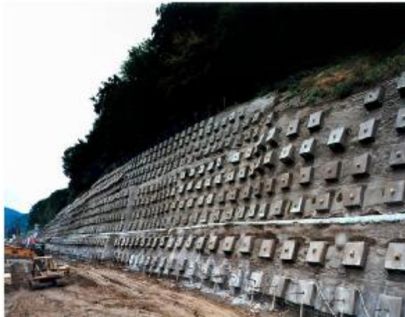
Εικόνα 2.25: Εδαφοήλωση
