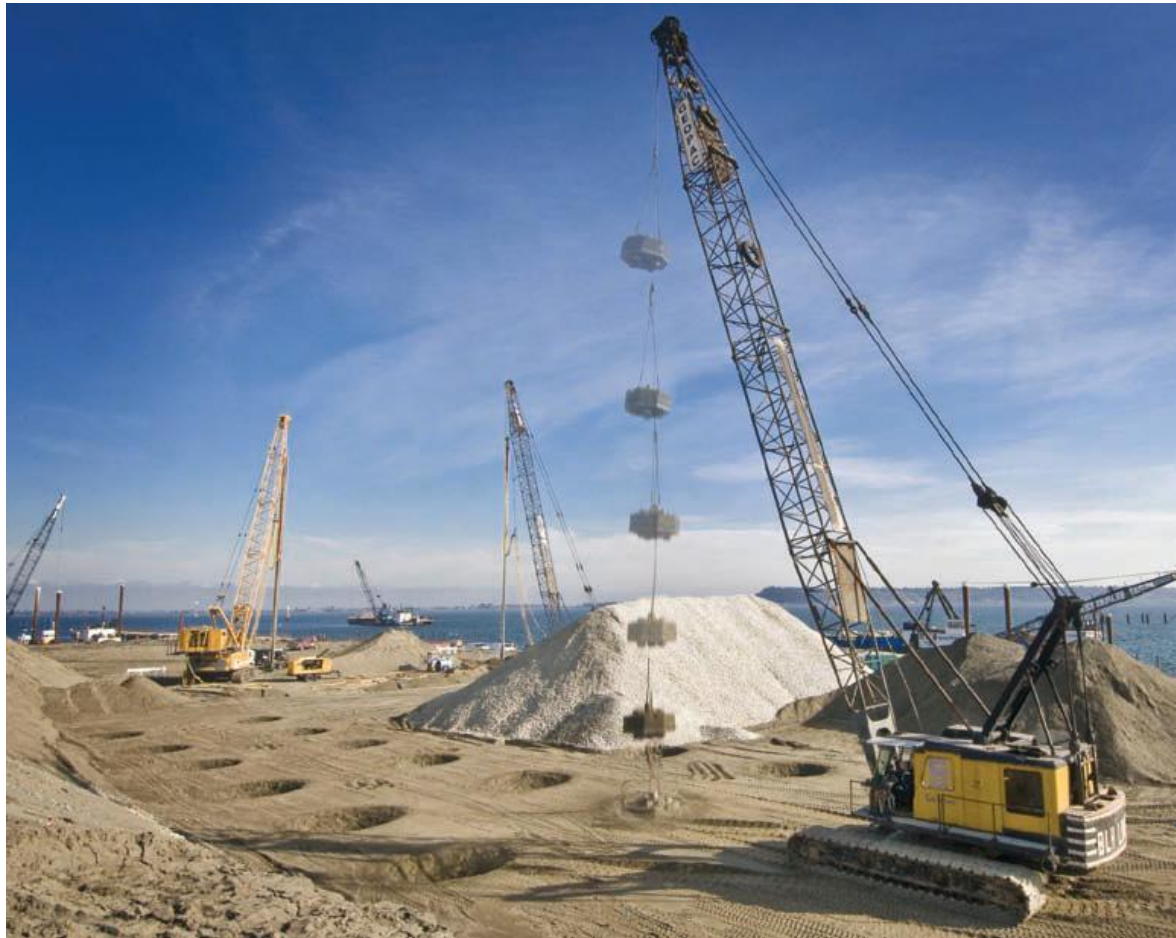
Εικόνα 2.27: Εφαρμογή της μεθόδου δυναμικής συμπίκνωσης
