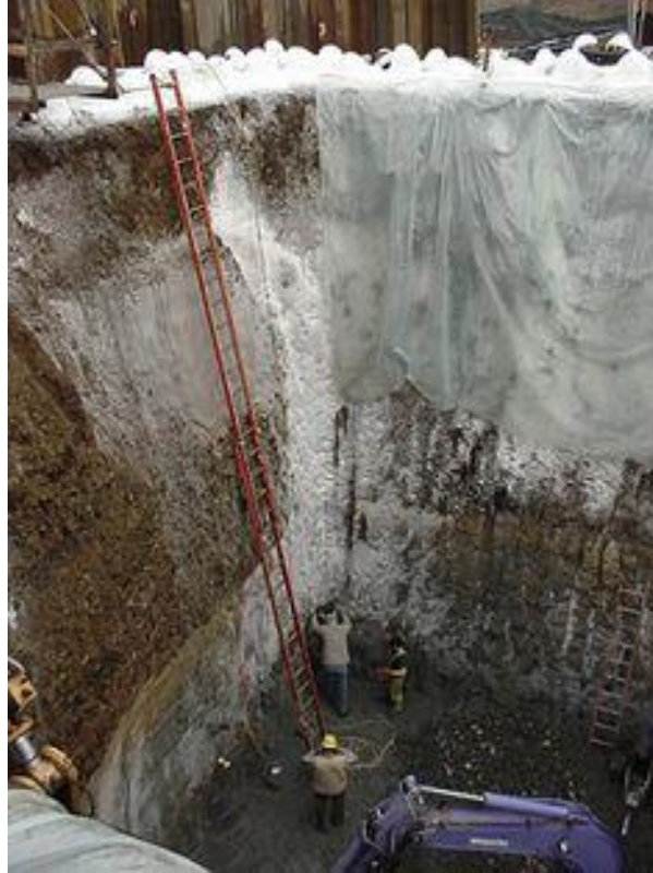
Εικόνα 2.40: Εφαρμογή μεθόδου ψύξης του εδάφους σε βαθιά εκσκαφή
