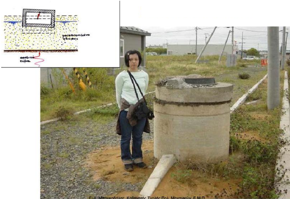
Εικόνα 2.3: Αστοχία θεμελίωσης φρεατίου λόγω ρευστοποίησης εδάφους - Hokkaido, Ιαπωνία (2003)
