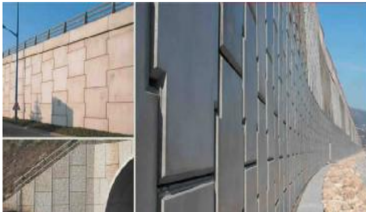
Εικόνα 2.18: Στοιχεία πρόσοψης που χρησιμοποιούνται στην μέθοδο Οπλισμένης Γης.
