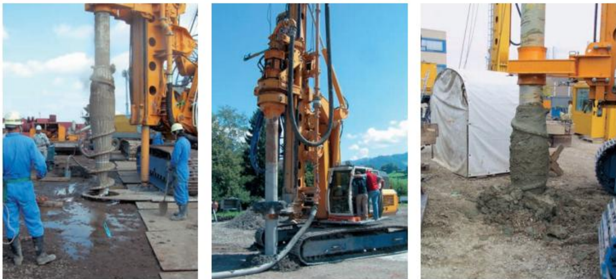
Εικόνα 2.38: Κατασκευή πασσάλων πλήρους εκτόπισης FDP
