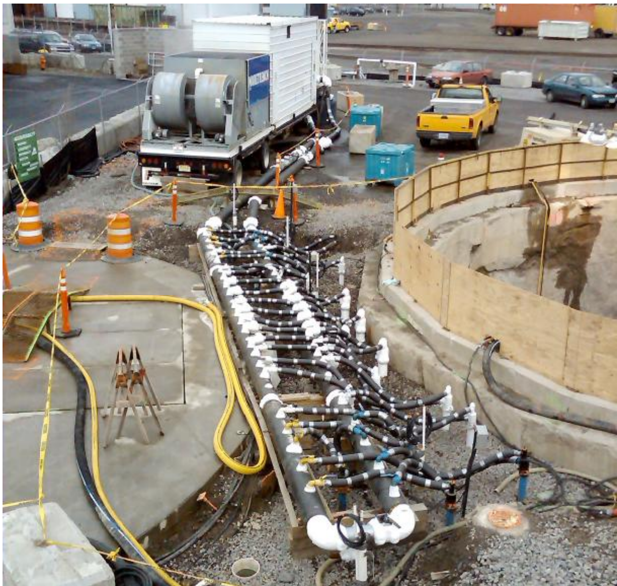
Εικόνα 2.39: Διάταξη ψύξης του εδάφους για σταθεροποίηση
