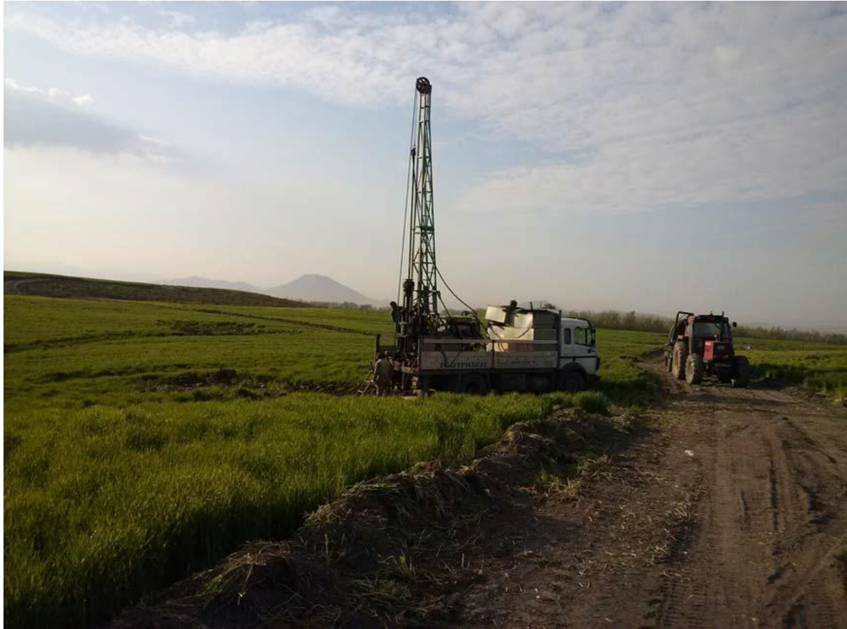
Εικόνα 3.2: Δειγματοληπτική γεώτρηση
