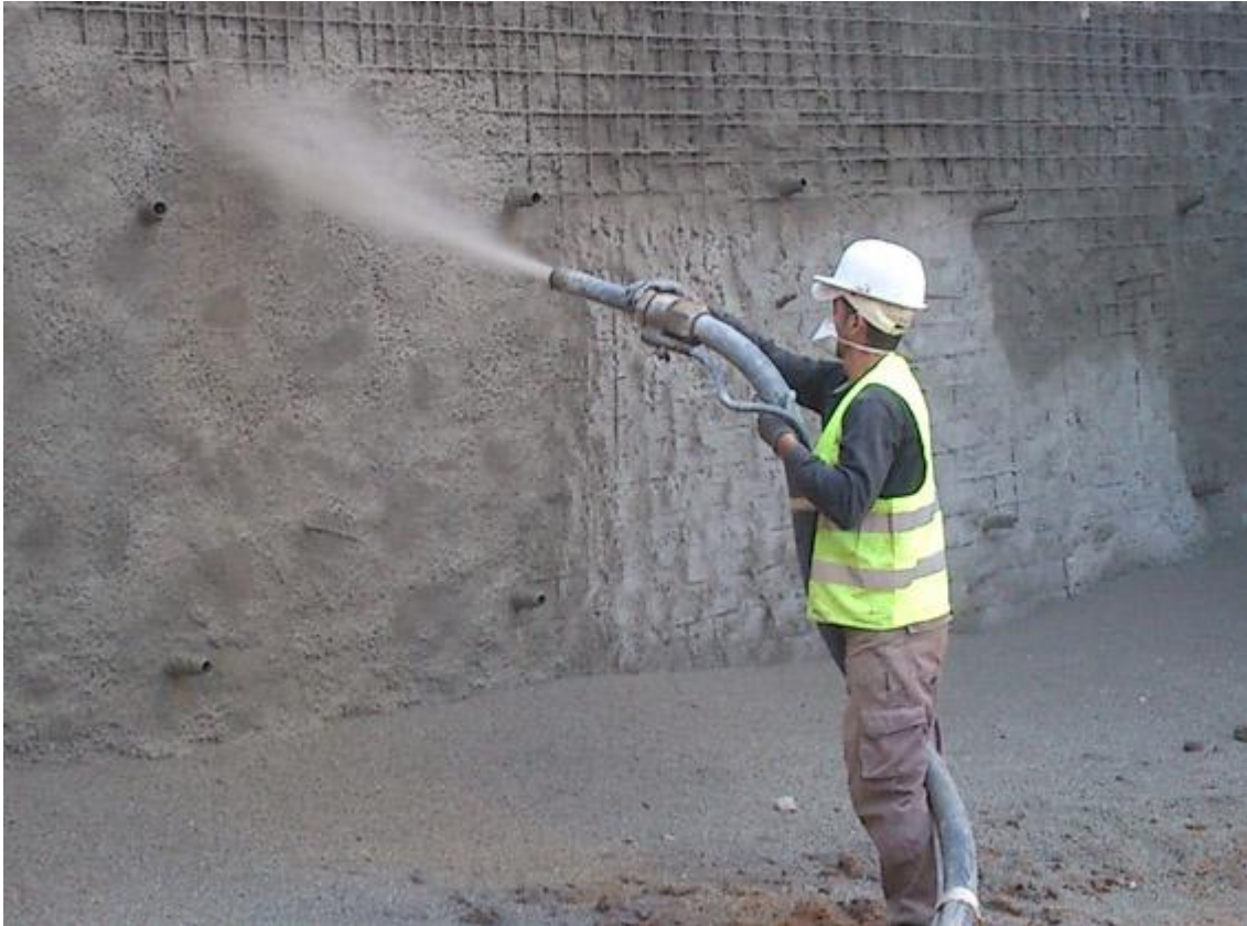
Εικόνα 2.33: Εκτοξευόμενο σκυρόδεμα (Gunité)
