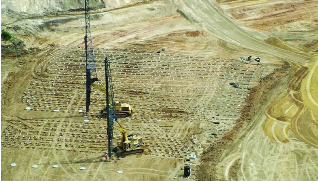
Εικόνα 2.9: Τα κατακόρυφα γεωσύνθετα στραγγιστήρια τοποθετούνται μέσα στο έδαφος με τη βοήθεια ειδικού γερανού με κατακόρυφο οδηγό, σε μικρές μεταξύ τους αποστάσεις των 2 - 4 m
