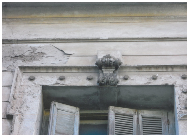
Εικόνα 4. Τραβηγτό επίχρισμα με σχέδια σε κορνίζα παραθύρου
