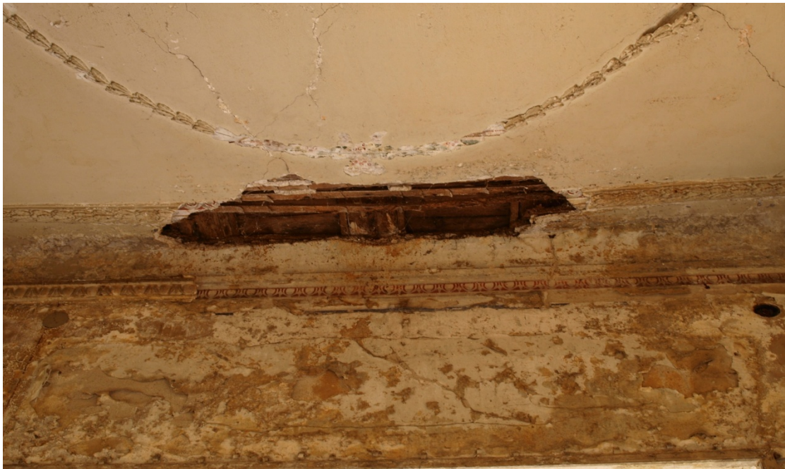
Εικόνα 47.Πτώση επιχρίσματος και εμφάνιση μπαγδατί
