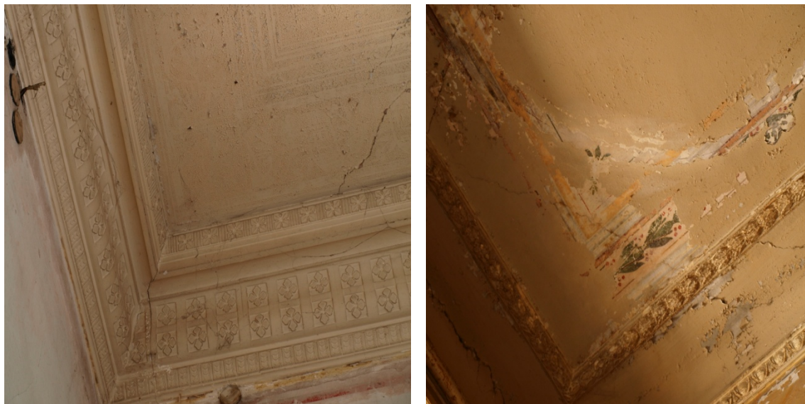
Εικόνα 42.Εμφάνιση ζωγραφικού διάκοσμου από αποσαθρώσεις του χρώματος στις οροφές
