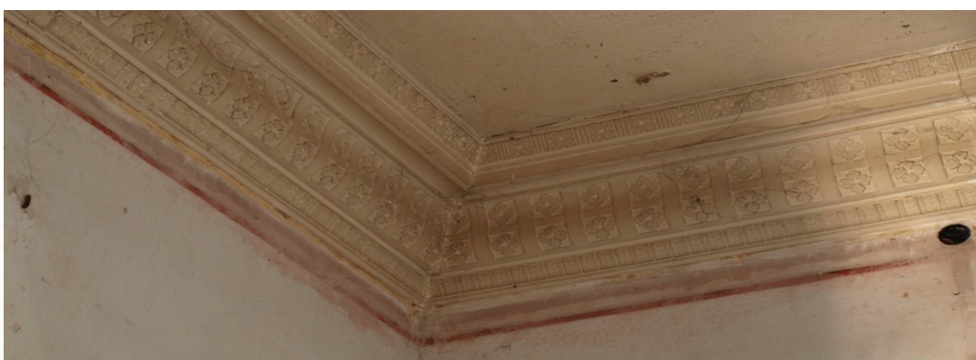
Εικόνα 15.Γύψινα περιμετρικά των δωματίων
