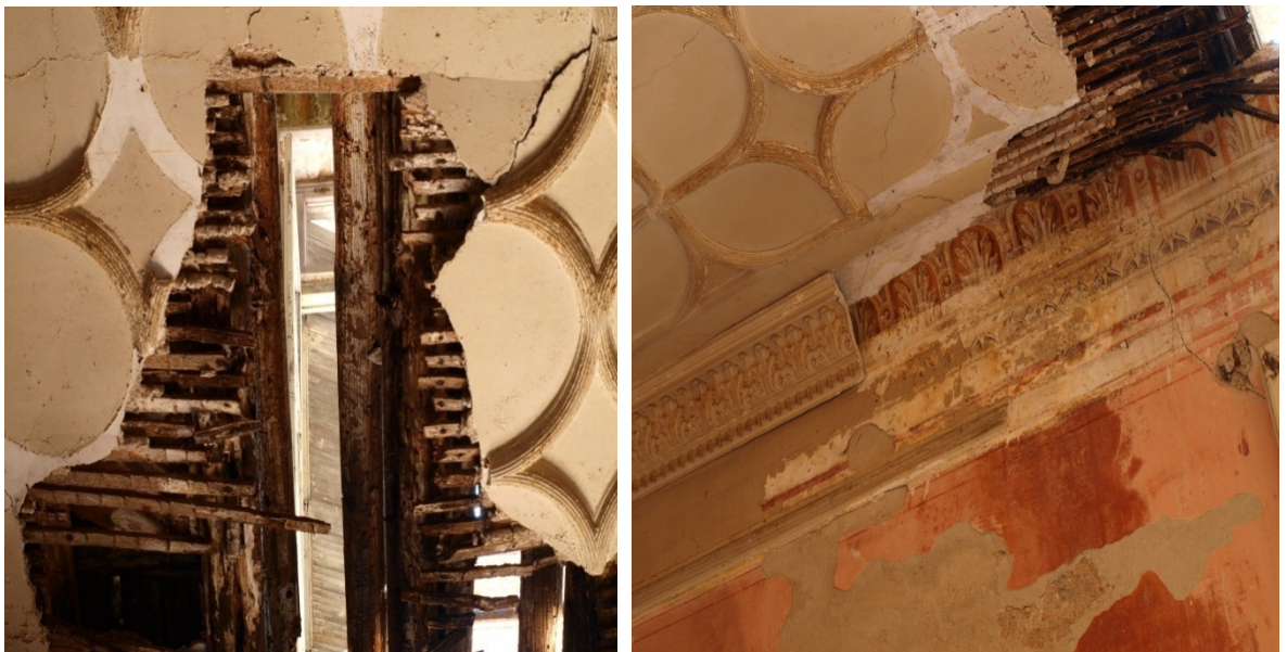
Εικόνα 41. Αποκολλήσεις επένδυσης και περιμετρικών γύψινων
