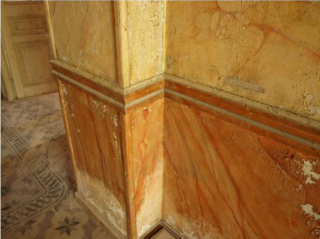
Εικόνα 26.Φθορές ζωγραφικού διάκοσμου ισογείου από υγρασία
