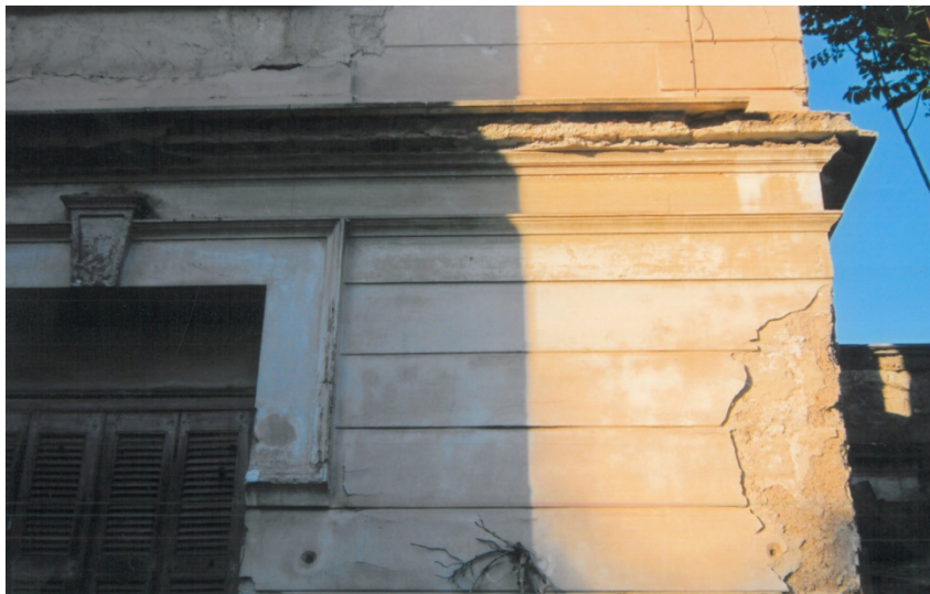
Εικόνα 1. Σκοτίες από επίχρισμα
