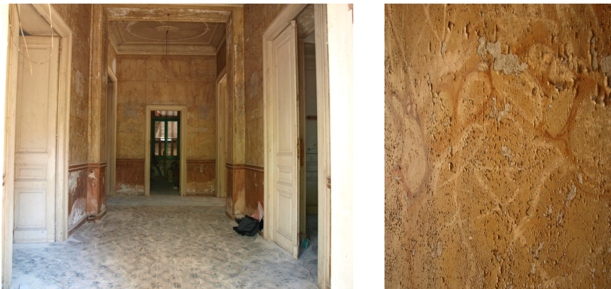
Εικόνα 8.Απομίμηση μαρμάρου με χρώμα σε μπέζ, καφέ και πράσινες αποχρώσεις περιμετρικά του διαδρόμου υποδοχής
