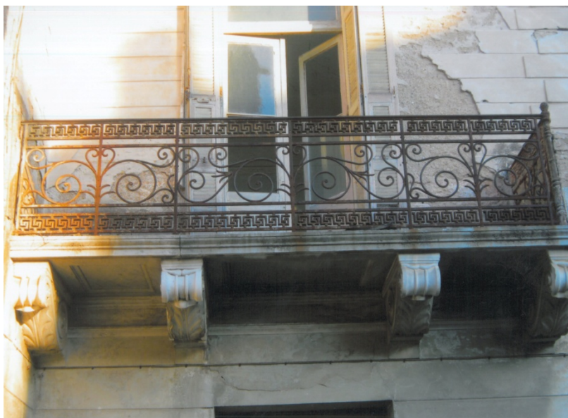
Εικόνα 57. Αποκολλήσεις των μαρμάρων των στηθαίων
