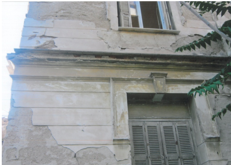
Εικόνα 3. Περιμετρική ταινία, τραβηγτό επίχρισμα
