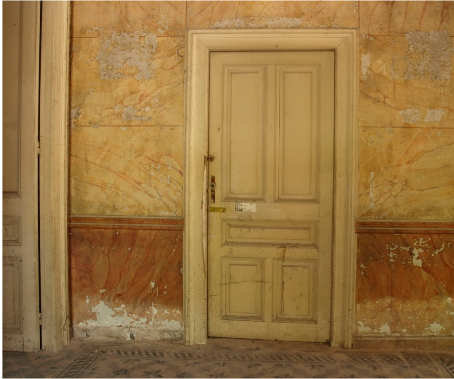
Εικόνα 49.Μονόφυλλη πόρτα ισογείου με ελάχιστες φθορές
