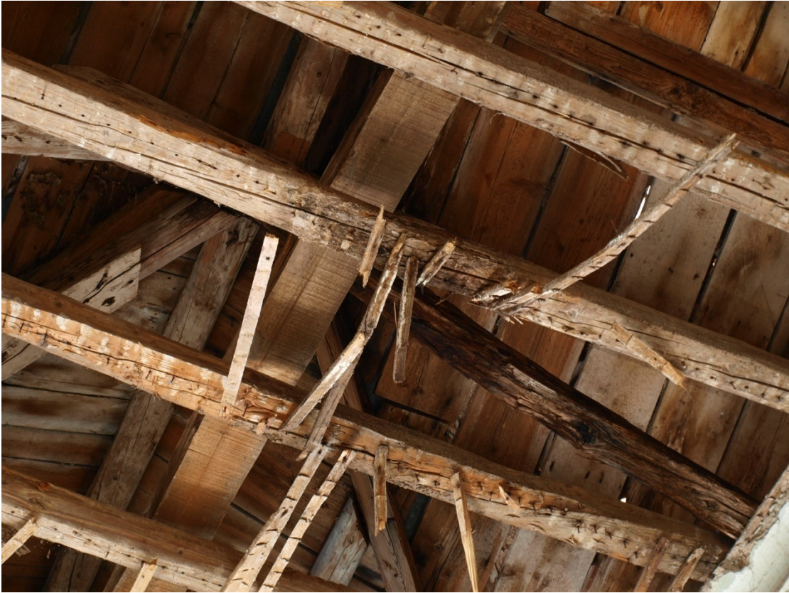
Εικόνα 34.Ζευκτό στέγης και ίχνη από μπαγδατί
