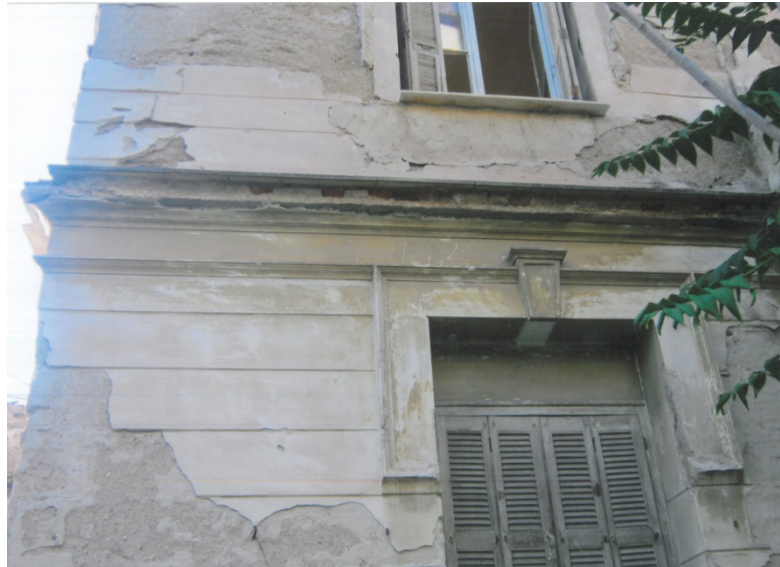
Εικόνα 20. Αποσαθρώσεις και αποκολλήσεις τραβηγτών διακοσμητικών
