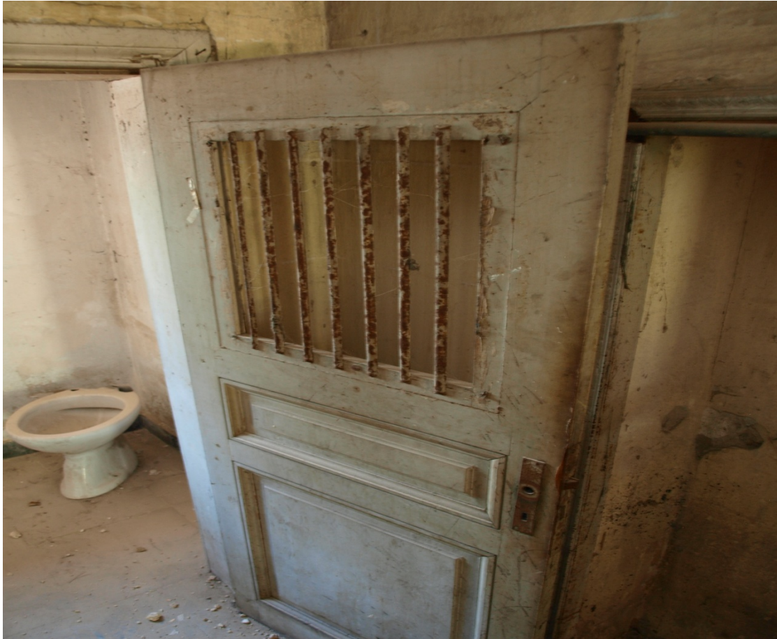
Εικόνα 51. Χαμηλή πόρτα που έφερε υαλοστάσιο παλαιότερα και οδηγεί στο w.c του προσωπικού
