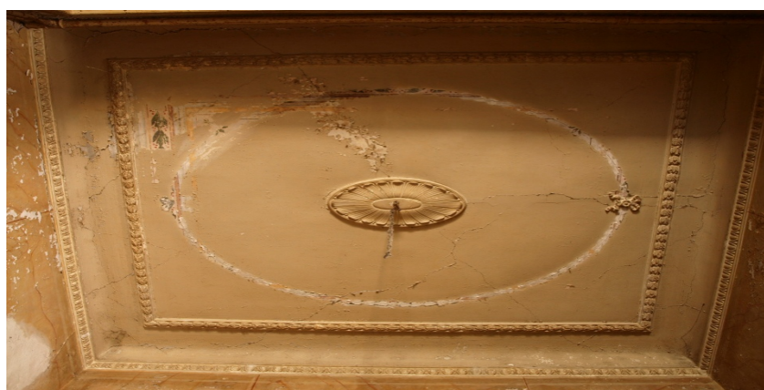
Εικόνα 11.Οροφή εισόδου με περίτεχνα γύψινα
