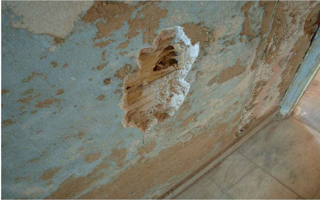
Εικόνα33.Εκτεταμένη αποκόλληση στην τοιχοποιία
