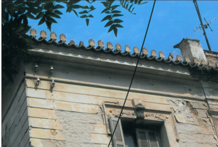
Εικόνα 5. κεραμικά ακροκέραμα
