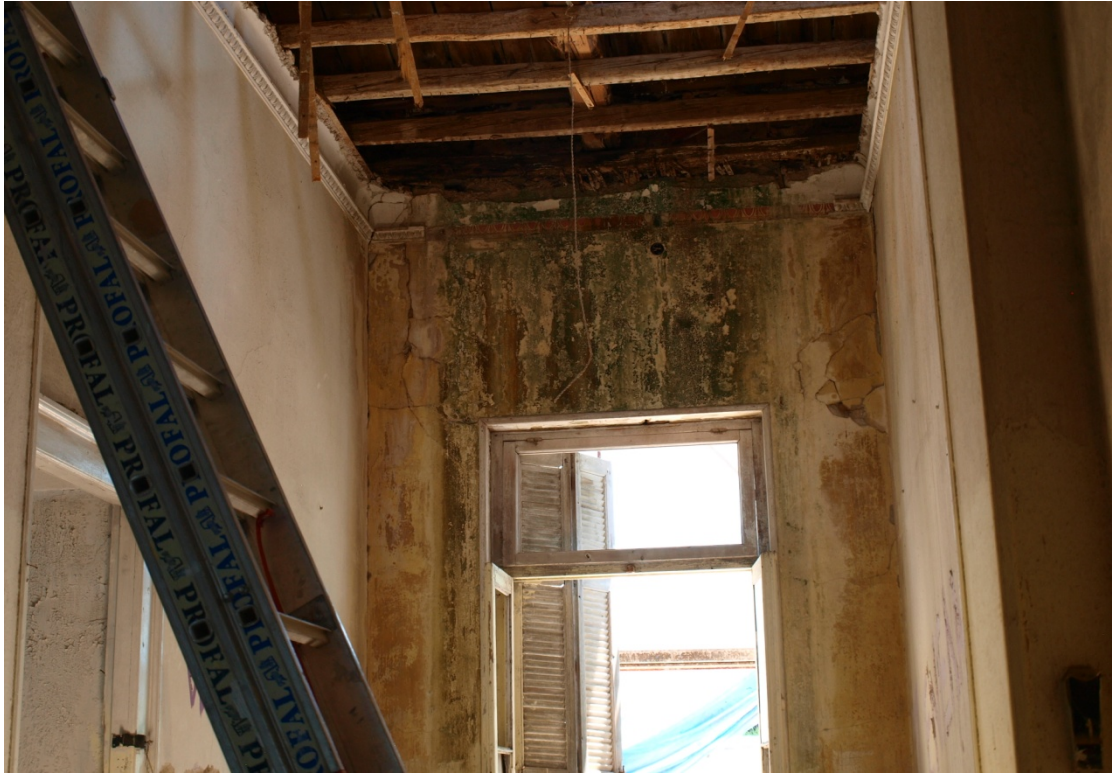
Εικόνα 24.Υγρασία και μικροοργανισμοί εσωτερικά στον επάνω όροφο
