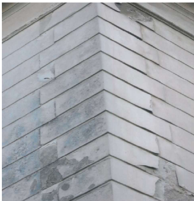
Εικόνα 2. Γωνιακό επίχρισμα, οπτική ενίσχυση γωνιών
