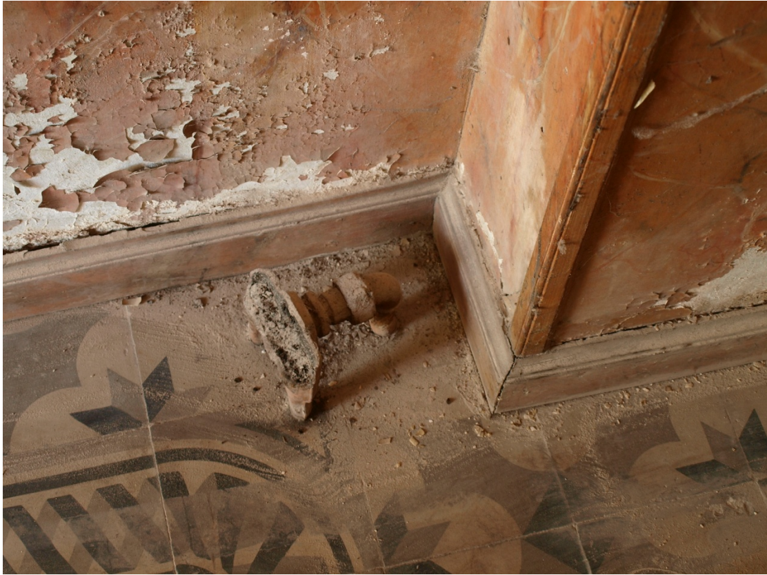
Εικόνα 16.Φθορά ζωγραφικού διάκοσμου, ίχνος θερμαντικού σώματος
