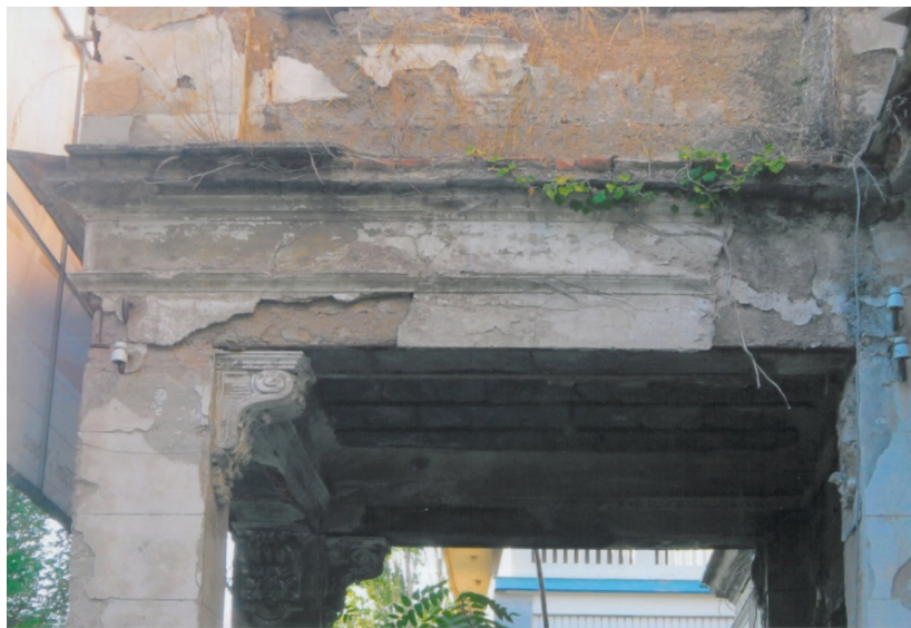
Εικόνα 21. Αποκολλήσεις και εμφάνιση βλάστησης -μικροοργανισμών
