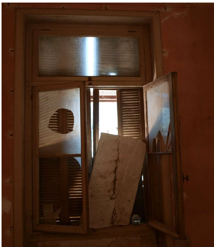
Εικόνα 54.Σπασμένα παράθυρα γαλλικού τύπου και πρόχειρα επενδεδυμένα με ξύλα
