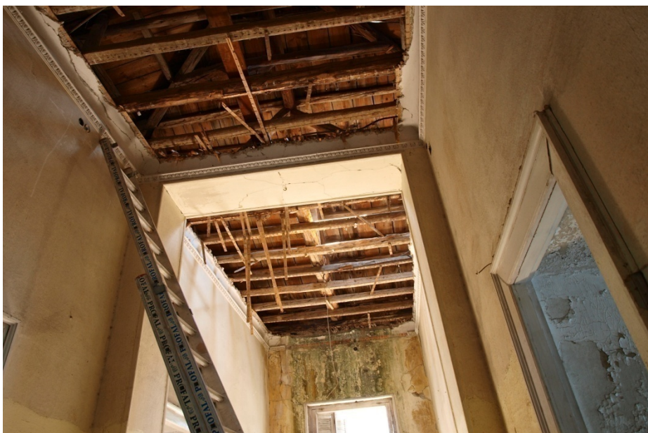
Εικόνα 44.Αποκόλληση της οροφής του διαδρόμου στον όροφο
