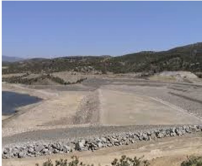
Εικόνα 1.4 Βοηθητικό - κύριο ανάντη πρόφραγμα
