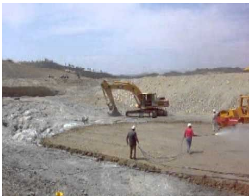
(Εικόνα 1.9) Κατασκευή Αυχενικού φράγματος
