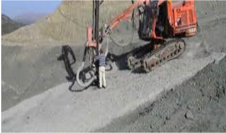
Εικόνα 1.5 :Τσιμεντενέσεις τάπητα (ΑΕΓΕΚ , 2001)
