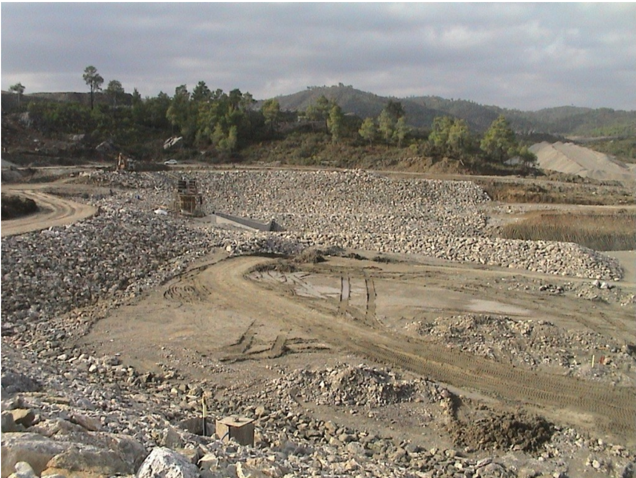
Εικόνα 1.8. Λιθορριπή προστασίας
