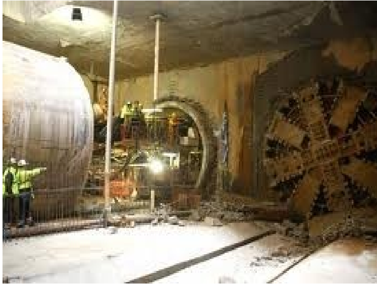
Εικόνα 1.2 : Εκσκαφή σήραγγας εκτροπής
