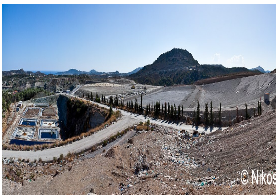
Εικόνα 1.6 Γενική άποψη φράγματος κατά την κατασκευή του
