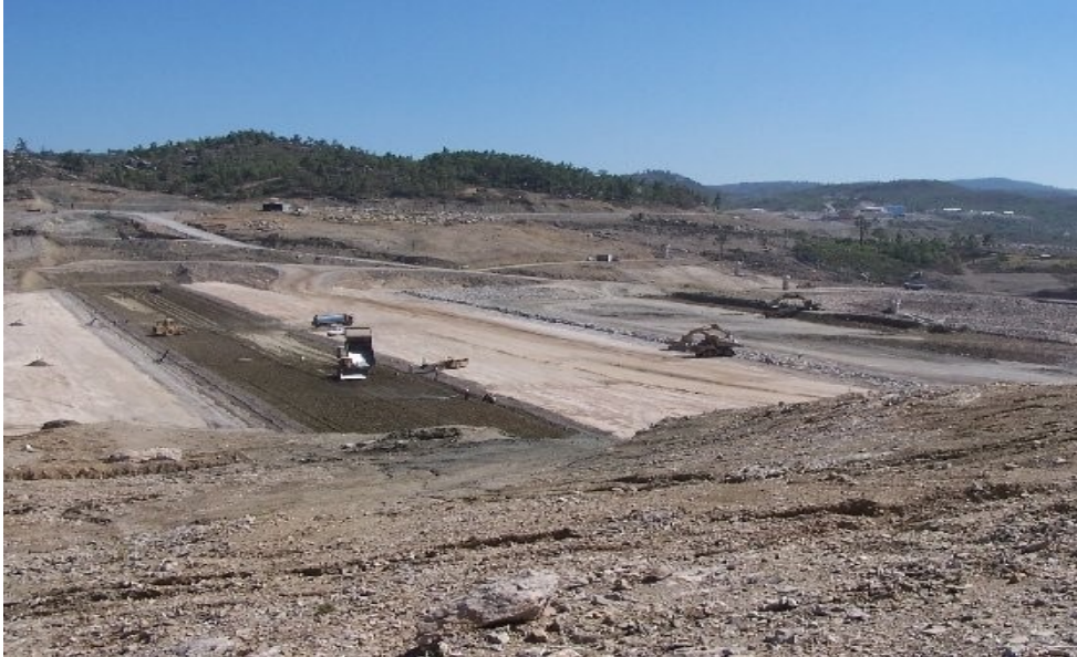
Εικόνα 1:7 Ζώνες φίλτρων – στραγγιστηριών
