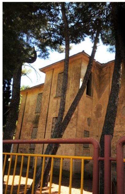
ΕΙΚ. 12 Βόρεια όψη υφιστάμενου κτηρίου.
