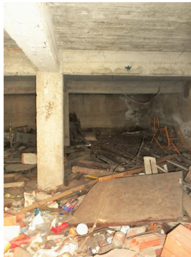
ΕΙΚ. 15 Δοκοί και υποστυλώματα που στηρίζουν την πλάκα του ισογείου.
