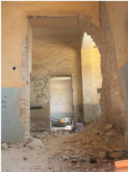
ΕΙΚ. 53 Ανατολικός τοίχος .
