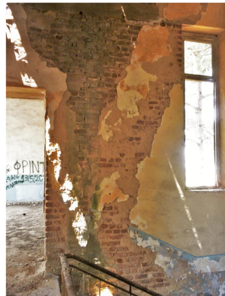
ΕΙΚ. 71 Δυτικός τοίχος στο επίπεδο του ορόφου (β).
