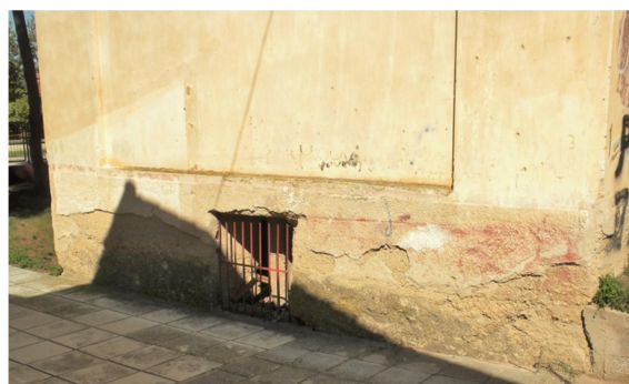
ΕΙΚ. 28 Σιδεριά ανοίγματος στη δυτική πλευρά του ημιυπογείου.
