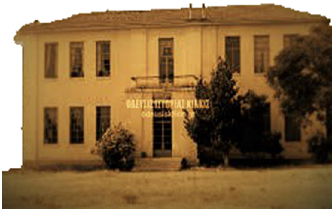
ΕΙΚ. 1 Όψη του κτηρίου το 1964 μετά την ανακαίνιση.
