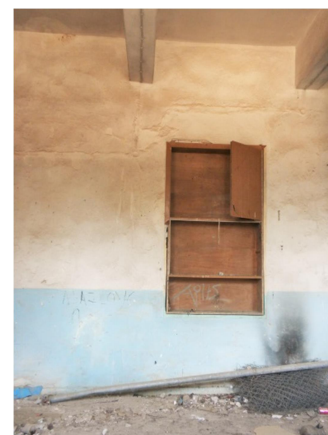
ΕΙΚ. 59 Βόρειος τοίχος .
