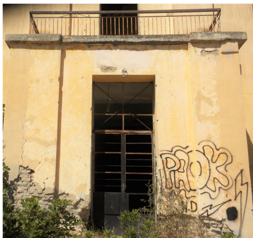
ΕΙΚ.29 Εξωτερικό επίχρισμα τοιχοποιίας.
