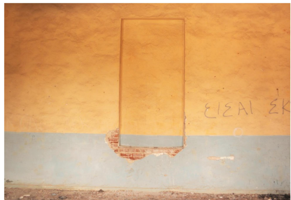
ΕΙΚ. 85 Βόρειος τοίχος . Πλήρωση του αρχικού κουφώματος.
