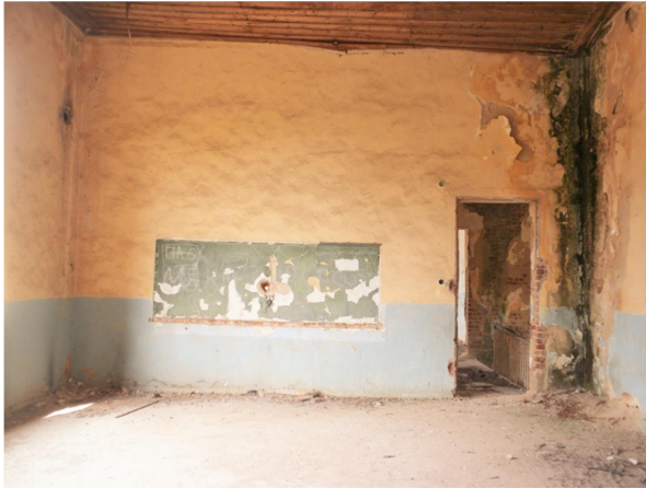
ΕΙΚ. 81 Δυτικός τοίχος.
