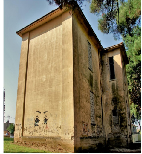
ΕΙΚ. 48 Ανατολικός τοίχος.
