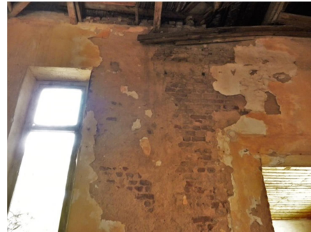
ΕΙΚ. 69 Ανατολικός τοίχος κλιμακοστασίου.
