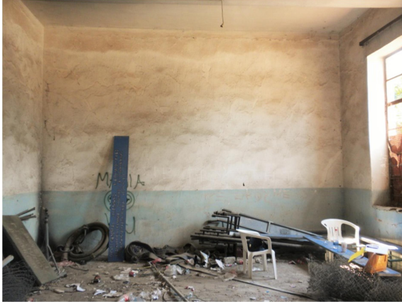
ΕΙΚ. 55 Ανατολικός τοίχος.
