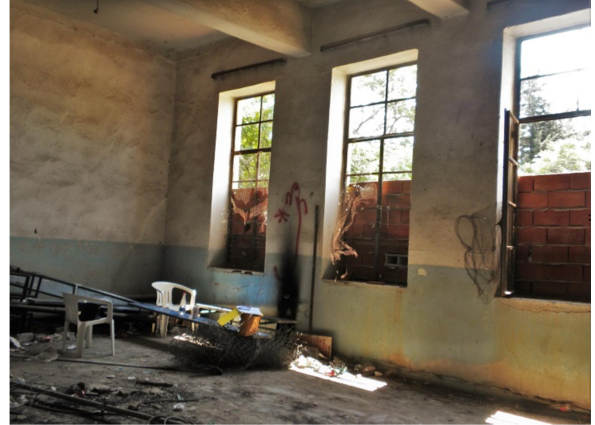
ΕΙΚ. 56 Νότιος τοίχος.
