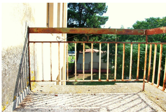
ΕΙΚ. 41 Εξωτερικό κιγκλίδωμα στον εξώστη του ορόφου.
