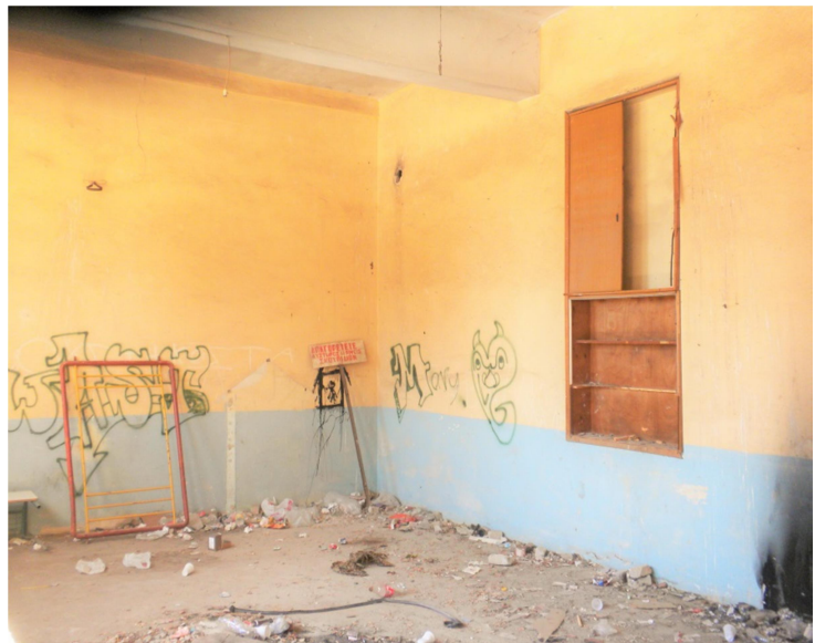
ΕΙΚ. 54 Δυτικός και Βόρειος τοίχος.
