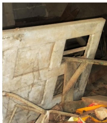
ΕΙΚ. 27 Θυρόφυλλο από το κούφωμα Κ6 (ισόγειο –όροφος).
