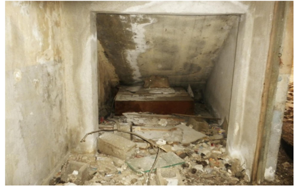
ΕΙΚ. 61 Δοκάρι με υποστυλώματα που στηρίζει την κλίμακα.
