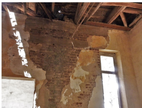
ΕΙΚ. 18 Δύο σενάζ το ένα στο ύψος του παραθύρου και το άλλο στην απόληξη της φέρουσας τοιχοδομής (χώρος κλιμακοστασίου).
