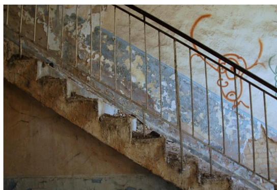
ΕΙΚ. 42 Εσωτερικό κιγκλίδωμα στην κλίμακα ανόδου.
