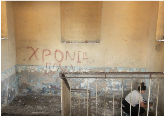
ΕΙΚ. 68 Βόρειος τοίχος κλιμακοστασίου στο επίπεδο του πλατύσκαλου.
