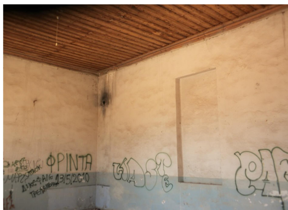
ΕΙΚ. 16 Ξύλινη ψευδοροφή από σανίδες ραμποτέ (όροφος).
