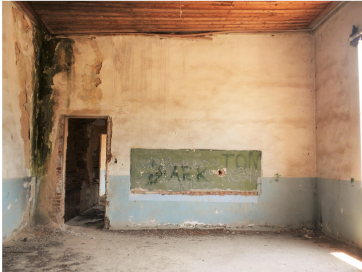
ΕΙΚ. 77 Ανατολικός τοίχος.
