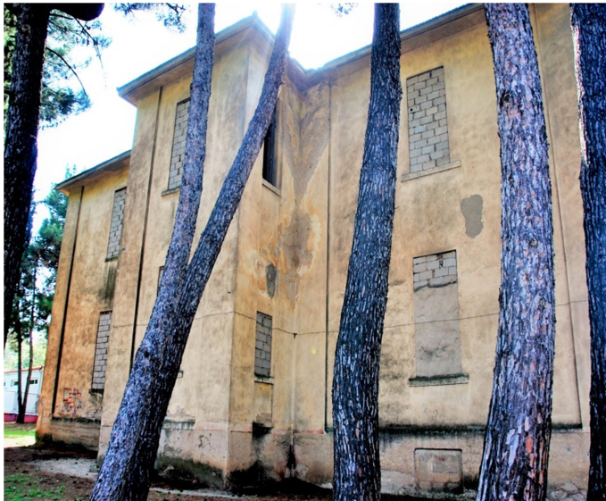
ΕΙΚ. 49 Βόρειος τοίχος .
