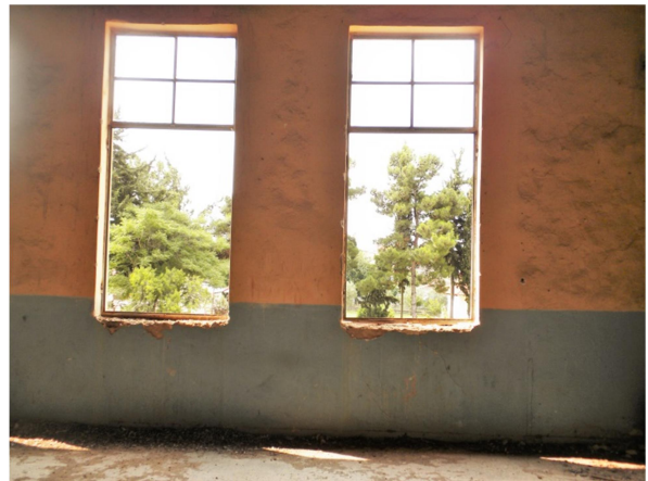
ΕΙΚ. 84 Δύο από τα κουφώματα του νότιου τοίχου.
