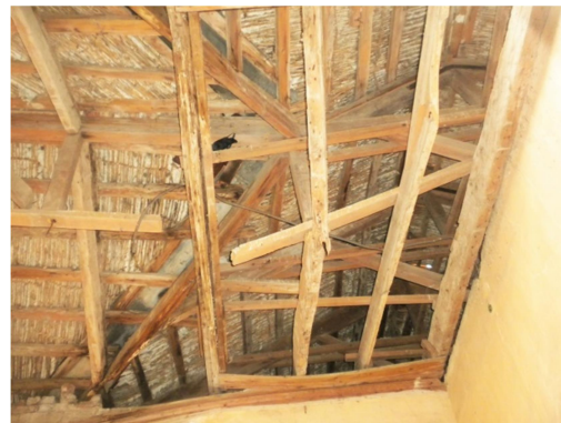
ΕΙΚ. 37 Τμήμα ζευκτού της στέγης (Β κομμάτι -πάνω από τον χώρο του κλιμακοστασίου).
