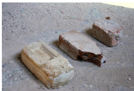
ΕΙΚ. 13 Συμπαγής οπτόπλινθος με εσοχή (αριστερό τούβλο)
