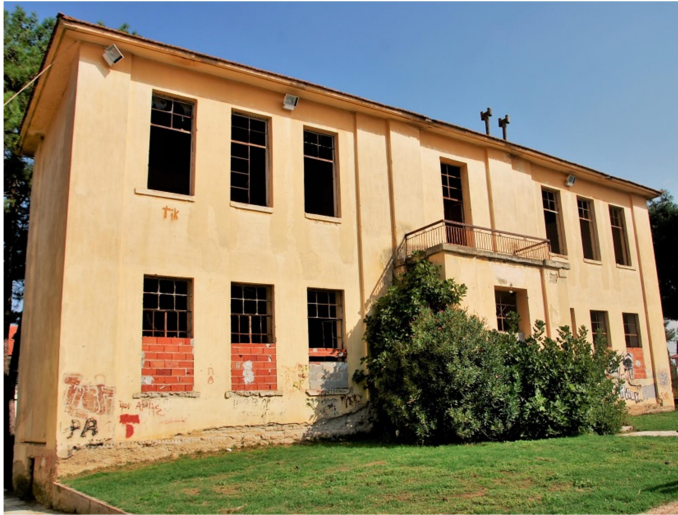
ΕΙΚ. 47 Νότιος τοίχος
