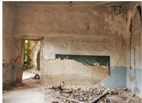
ΕΙΚ. 58 Δυτικός τοίχος.
