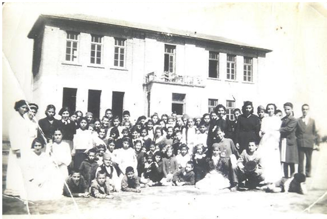
ΕΙΚ. 4 Εικόνα του σχολείου πριν από την ανακαίνιση.
