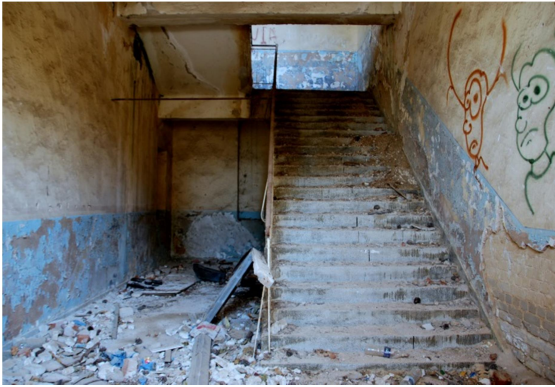
ΕΙΚ. 60 Κλιμακοστάσιο κτηρίου.
