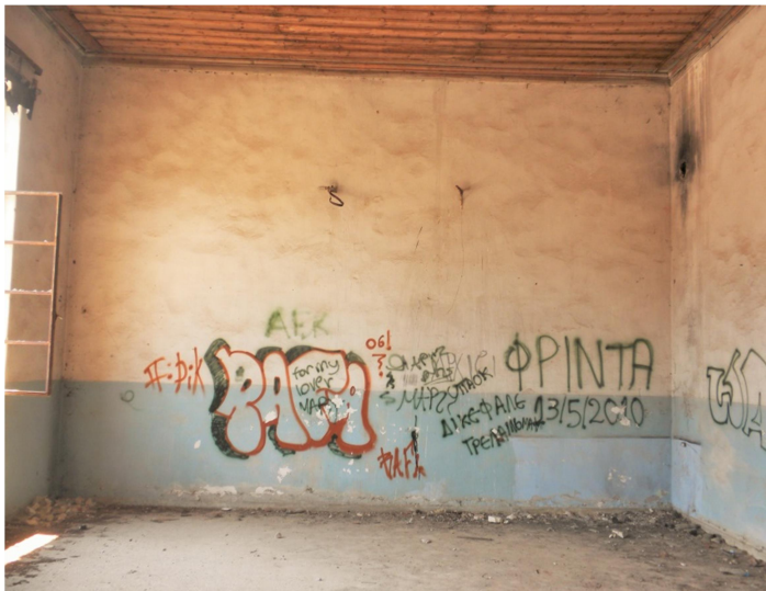
ΕΙΚ. 79 Δυτικός τοίχος.
