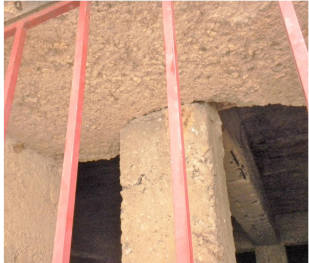
ΕΙΚ. 87 Υποστύλωμα μέσα στο πάχος της τοιχοδομής .
