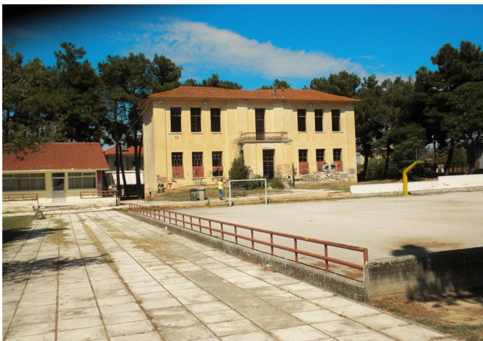
ΕΙΚ. 11 Νότια όψη υφιστάμενου κτηρίου.
