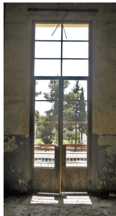
ΕΙΚ. 25 Κουφώμα K5 (όροφος).
