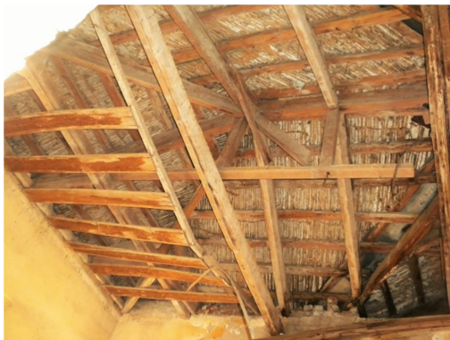
ΕΙΚ. 36 Τμήμα ζευκτού της στέγης (Α κομμάτι -πάνω από τον χώρο του κλιμακοστασίου).
