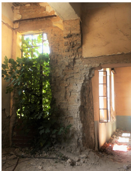
ΕΙΚ. 17 Τοπικό πρέκι οπλισμένου σκυροδέματος πάνω από εσωτερική θύρα στο ισογείου .
