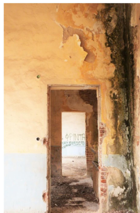
ΕΙΚ. 38 Τοιχοδομή στον ορόφο που παρουσιάζει έντονα προβλήματα υγρασίας.
