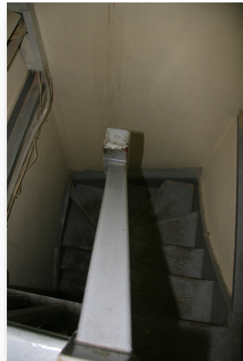
Φωτογραφία 10: Κλιμακοστάσιο για υπόγειο
