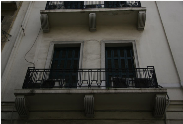
Εικόνα 81: Μεταλλικά κιγκλιδώματα εξωστών
