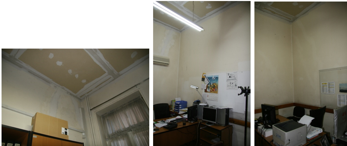
Εικόνα 59,60,61: Φθορές επιχρίσματος
