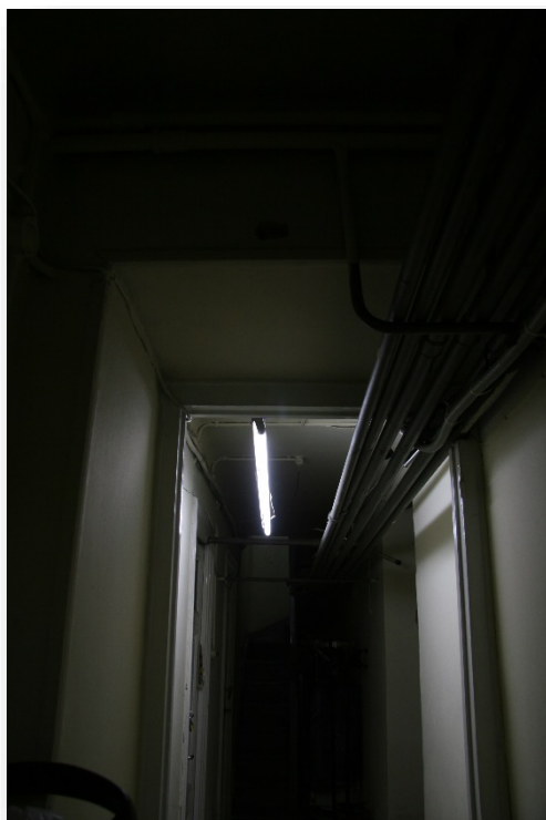
Φωτογραφία 8: Διάδρομος υπογείου
