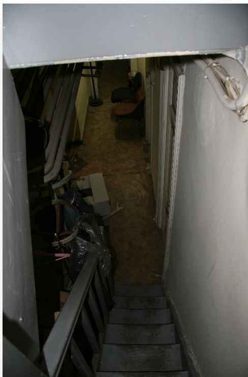
Φωτογραφία 9: Αποψη εισόδου του υπογείου
