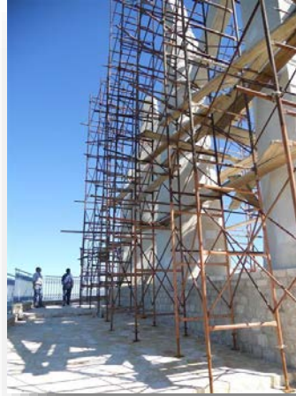
Εικόνα 71: Εγκατάσταση ικριωμάτων
