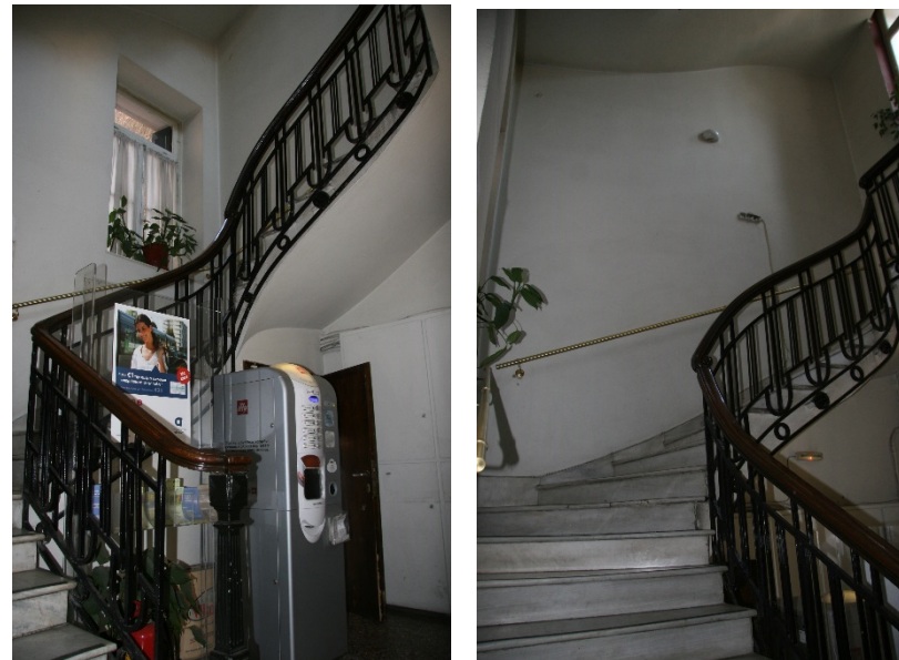
Εικόνα 57,58: Το κλιμακοστάσιο στο ισόγειο
