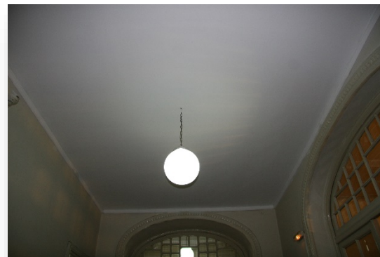
Φωτογραφία 18: Οροφή ισογείου
