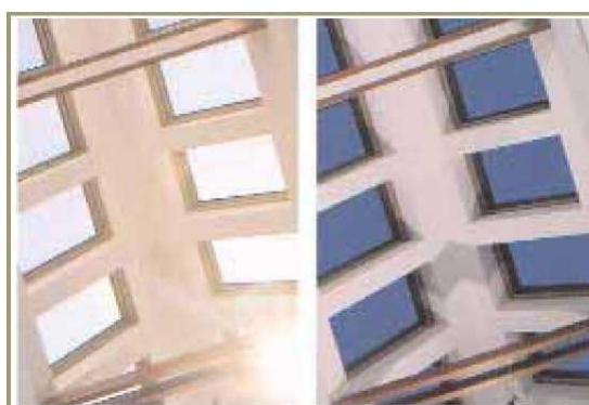
Εικόνα 7.Οι ηλεκτροχρωμικοί υαλοπίνακες μπορούν να αποκτήσουν λιγότερη διαφάνεια με την εφαρμογή μικρής τάσης σε στρώση οξειδίων του βολφραμίου.[5]
