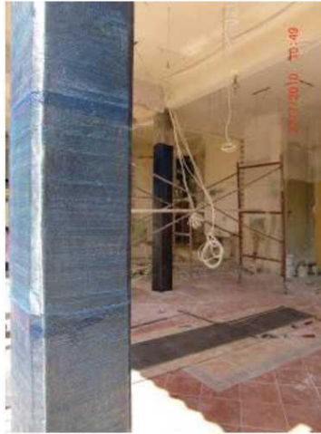
Εικόνα 16. Εφαρμογή ανθρακοϋφάσματος.[8]
