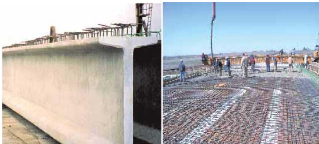
Εικόνα 3.Εφαρμογές του χάλυβα MMFX2 σε προκατασκευασμένη δοκό και σε κατάστρωμα γέφυρας στις Η.Π.Α.[5]
