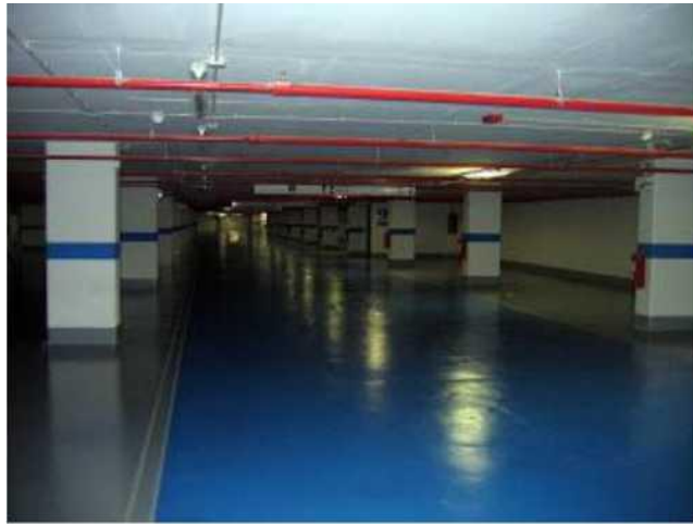
Εικόνα 14. Εφαρμογή ινοπλισμένου σκυροδέματος.[8]
