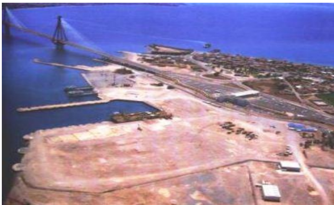
Εικόνα 1 Πρώην εργοταξιακός χώρος της Γέφυρας Ρίου - Αντιρρίου σήμερα 1
