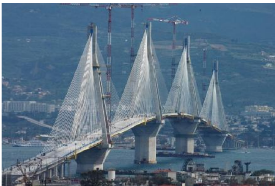
Εικόνα3 Πυλώνες της Γέφυρας III
