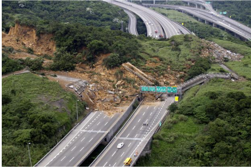
Εικόνα 14 Ολίσθηση εδάφους σε αυτοκινητόδρομο, Ταϊβάν. Πηγή: media3.washingtonpost.com
