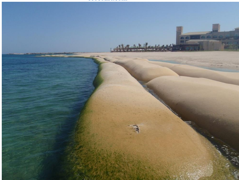
Εικόνα 59 Αποψη τοποθέτησης γεωσωλήνων στο νησί Σιρ Μπάνι Γιάς, Η.Α.Ε. Πηγή: ecocoast.com
