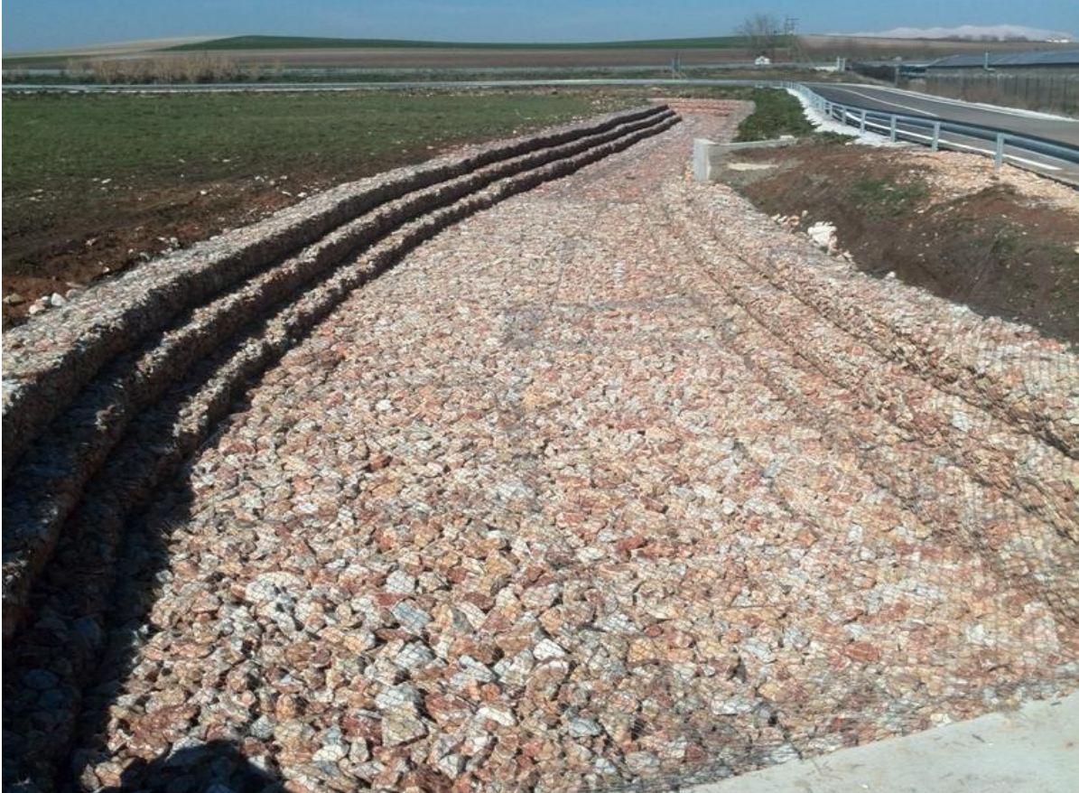
Εικόνα 30 Κατασκευή αποστραγγιστικής τάφρου όμβριων υδάτων επαρχιακή οδός Λάρισας-Καρδίτσας. Πηγή: e-thessalia.gr
