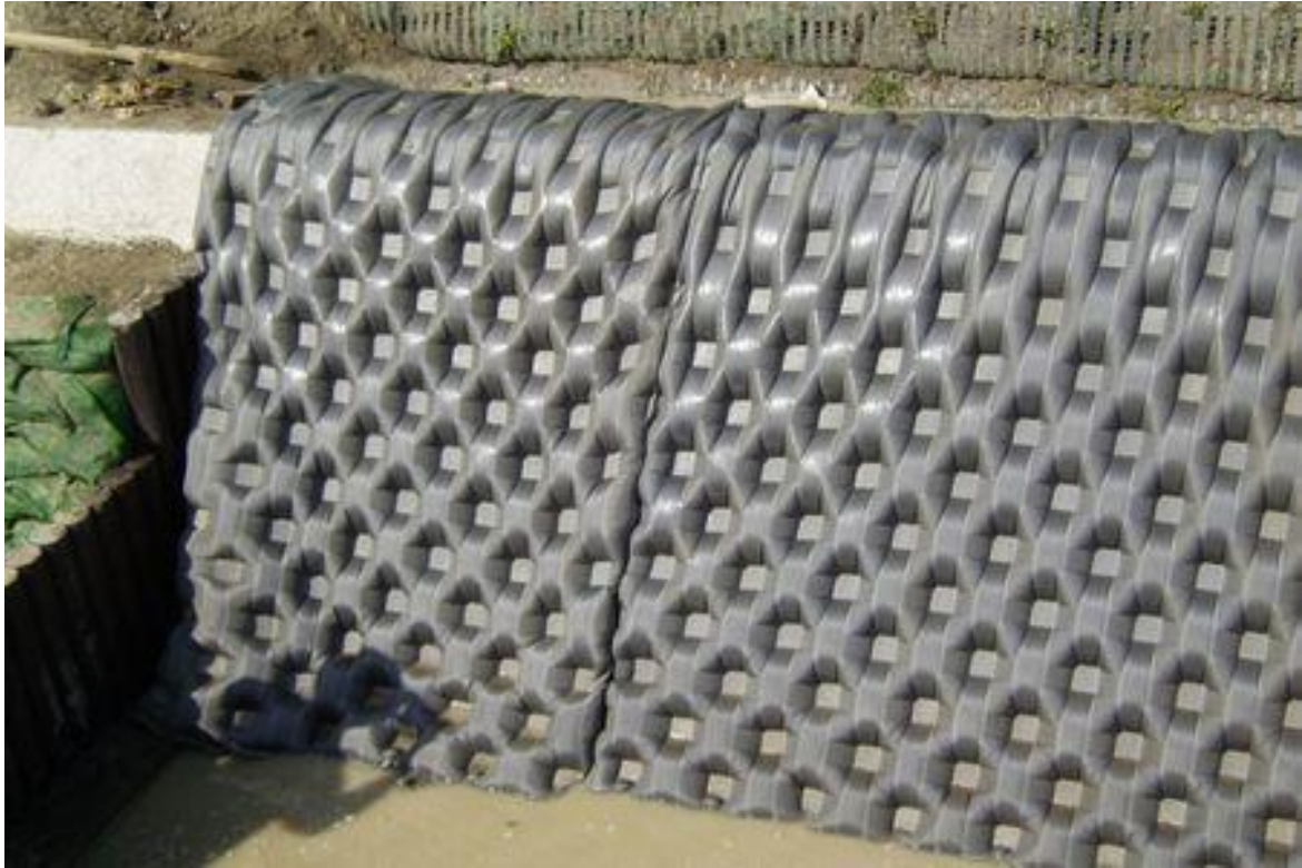
Εικόνα 47 Ζεύγος γεωυφάσματος για την προστασία καναλιού. Πηγή: acegeosyntheticsecopark.com
