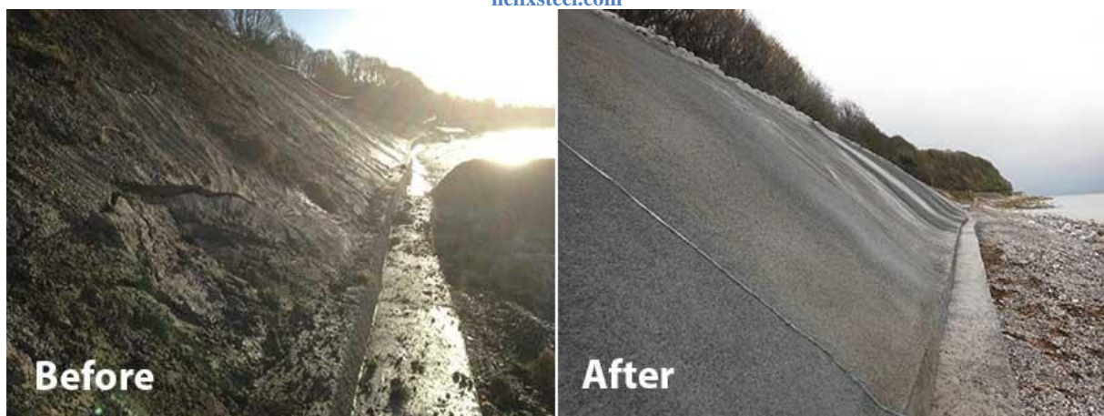
Εικόνα 35 Χρήση εκτοξευμένου σκυροδέματος σε ανάχωμα οδού Κάρνλοου, Αγγλία. Πηγή: fpmccann.co.uk
