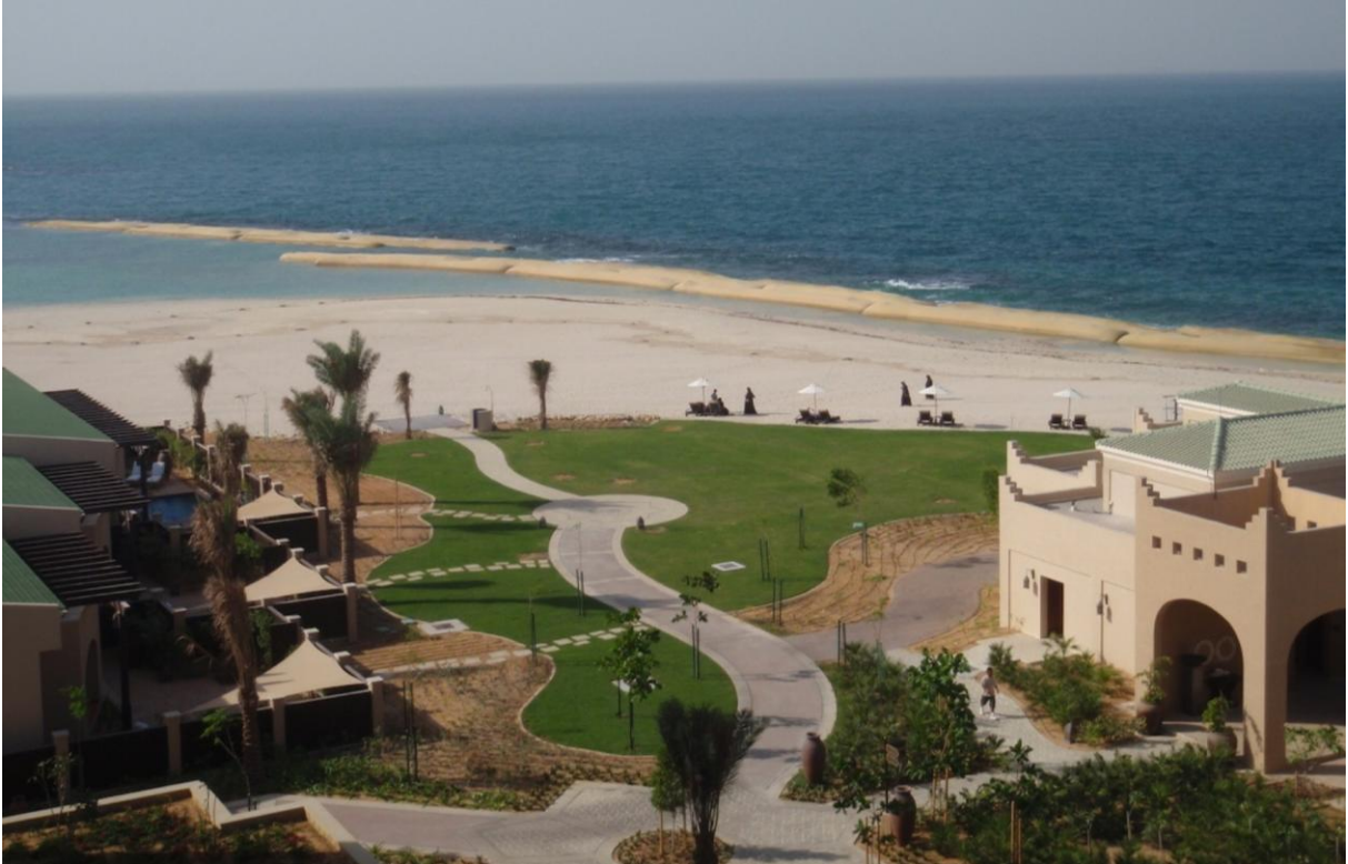
Εικόνα 58 Χρήση γεωσωλήνων για την προστασία της παραλίας στο νησί Σιρ Μπάνι Γιάς, Η.Α.Ε. Πηγή: ecocoast.com
