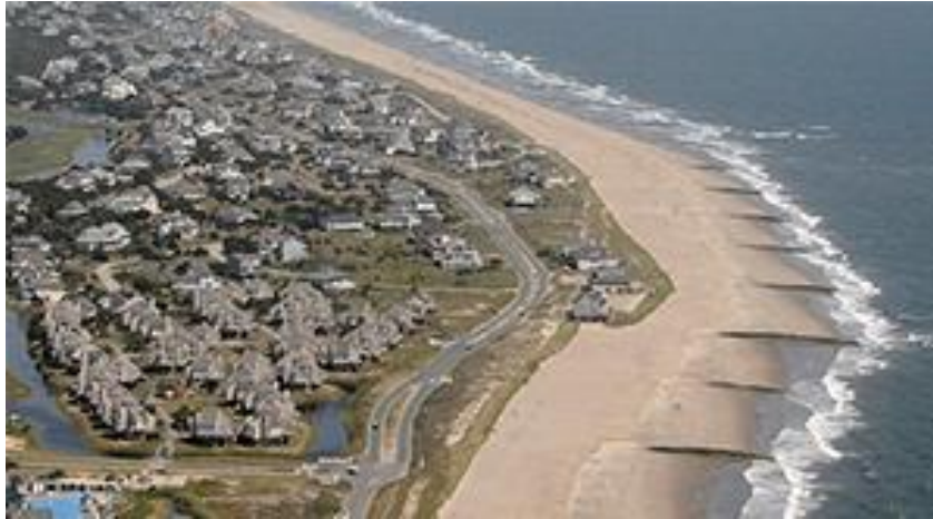
Εικόνα 54 Πανοραμική άποψη αντιδιαβρωτικών προβόλων στο νησί Μάλντ Χέντ, Βόρεια Καρολίνα. Πηγή: coastalnewstoday.com
