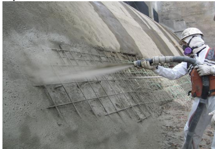
Εικόνα 32 Χρήση εκτοξευμένου σκυροδέματος. Πηγή: knowlesindustrial.com
