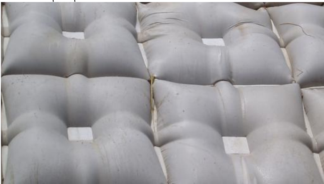
Εικόνα 46 Ζεύγος γεωφάσματος πληρωμένο με σκυρόδεμα. Πηγή: tencate.com
