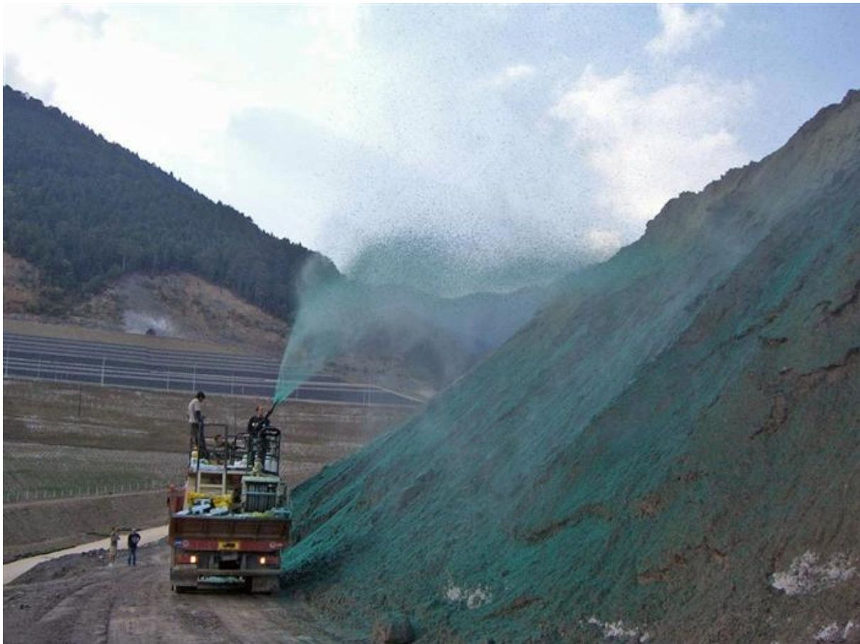
Εικόνα 38 Εφαρμογή υδροσποράς με ειδικό μηχάνημα σε πρανή της Εγνατίας Οδού. Πηγή: agrohoum.gr
