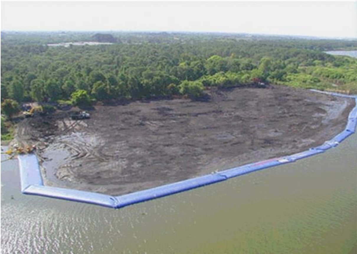
Εικόνα 49 Εκτροπή νερόν ποταμού για την βελτίωση συνθηκών εργασίας. Πηγή: hydroresponse.com
