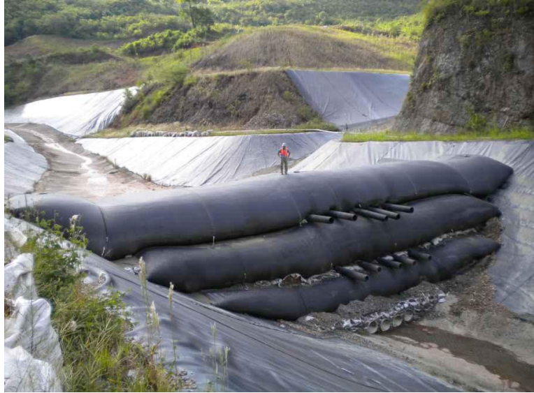
Εικόνα 50 Δημιουργία φράγματος συγκράτησης, ορυχείο Ελ Μοχίτο, Ονδούρα. Πηγή: tierragroupinternational.com
