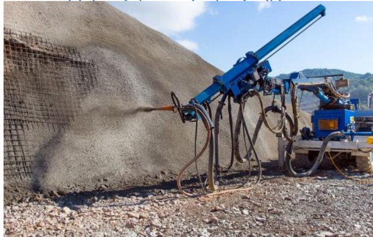
Εικόνα 33 Χρήση αυτόματου μηχανήματος εκτοξευμένου σκυροδέματος. Πηγή: americanshotcreteconstruction.com
