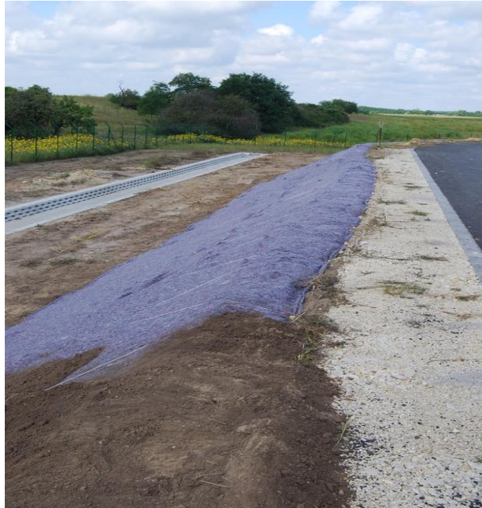
Εικόνα 41 Εφαρμογή βιοδιασπώμενου γεωτάπητα. Πηγή: geomuanyag.hu
