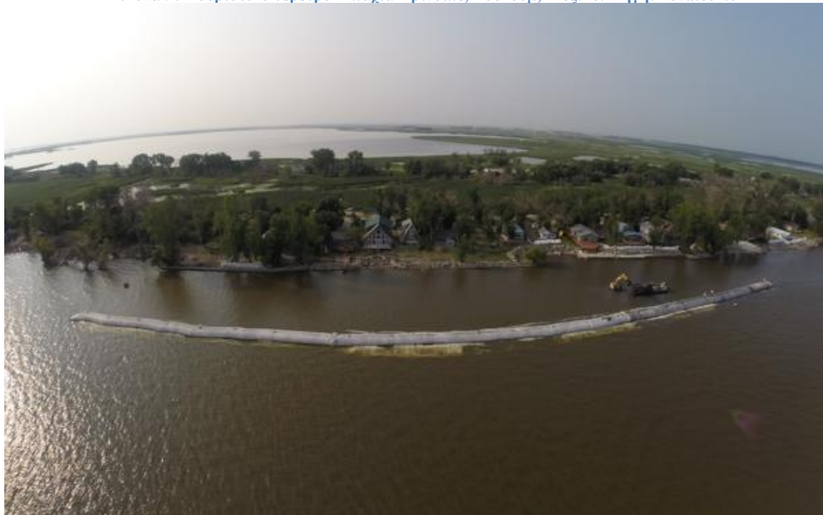
Εικόνα 57 Κατασκευή κυματοθραύστη από γεωσωλήνες, Καναδάς. Πηγή: flintusa.net
