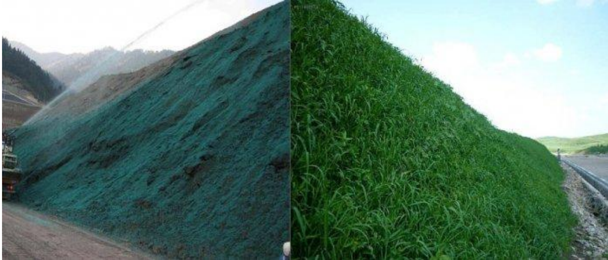
Εικόνα 37 Πρανές πριν και μετά την υδροσπορά στην Εγνατία Οδό. Πηγή: temmuzpeyzaj.com
