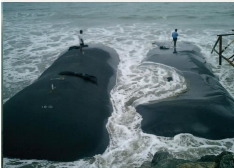
Εικόνα 52 Κατασκευή προβλήτας στο τουριστικό θέρετρο Στέλλα Μαρίς, Εκουαδόρ. Πηγή: tencate.com
