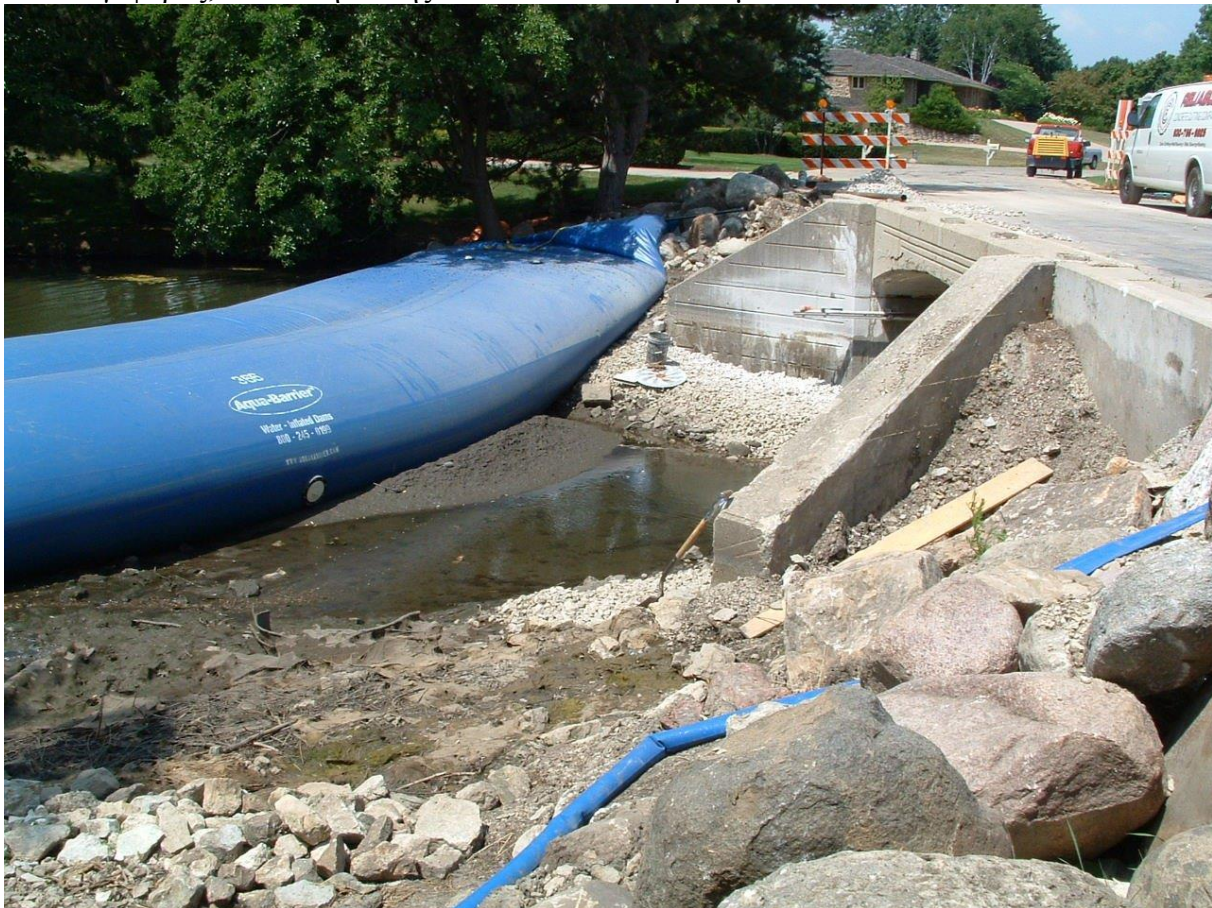
Εικόνα 48 Εκτροπή νερού για την κατασκευή αγωγού, Η.Π.Α. Πηγή: hydrologicalsolutions.com
