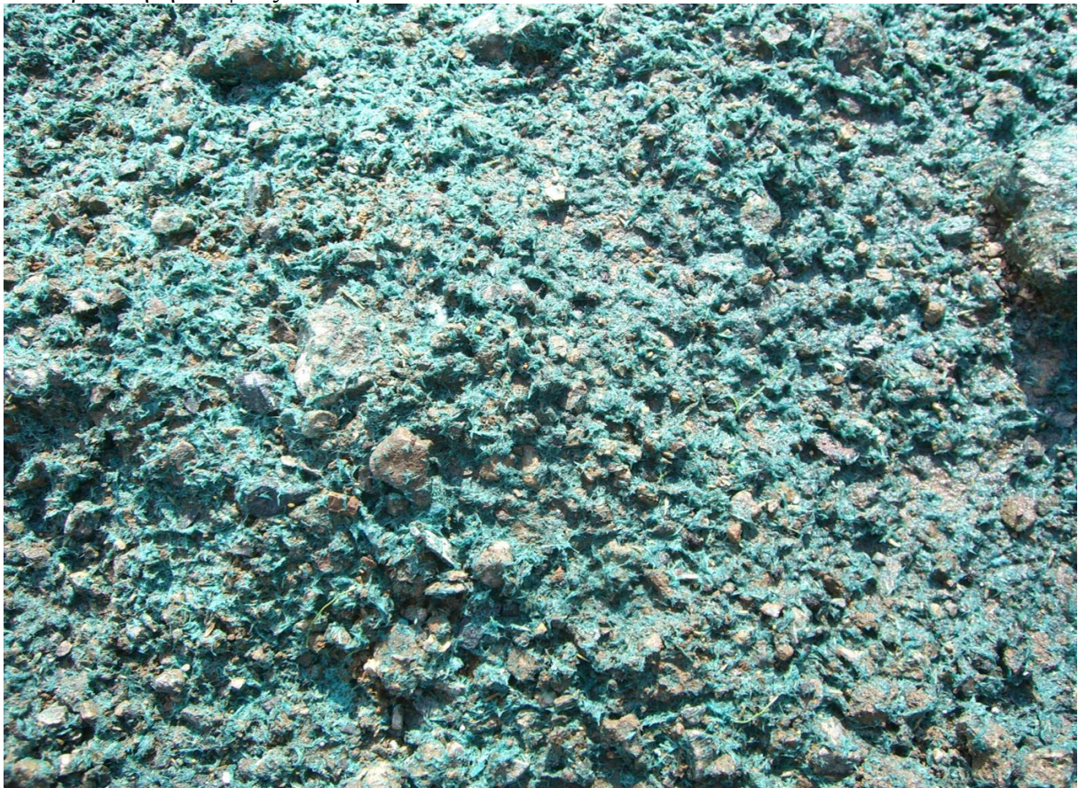
Εικόνα 36 Το μίγμα της υδροσποράς αμέσως μετά την εφαρμογή τους σε πρανή της Εγνατίας Οδού. Πηγή: agrohoum.gr
