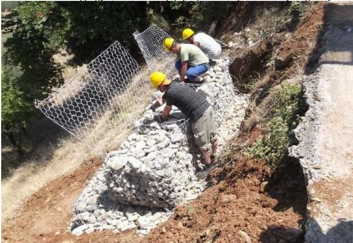
Εικόνα 29 Αποκατάσταση ζημιών πρανούς σε επαρχιακή οδό Ραψάνη, Λάρισα. Πηγή: paidis.com
