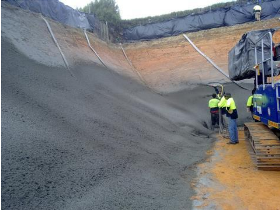
Εικόνα 34 Σταθεροποίηση πρανούς με τη βοήθεια εκτοξευμένου σκυροδέματος, Βικτόρια, Αυστραλία. Πηγή: helixsteel.com
