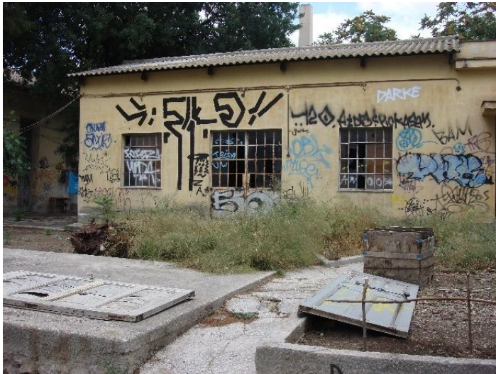
Εικόνα 37: Νοτιοδυτική όψη κτιρίου 4α
