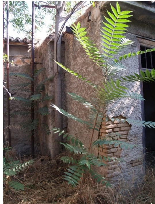
Εικόνα 46: Δυτική όψη κτιρίου 7
