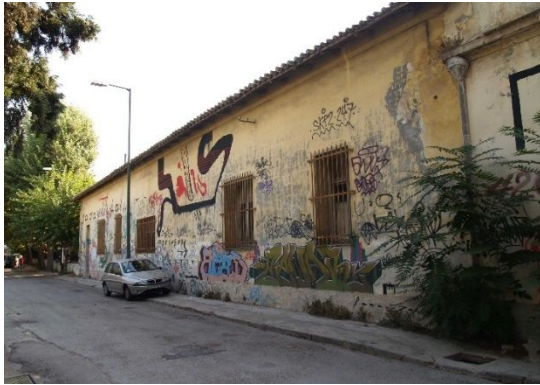
Εικόνα 35: Βορειοδυτική όψη κτιρίου 3
