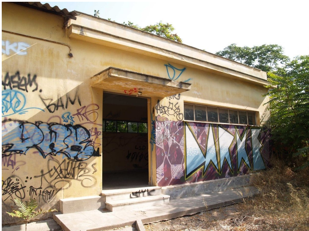
Εικόνα 19: Νοτιοδυτική όψη κτιρίου 4β
