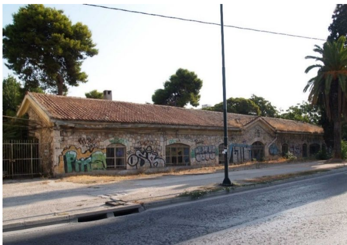
Εικόνα 47: Νοτιοδυτική όψη κτιρίου 1
