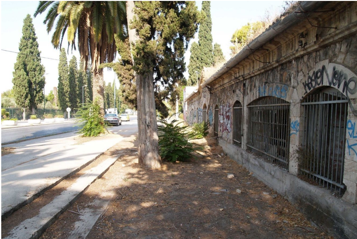
Εικόνα 8: Νοτιοδυτική όψη κτιρίου 1
