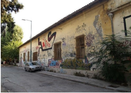
Εικόνα 52: Βορειοδυτική όψη κτιρίου 3
