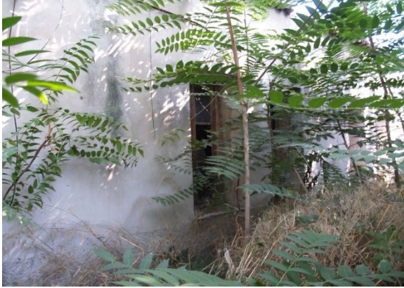
Εικόνα 43: Νότια όψη κτιρίου 7
