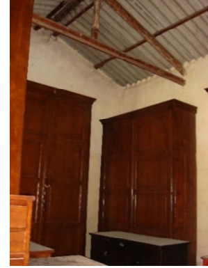
Εικόνα 60: Εσωτερικό κτιρίου 4α
