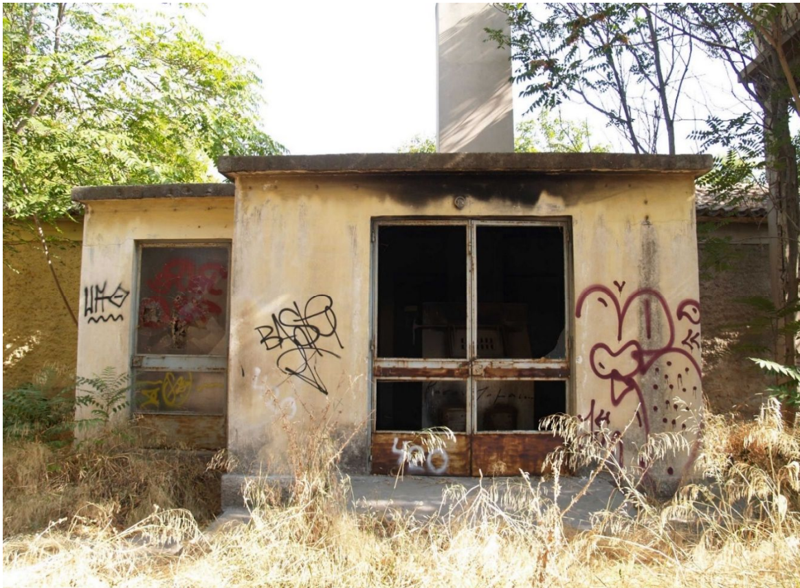
Εικόνα 24: Νοτιοδυτική όψη κτιρίου 6
