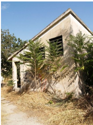
Εικόνα 61: Νότια όψη κτιρίου 5
