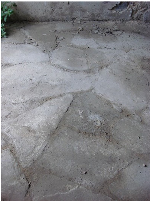
Εικόνα 31: Δάπεδο από πέτρινες πλάκες
