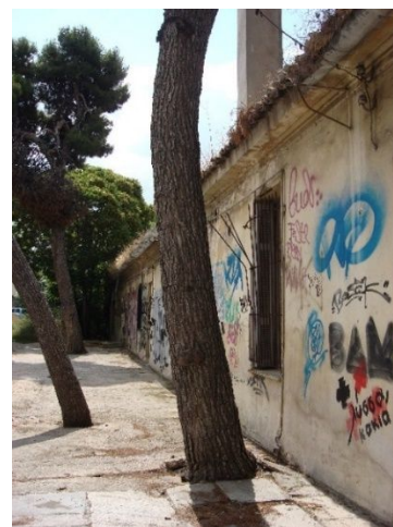
Εικόνα 48: Βορειοανατολική όψη κτιρίου 1
