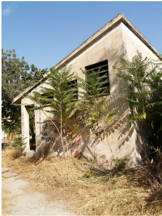
Εικόνα 21: Νότια όψη κτιρίου 5
