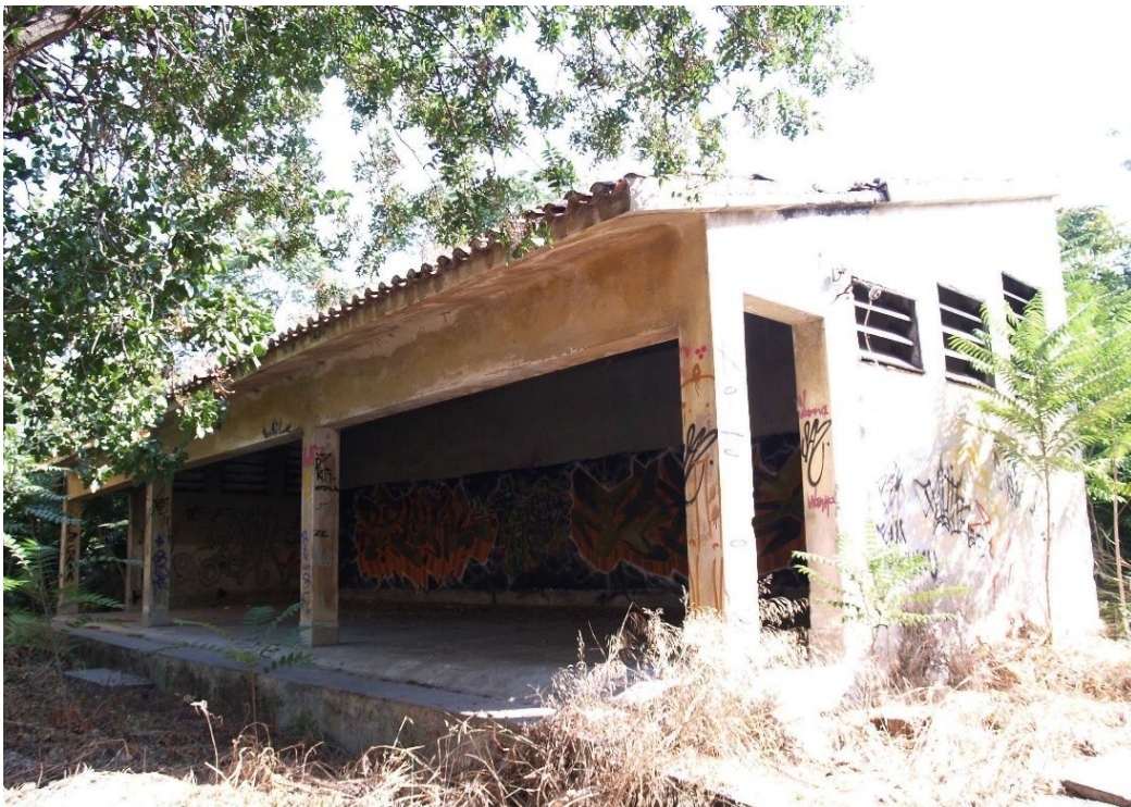
Εικόνα 20:Δυτική όψη κτιρίου 5
