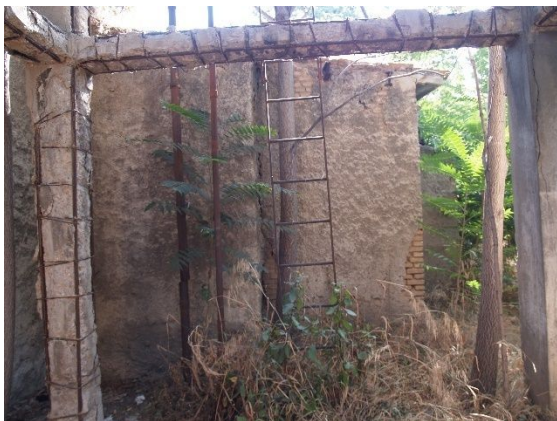
Εικόνα 65: Δυτική όψη κτιρίου 7
