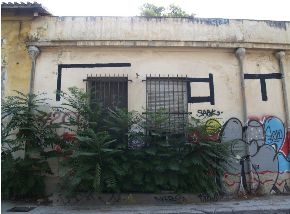
Εικόνα 13: Βορειοδυτική όψη κτιρίου 2
