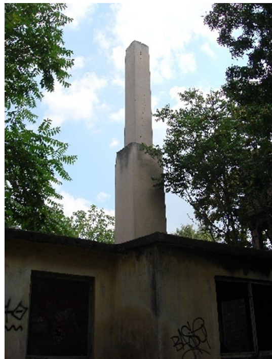
Εικόνα 42: Νότια όψη κτιρίου 6
