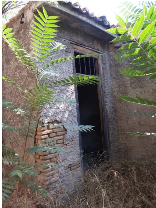
Εικόνα 16: Νότια όψη κτιρίου 7
