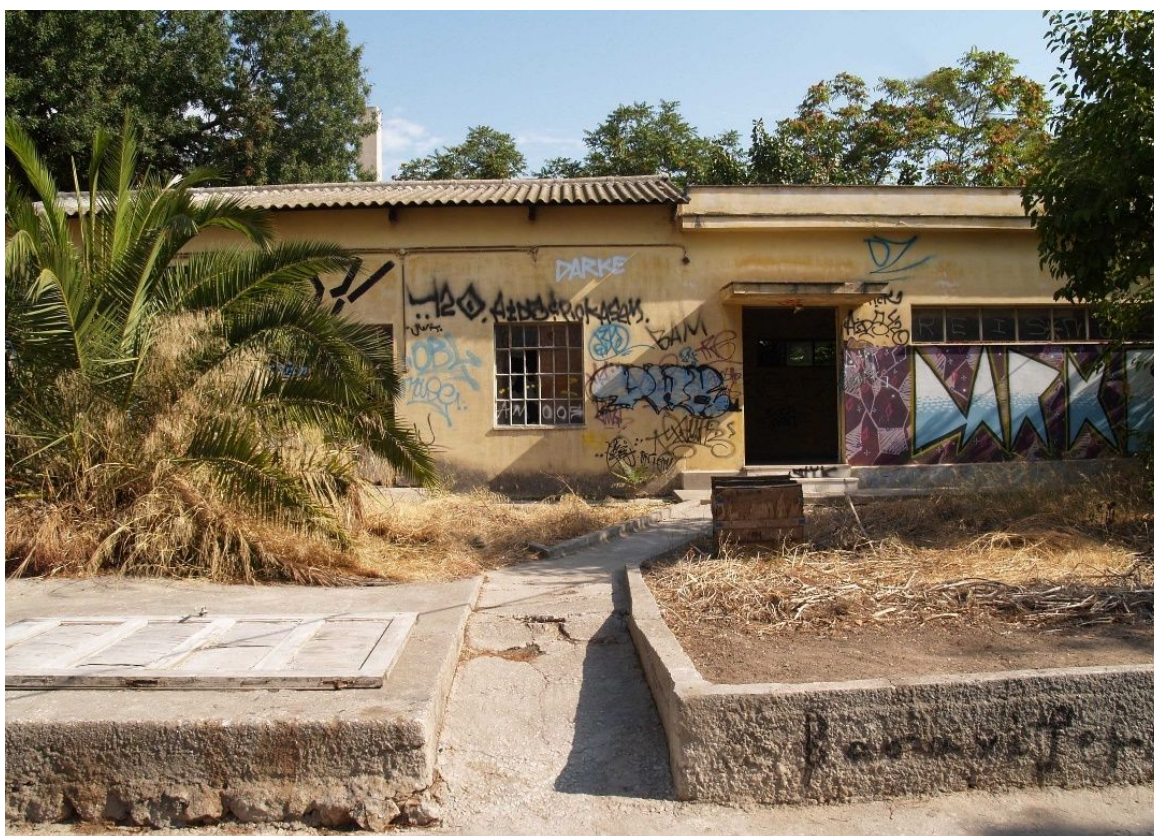
Εικόνα 17: Νοτιοδυτική όψη κτιρίου 4
