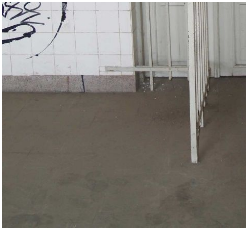
Εικόνα 29: Δάπεδο από τσιμεντοκονία
