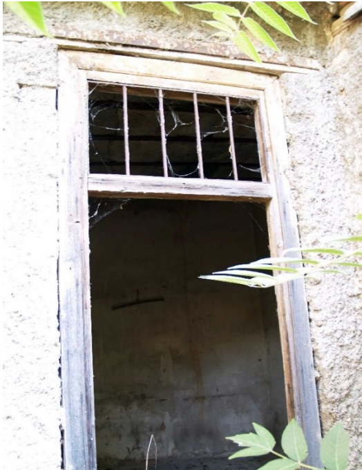
Εικόνα 25: Νότια όψη κτιρίου 7
