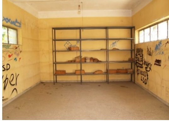
Εικόνα 59: Εσωτερικό κτιρίου 4β
