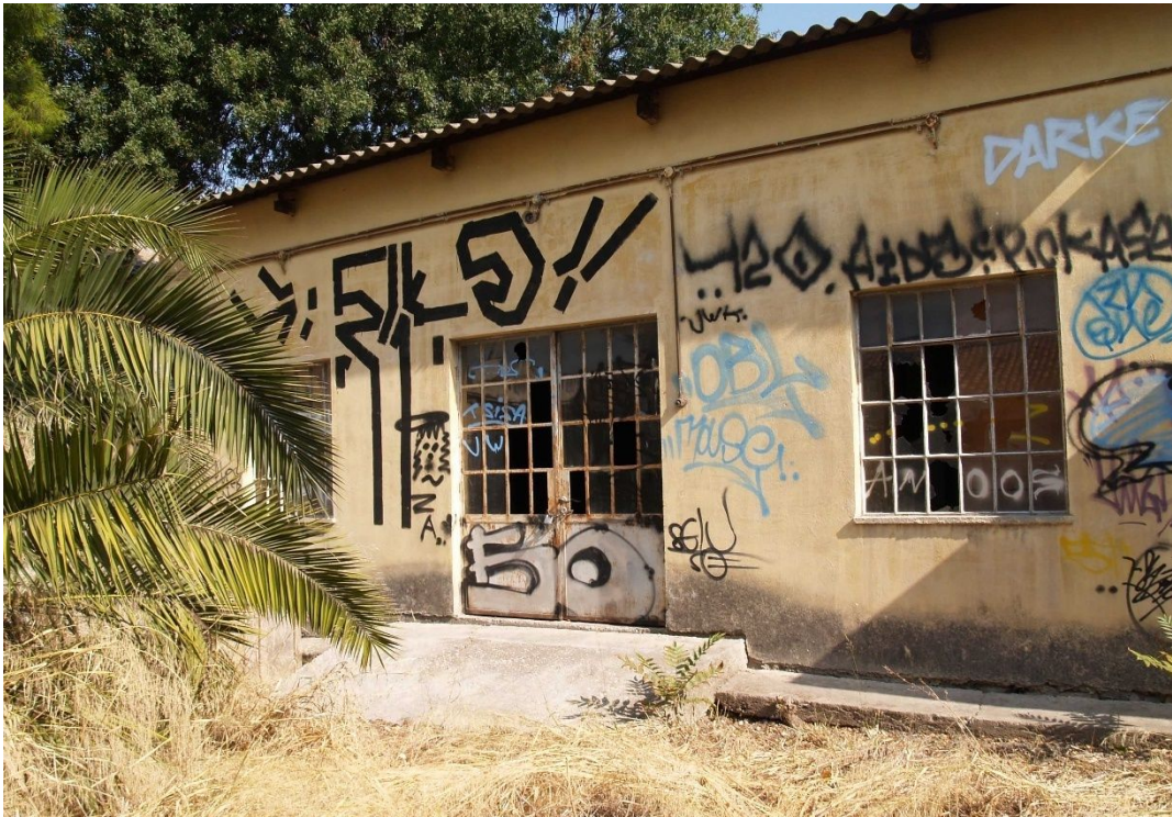
Εικόνα 18: Νοτιοδυτική όψη κτιρίου 4α
