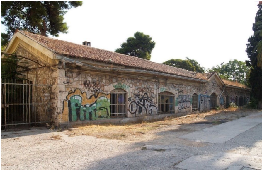
Εικόνα 9: Νοτιοδυτική όψη κτιρίου 1
