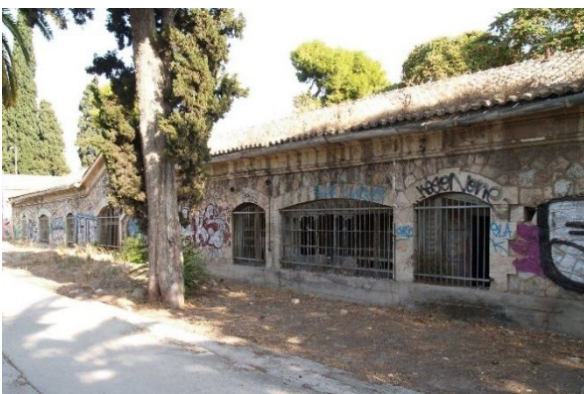
Εικόνα 27: Νοτιοδυτική όψη κτιρίου 1
