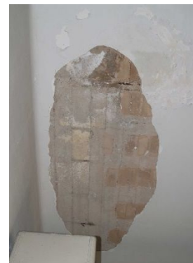
Εικόνα 51: Δοκιδωτές πλάκες
