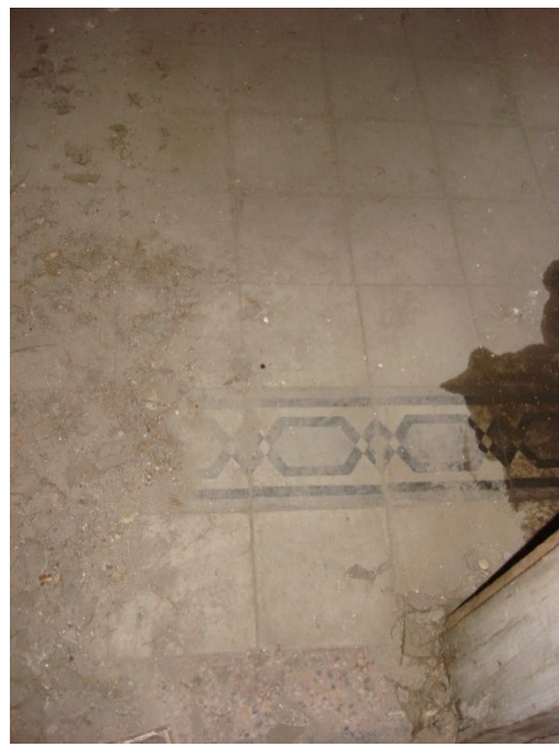
Εικόνα 32: Δάπεδο από τσιμεντοπλακίδια
