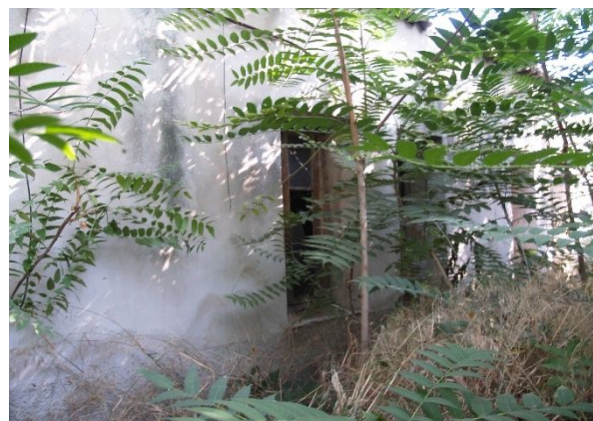
Εικόνα 66: Νοτια όψη κτιρίου 7
