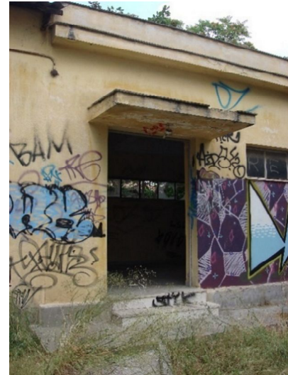
Εικόνα 38: Είσοδος κτιρίου 4β
