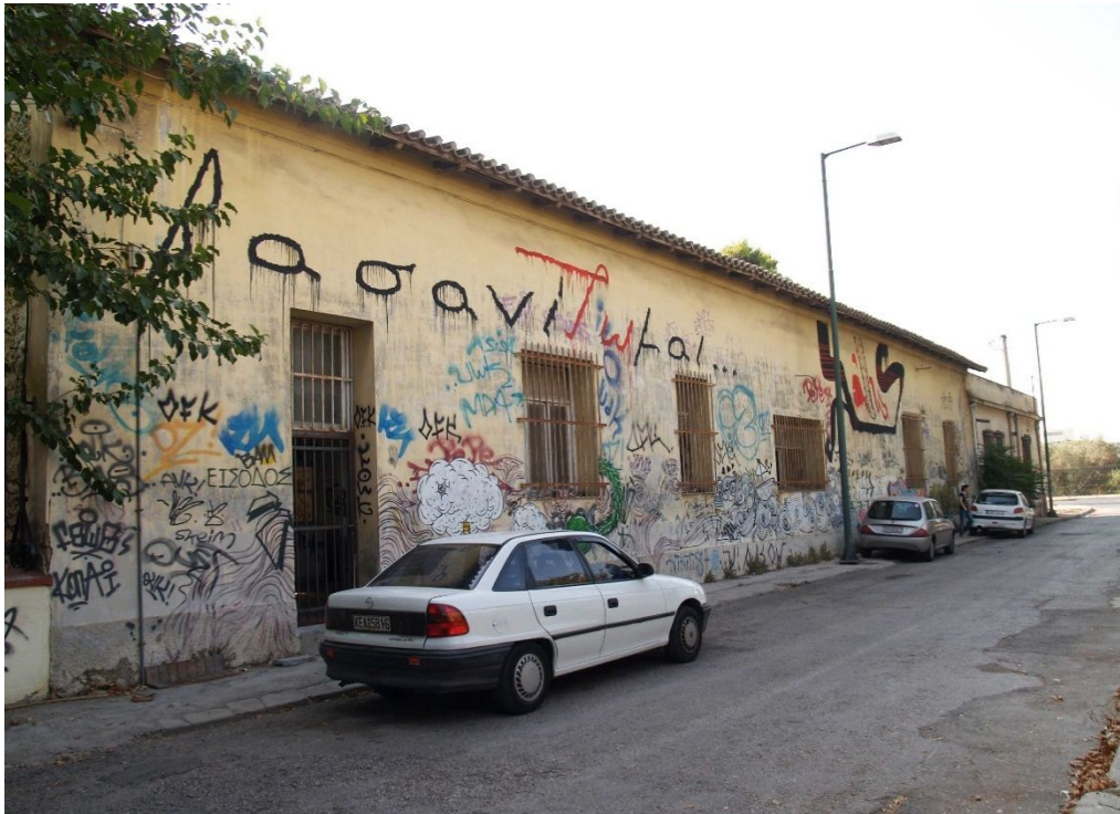
Εικόνα 15: Βορειοδυτική όψη κτιρίου 3
