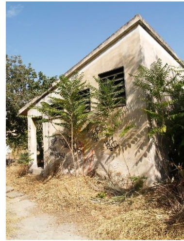
Εικόνα 40: Νότια όψη κτιρίου 5
