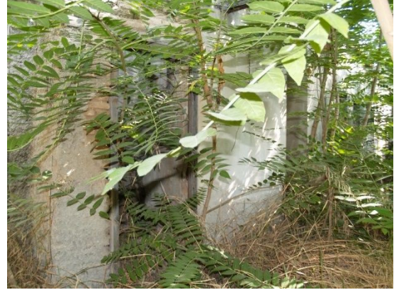
Εικόνα 44: Νότια όψη κτιρίου 7
