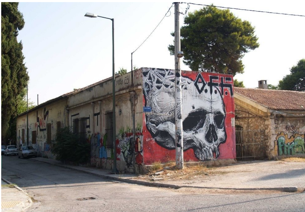
Εικόνα 11: Νοτιοδυτική όψη κτιρίου 2
