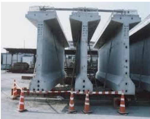
Εικόνα 25: Προκατασκευασμένες Δοκοί ΑΣΣ
