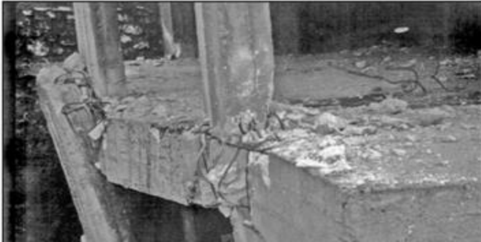
Εικόνα 18 : Αστοχία μη πλαστικού ΔΥΔ στο σεισμό Kocaeli 1999
