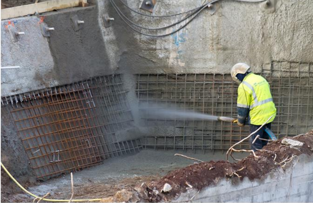
Εικόνα 6: Εφαρμογή εκτοξευόμενου σκυροδέματος
