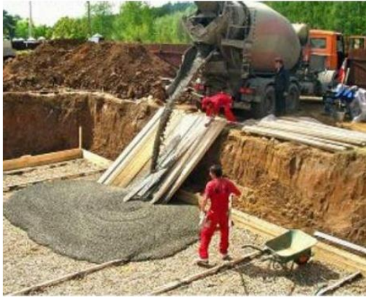
Εικόνα 15 Έγχυση αυτοσυμπυκνούμενου σκυροδέματος
