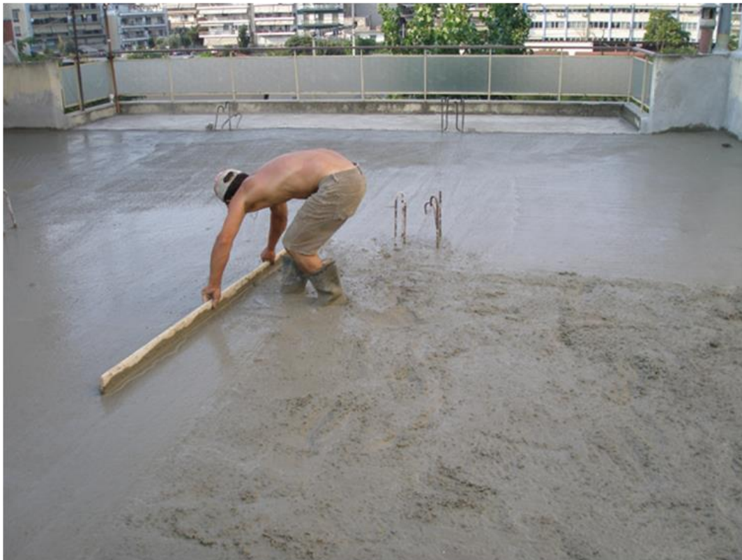
Εικόνα 3: Άοπλο σκυρόδεμα (γκρο μπετόν)
