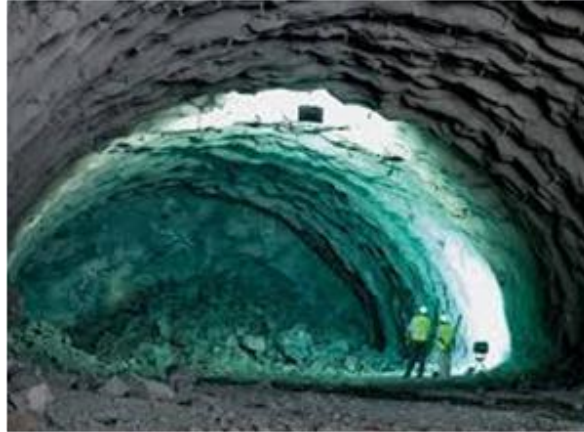
Εικόνα 27 Εσκαμμένο Τούνελ πριν την σκυροδέτηση
