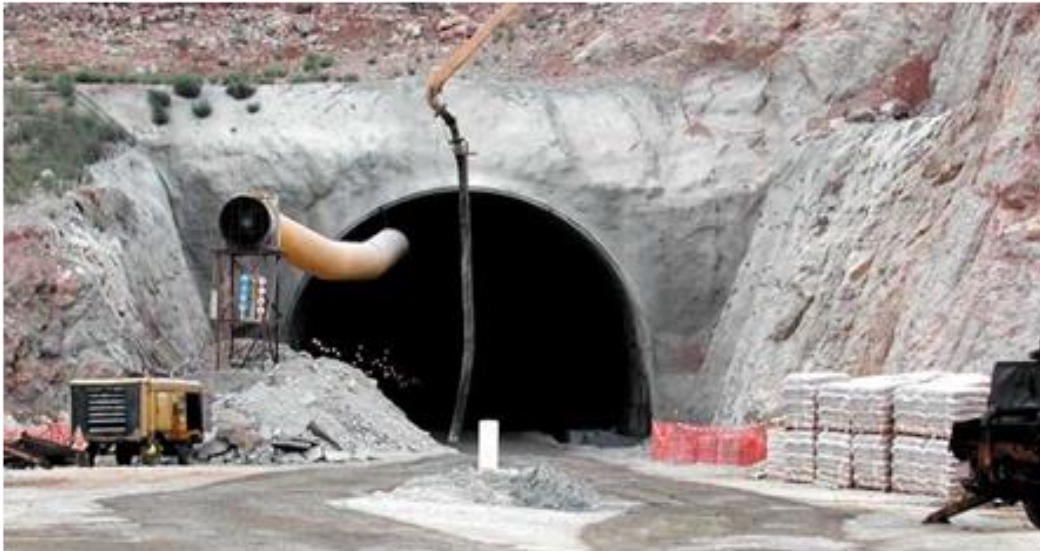
Εικόνα 7: Διάνοξη σήραγγας και τοποθέτηση κελύφους στήριξης
