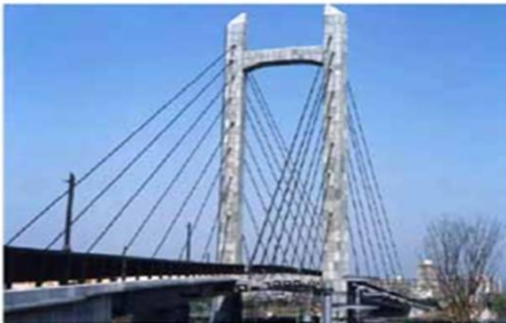
Εικόνα 11: Η γέφυρα Shin-kiba Ohashi
