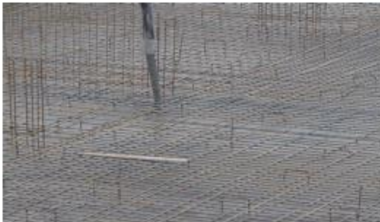
Παράρτημα 3 Εικόνα 6: Casting an SCC slab. (fig 11.1)
