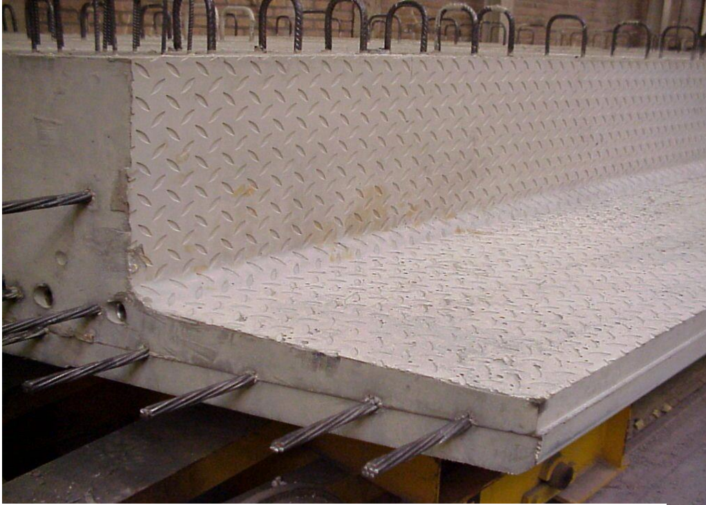
Παράρτημα 3 Εικόνα 2: Figure 5.1: Surface detail on precast element with SCC filling under the formwork
