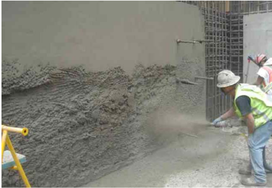
Εικόνα 3.26 Εκτόξευση της τελικής στρώσης [14]
