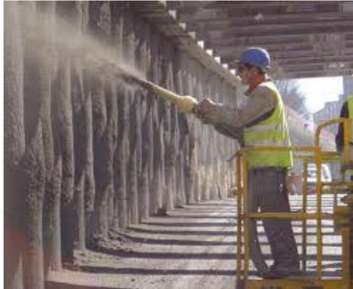
Εικόνα 3.6 Χρήση εκτοξευόμενου σκυροδέματος για την κάλυψη κουρτίνας από οπλισμένο σκυρόδεμα [25].
