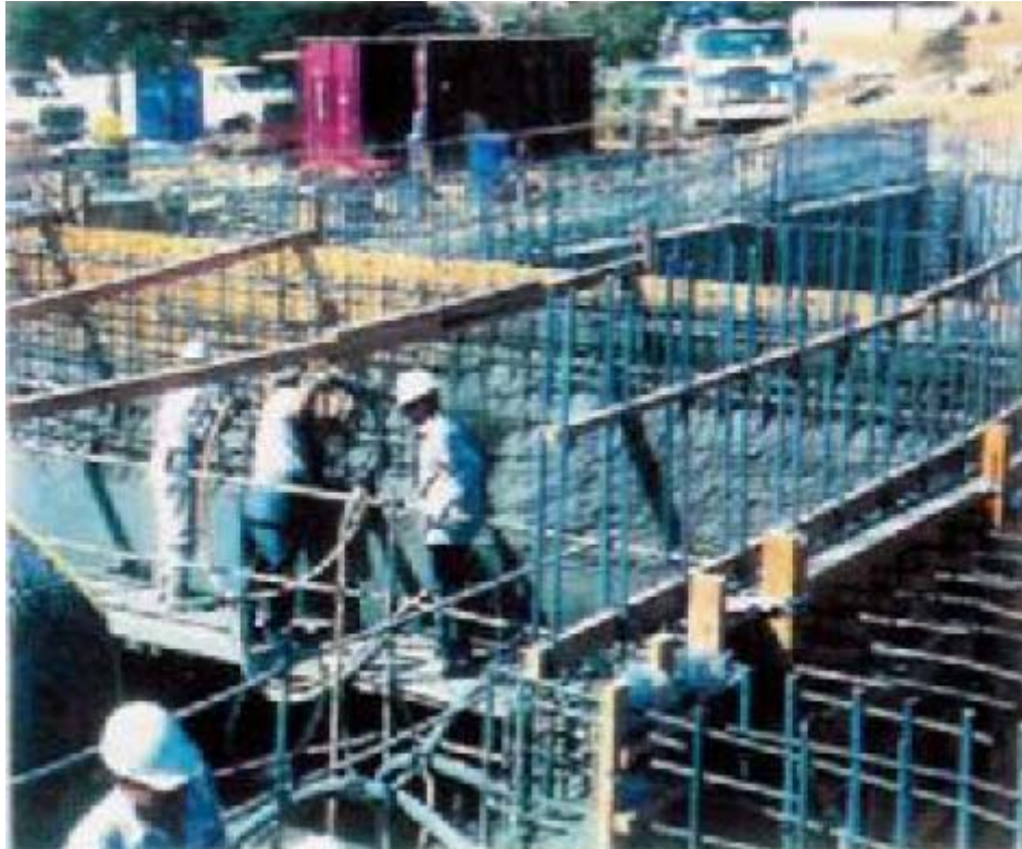
Εικόνα 3.18 Διάστρωση εκτοξευόμενου σκυροδέματος στο κτίριο της Hewlett Packard [7]
