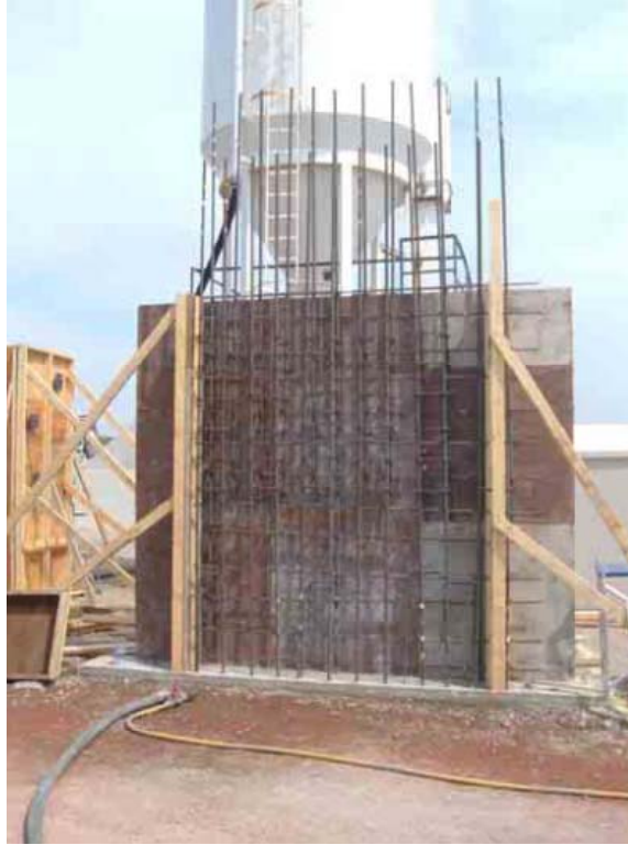
Εικόνα 3.22 Τοποθέτηση ξυλοτύπου και οπλισμού στο προς κατασκευή στοιχείο (τοιχείο) [14]
