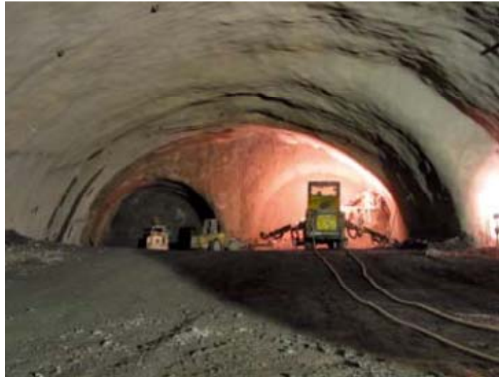
Εικόνα 3.8 Υποστήριξη του μετώπου της σήραγγας του Lungern με αρχική στρώση εκτοξευόμενου σκυροδέματος [22].
