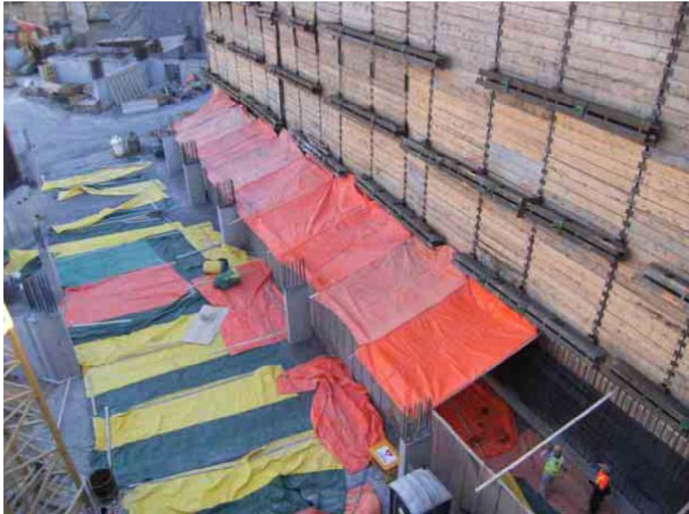
Εικόνα 3.24 Τμήμα του έργου κατά την εκτέλεση των εργασιών σκυροδέτησης [14]
