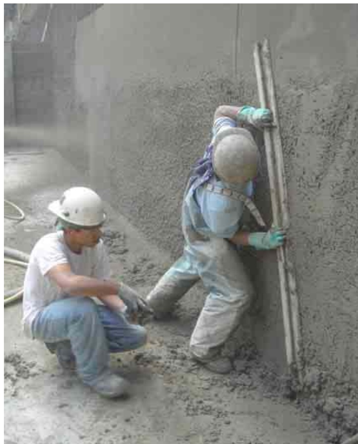
Εικόνα 3.27 Εξομάλυνση της τελικής επιφάνειας [14]
