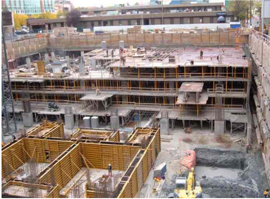
Εικόνα 3.28 Γενική όψη του έργου μετά τη σκυροδέτηση [14]
