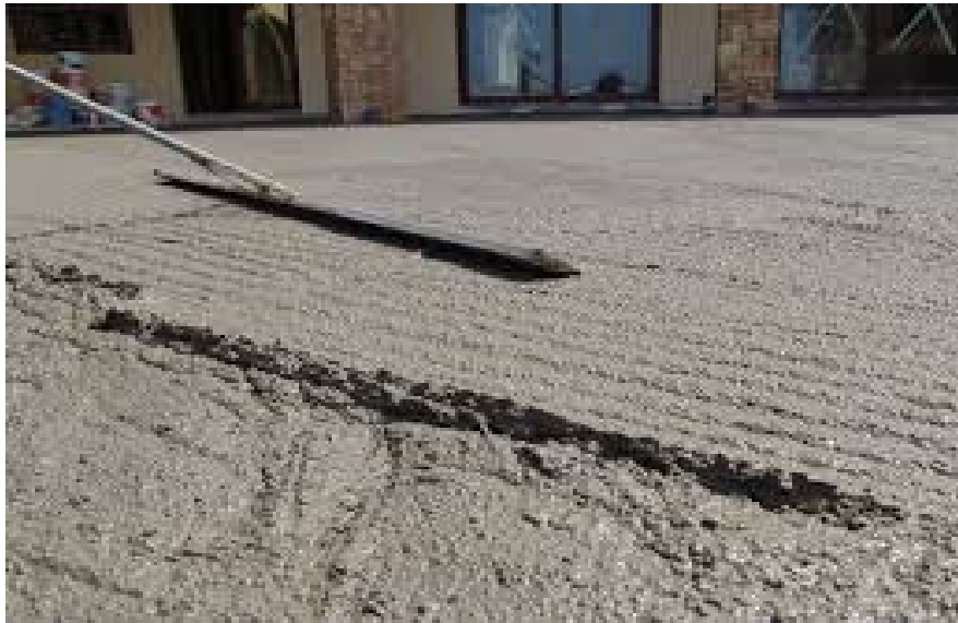
Εικόνα 1.2 Εφαρμογή ελαφροσκυροδέματος [3]
