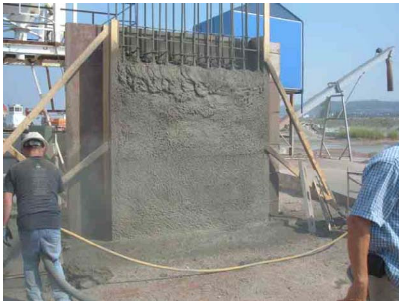
Εικόνα 3.23 Σταδιακή εκτόξευση σκυροδέματος στο στοιχείο [14]
