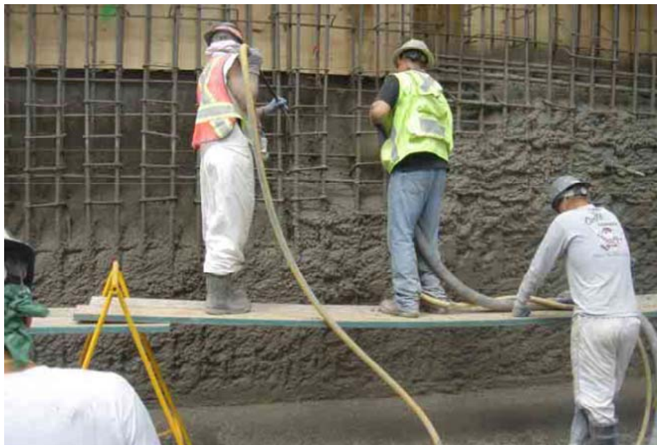
Εικόνα 3.25 Εκτόξευση σκυροδέματος, πρώτη στρώση [14]
