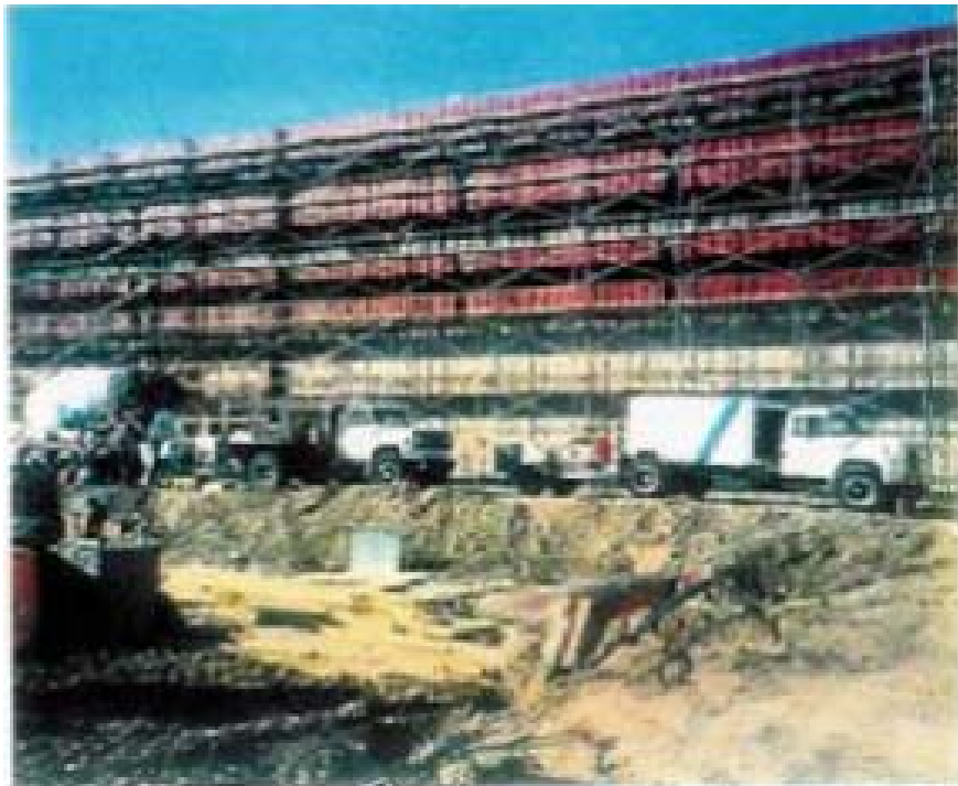
Εικόνα 3.16 Το έργο στην πλατεία Capitol όπου κατασκευάστηκαν δύο λεπτοί τοίχοι από εκτοξευόμενο σκυρόδεμα [7]
