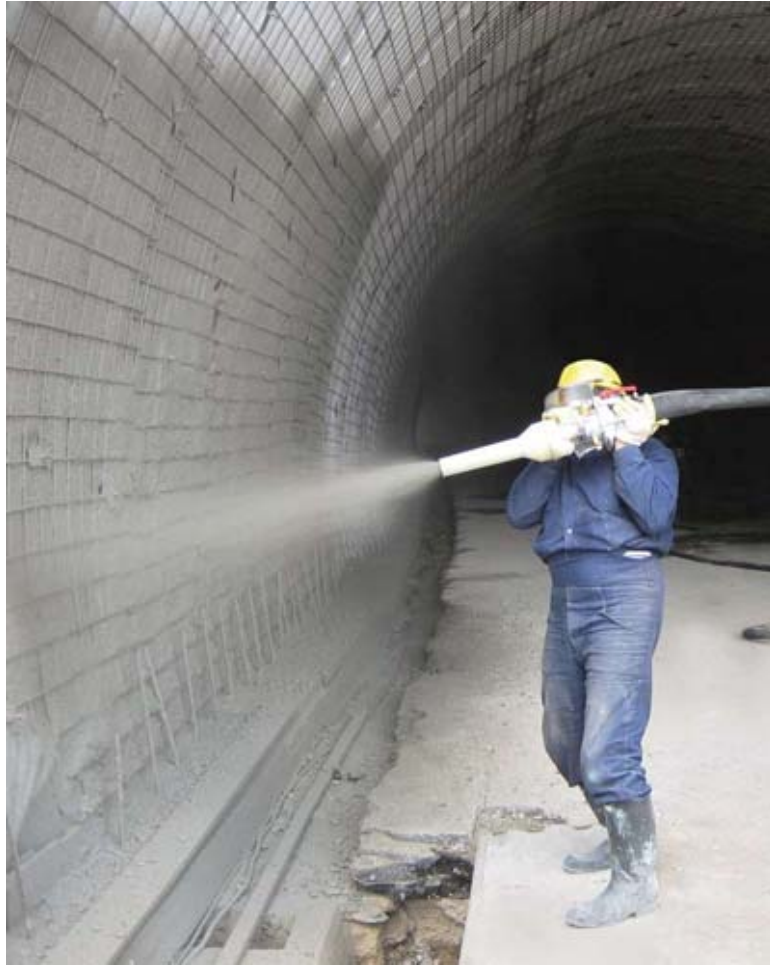
Εικόνα 3.4 Εκτόξευση σκυροδέματος σε έργα σηράγγων [23].
