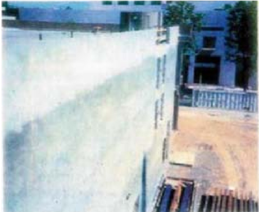
Εικόνα 3.17 Το έργο στην πλατεία Capitol στη φάση ολοκλήρωσης των τοιχείων, η χρωματική διαφορά είναι αποτέλεσμα της διαφορετικής τεχνικής αποπεράτωσης που χρησιμοποιήθηκε, για αρχιτεκτονικούς λόγους. [7]
