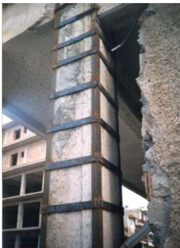
Εικόνα 3.11 Επέμβαση με μεταλλικό κλωβό. [13]
