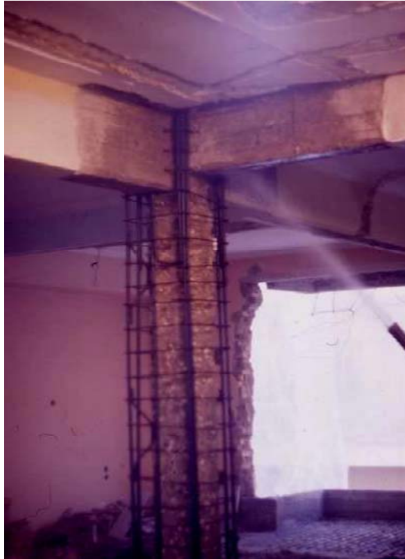
Εικόνα 3.12 Ενίσχυση υποστυλώματος με μανδύα οπλισμένου σκυροδέματος [13]
