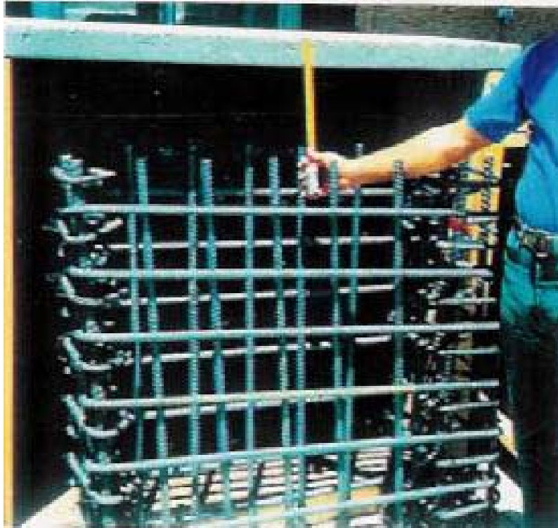
Εικόνα 3.21 Η χειρότερη περίπτωση όσον αφορά την πυκνότητα του οπλισμού στο έργο του πανεπιστημίου Stanford [7]
