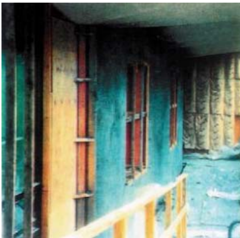
Εικόνα 3.20 Ολοκληρωμένα τοίχεία στο έργο του Πανεπιστημίου Stanford [7]
