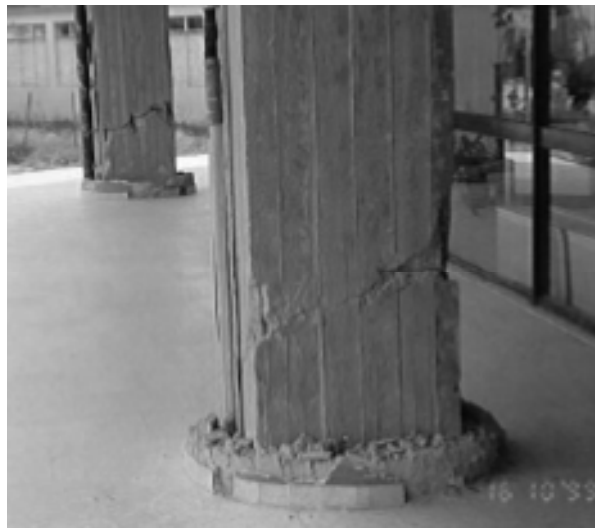
Εικόνα 3.10 Αστοχία υποστυλώματος [13]
