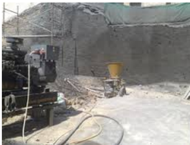
Εικόνα 3.5 Χρήση εκτοξευόμενου σκυροδέματος για στήριξη πρανών [24].
