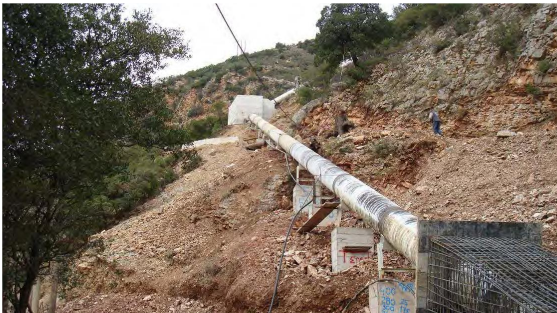
Εικόνα 55: Το στερεό εγκιβωτισμού block No 2 και τμήμα του αγωγού πτώσης κατόντη
