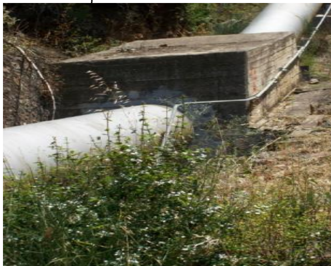
Εικόνα 17: Πάκτωση αγωγού πτώσεως σε αλλαγή κλίσης του
