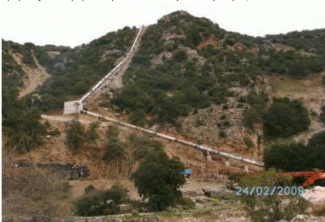
Εικόνα 46: Ο αγωγός φυγής όπως κατασκευάστηκε
