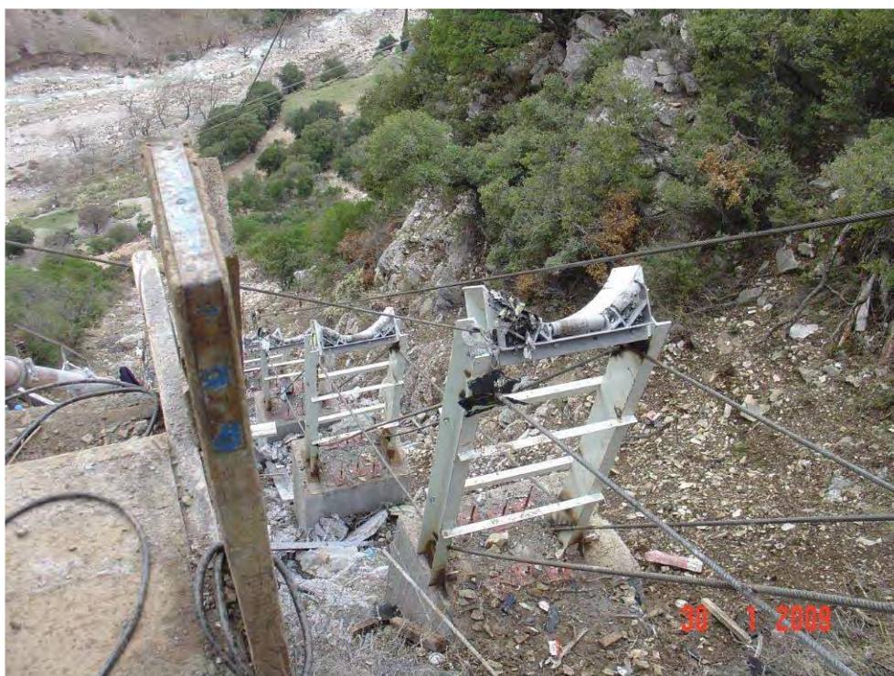
Εικόνα 53:Οι βάσεις στήριξης του αγωγού
