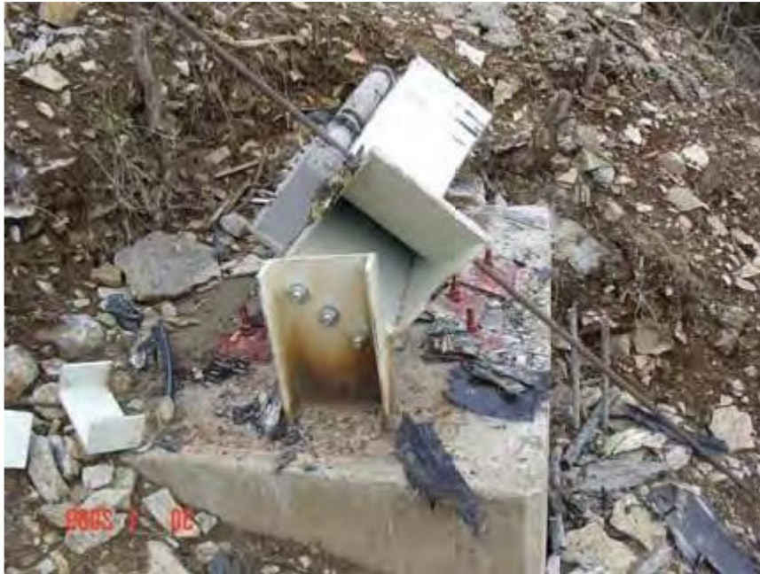
Εικόνα 47: Βάση στηρίγματος με αγκύρια και πλάκα αγκύρωσης
