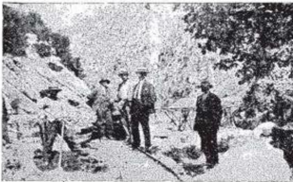
Εικόνα 5:εργασίες κατασκευής του Υ.Η.Σ Γλαύκου
