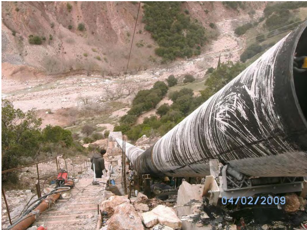
Εικόνα 54: Άποψη του αγωγού πτώσης πριν την ολοκλήρωση της τοποθέτησης
