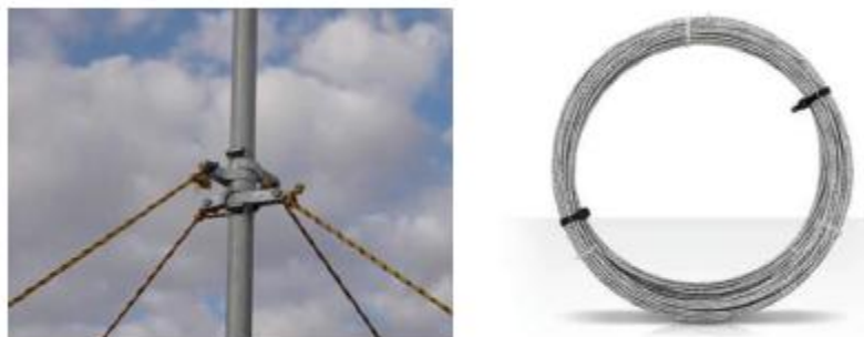
Εικόνα 4.2 Βοηθητικά καλώδια στήριξης των θεμελίων του πυλώνα
