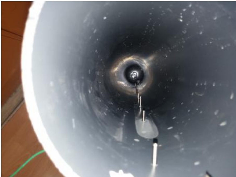
Εικόνα 39: Η εσωτερική πλευρά της δεξαμενής
