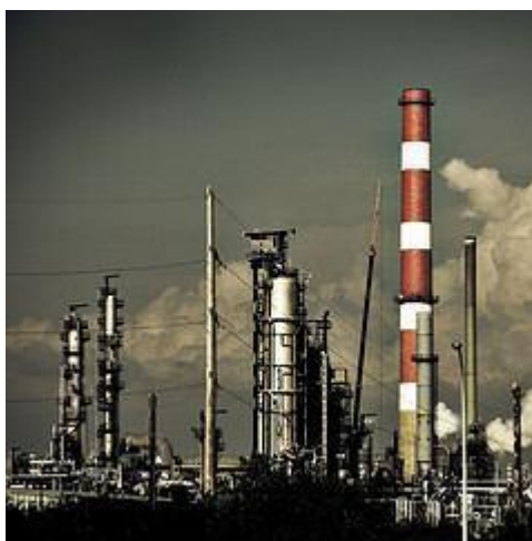
Σχήμα 1.2. Μονάδα διύλισης πετρελαίου.
