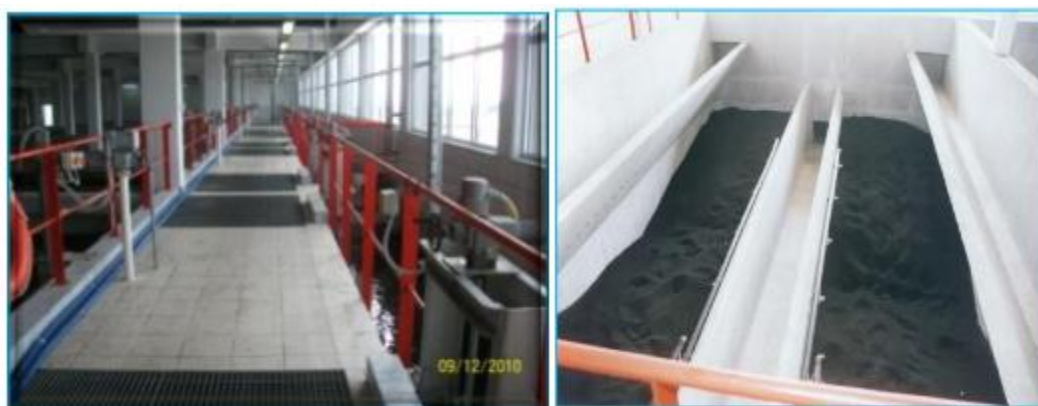
Εικόνα 2:Κλίνες ενεργού άνθρακα στην Ε.Ε.Ν. Θεσσαλονίκης
