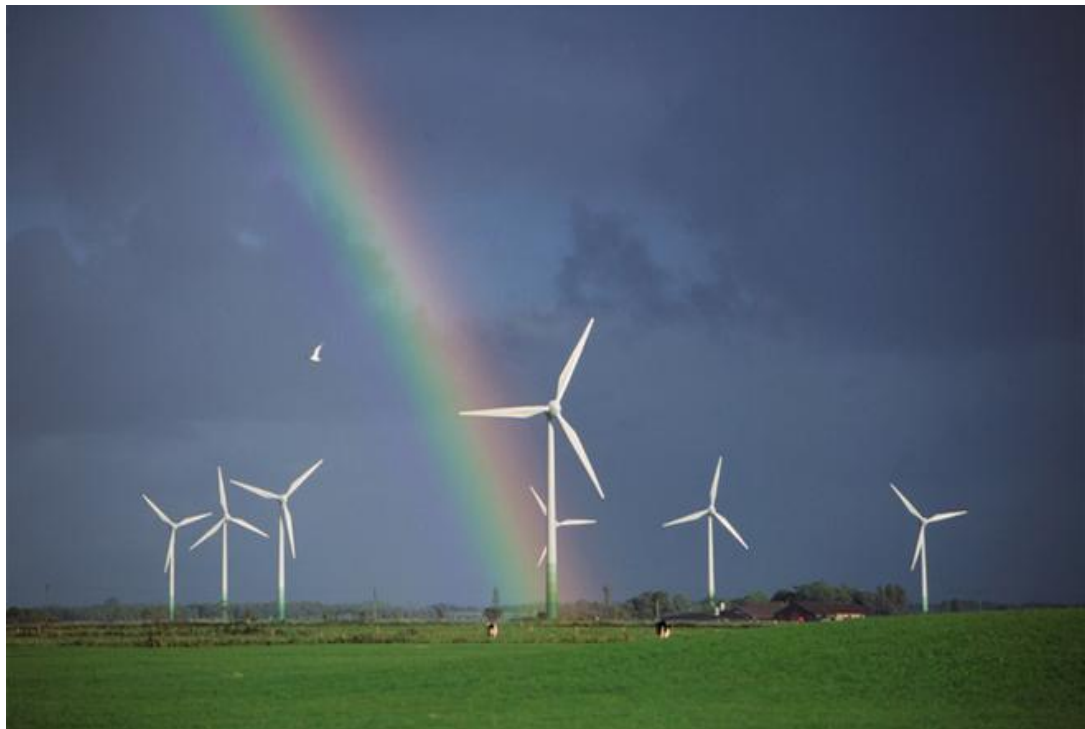
Ανεμογεννήτριες με χρωματισμό σύμφωνα με το περιβάλλον.
