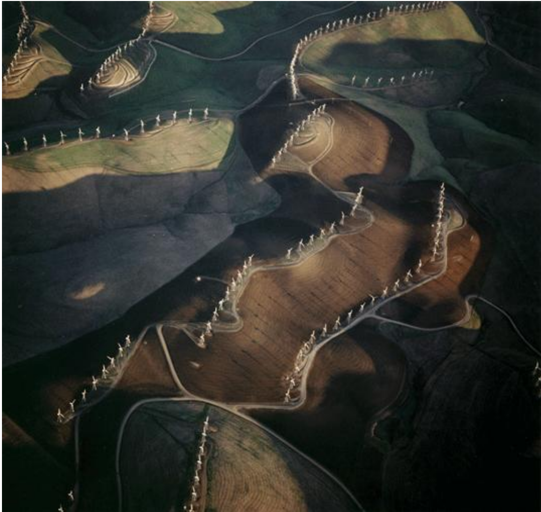
Αεροφωτογραφία αιολικού πάρκου Άλταμοντ στην Καλιφόρνια.
