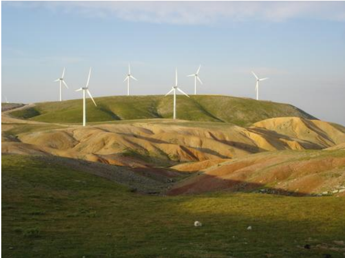
Αιολικό Πάρκο στην περιοχή της Πάτρας.
