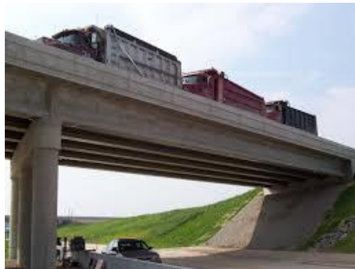
Εικόνα 4.14: Γέφυρα στην πόλη Waurun του Wisconsin [παρ.166].
