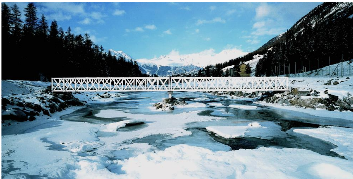
Εικόνα 4.21: Γέφυρα Pontresina [παρ.174].
