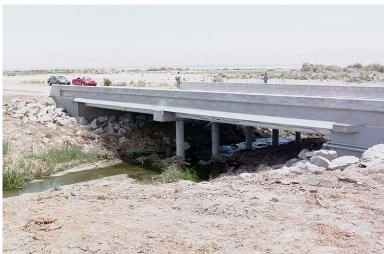
Εικόνα 4.16: Η γέφυρα δύο ανοιγμάτων Stormwater Cannel στο Salton Sea [παρ.168].
