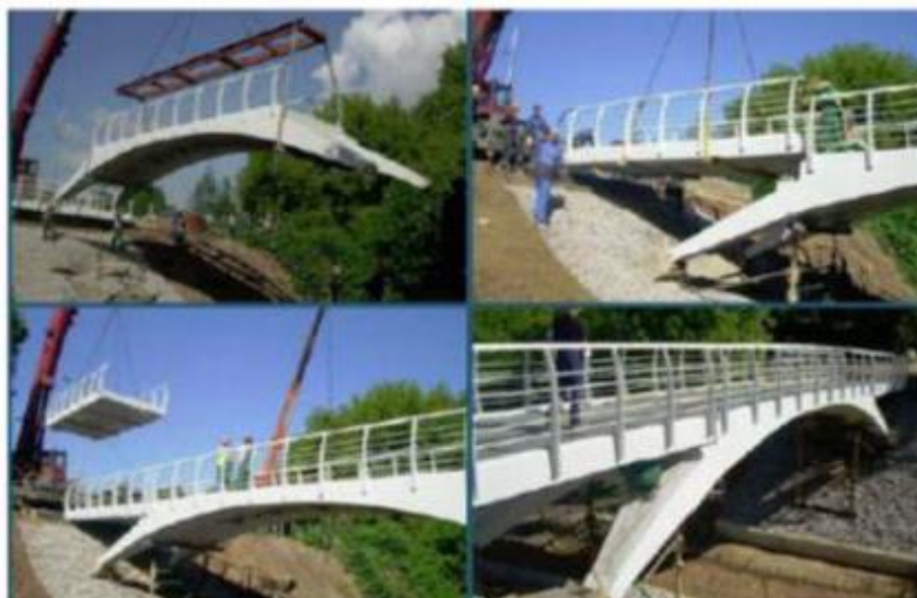
Εικόνα 4.28: Φάσεις κατασκευής της τοξωτής πεζογέφυρα ArATeCH [παρ.192].
