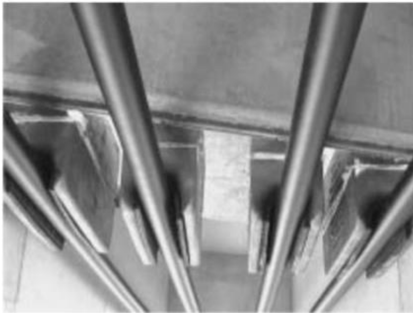
Εικόνα 2.9: Χαρακτηριστική διάταξη τενόντων για εξωτερική προένταση [παρ.85].
