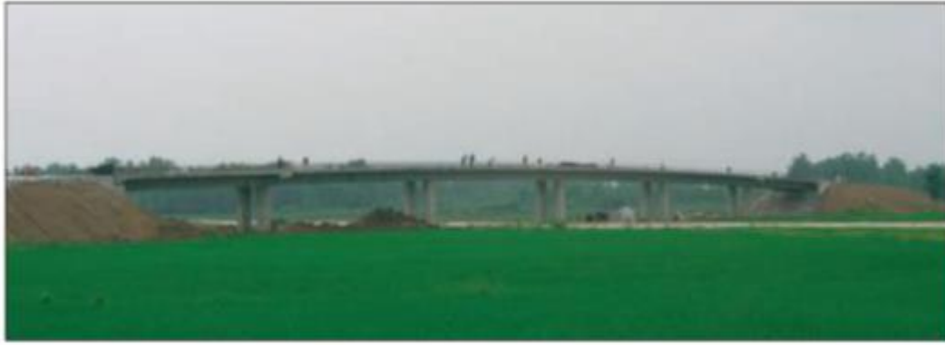
Εικόνα 4.1: Γενική άποψη της Γέφυρας Heiwei στην επαρχία Huai'an Jiangsu [παρ.141].
