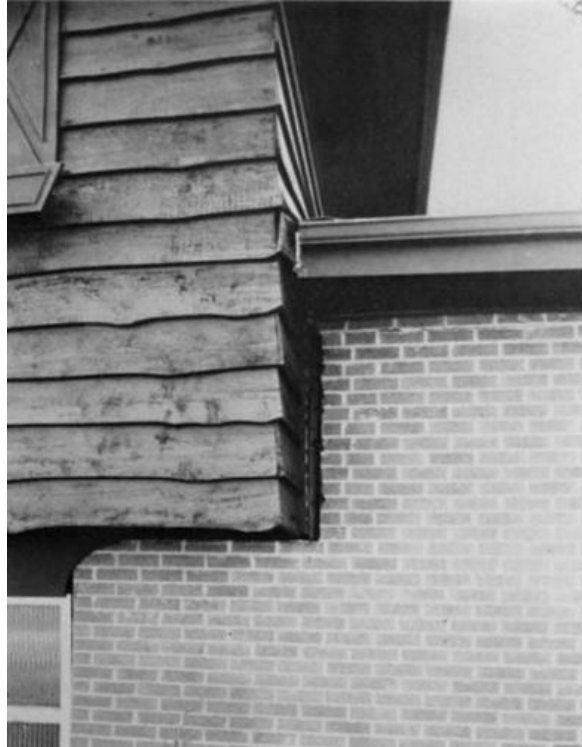
Εικόνα 35: Διαχωρισμός του σαλονιού από το διώροφο τμήμα. [Πηγή: Fu Hua Chen, 1975]
