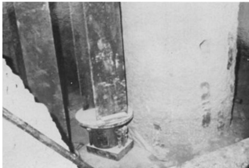
Εικόνα 32: Ανύψωση της πεδιλοδοκού κατά την επιχείρηση της ισοστάθμισης (των πασσάλων).
