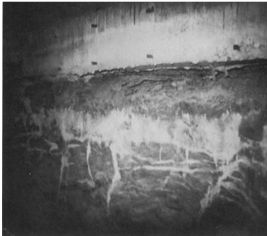
Εικόνα 28: Κενό 4 in (=0.1 m), το οποίο έχει κλείσει τελείως, κάτω από την πεδιλοδοκό. [Πηγή: Fu Hua Chen, 1975]
