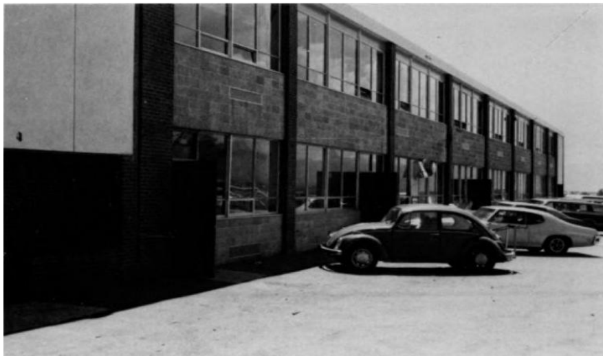
Εικόνα 22: Σχολείο Πτέρυγα Γ : Εξωτερική όψη του σχολείου υπό μελέτη. [Πηγή: Fu Hua Chen,1975]
