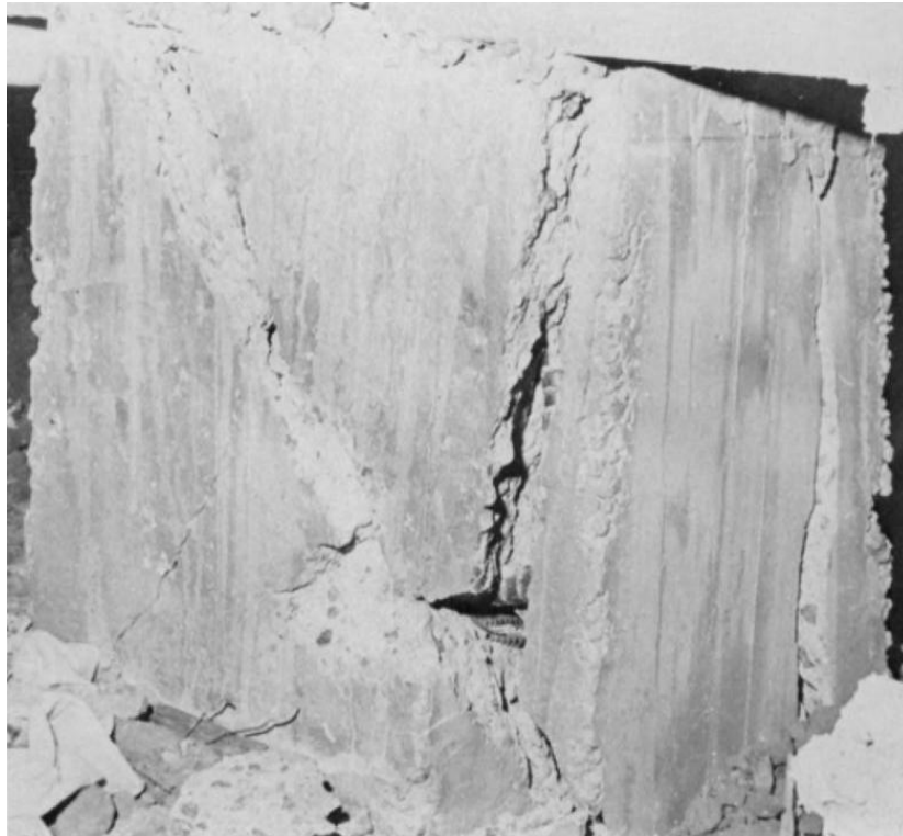
Εικόνα 23: Θλίψη του βάθρου που βρίσκεται πάνω από τον πάσσαλο και κάτω από την κύρια δοκό [Πηγή: Fu Hua Chen, 1975]
