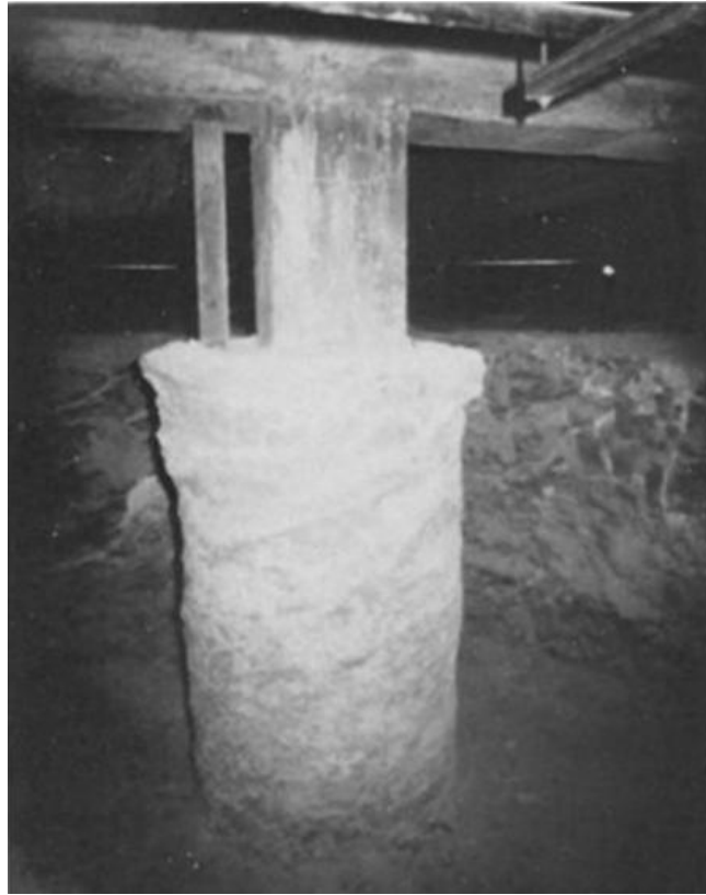
Εικόνα 30: Χαλάρωση του εδάφους γύρω από τον πάσσαλο για να εξαλειφθεί η πίεση ανύψωσης.
