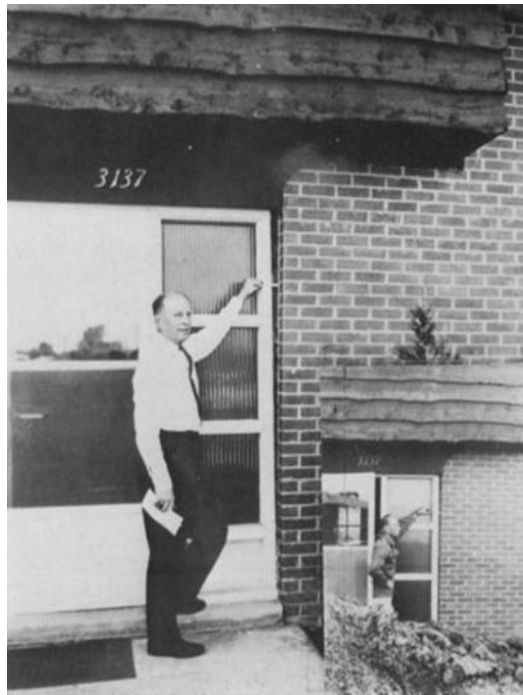
Εικόνα 37: Μετακίνηση του σπιτιού πριν και μετά τις διορθωτικές κατασκευές. [Πήγη: Fu Hua Chen, 1975]
