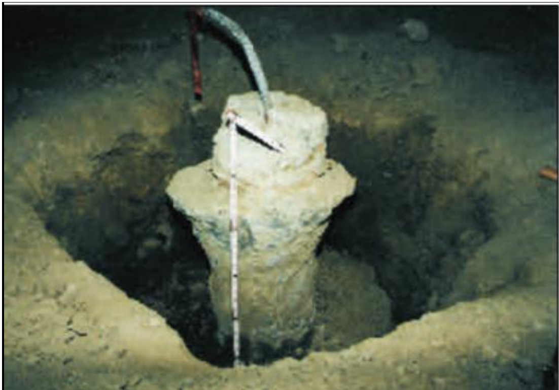
Εικόνα 29: Τυπική εικόνα που δείχνει την παρουσία «μανιταριού» στην κορυφή του πασσάλου
