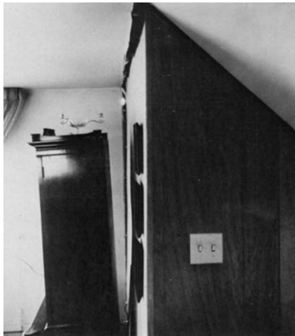
Εικόνα 36: Διαχωρισμός του σπιτιού εξαιτίας διαφορετικής διαστολής. [Πηγή: Fu Hua Chen, 1975]
