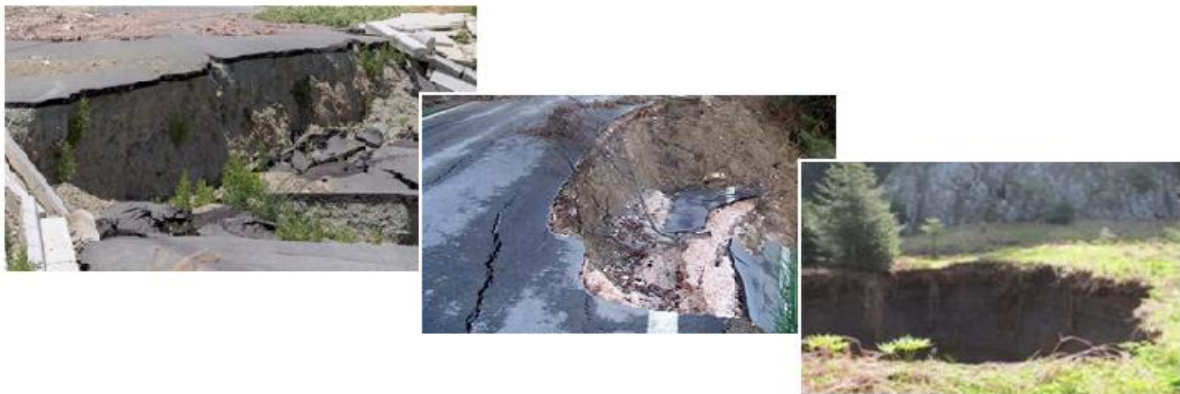
Εικόνα 2: Καθίζηση εδαφών
