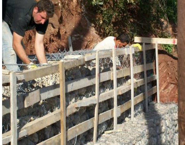
Σχ. 1.4 Τοποθέτηση λίθων με το χέρι
