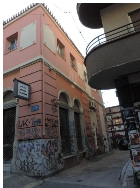
Πλαϊνή Όψη Κτηρίου- Στοά
