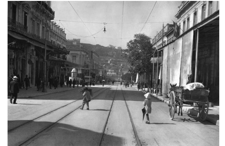
Φωτογραφία Αρχείου 1960 Οδός Αθηνάς (Στο Βάθος Αριστερά Φαίνεται το Κτήριο)
