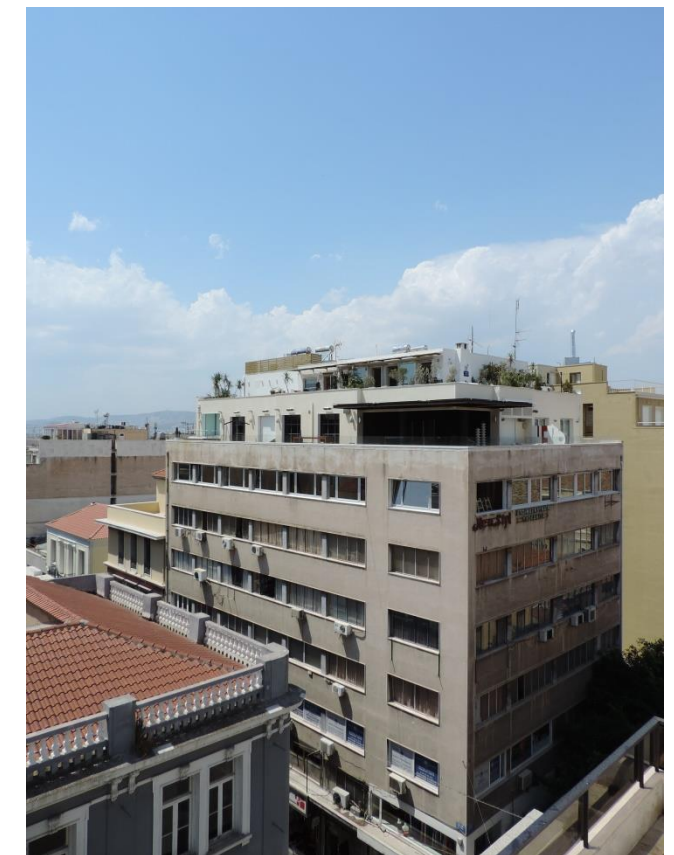
Οι όψεις του κτηρίου
