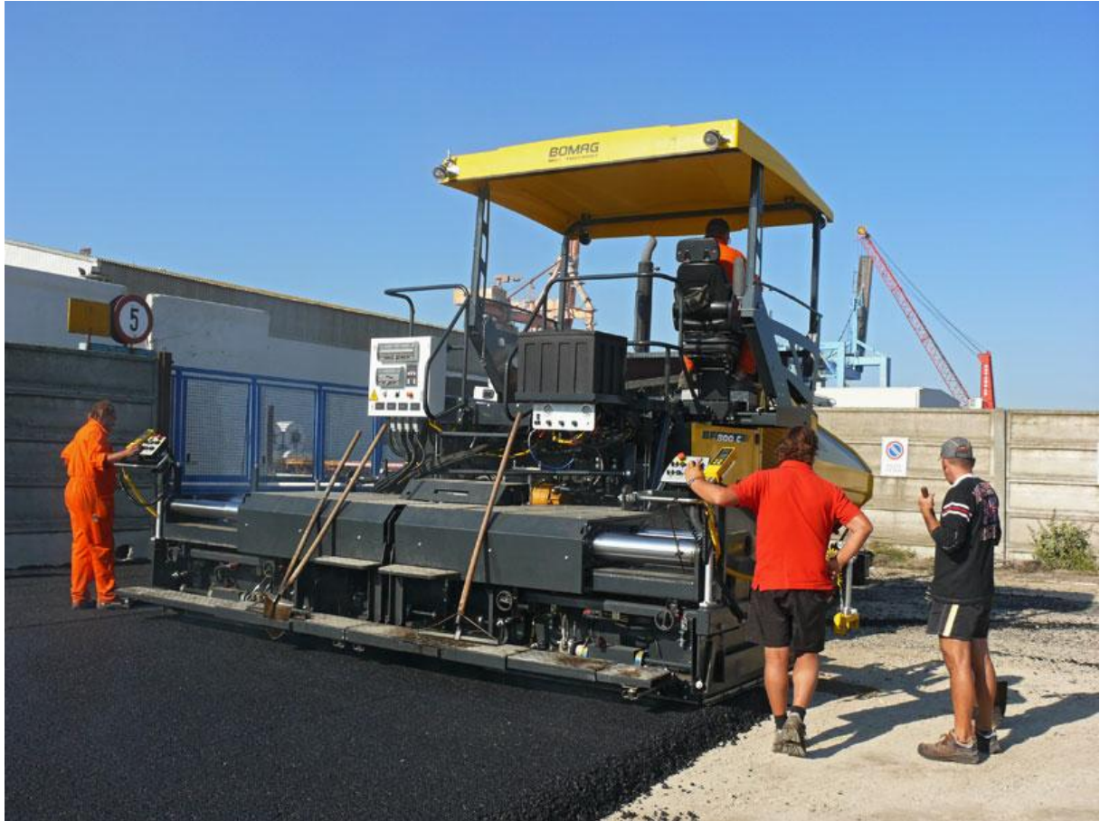
Εικόνα 8. Μηχάνημα κατασκευής ασφαλτοτάπητα
