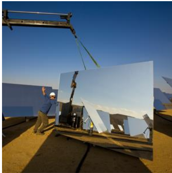
Εικόνα 27: Τυπικός Ηλιοστάτης
