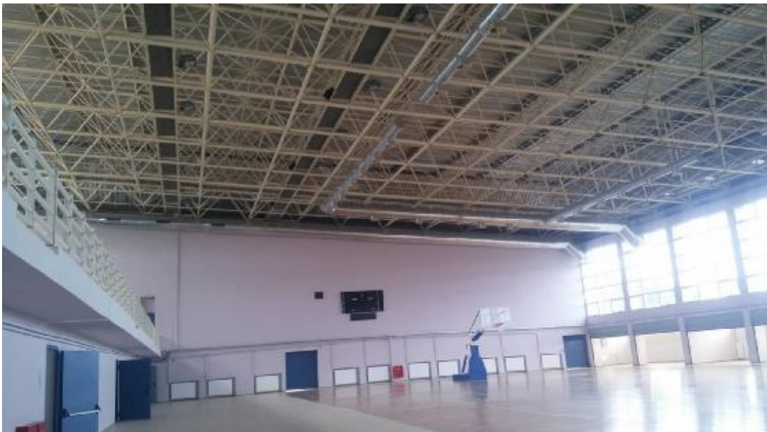
Εικόνα 18. Στέγη κτηρίου, εσωτερικά.
