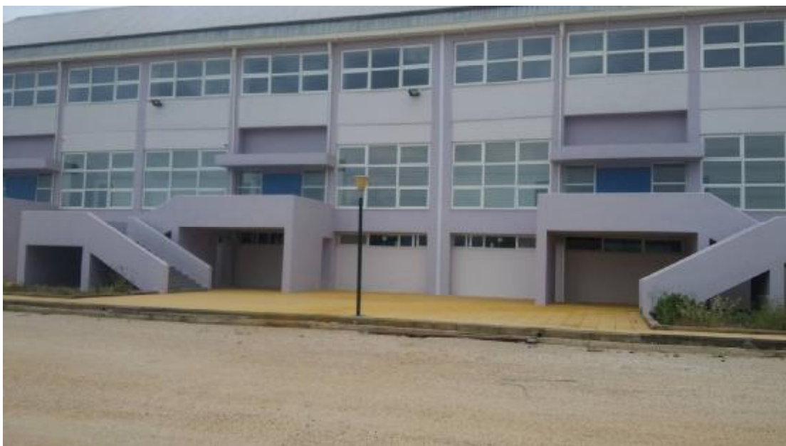
Εικόνα 14. Πρόσοψη κτηρίου. Είσοδοι.
