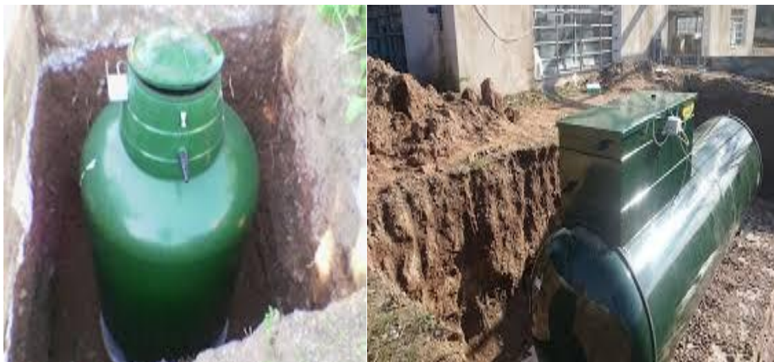
Εικόνα 2.2.2: Υπόγεια δεξαμενή υγραερίου.
