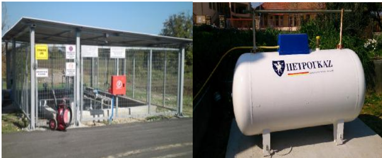
Εικόνα 2.2.1: Προστασία δεξαμενής από την ηλιακή ακτινοβολία και τη θερμοκρασία του περιβάλλοντος.
