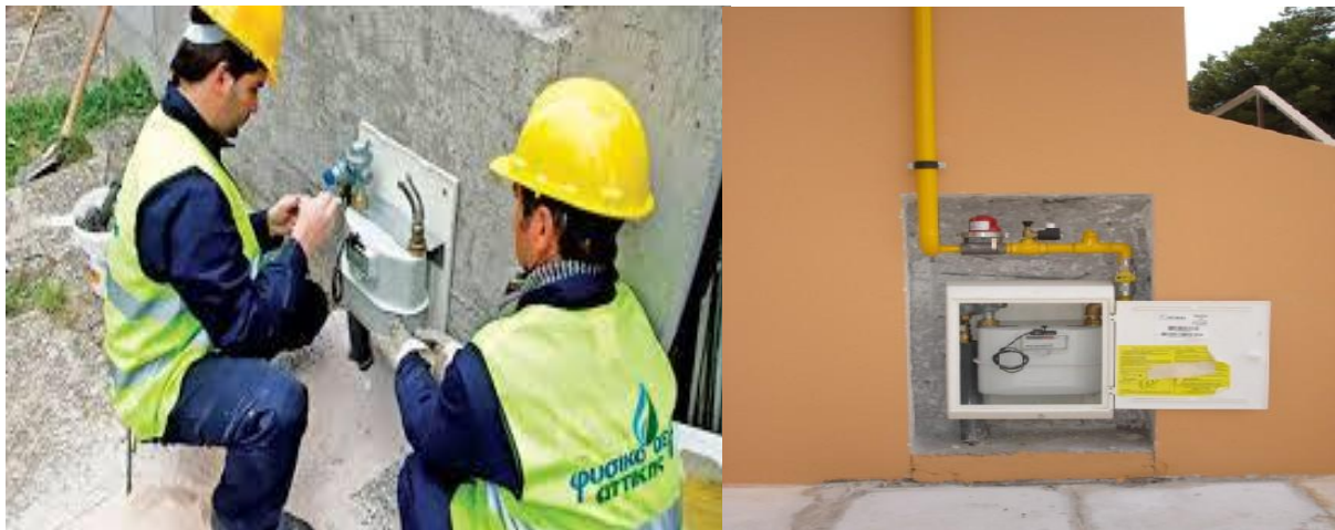
Εικόνα 2.4.1: Διαδικασία τοποθέτησης ενός μετρητή αερίου.
