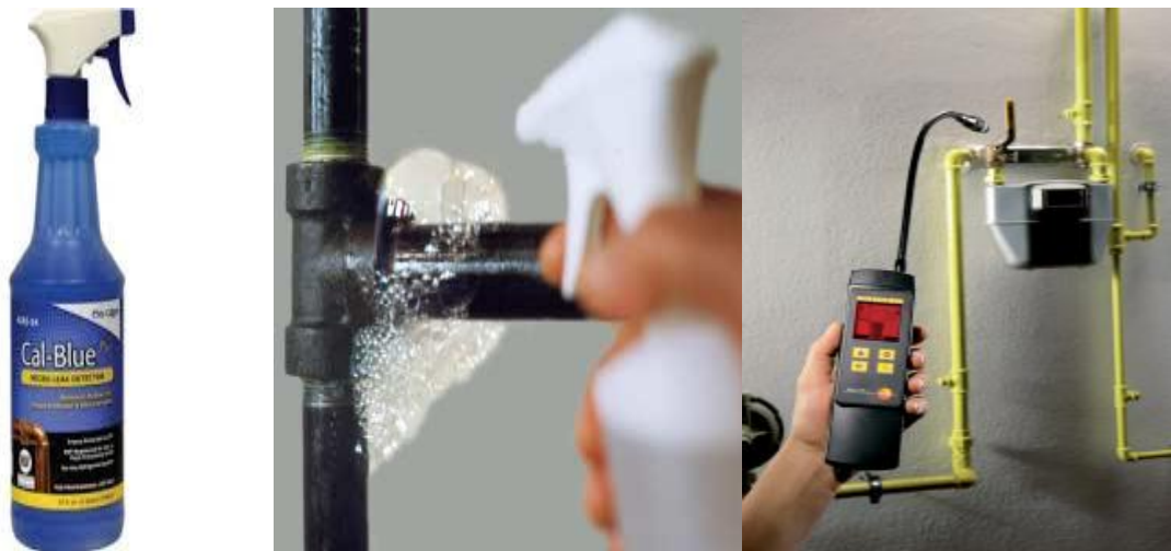
Εικόνα 2.5.7: Υγρά, Σαπουνάδα και Ανιχνευτής για εντοπισμό διαρροής.
