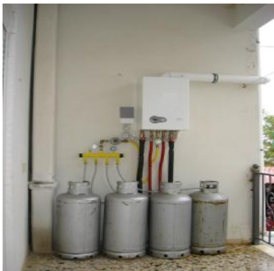
Εικόνα 2.3.1: Συστοιχίες 2*2 φιαλών υγραέριο και προειδοποίησης κινδύνου.
