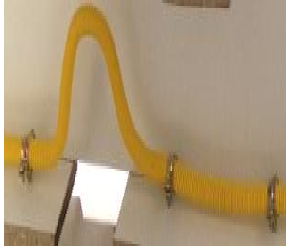
Εικόνα 2.7.9: Αντισεισμικό σωλήνα και απορροφητή θερμικών διαστολών.
