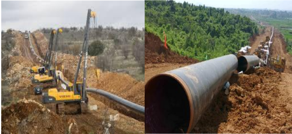
Εικόνα 1.4.2: Αγωγός για μεταφορά Φ. Αερίου σε κατασκευαστικό στάδιο.
