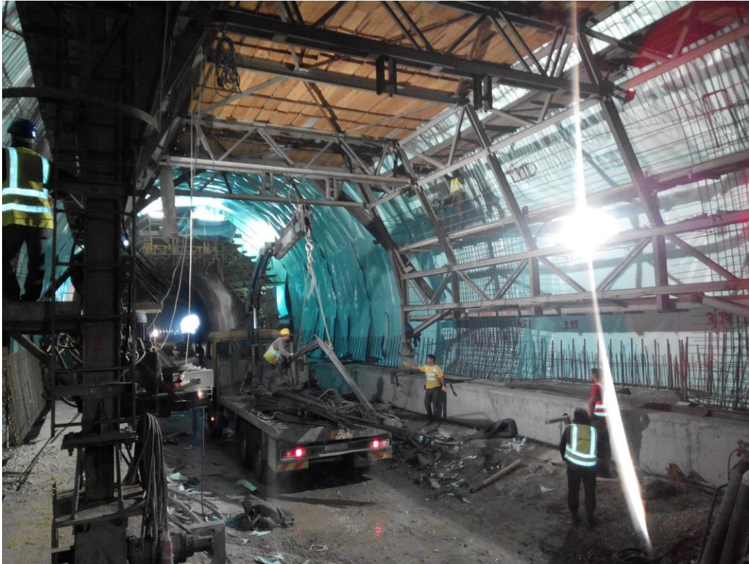
Εικόνα 29. Τοποθέτηση μεμβρανών και σιδηρού οπλισμού.
