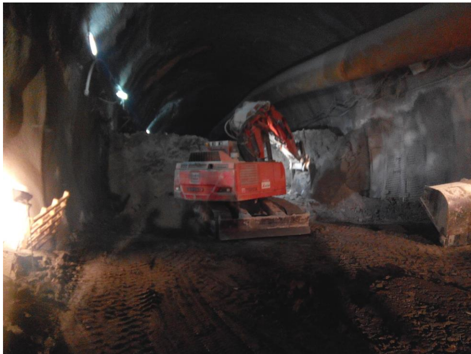
Εικόνα 28. Εσκαφή Β φάσης.
