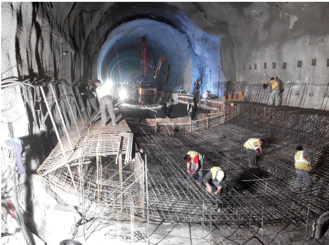
Εικόνα 30. Τοποθέτηση μόνιμου σιδηρού οπλισμού και σκυροδέτηση.
