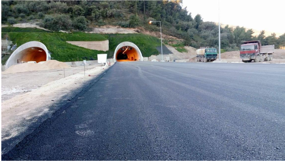
Εικόνα 33. Τελική εξωτερική όψη.
