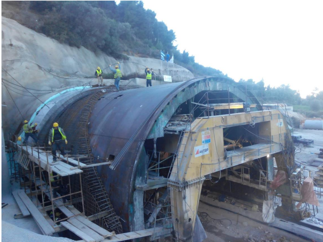
Εικόνα 31. Τοποθέτηση οπλισμού στομίου.
