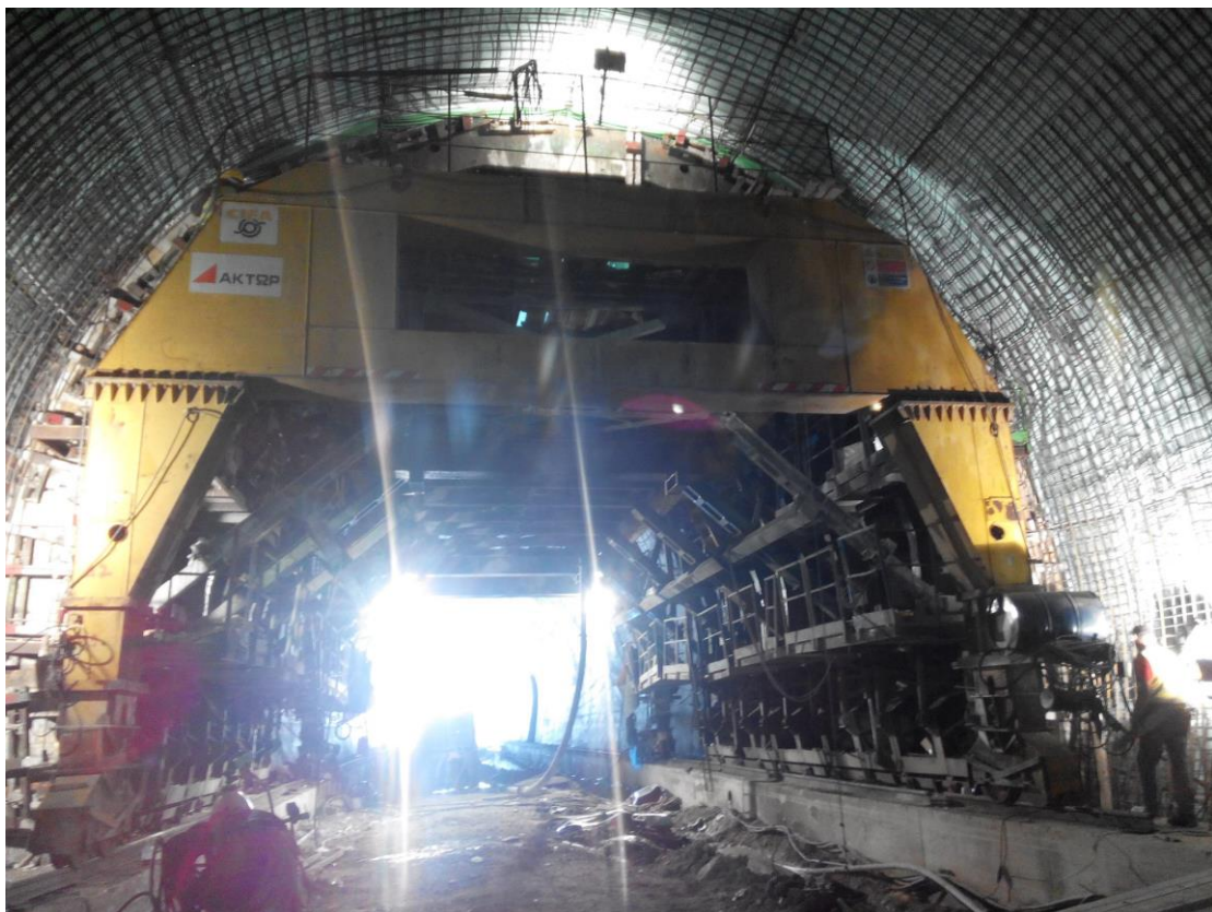
Εικόνα 32. Τοποθέτηση θόλου.
